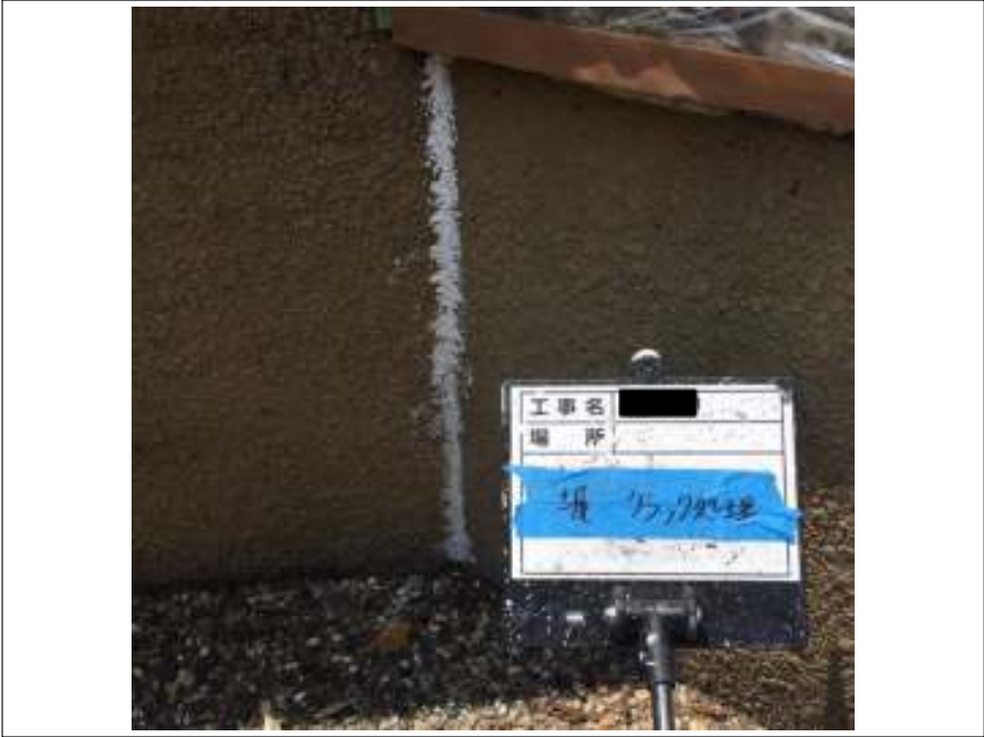
塀 クラック補修施工後
