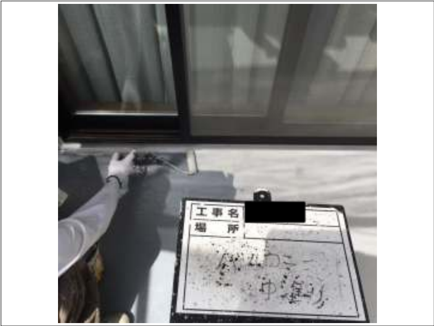
バルコニー 中塗り施工中
