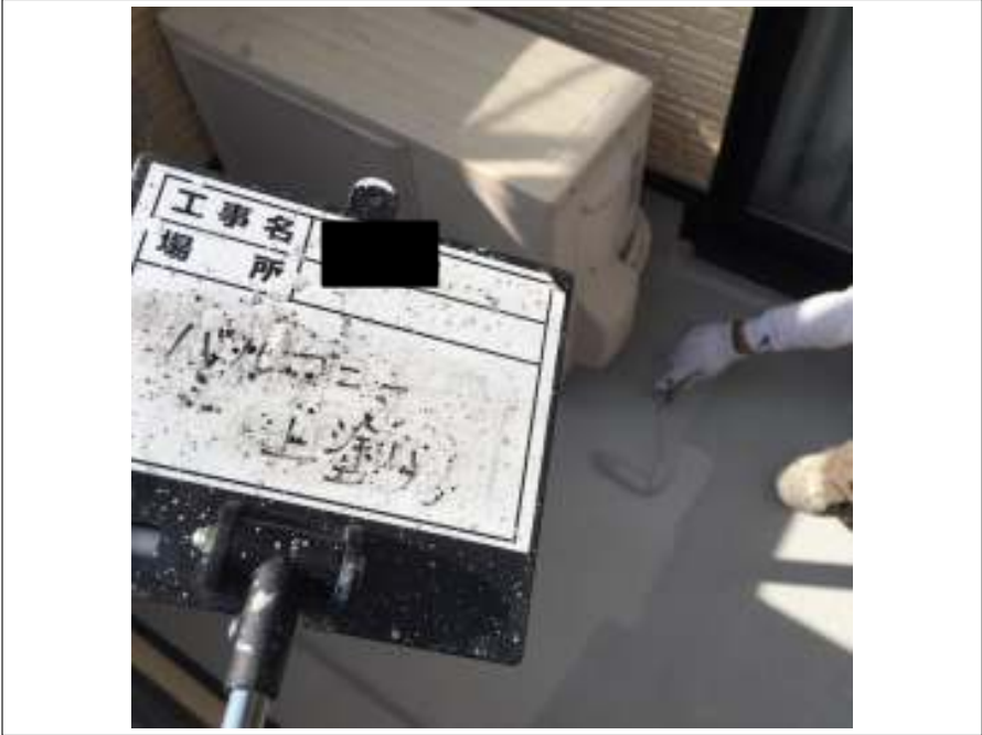
バルコニー 上塗り施工中
