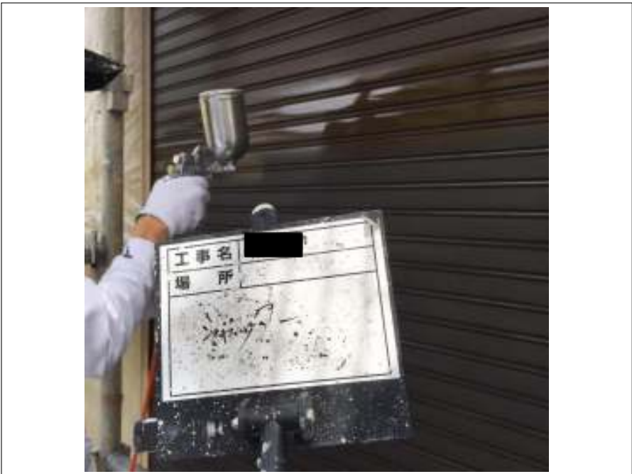
シャッター 上塗り施工中
