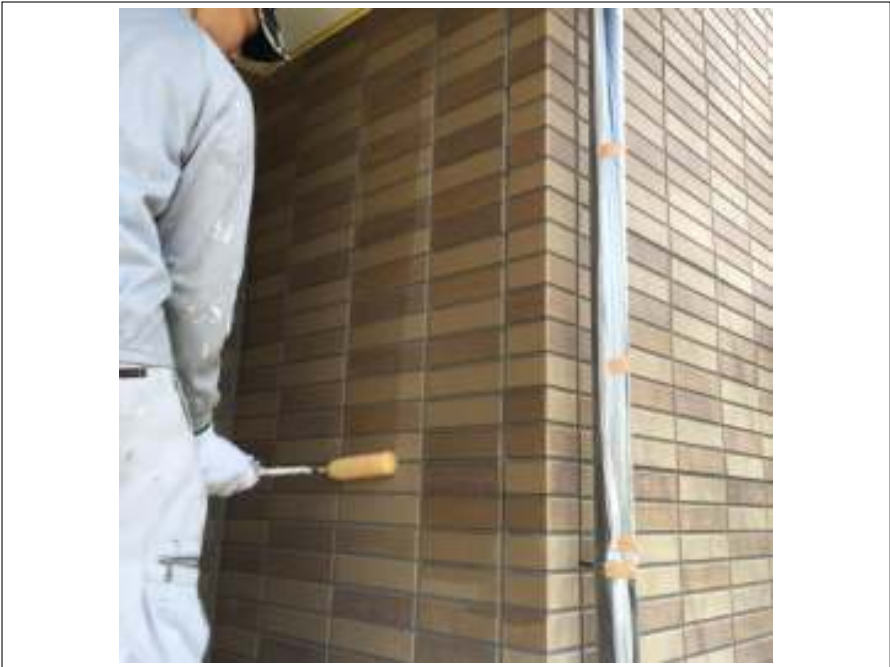
外壁(1F) クリア塗布施工中
