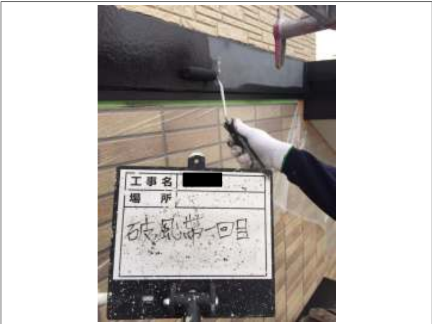
帯 上塗り施工中
