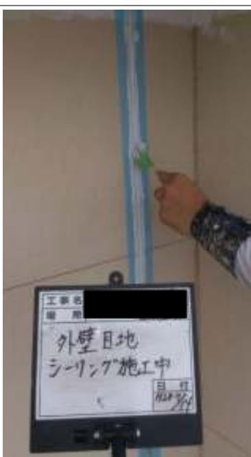
外壁(2F) 外壁 下塗り施工中
