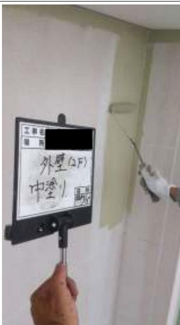
外壁(2F) 外壁 上塗り施工中
