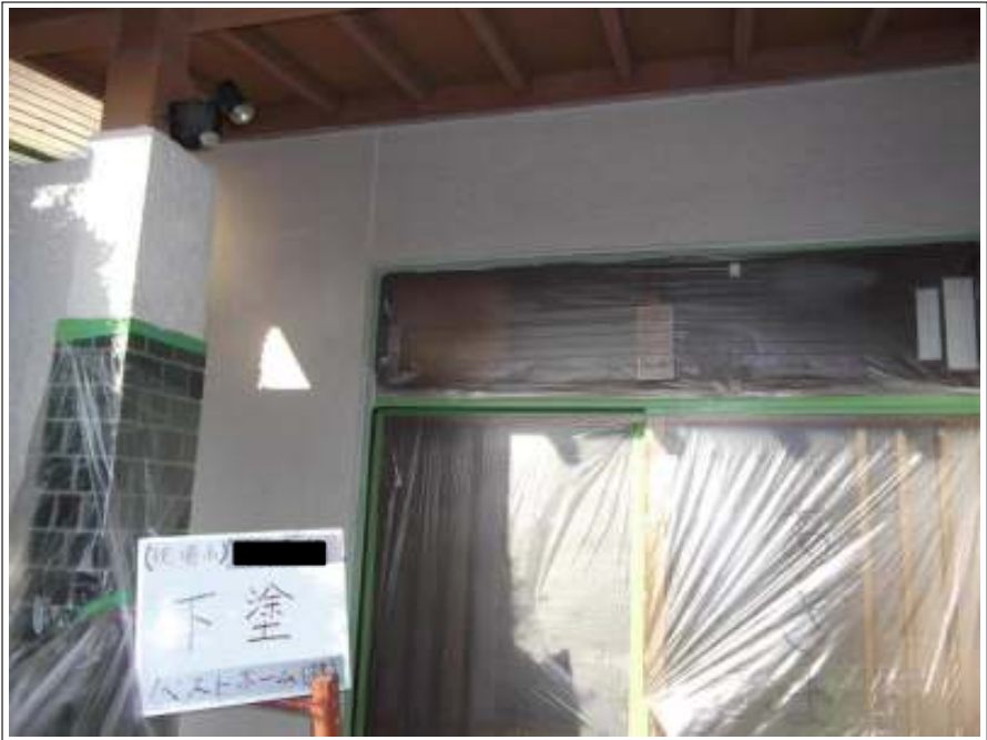
外壁 下塗り施工中
