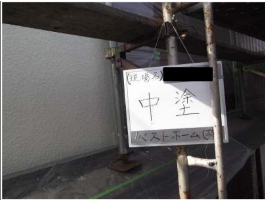
外壁 中塗り施工中
