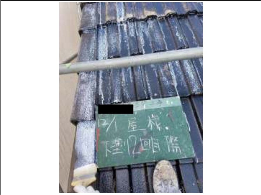
屋根 下塗り（2回目）施工中
