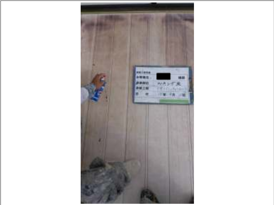
ベランダ床 下塗り施工中
