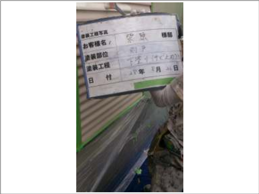
シャッター サビ止め塗布施工中
