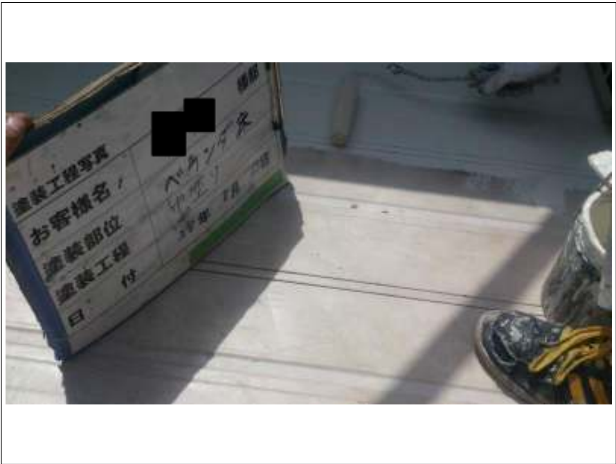
ベランダ床 中塗り施工中
