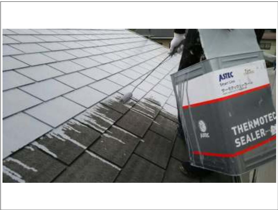
屋根 下塗り施工中
