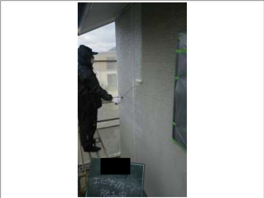
外壁 下塗り施工中
