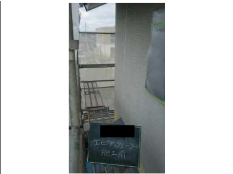
外壁 下塗り施工前
