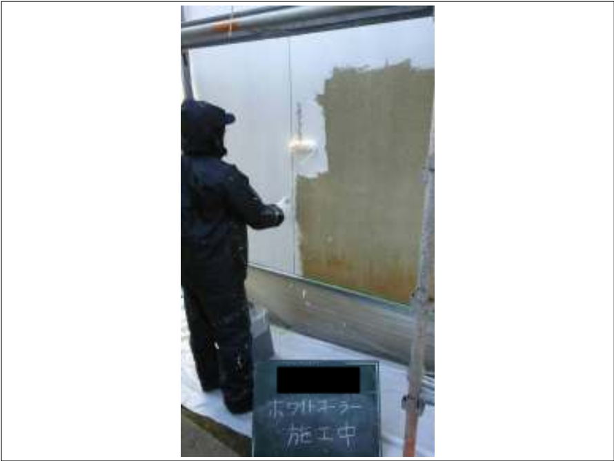
外壁 下塗り施工中
