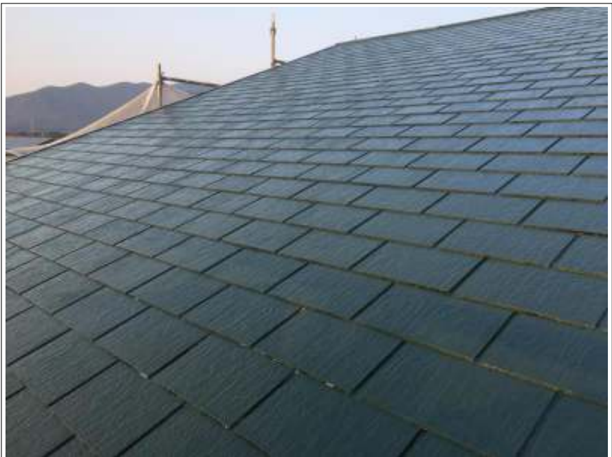
屋根 中塗り施工後
