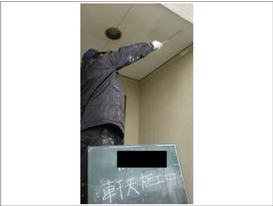
軒天 上塗り施工中 (1回目)
