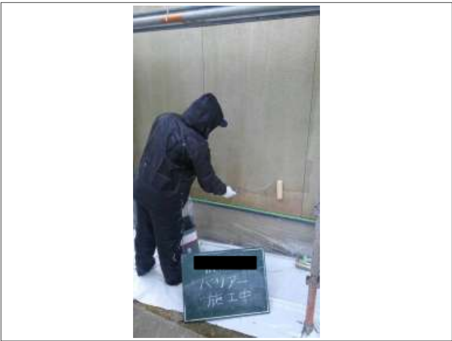
外壁 バリアー塗布施工中
