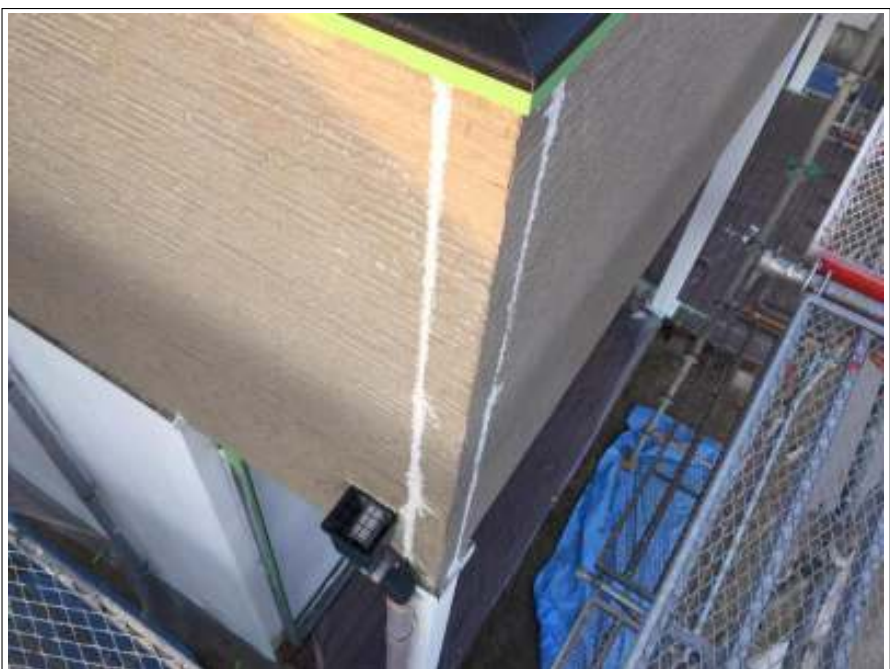
外壁 シーリング打ち替え施工後
