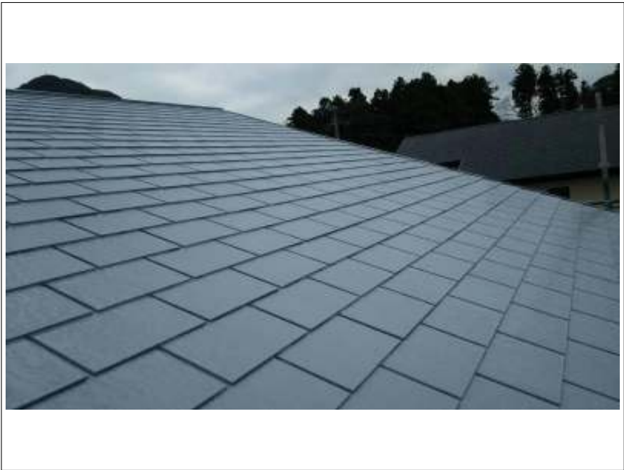
屋根 下塗り施工後
