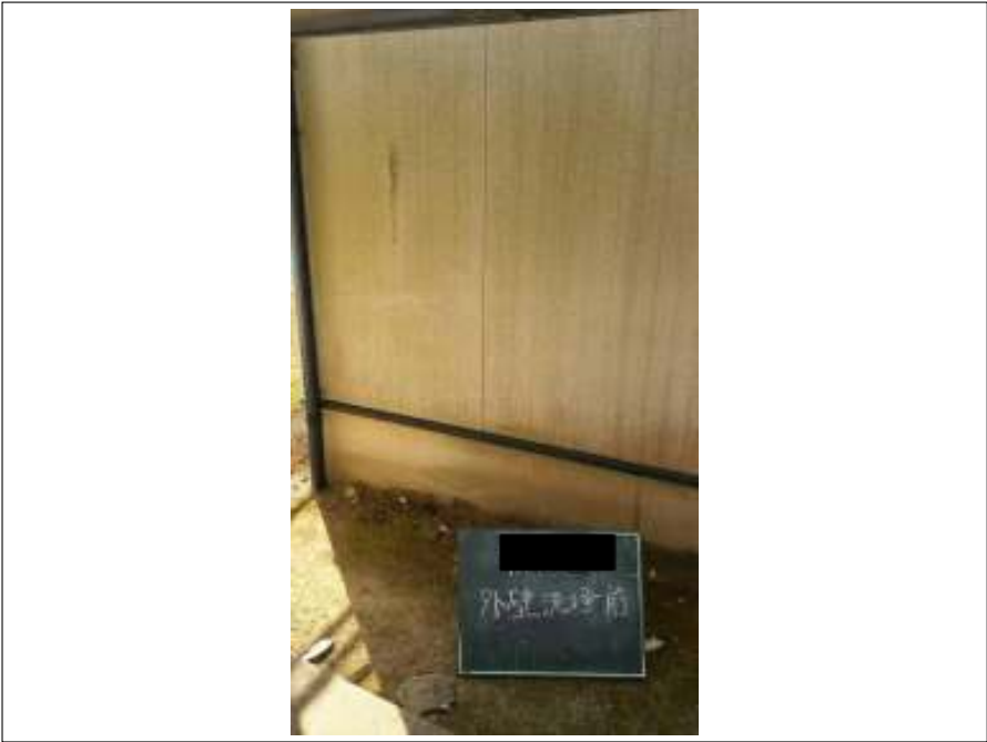
外壁 高圧洗浄前
