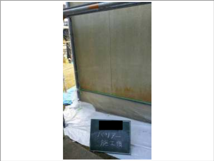
外壁 バリアー塗布施工後
