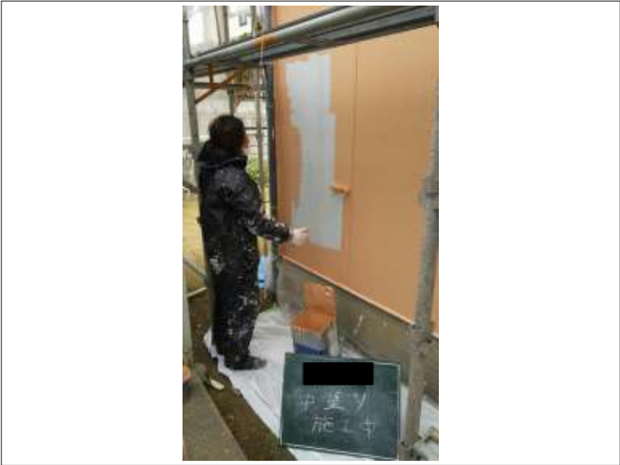
外壁 中塗り施工中
