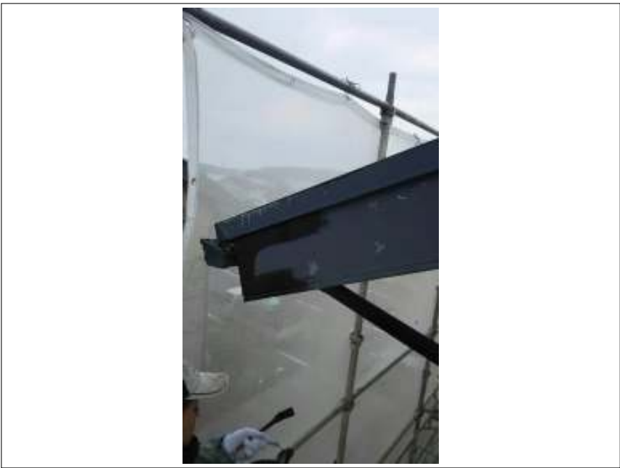
破風板 施工中
