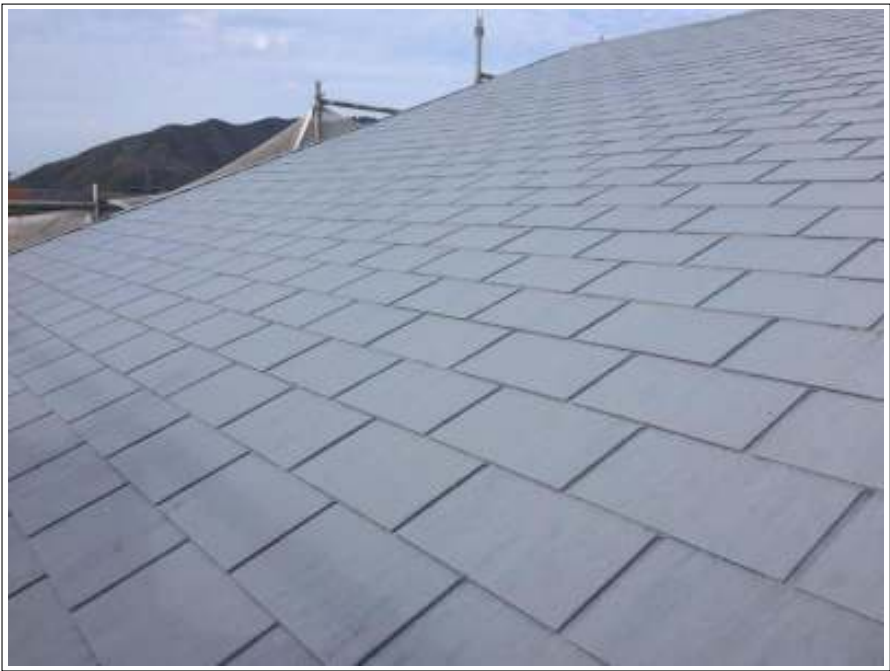
屋根 下塗り施工後
