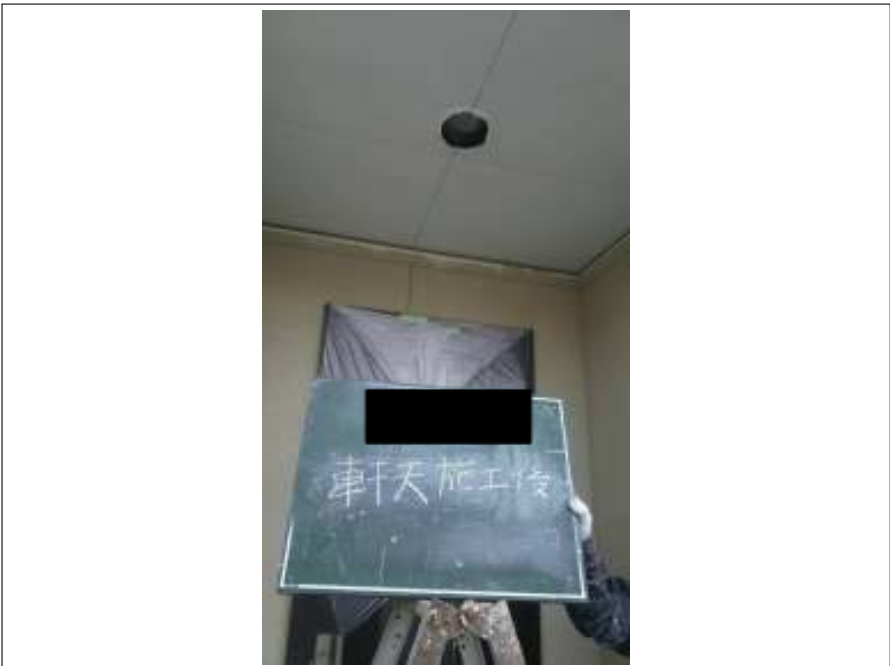
軒天 施工完了
