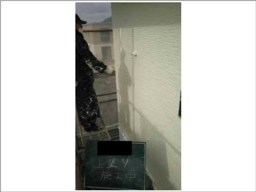
外壁 上塗り 施工中
