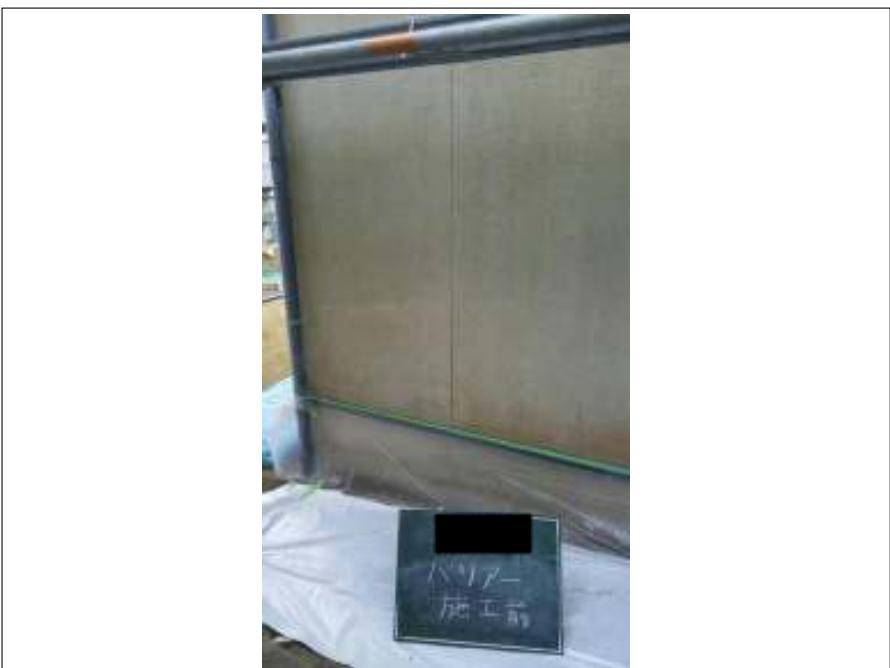
外壁 バリアー塗布施工前
