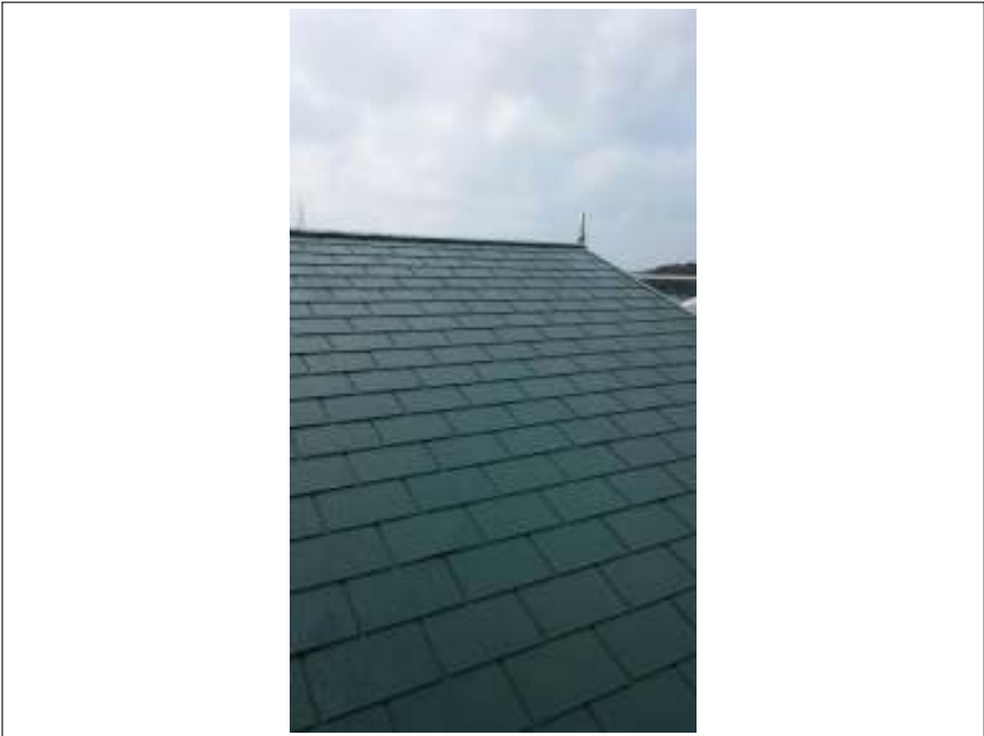
屋根 上塗り施工後
