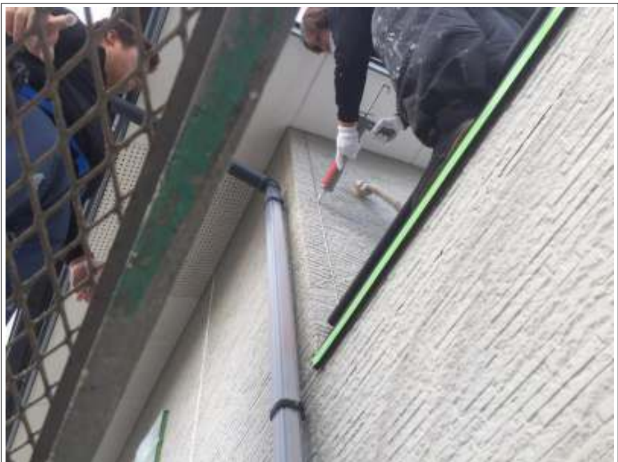
外壁 シーリング打ち替え施工中
