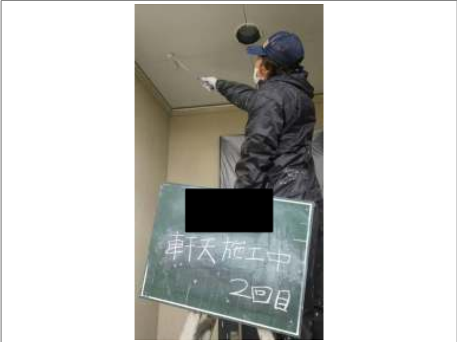
軒天 上塗り施工中 (2回目)
