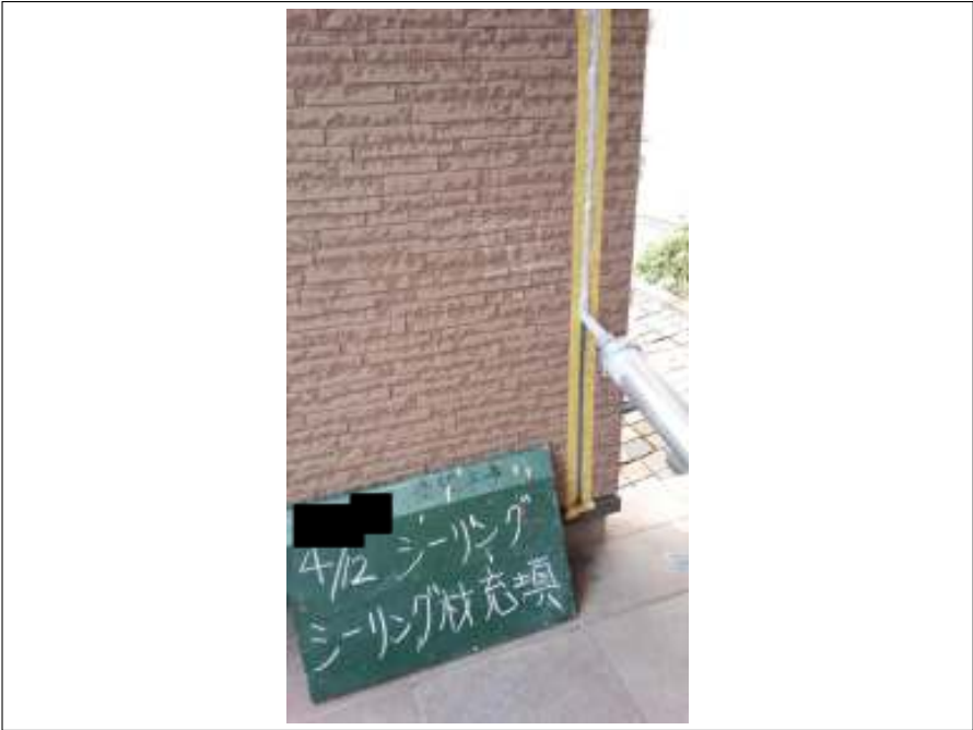
シーリング打ち替え 施工中
