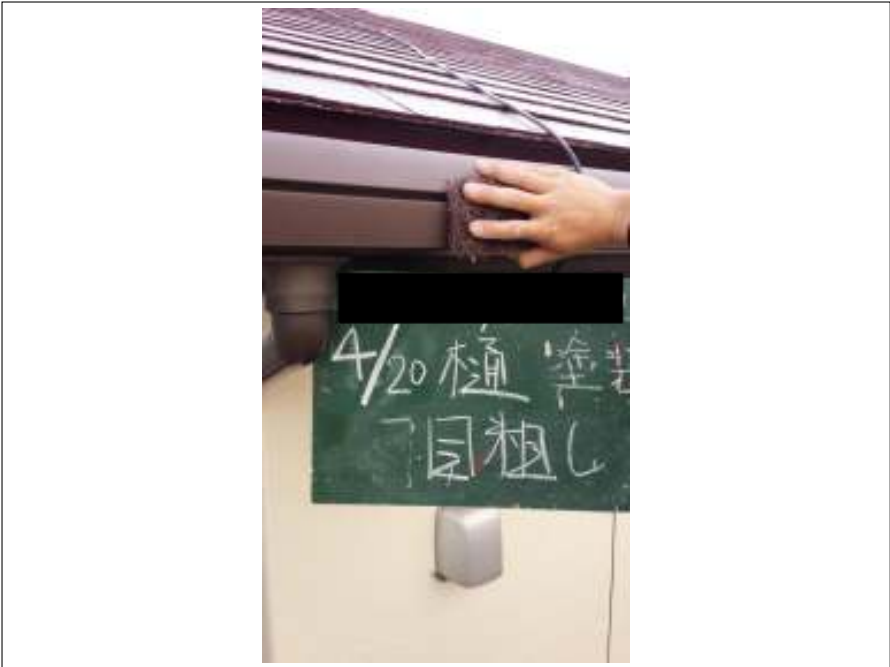
樋 下地処理施工中
