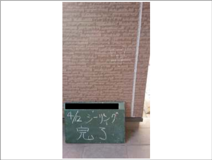
シーリング打ち替え 施工後
