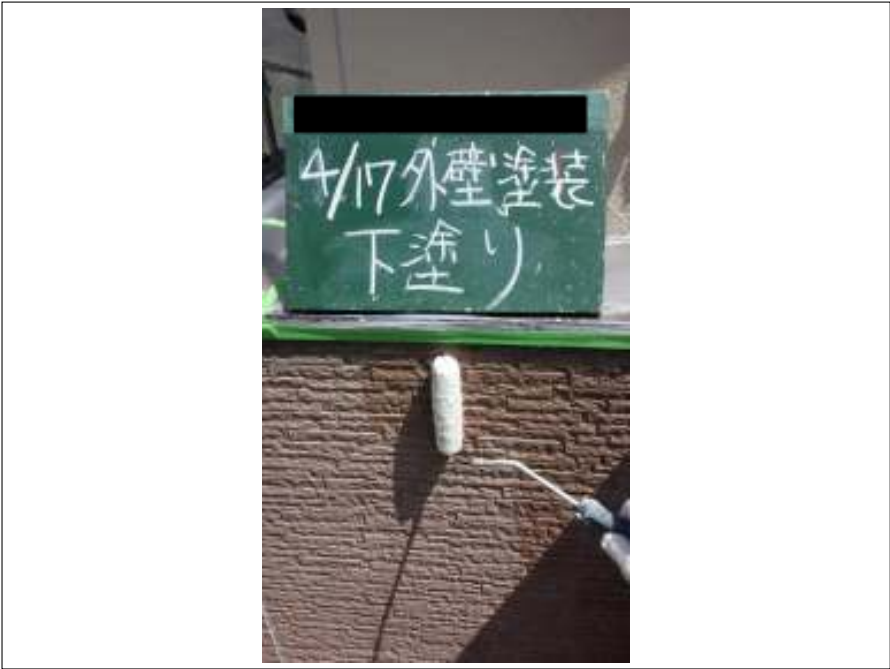
外壁（1F） 下塗り施工中
