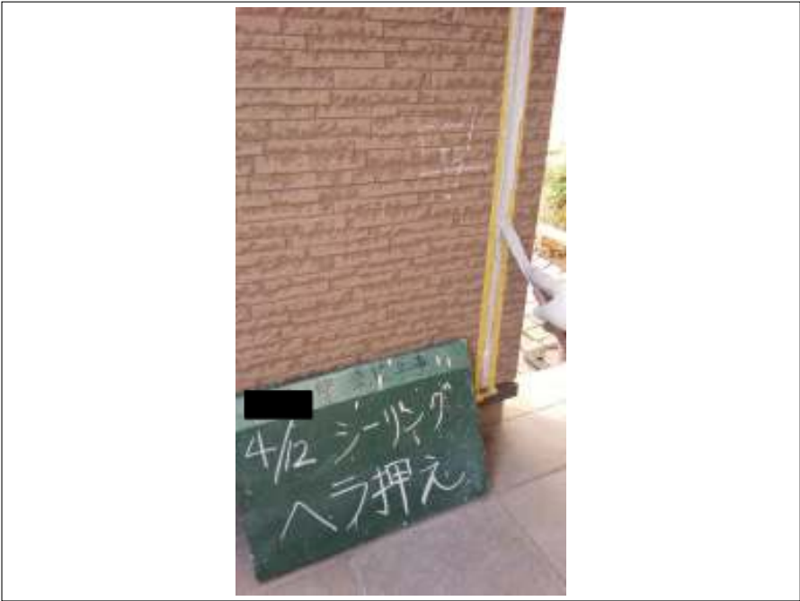
シーリング打ち替え 施工中
