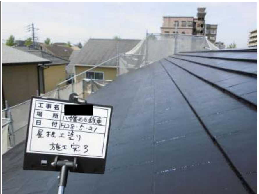
屋根 上塗り施工後
