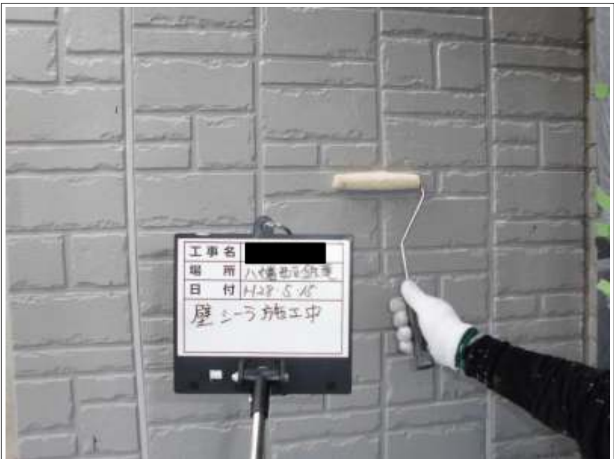
外壁 下塗り施工中
