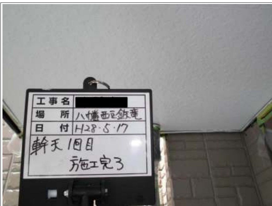
軒天 上塗り（1回目）施工後
