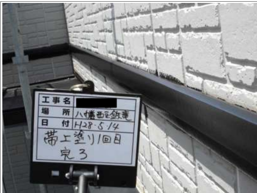
帯 上塗り（1回目）施工後
