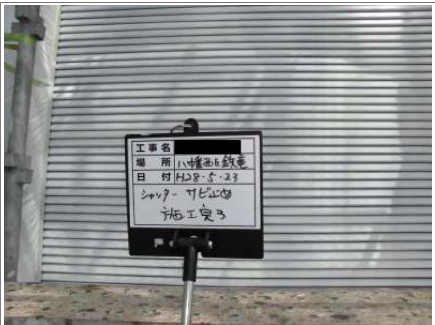
シャッター サビ止め塗布施工後
