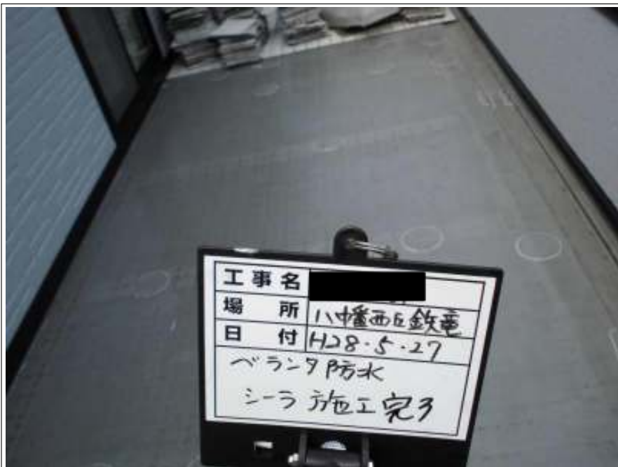
ベランダ防水 下塗り施工後
