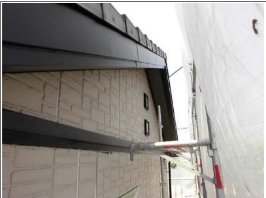
破風板 施工後
