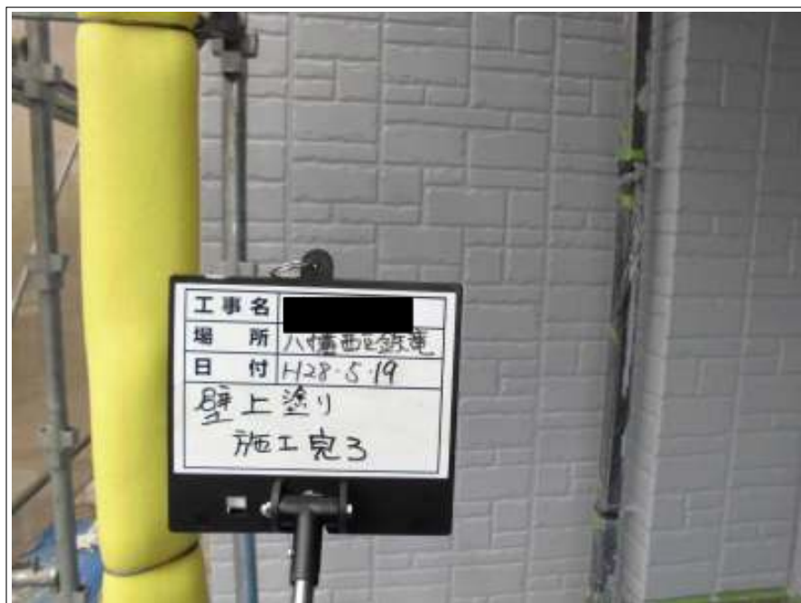
外壁 上塗り施工後
