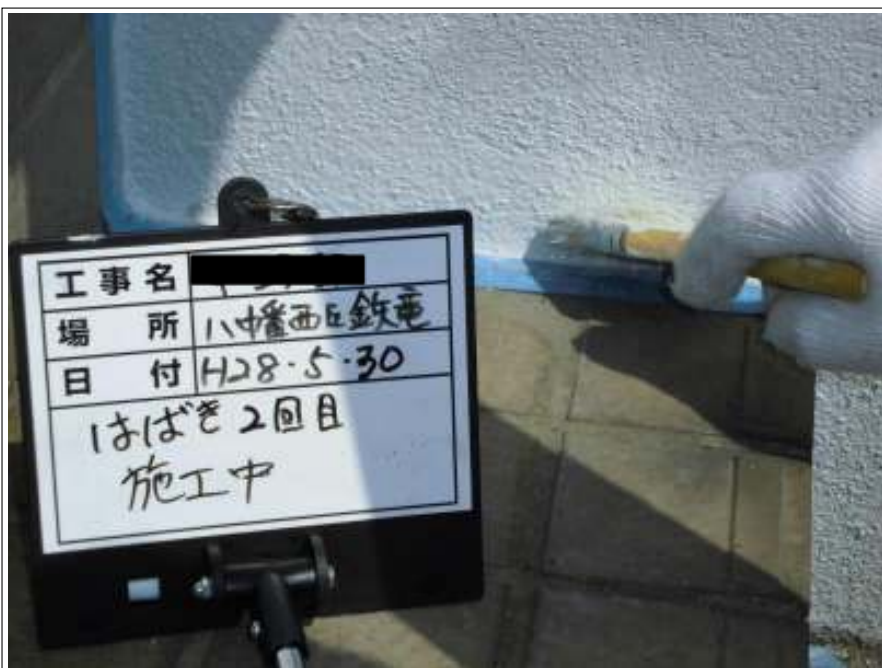
基礎塗り（2回目）施工中
