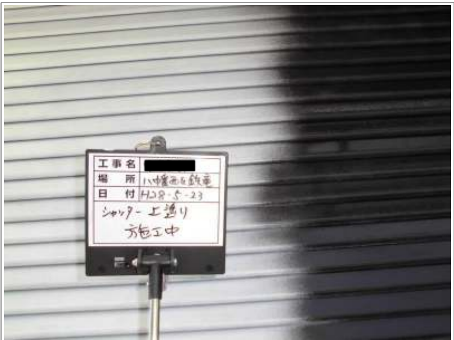
シャッター 上塗り施工中
