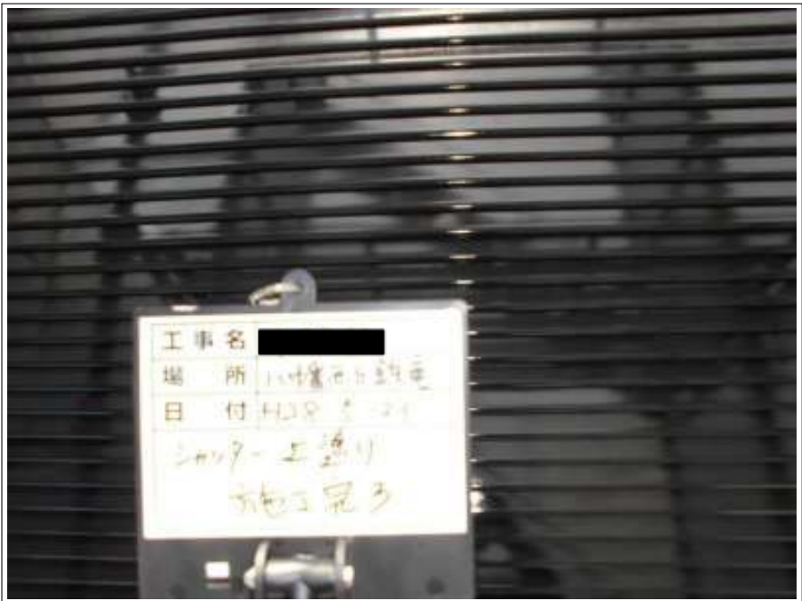
シャッター 上塗り施工後
