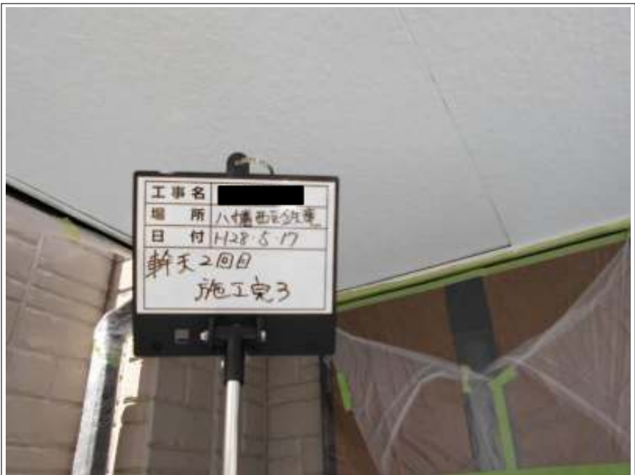
軒天 上塗り（2回目）施工後
