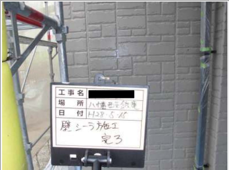
外壁 下塗り施工後
