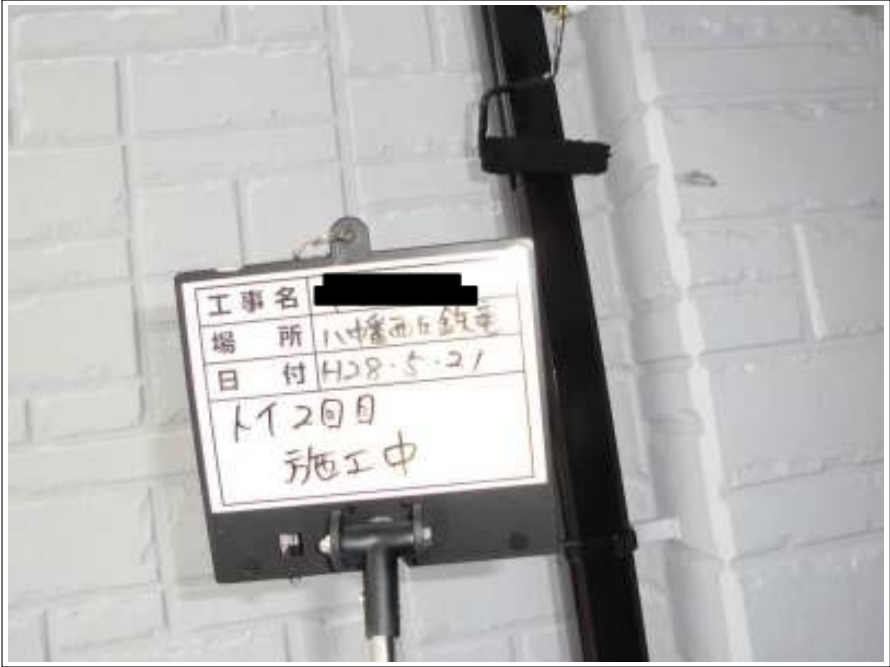
樋 上塗り（2回目）施工中
