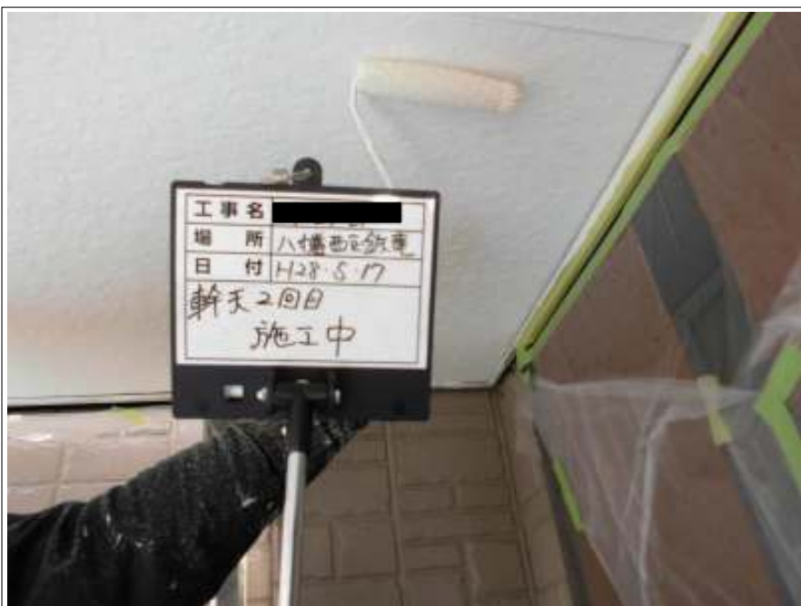
軒天 上塗り（2回目）施工中
