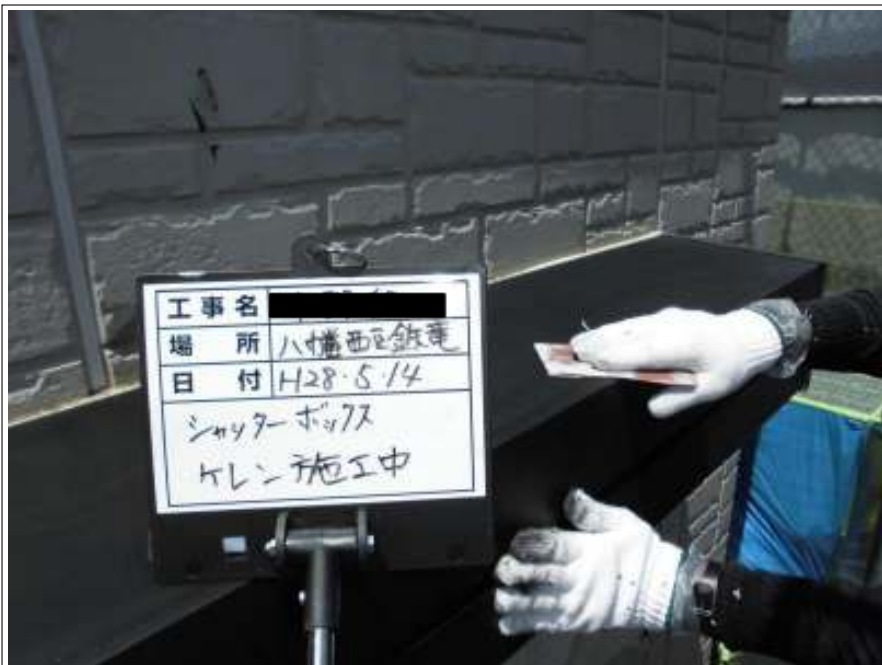
シャッターBOX ケレン処理施工中
