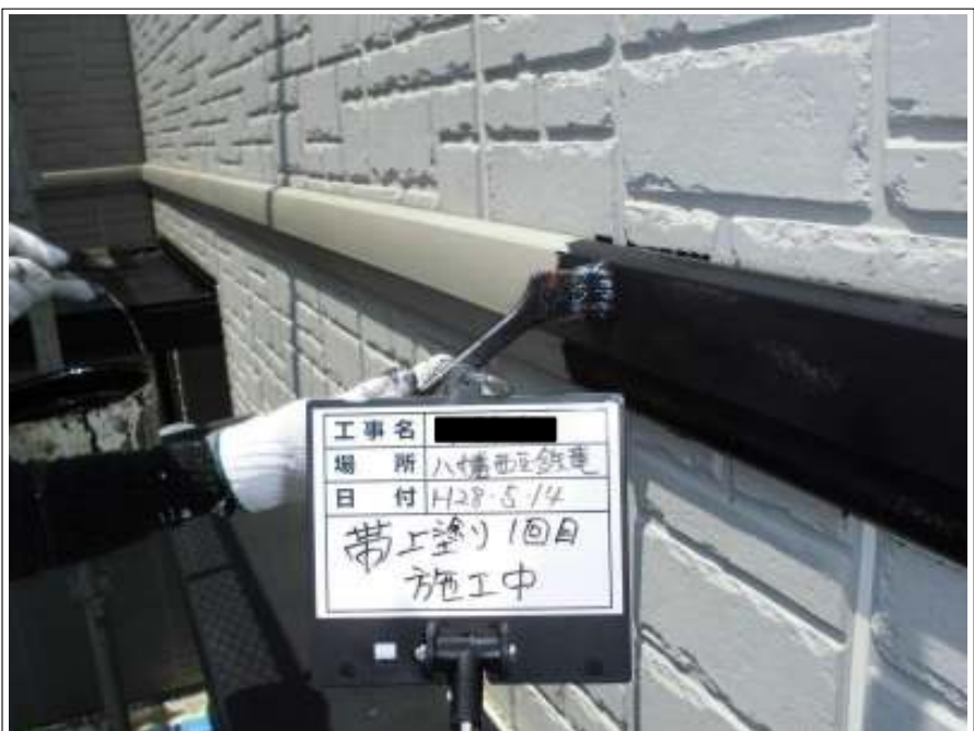
帯 上塗り（1回目）施工中
