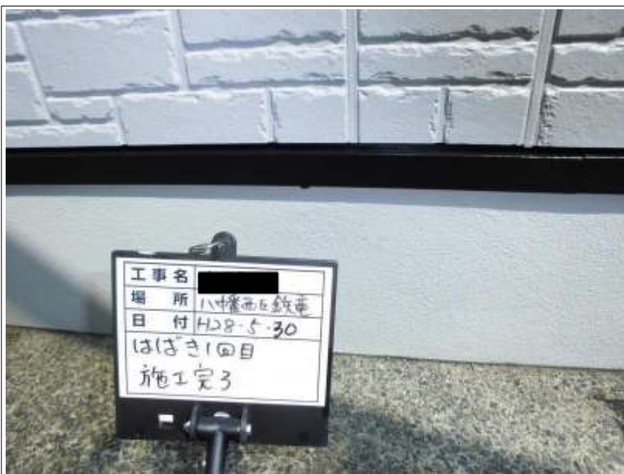
基礎塗り（1回目）施工後
