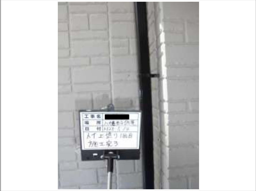
樋 上塗り（1回目）施工後
