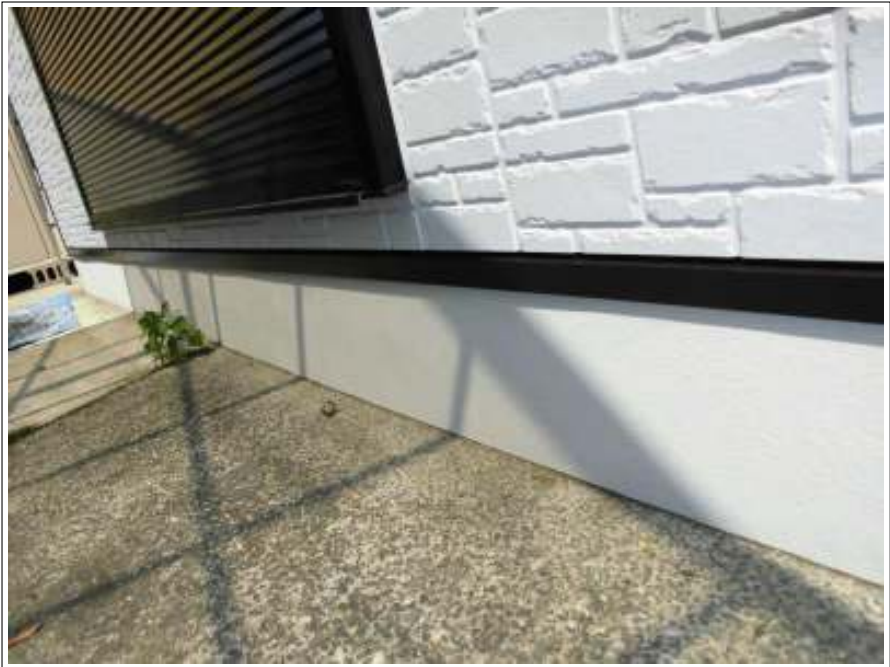
基礎塗り（2回目）施工後
