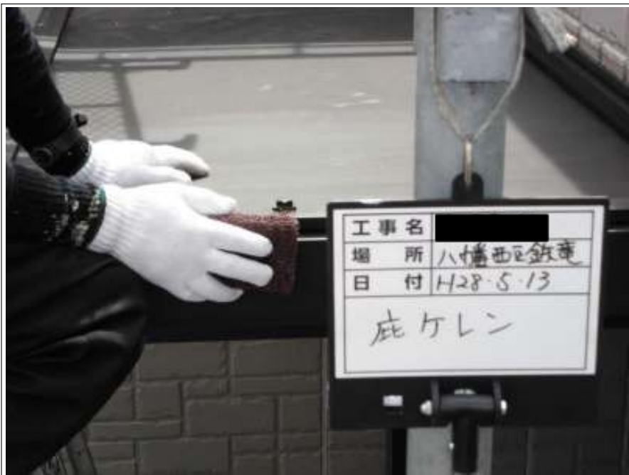
底 ケレン処理施工中
