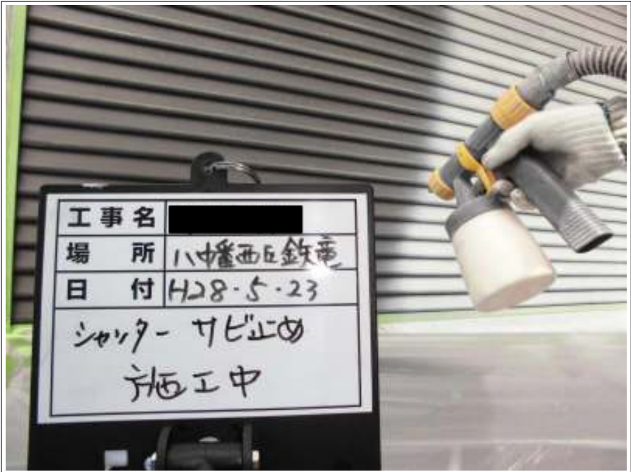
シャッター サビ止め塗布施工中
