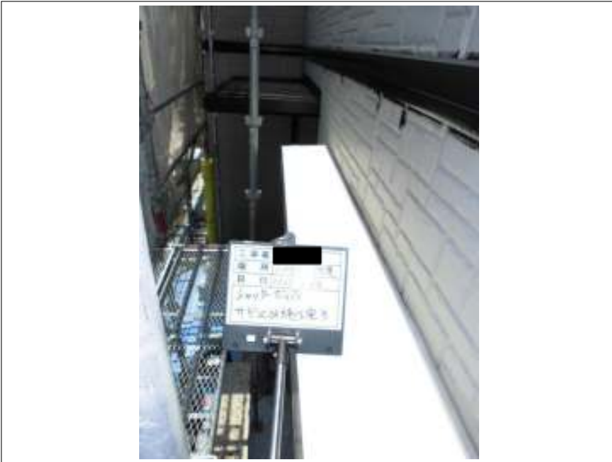
シャッターBOX サビ止め塗布施工後
