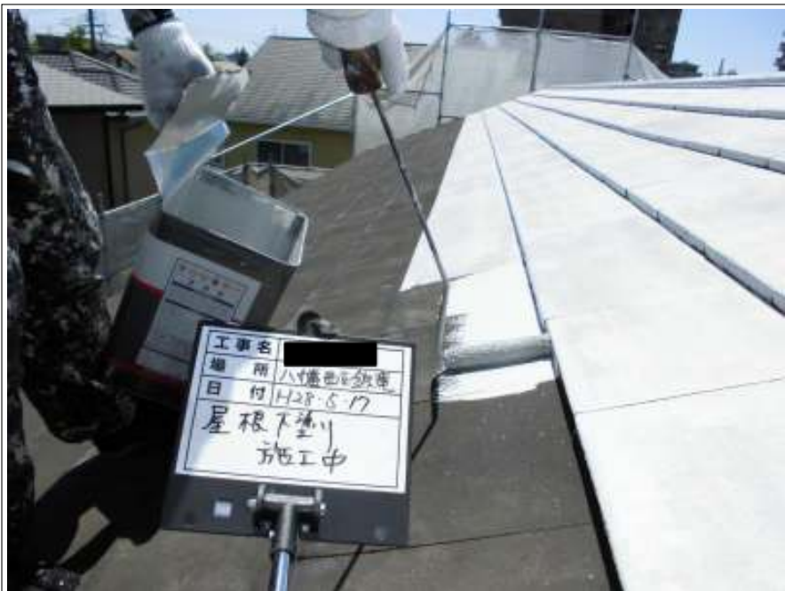
屋根 下塗り施工中
