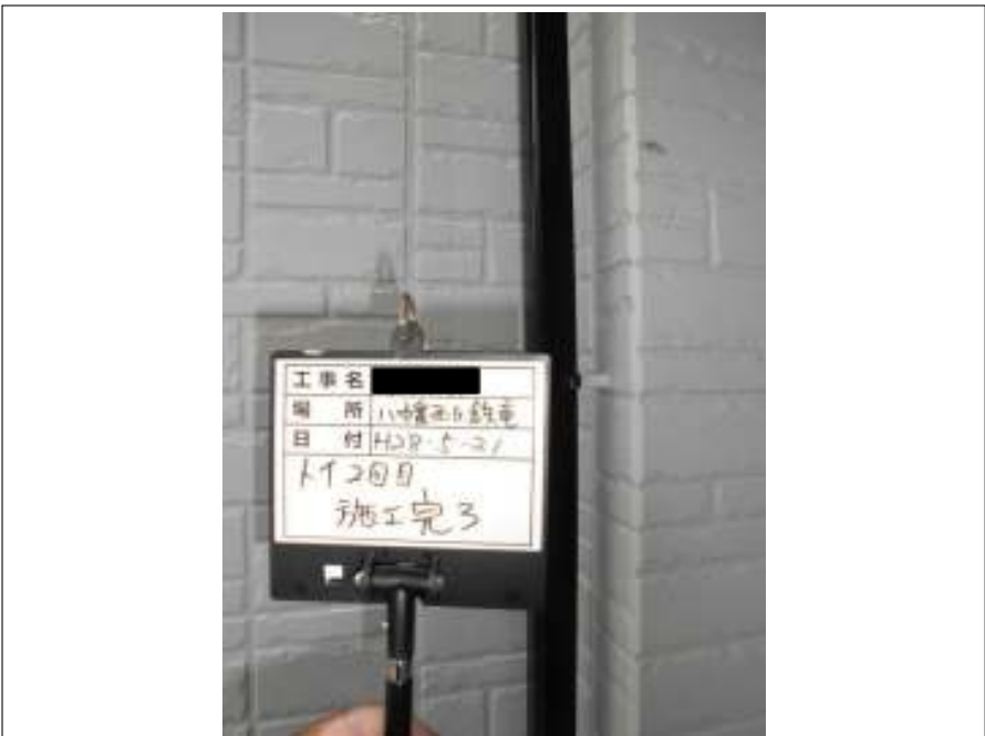
樋 上塗り（2回目）施工後
