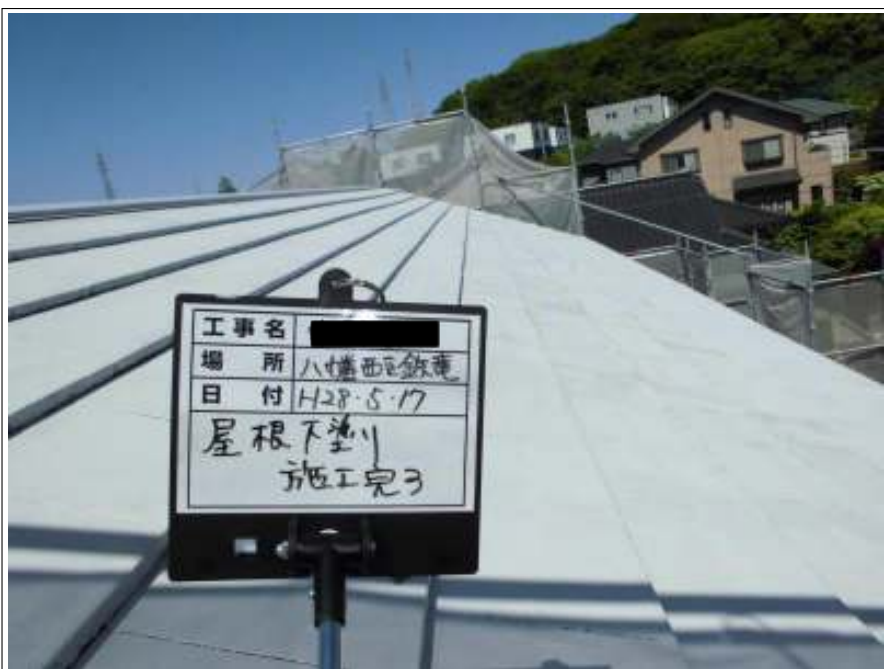
屋根 下塗り施工後
