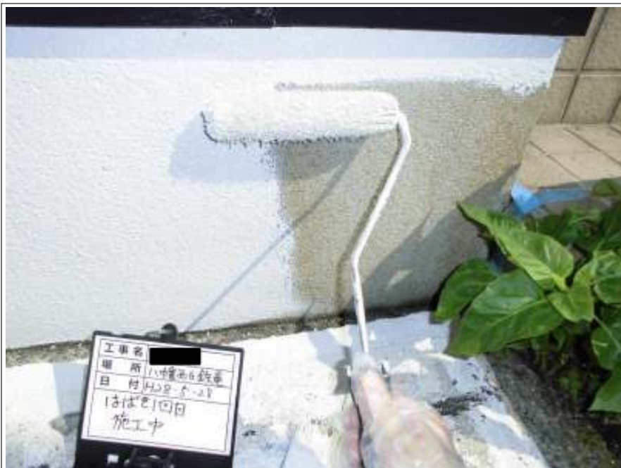
基礎塗り（1回目）施工中
