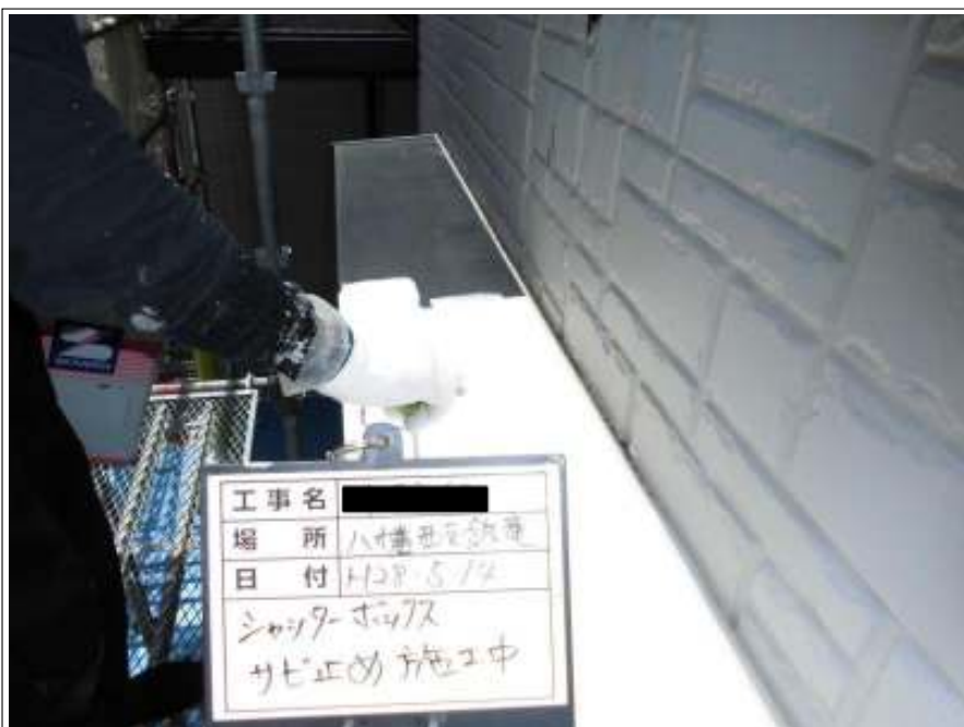
シャッターBOX サビ止め塗布施工中
