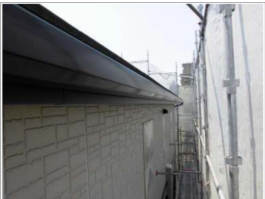
破風板 施工後
