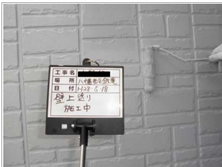
外壁 上塗り施工中
