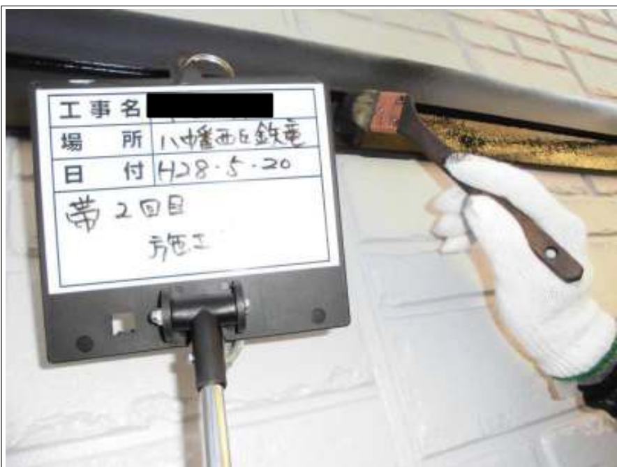
帯 上塗り（2回目）施工中
