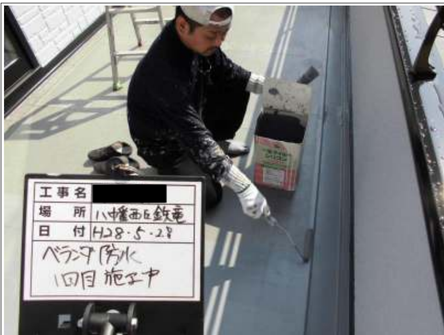
ベランダ防水 上塗り（1回目）施工中
