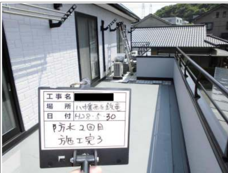
ベランダ防水 上塗り（2回目）施工後
