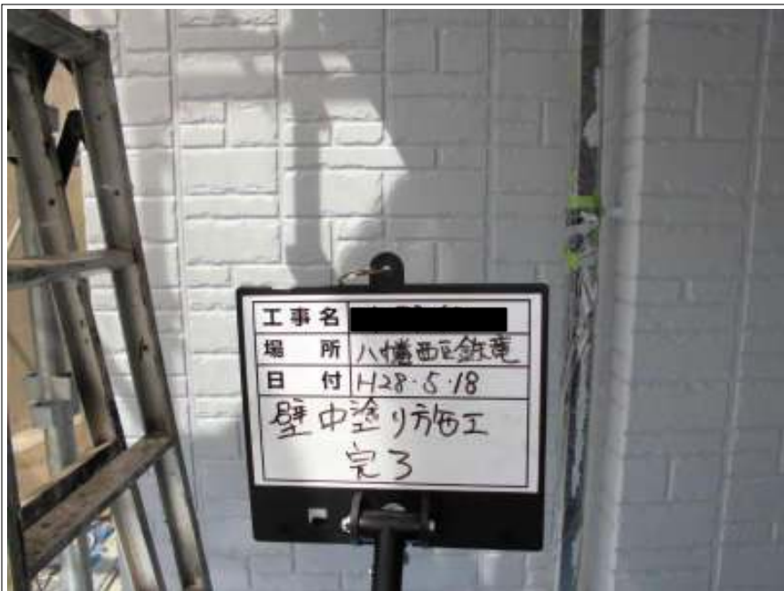
外壁 中塗り施工後
