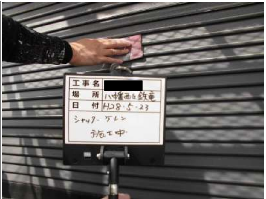
シャッター ケレン処理施工中
