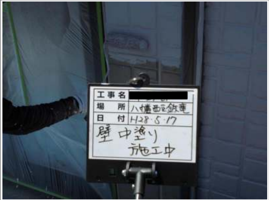
外壁 中塗り施工中
