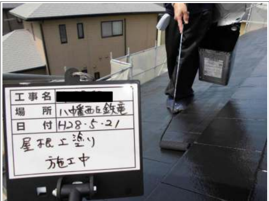
屋根 上塗り施工中
