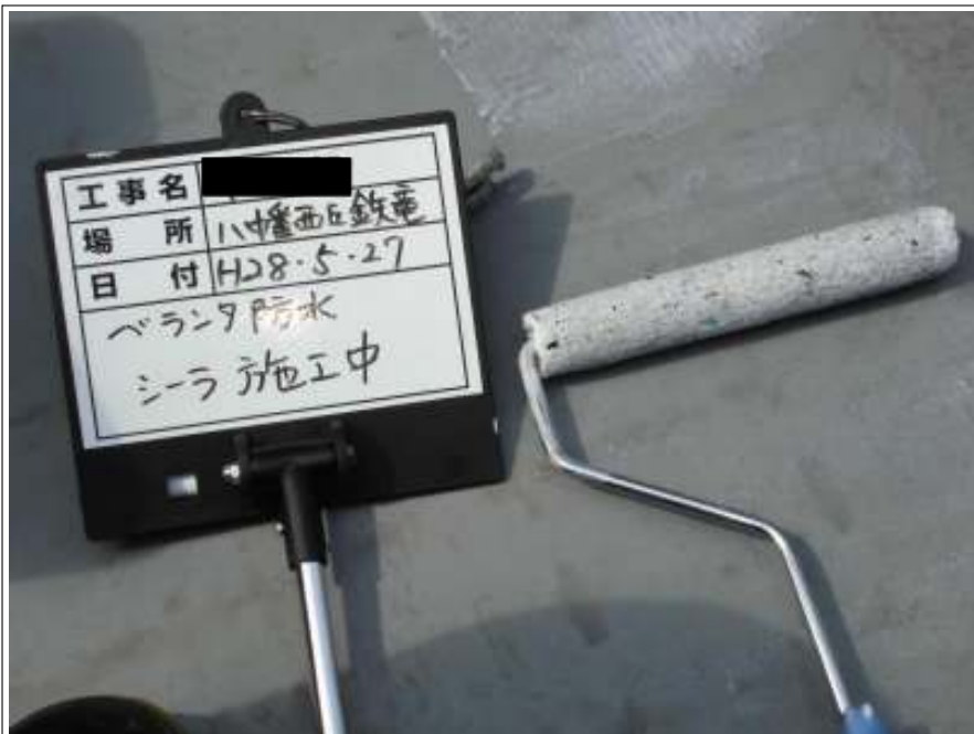
ベランダ防水 下塗り施工中
