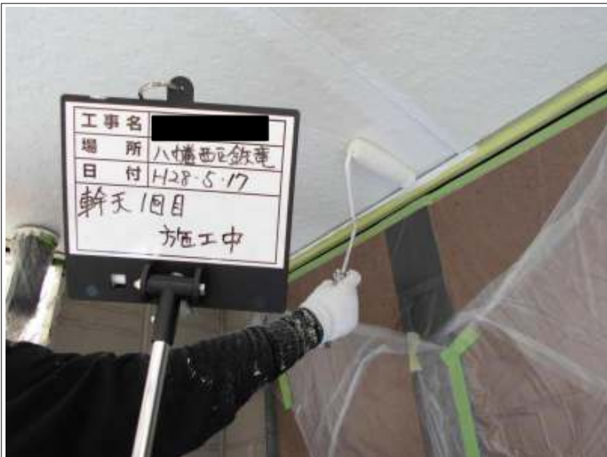
軒天 上塗り（1回目）施工中
