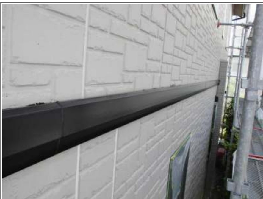
帯 上塗り（2回目）施工後
