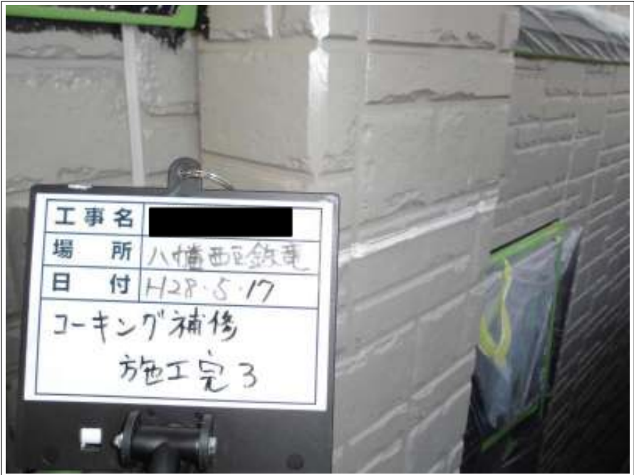
コーキング打ち替え 施工後
