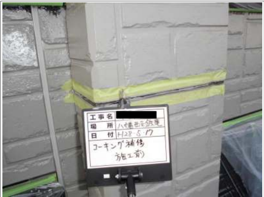
コーキング打ち替え 施工前
