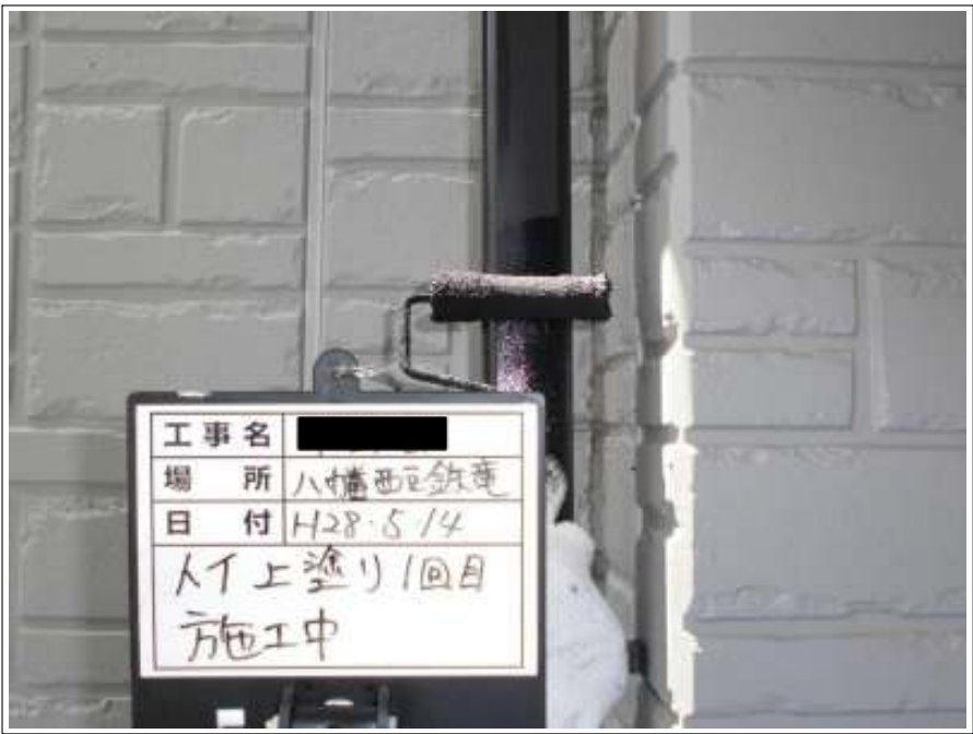
樋 上塗り（1回目）施工中
