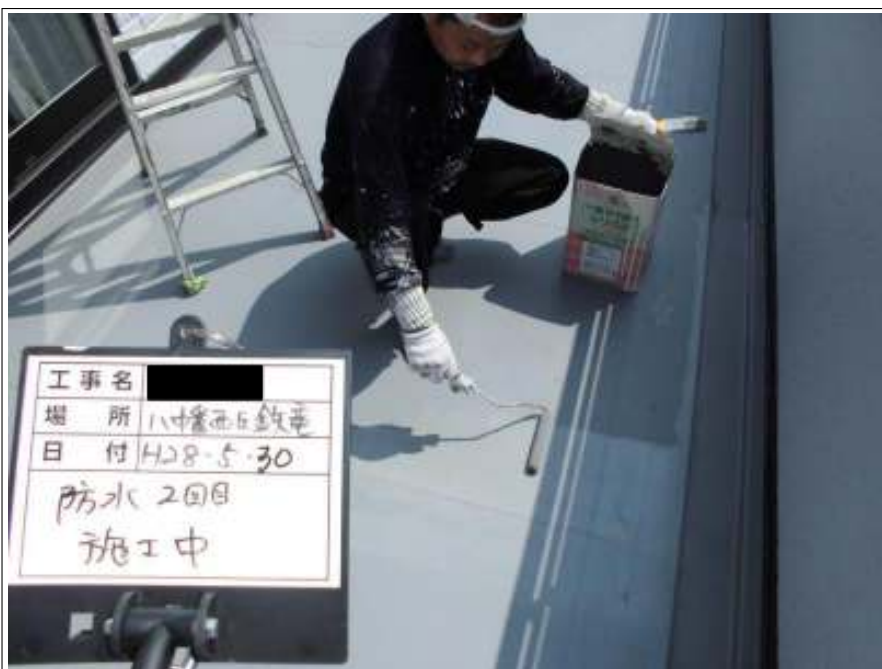
ベランダ防水 上塗り（2回目）施工中
