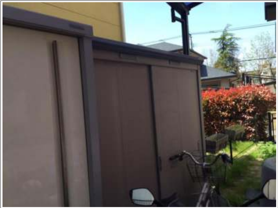
倉庫屋根 一カ所
