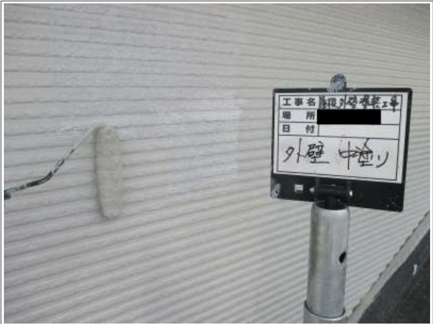
外壁 中塗り施工中
