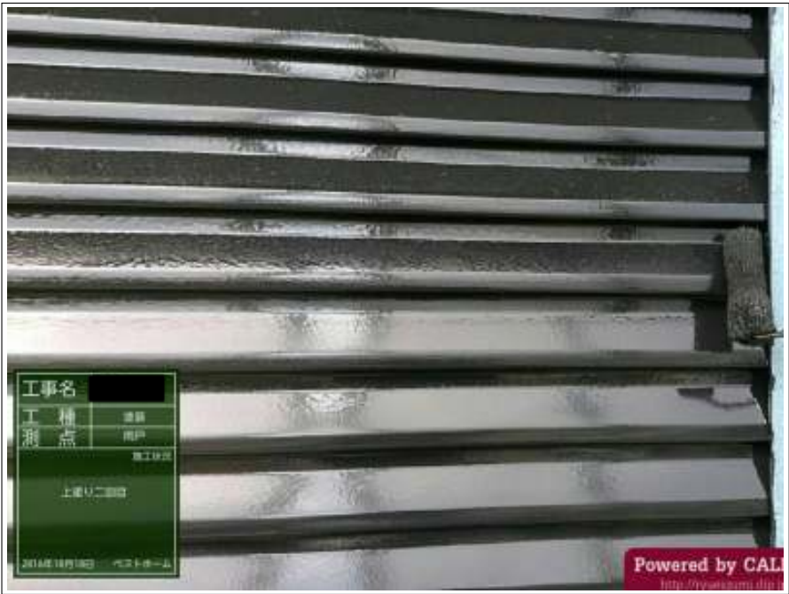
シャッター 上塗り(2回目)施工中
