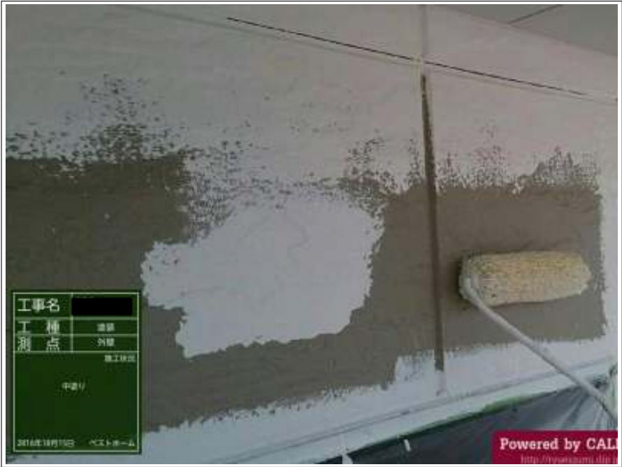
外壁 中塗り施工中
