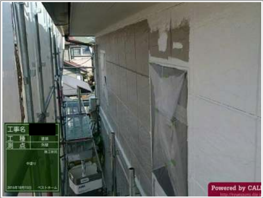
外壁 中塗り施工中
