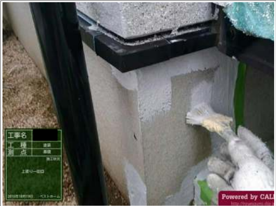
基礎塗り（1回目）施工中
