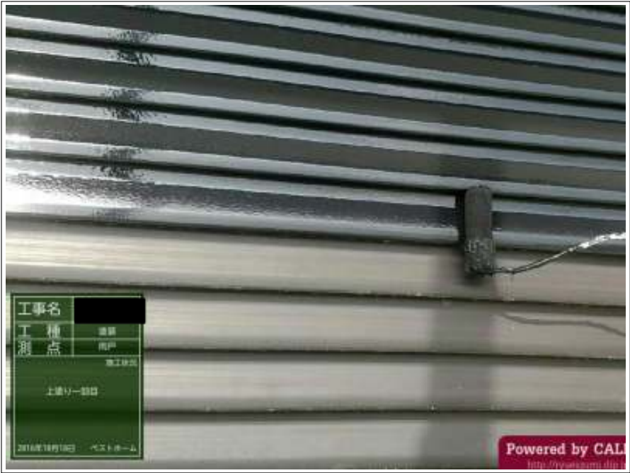
シャッター 上塗り(1回目)施工中
