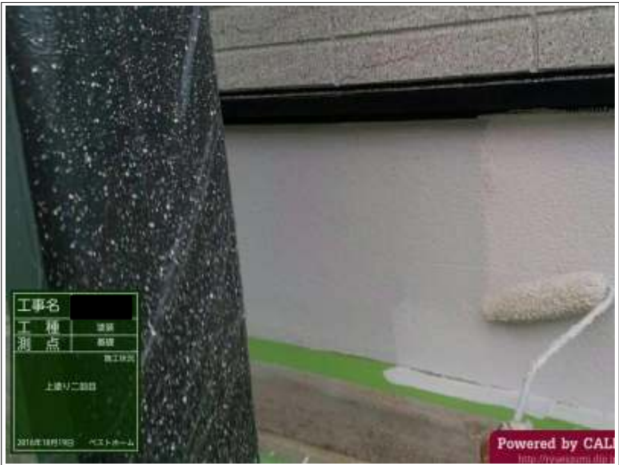
基礎塗り（2回目）施工中
