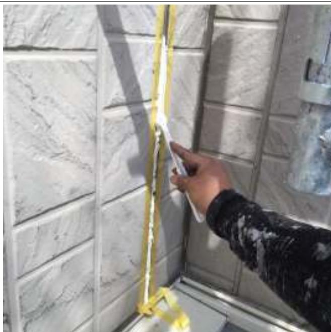
外壁 シーリング打ち替え施工中
