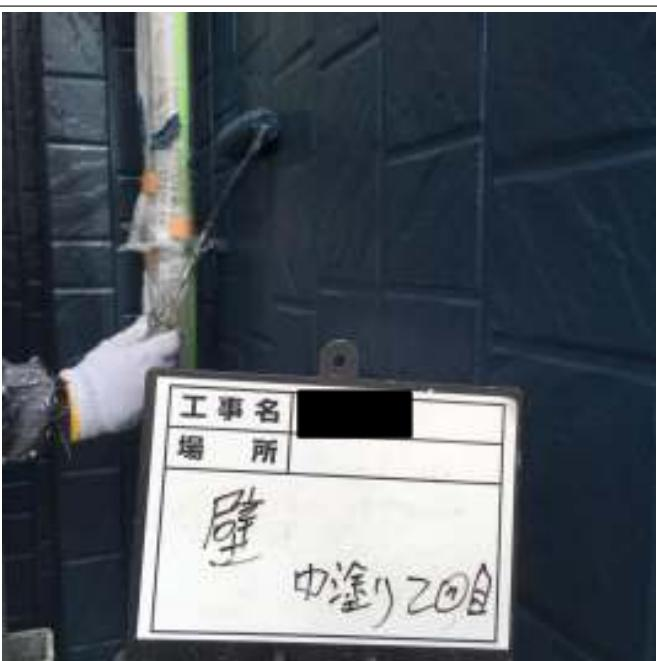
外壁 中塗り施工中（2回目）
