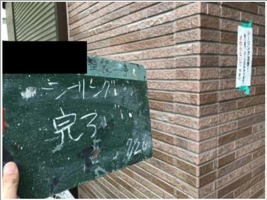
シーリング打ち替え 施工完了
