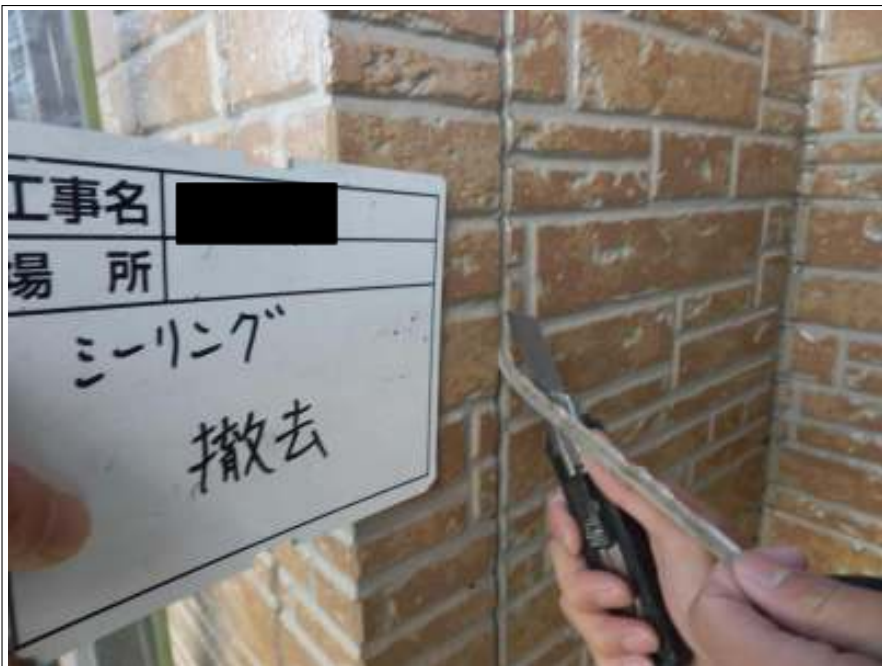
既存シーリング撤去
