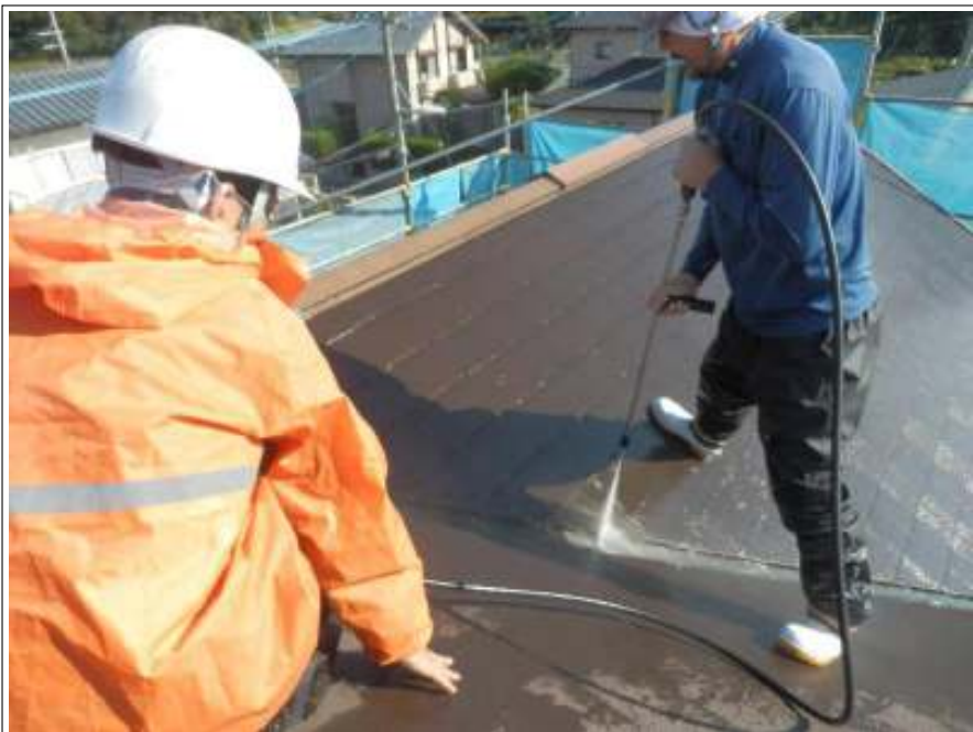
屋根 高圧洗浄中
