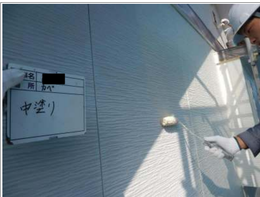
外壁 中塗り施工中
