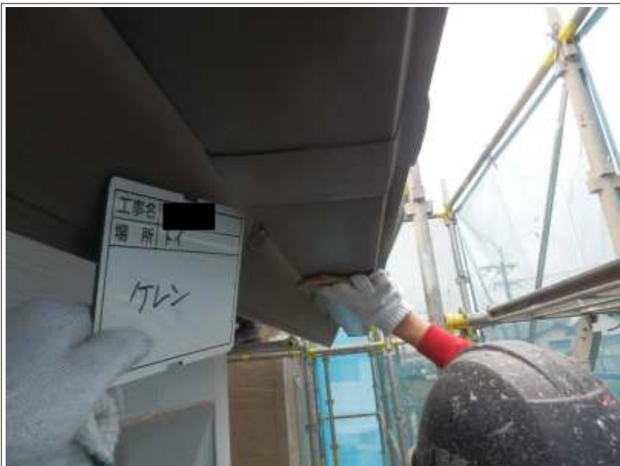
樋 ケレン処理施工中
