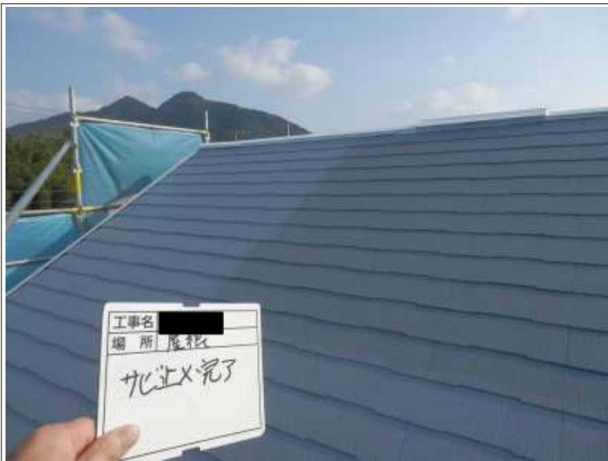
屋根板金部 サビ止め塗布後
