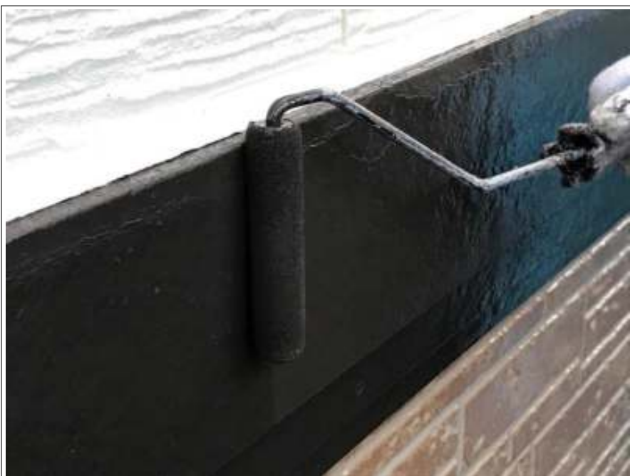
帯 上塗り施工中
