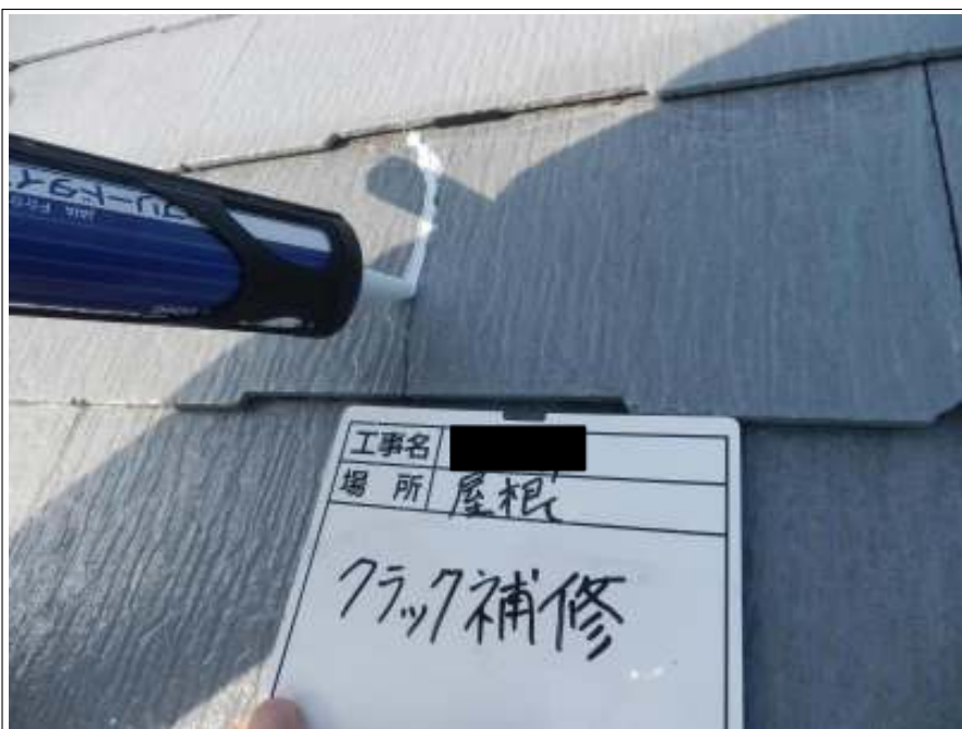
屋根 クラック補修施工中
