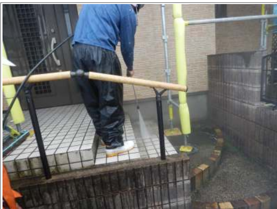
玄関部 高圧洗浄中
