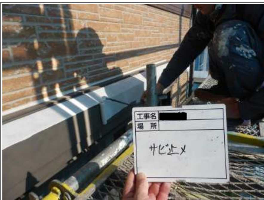
シャッター サビ止め塗布施工中
