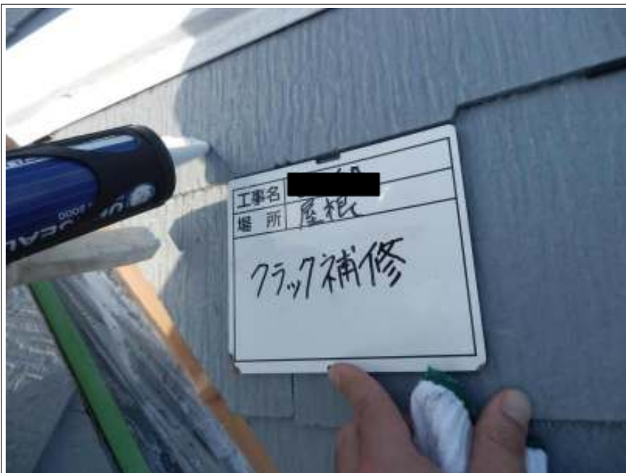
屋根 クラック補修施工中
