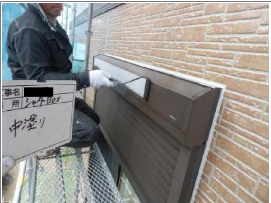
シャッター 中塗り施工中
