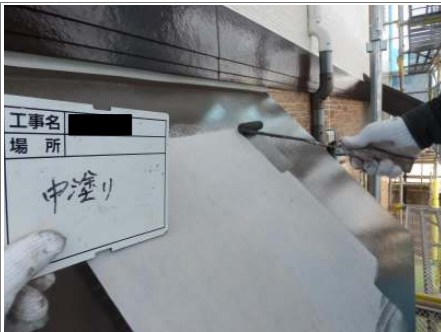
小庇 中塗り施工中
