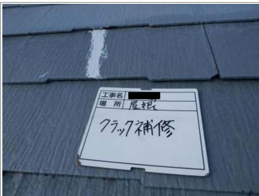
屋根 クラック補修施工後
