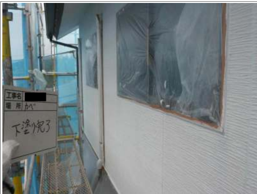
外壁 下塗り施工後
