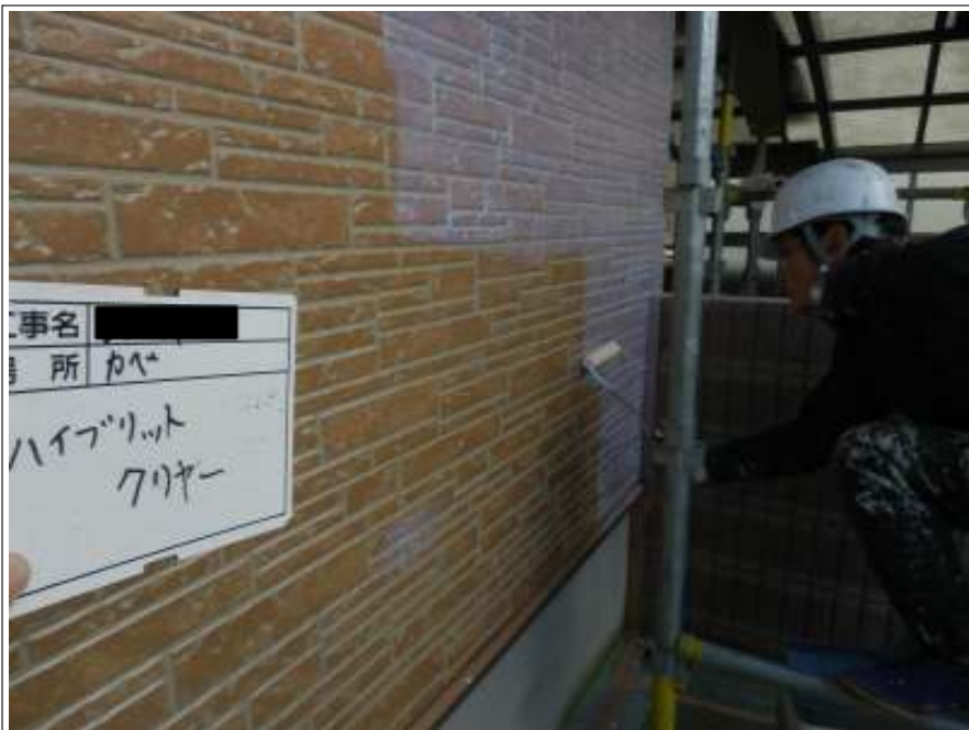
外壁(クリヤー部) 上塗り施工中
