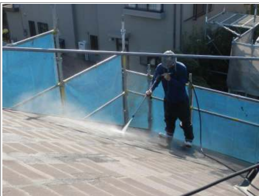
屋根 高圧洗浄中
