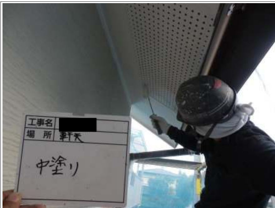
軒天 中塗り施工中
