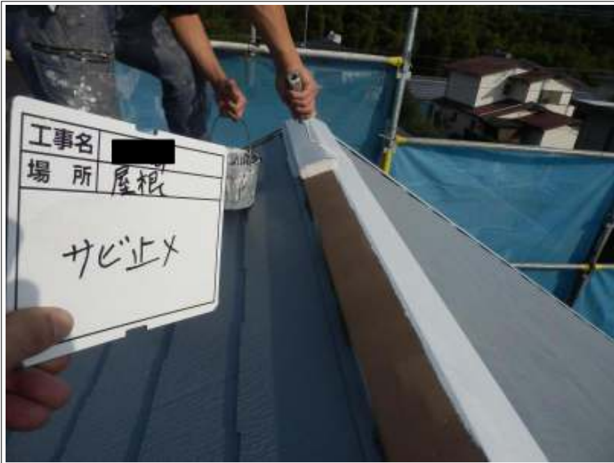
屋根板金部 サビ止め塗布
