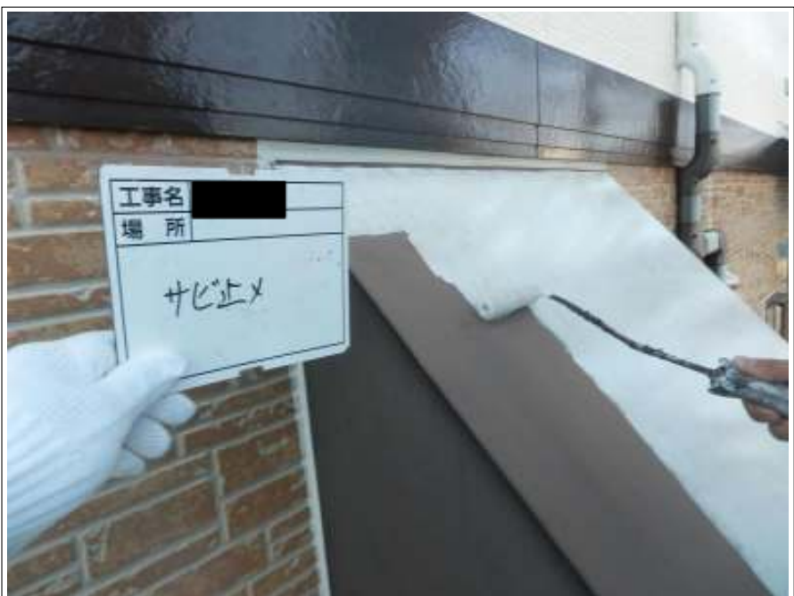
小庇 サビ止め塗布施工中
