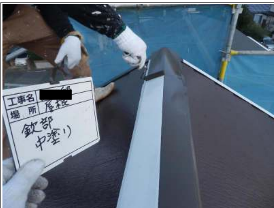
屋根板金部 中塗り施工中
