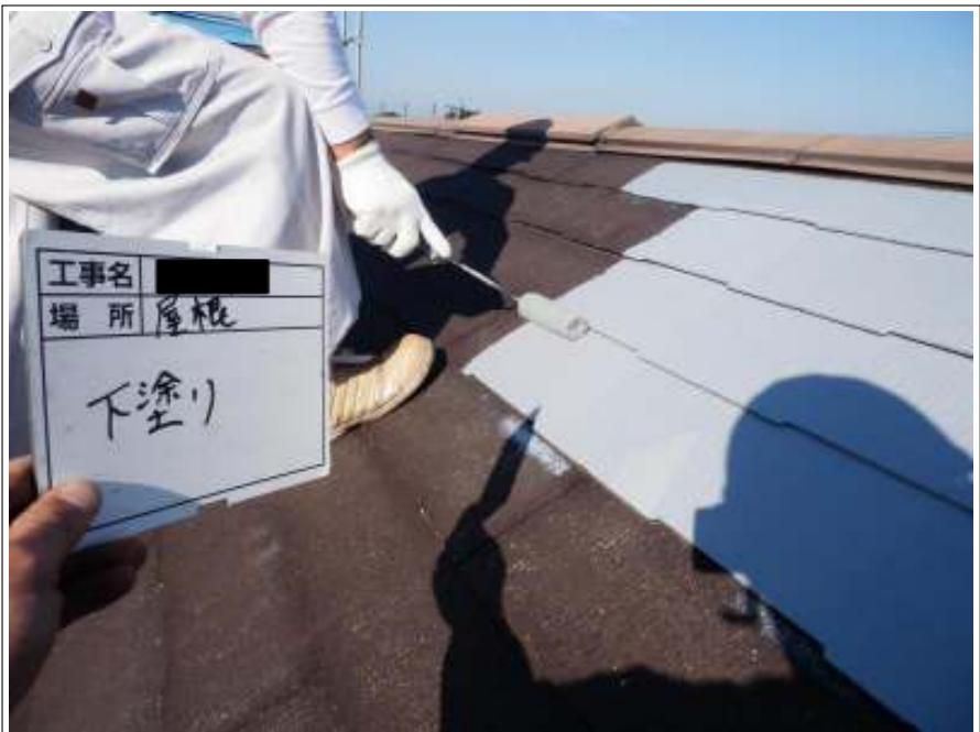
屋根 下塗り施工中
