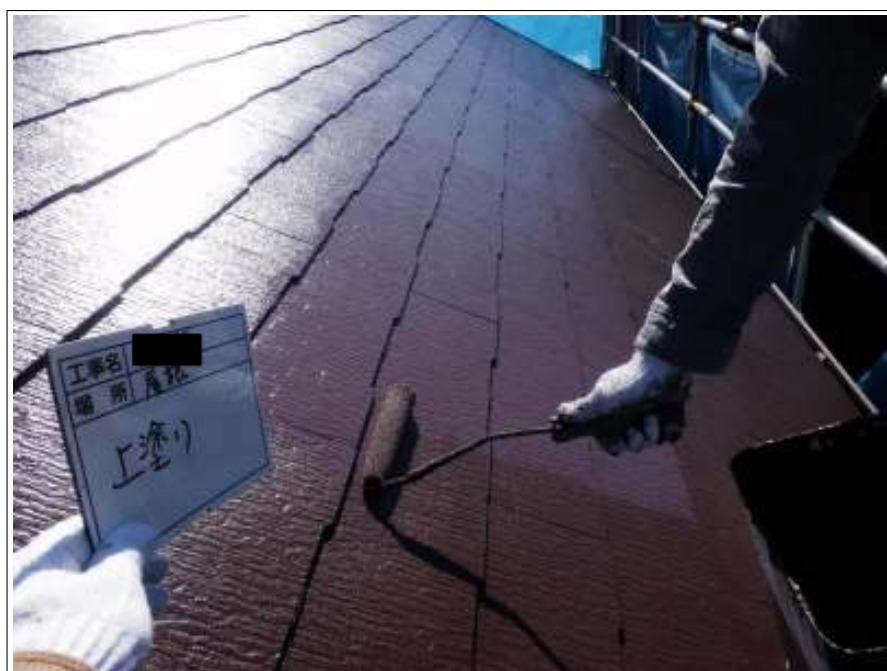
屋根 上塗り施工中
