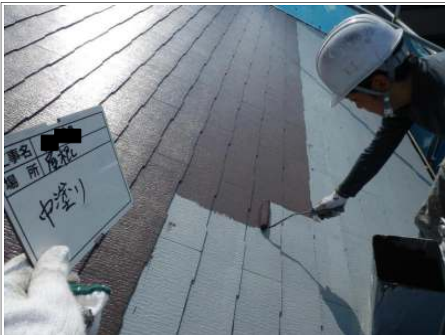
屋根 中塗り施工中
