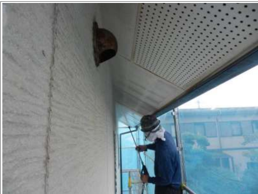
軒天 高圧洗浄中
