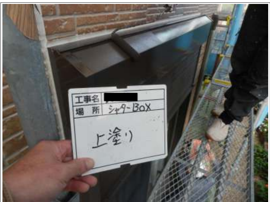
シャッター 上塗り施工中
