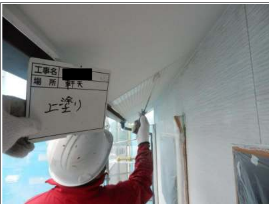
軒天 上塗り施工中
