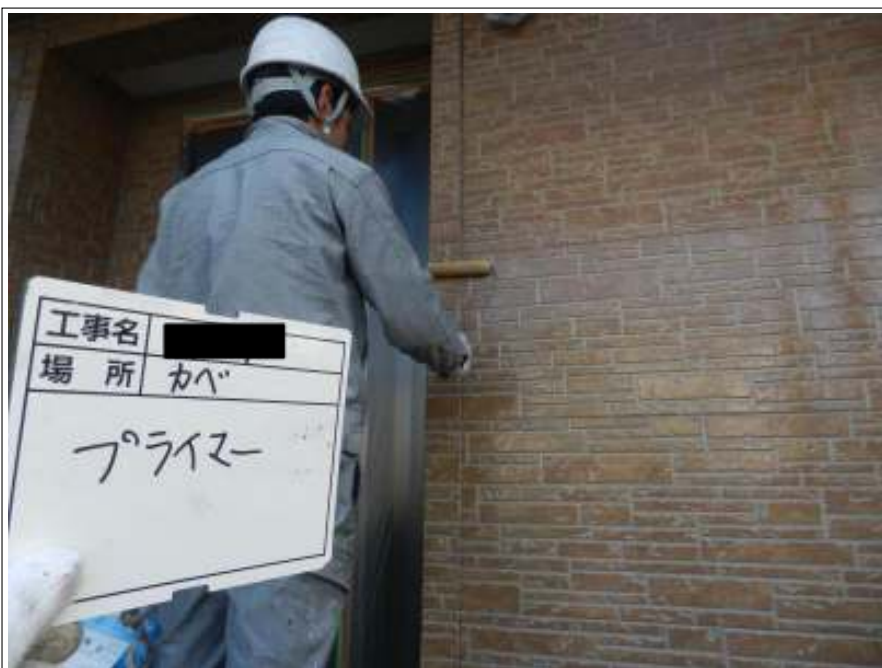
外壁(クリヤー部) 下塗り施工中
