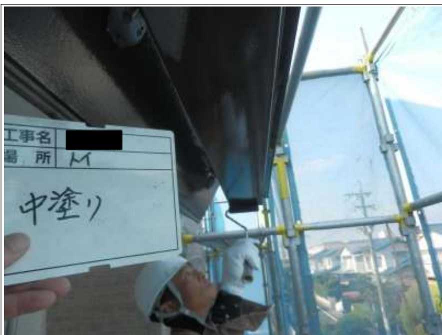
樋 中塗り施工中
