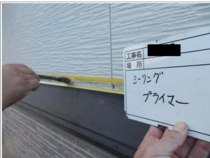
プライマー塗布
