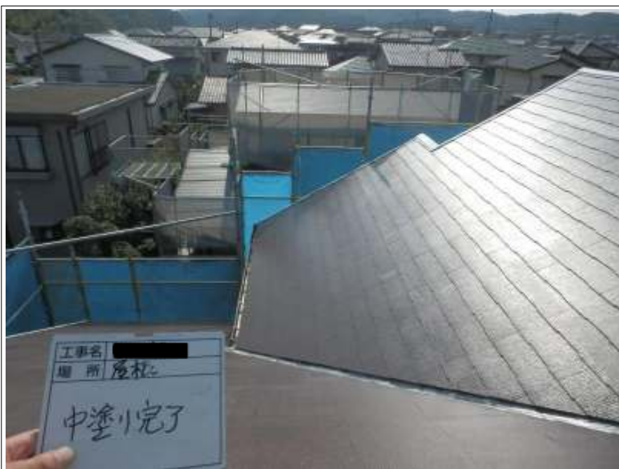
屋根 中塗り施工後
