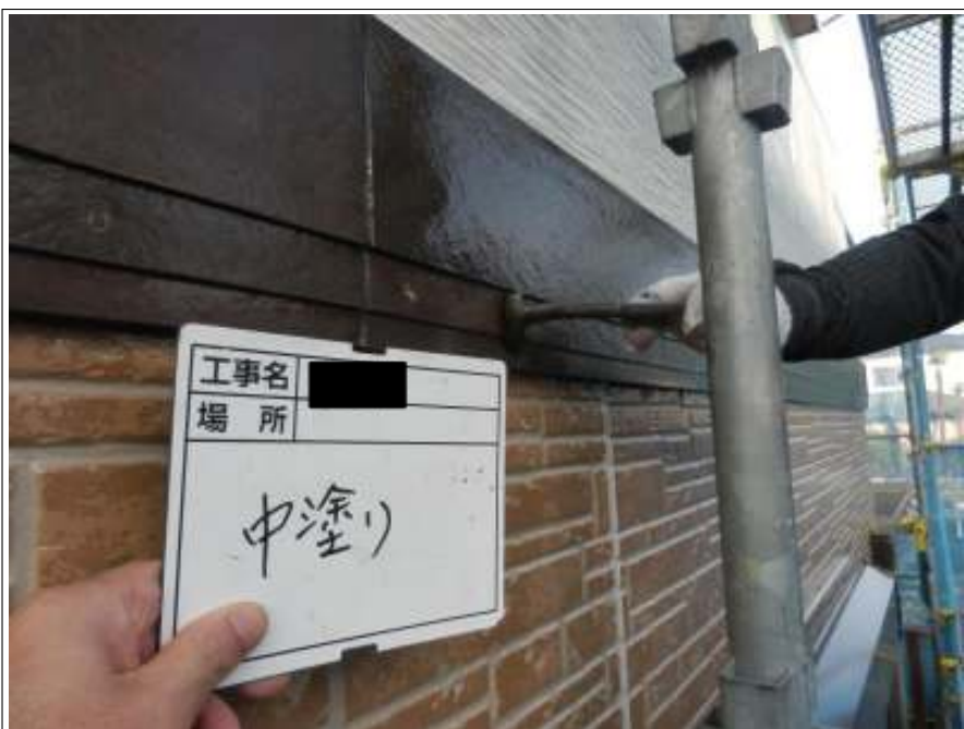
帯 中塗り施工中
