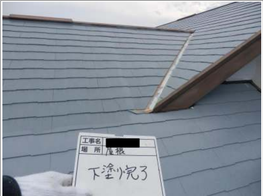
屋根 下塗り施工後
