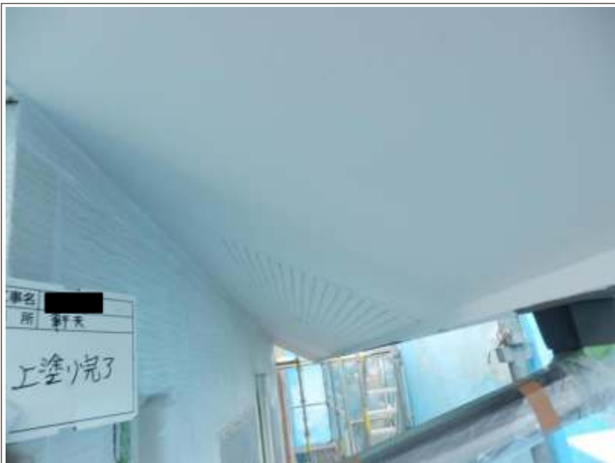
軒天 上塗り施工後
