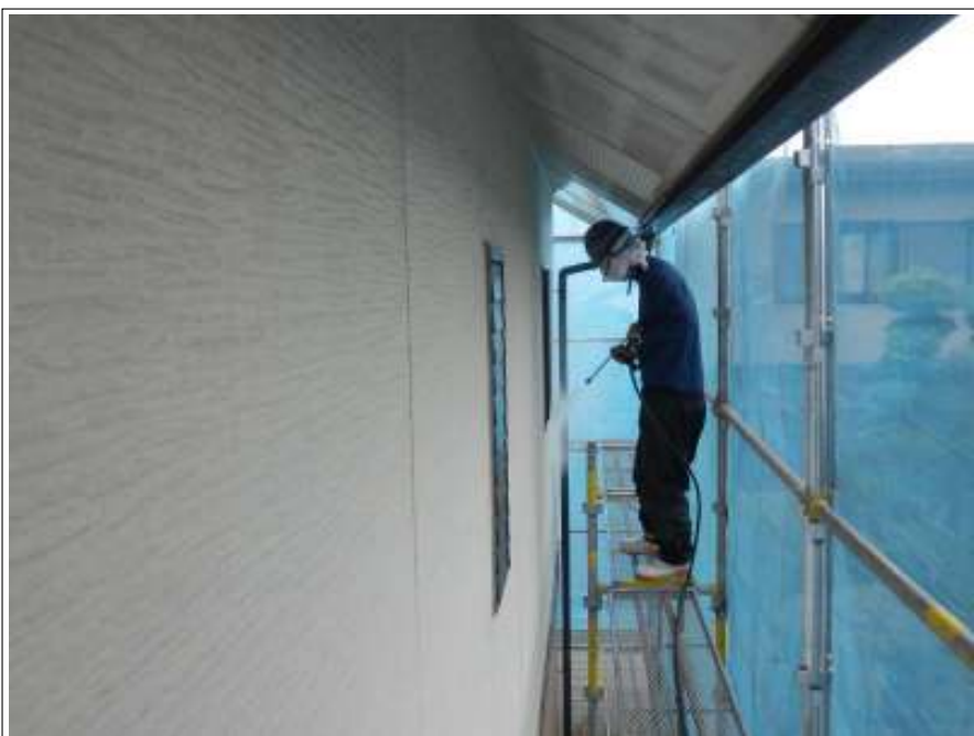
外壁 高圧洗浄中
