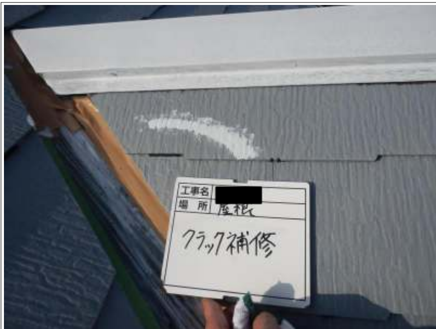
屋根 クラック補修施工後
