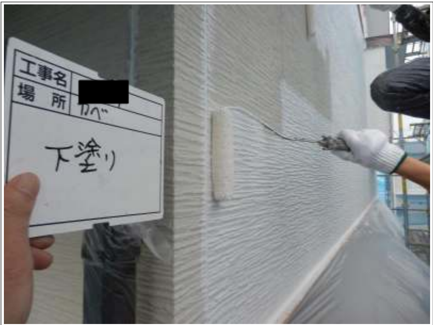
外壁 下塗り施工中
