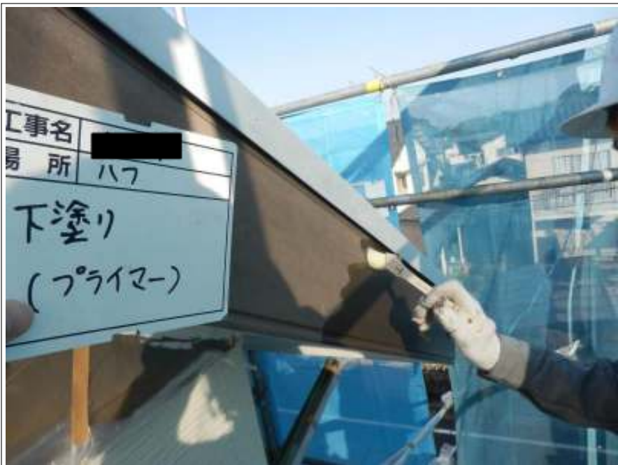
破風板 下塗り施工中
