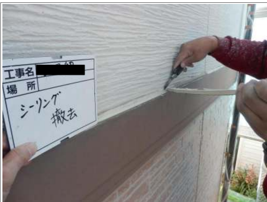
既存シーリング撤去
