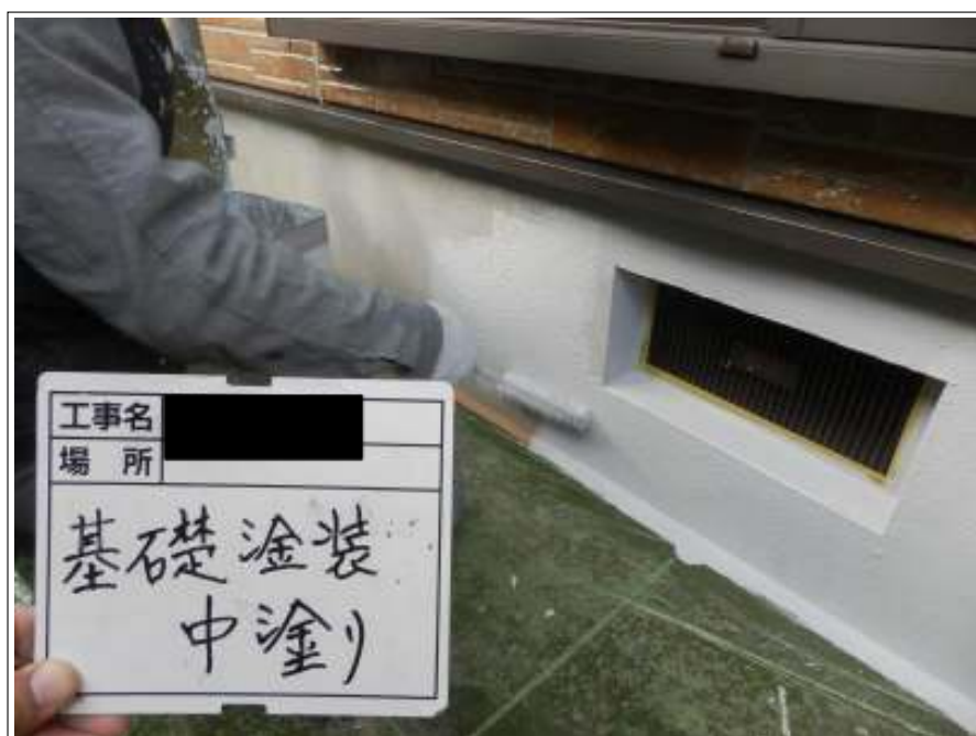
基礎 中塗り施工中
