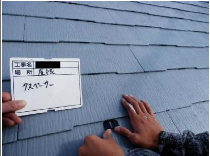
屋根 タスペーサー取付
