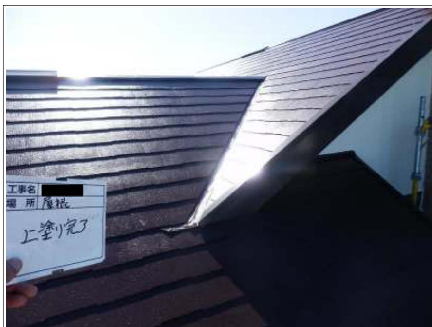
屋根 上塗り施工後
