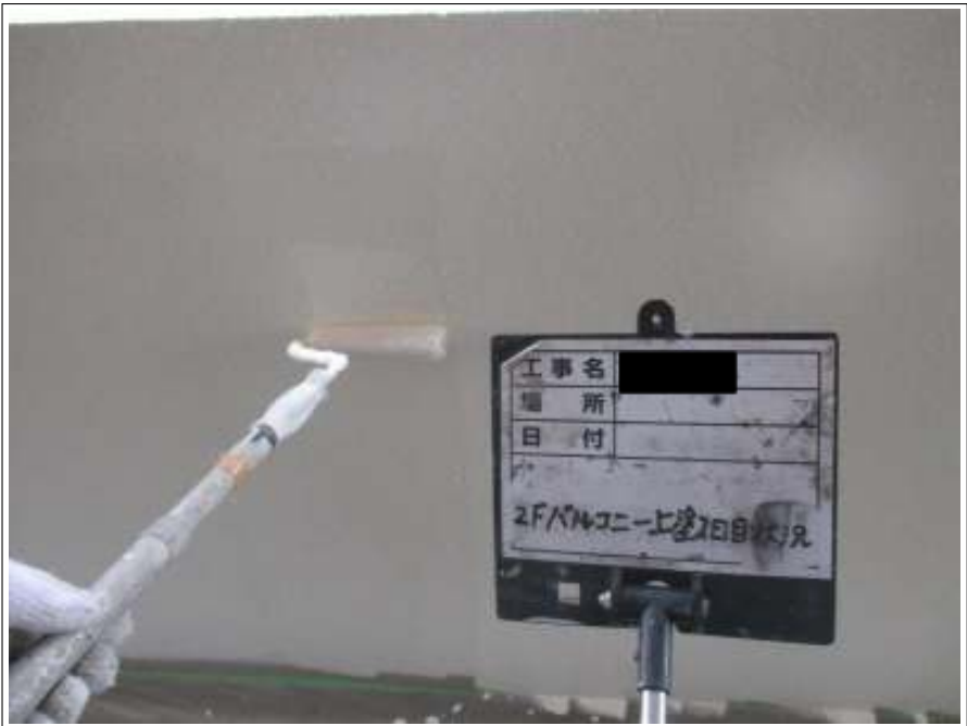
壁 上塗り（2回目）施工中
