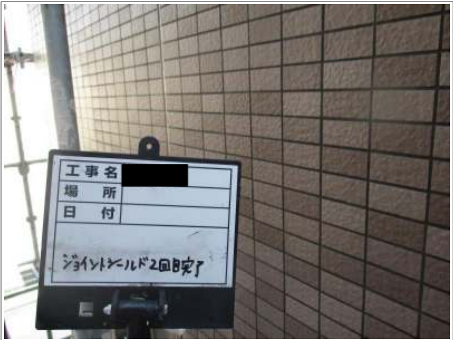
外壁 上塗り（2回目）施工後
