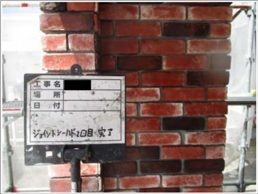
外壁 上塗り（2回目）施工後
