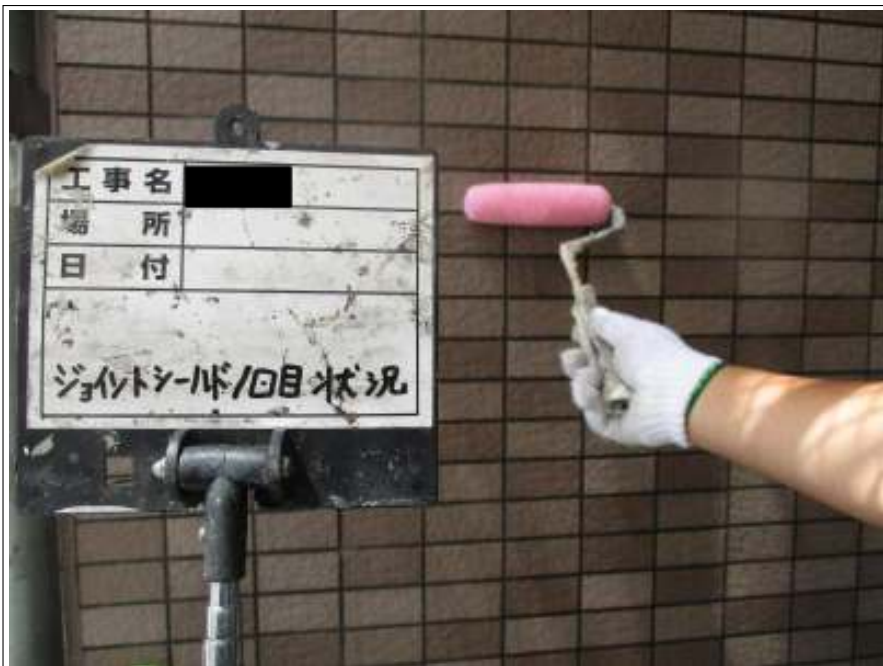
外壁 上塗り（1回目）施工中
