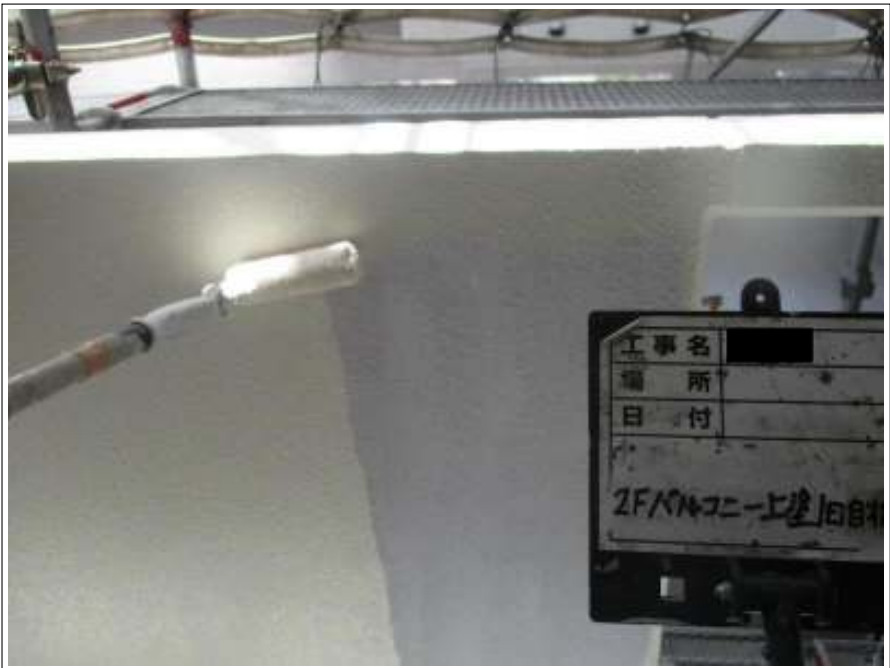
壁 上塗り（1回目）施工中
