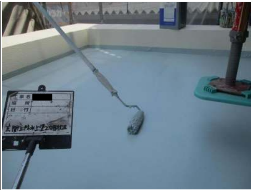
玄関庇 防水部 上塗り施工中
