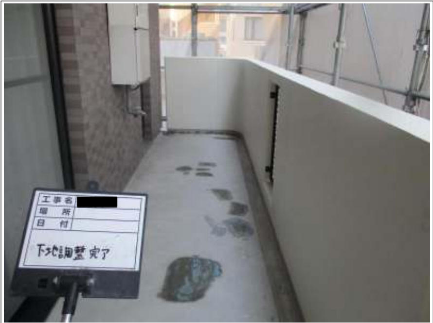
バルコニー床 下地調整 完了
