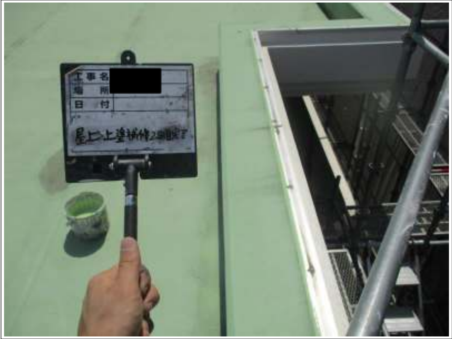
屋上 補修部上塗り(2回目) 施工後
