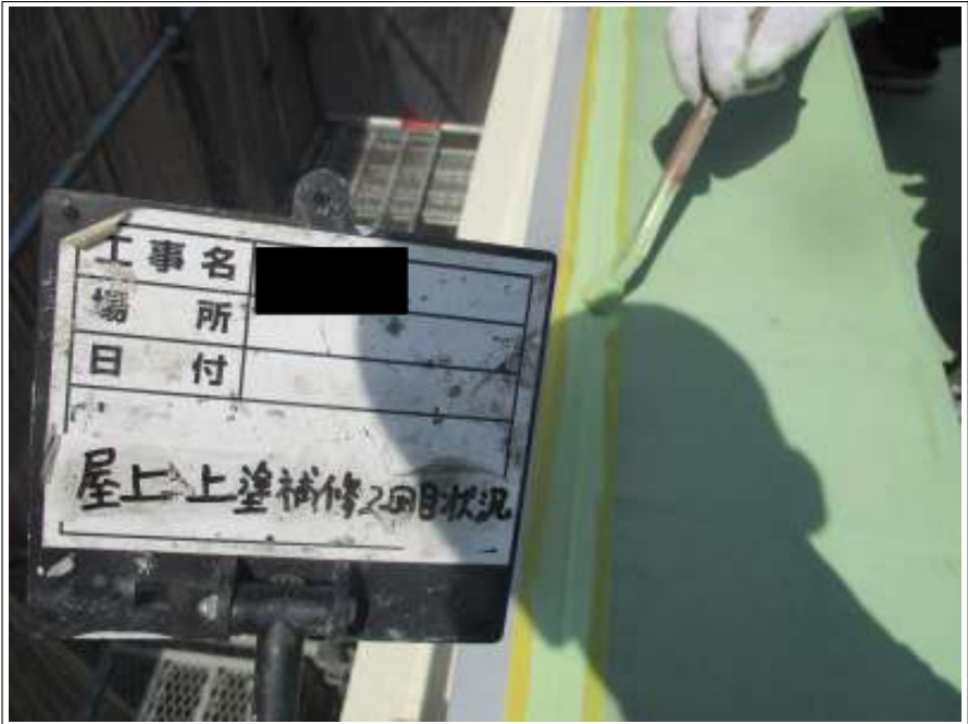
屋上 補修部上塗り(2回目) 施工中
