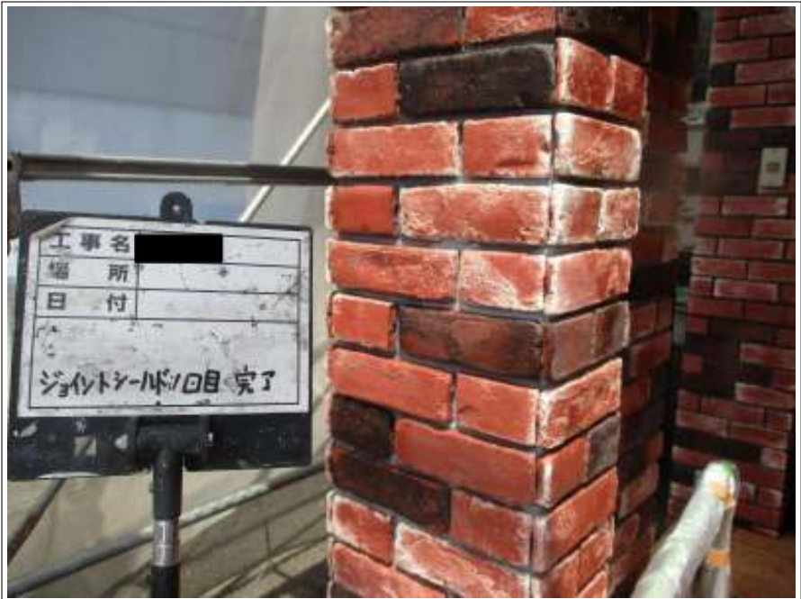
外壁 上塗り（1回目）施工後
