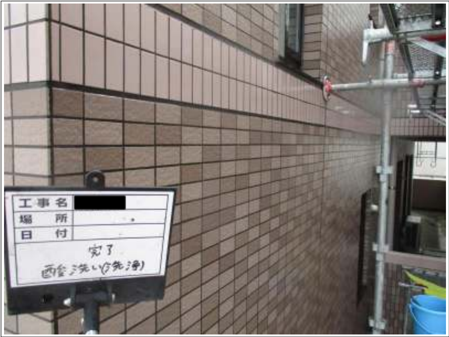
外壁 酸洗浄完了
