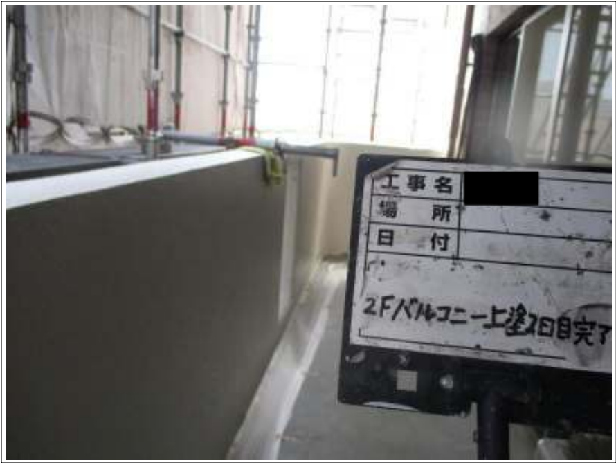
壁 上塗り（2回目）施工後
