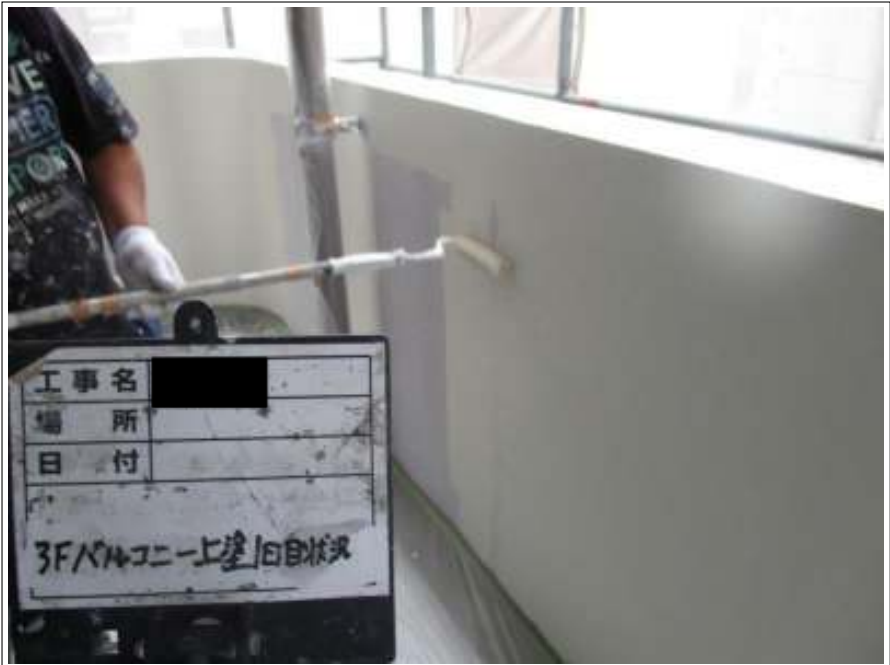
壁 上塗り（1回目）施工中
