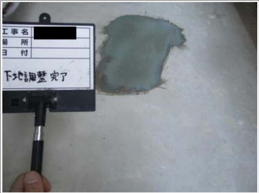
バルコニー床 下地調整 完了
