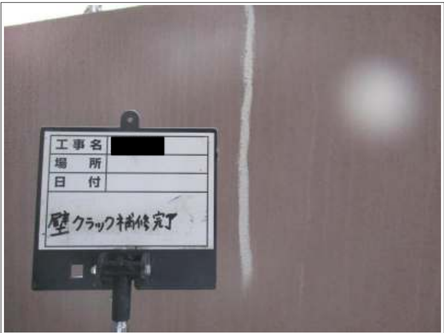
クラック補修施工後
