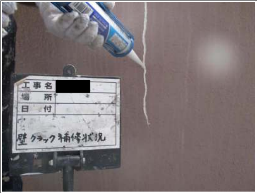
クラック補修施工中
