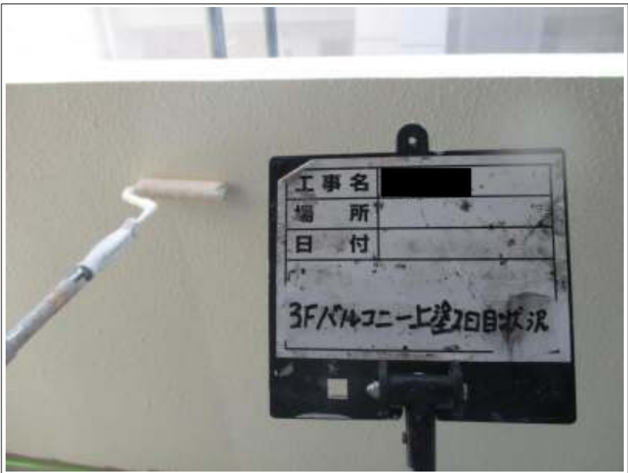
壁 上塗り（2回目）施工中
