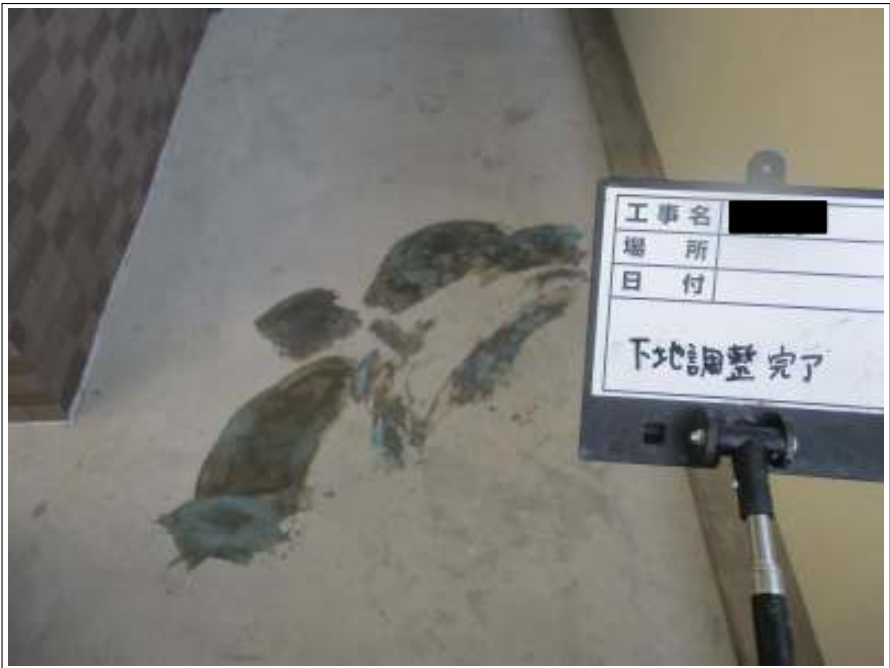
バルコニー床 下地調整 完了
