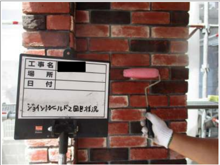
外壁 上塗り（2回目）施工中
