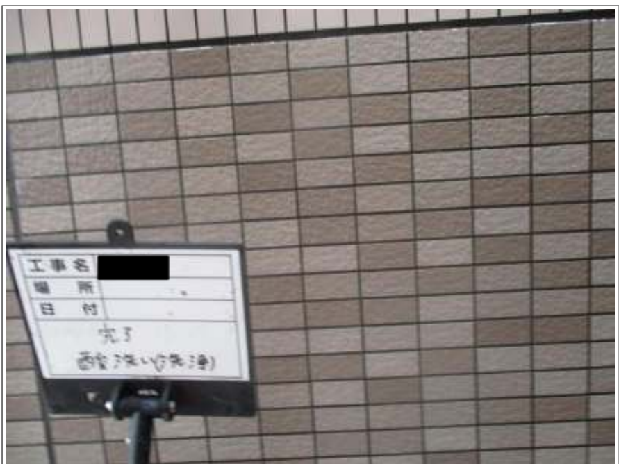
外壁 酸洗浄完了
