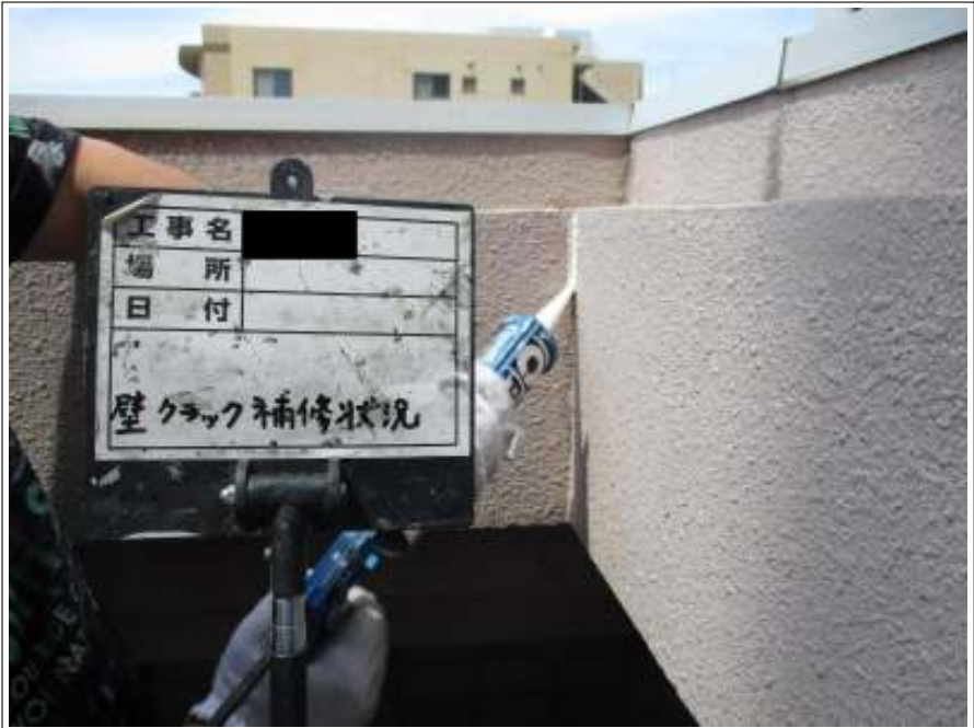
クラック補修施工中
