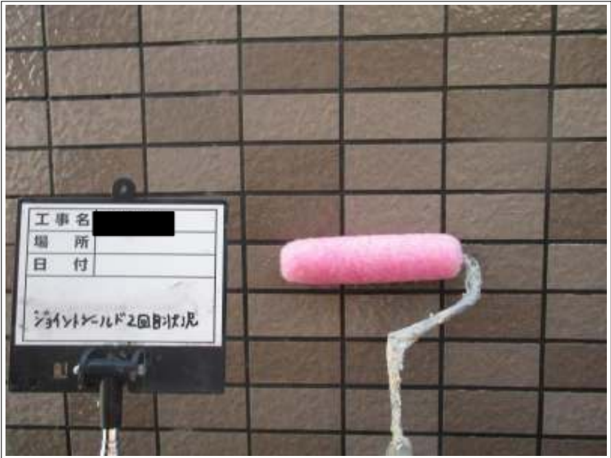
外壁 上塗り（2回目）施工中
