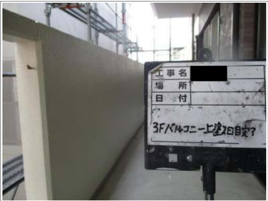
壁 上塗り（2回目）施工後
