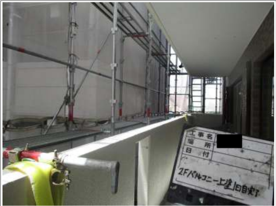
壁 上塗り（1回目）施工後
