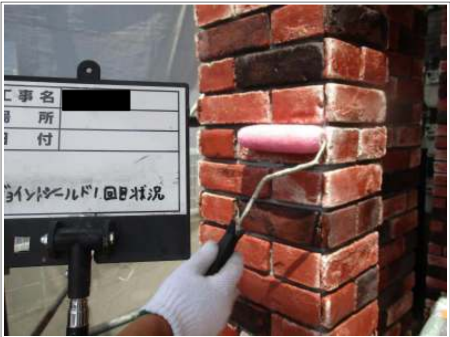
外壁 上塗り（1回目）施工中
