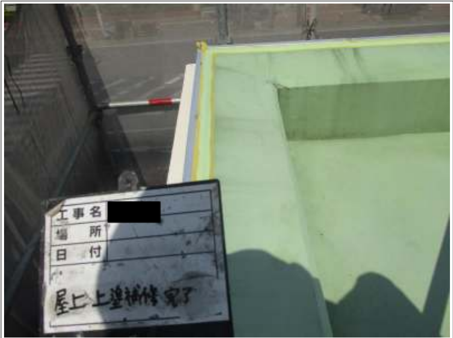
屋上 補修部上塗り(1回目) 施工後
