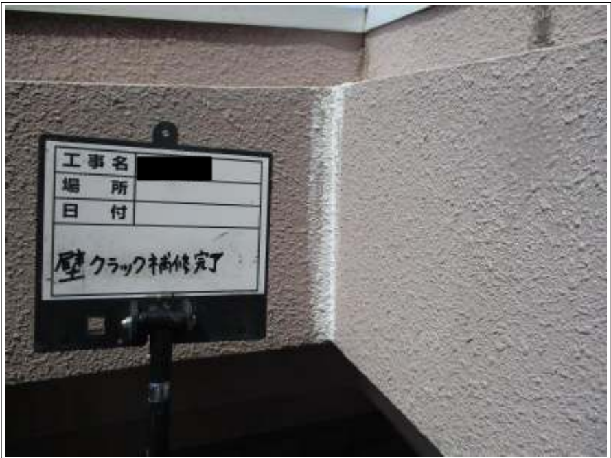
クラック補修施工後
