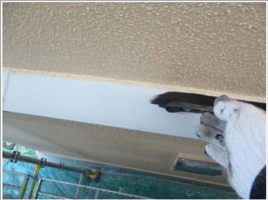
鉄部 上塗り施工中
