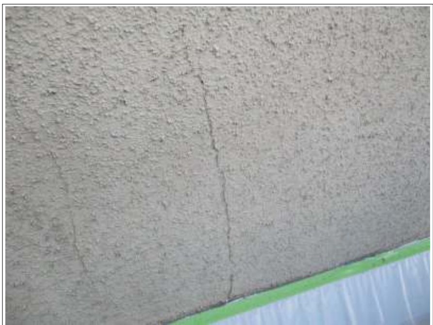
外壁 クラック補修施工前
