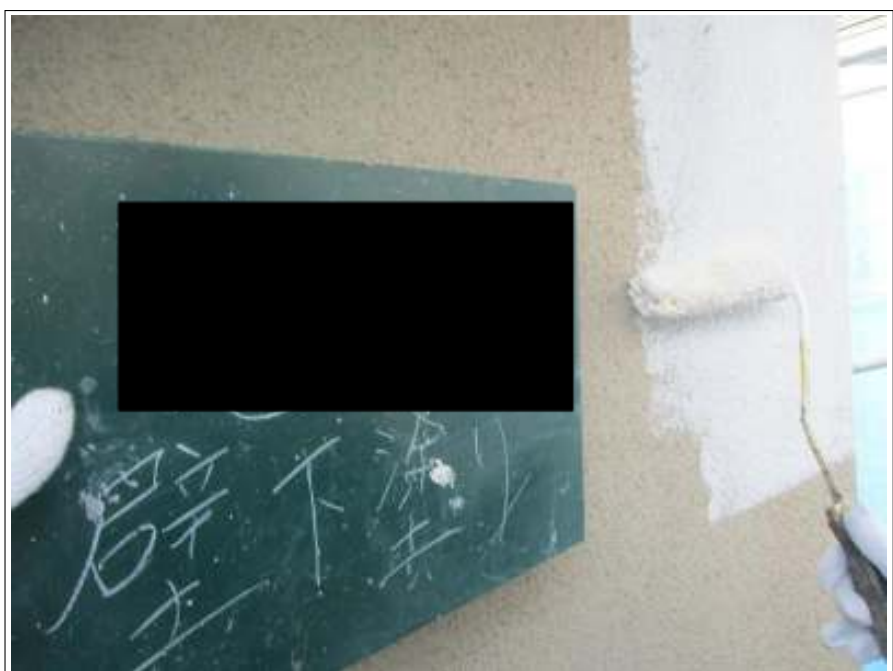
外壁 下塗り施工中
