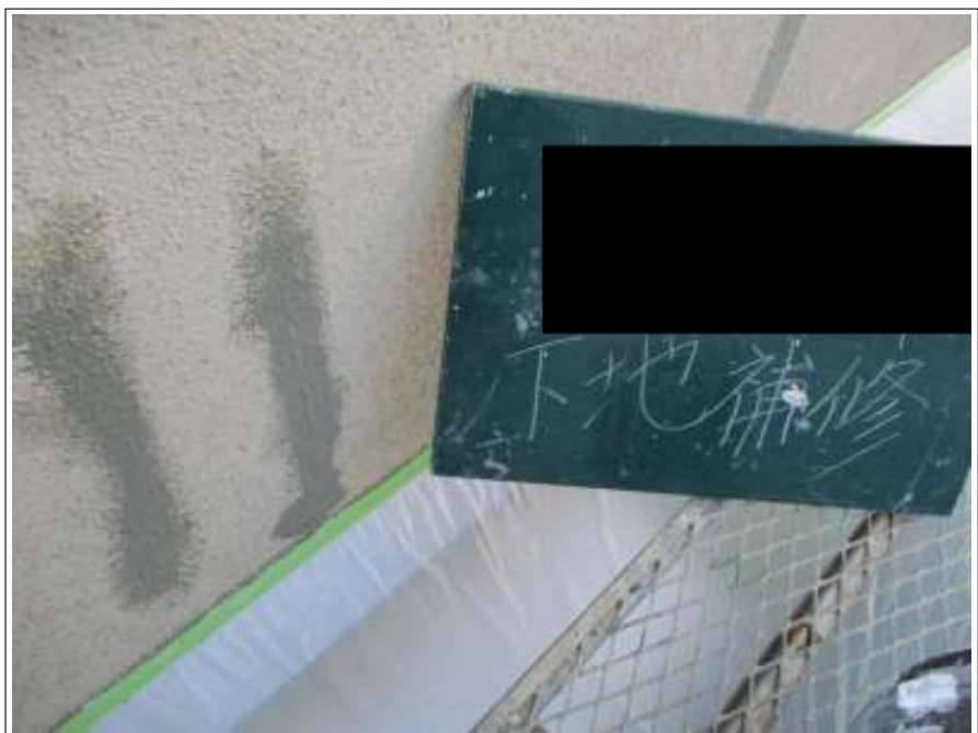
外壁 クラック補修施工後
