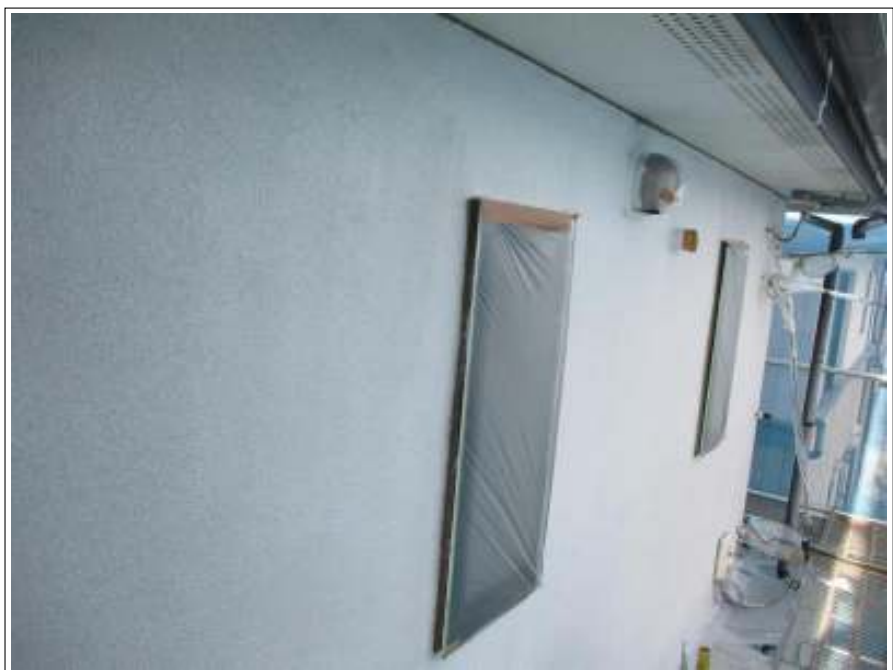
外壁 下塗り施工後
