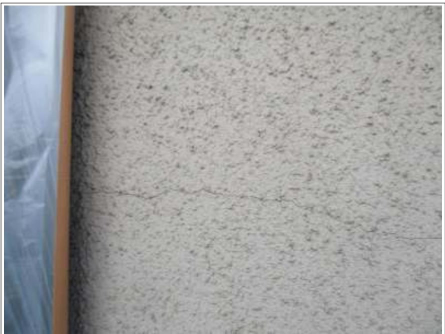
外壁 クラック補修施工前
