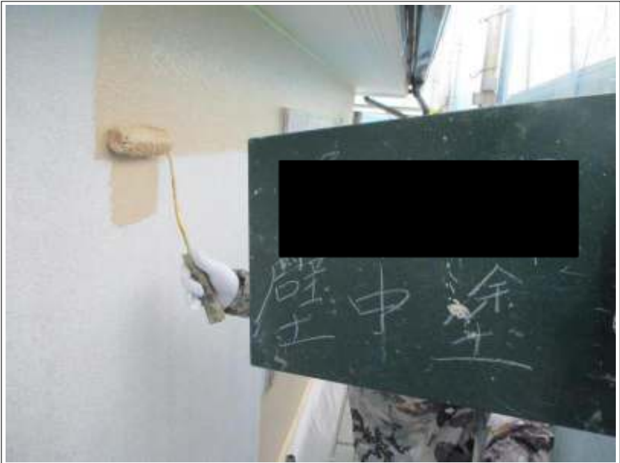
外壁 中塗り施工中
