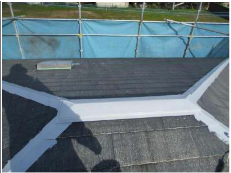
屋根板金部 サビ止め塗布後
