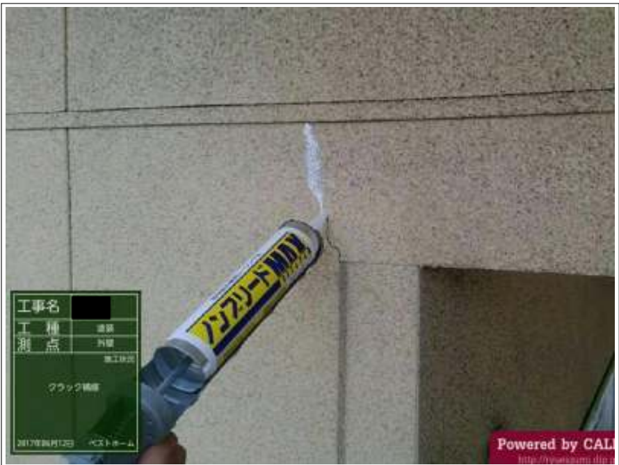
外壁 クラック補修施工中
