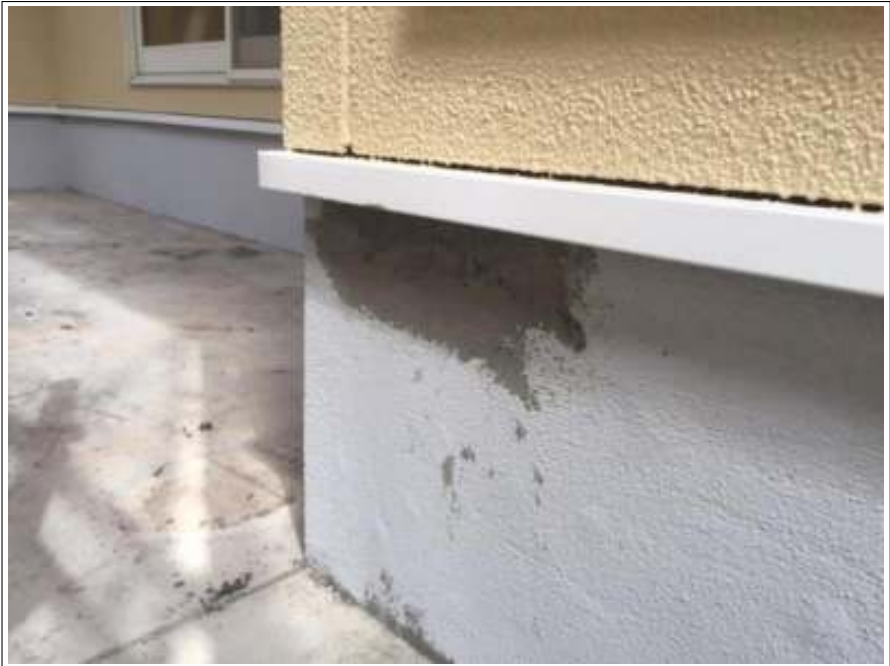
基礎 パテ補修 施工後
