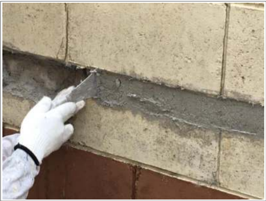
塀 パテ補修 施工中
