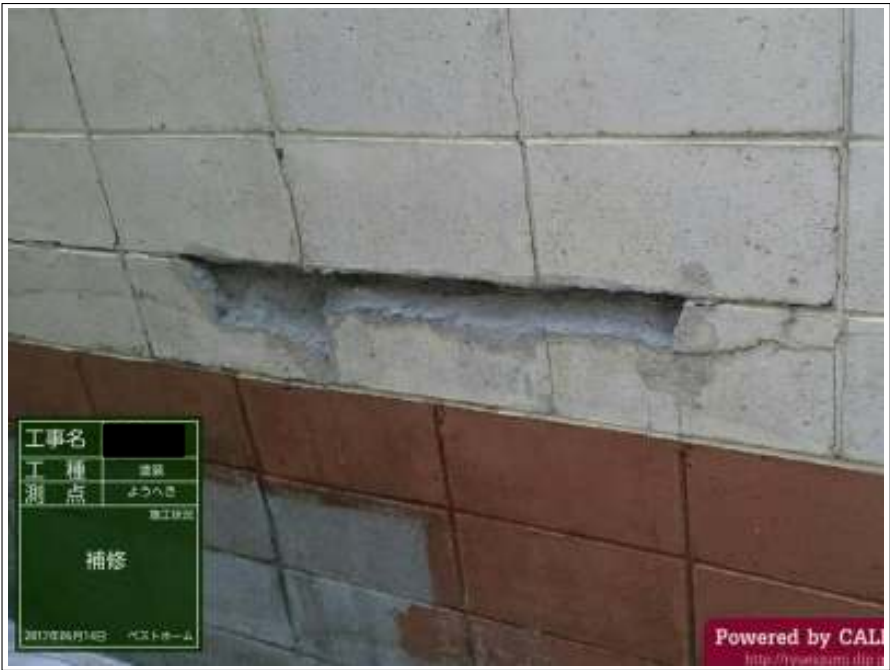
塀 パテ補修 施工前
