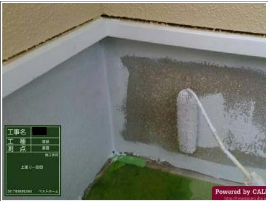
基礎 上塗り（1回目）施工中
