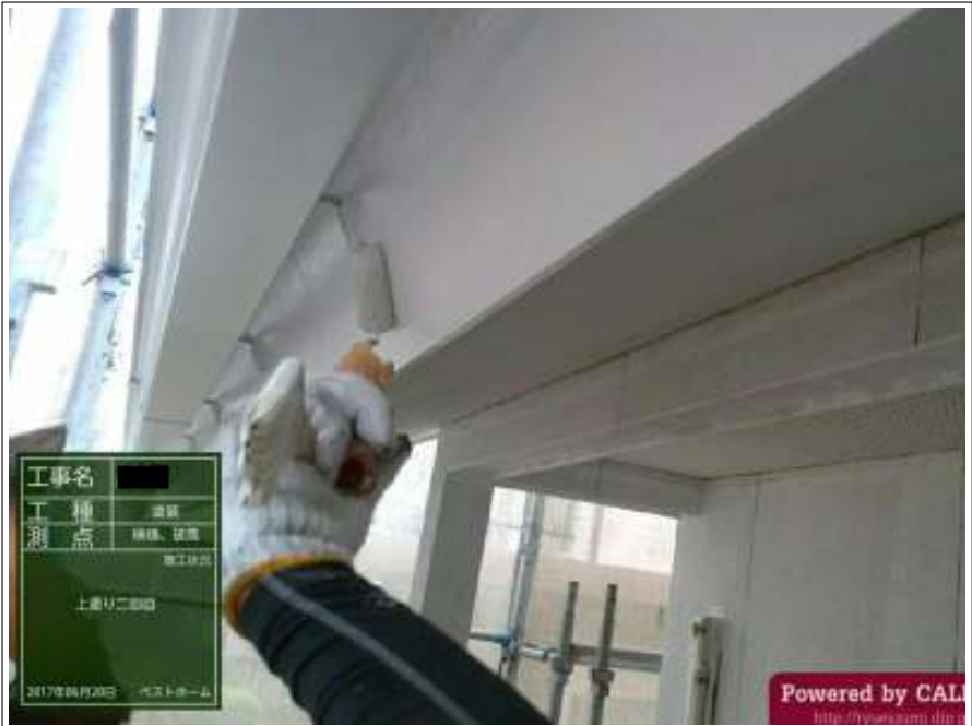
樋・破風板 上塗り（2回目）施工中
