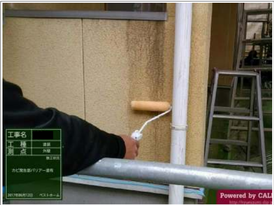
外壁 バリヤー塗布施工中
