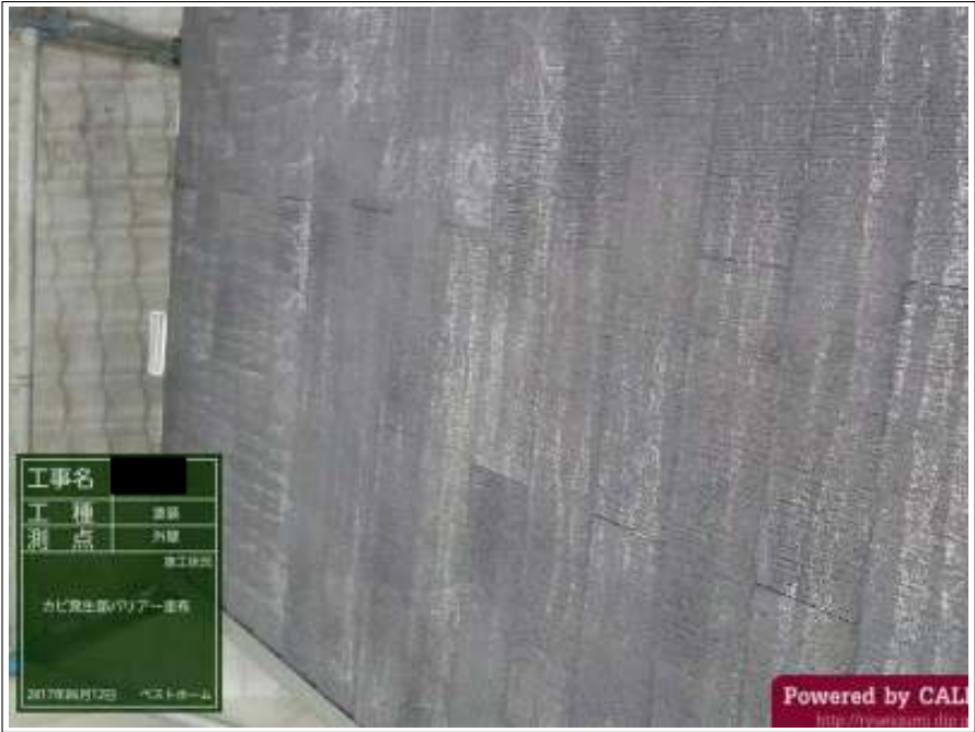
屋根 バリアー塗布施工後
