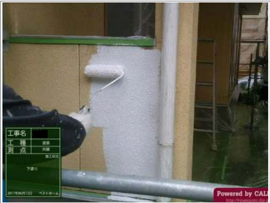
外壁 下塗り施工中
