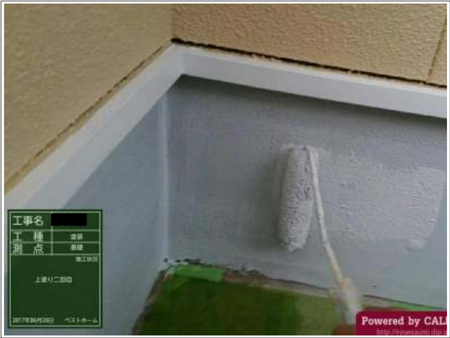
基礎 上塗り（2回目）施工中
