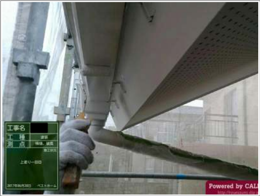
樋・破風板 上塗り(1回目)施工中
