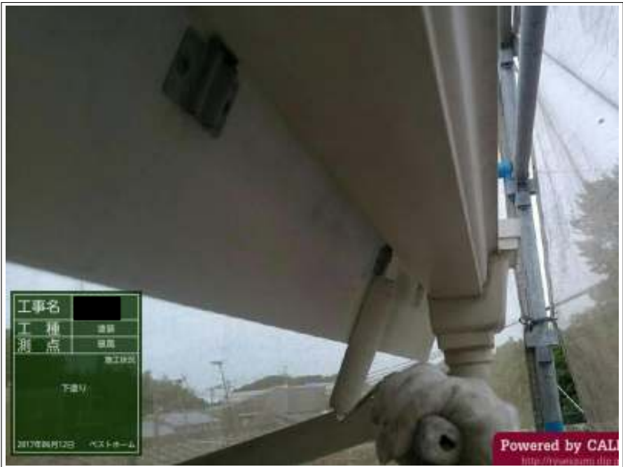
樋・破風板 下塗り施工中
