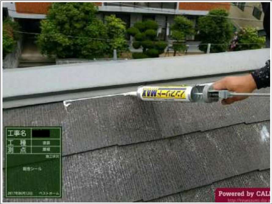
屋根 ラバー止め施工中
