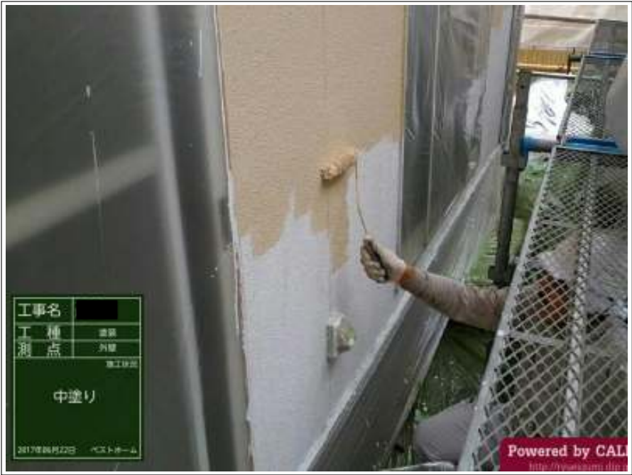
外壁 中塗り施工中
