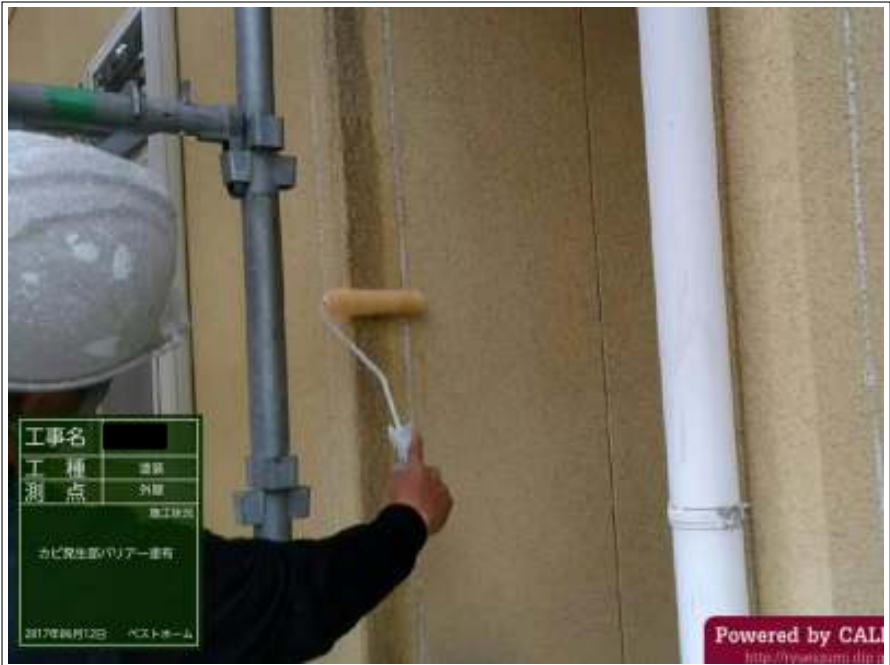
外壁 バリアー塗布施工中
