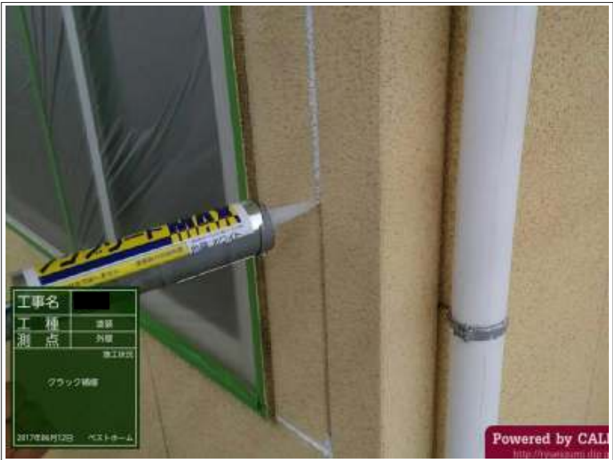
外壁 クラック補修施工中
