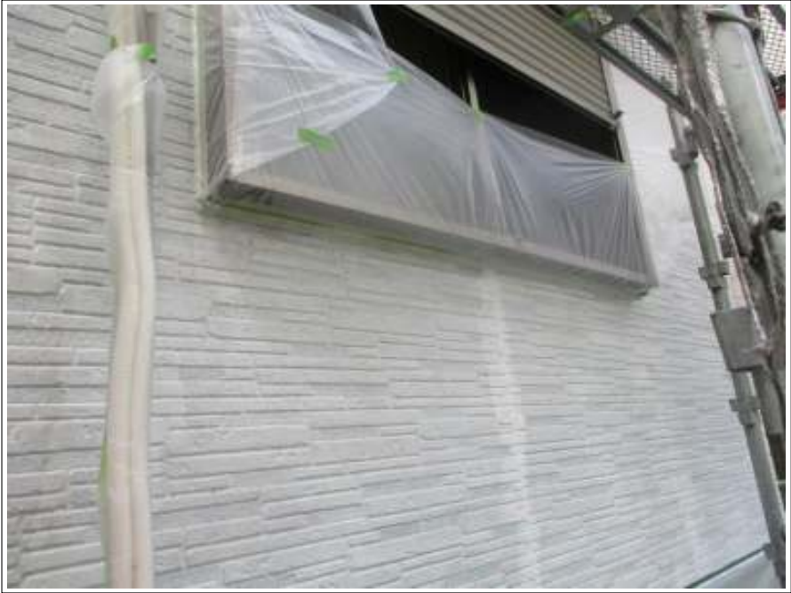
外壁 下塗り施工完了
