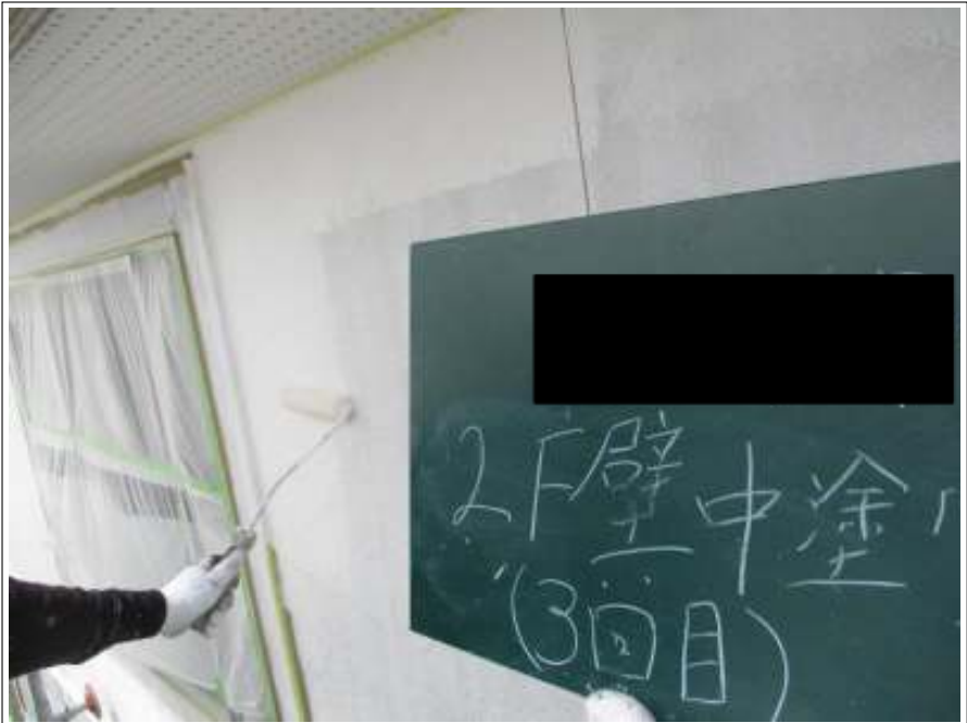
外壁 中塗り施工中
