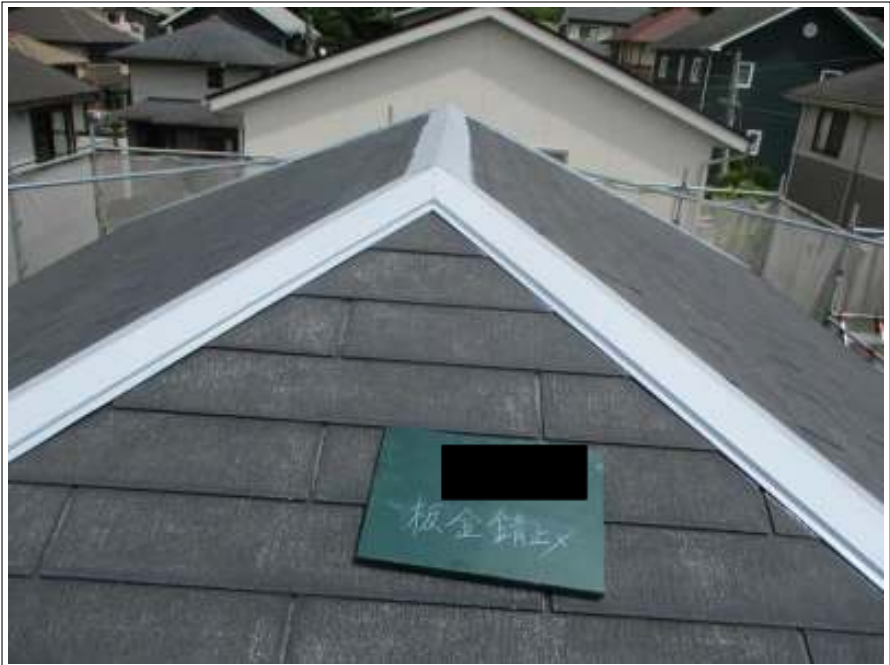
棟鉄板 サビ止め施工後
