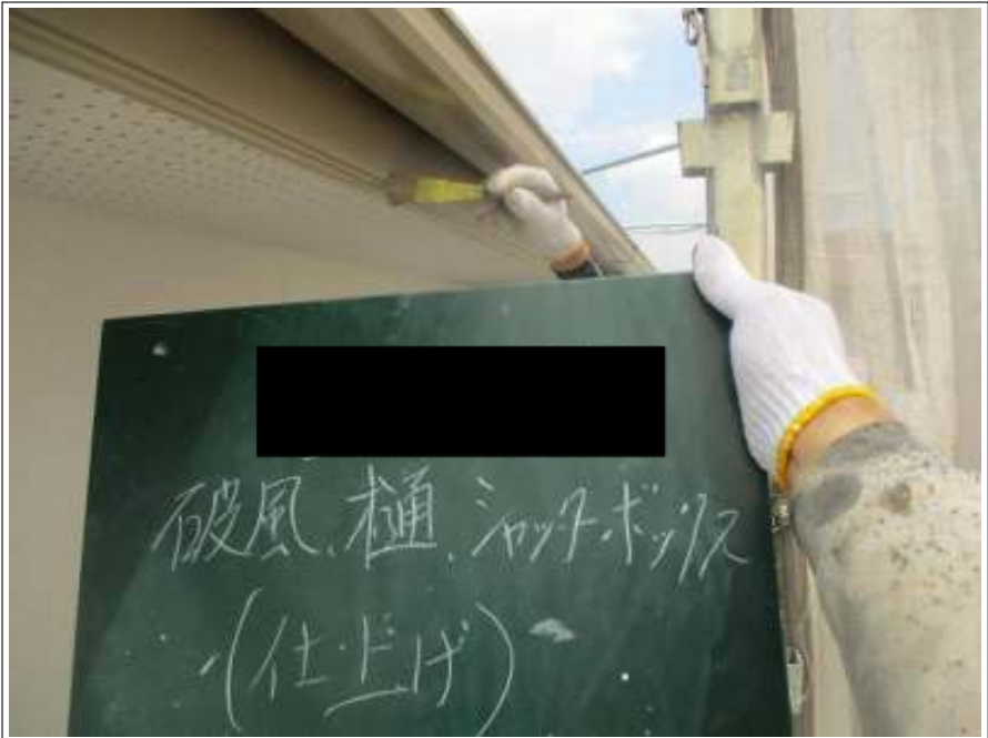
破風板・横樋 上塗り施工中
