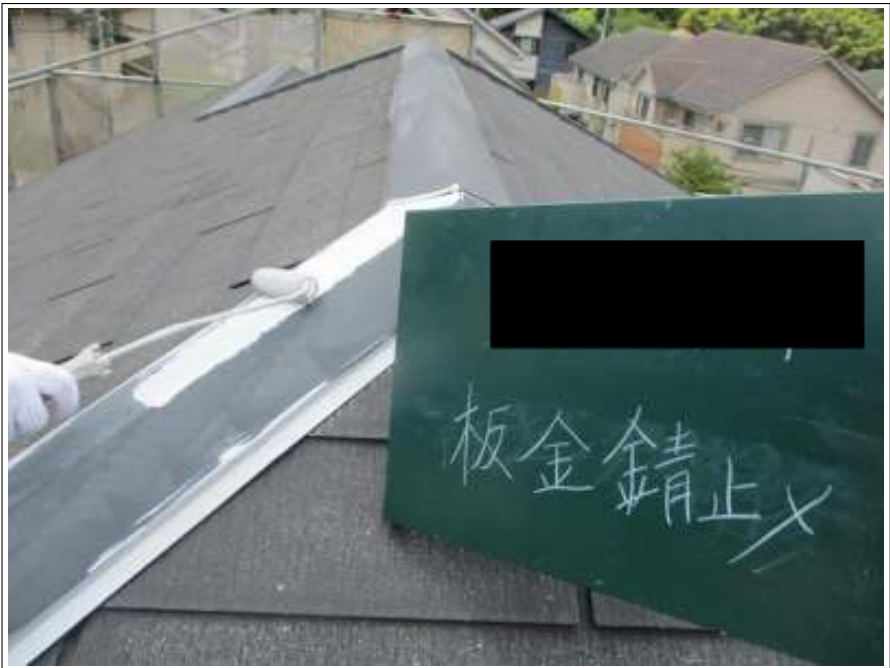
棟鉄板 サビ止め施工中
