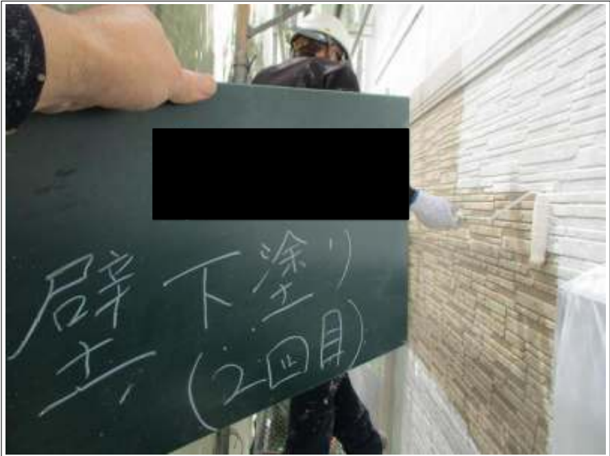
外壁 下塗り(2回目) 施工中
