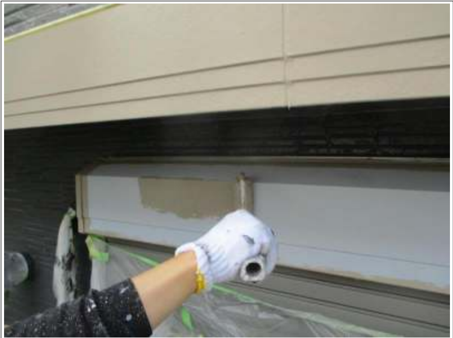
シャッターBOX 中塗り施工中
