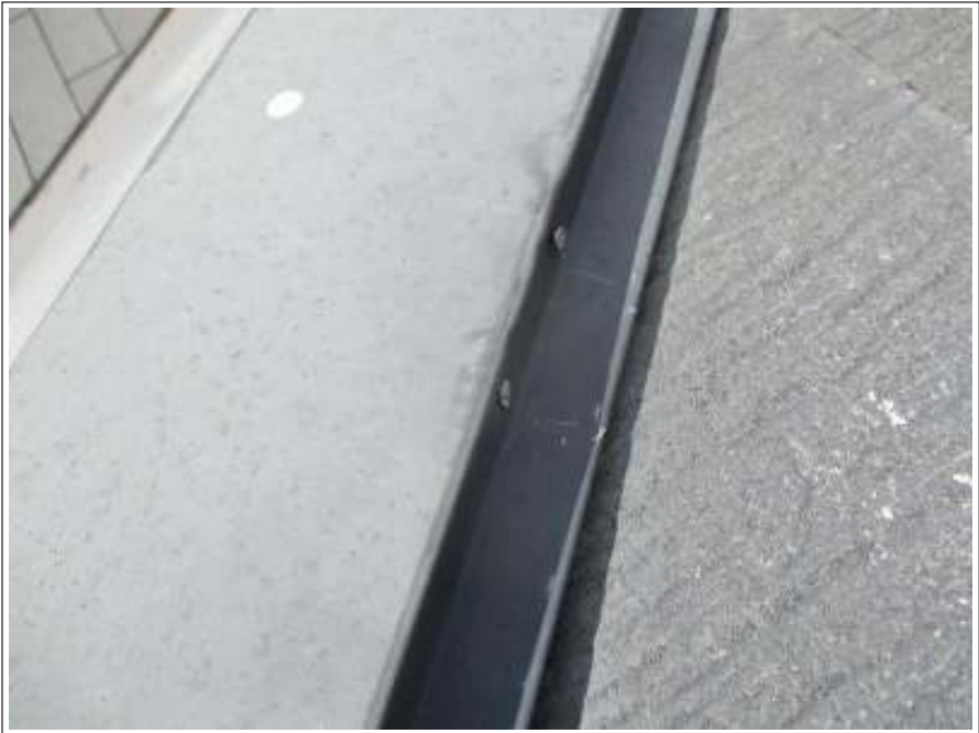
棟鉄板 釘打ち施工後
