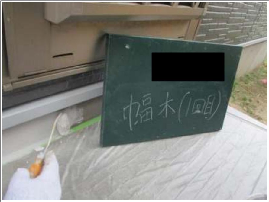
基礎 上塗り(1回目) 施工中
