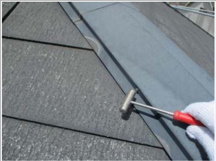
棟鉄板 釘打ち施工中
