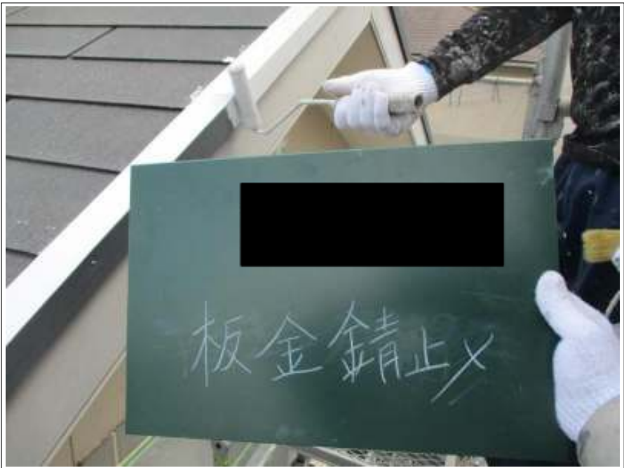
棟鉄板 サビ止め施工中
