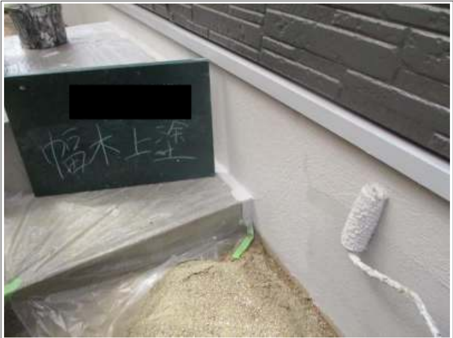
基礎 上塗り(2回目) 施工中
