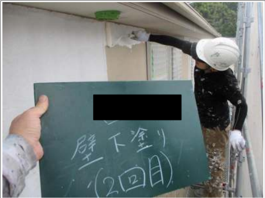
外壁 下塗り(2回目) 施工中
