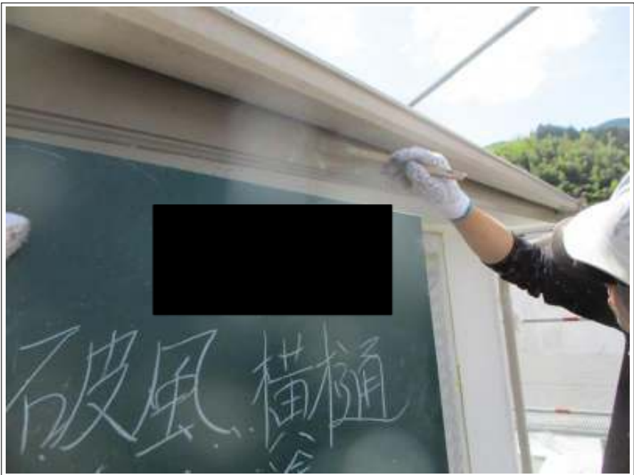
破風板・横樋 中塗り施工中
