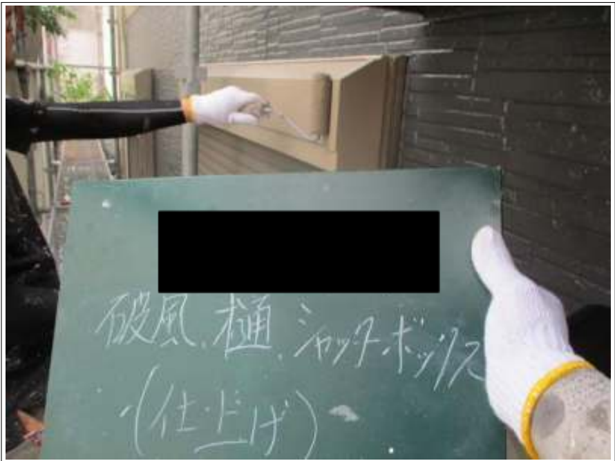
シャッターBOX 上塗り施工中
