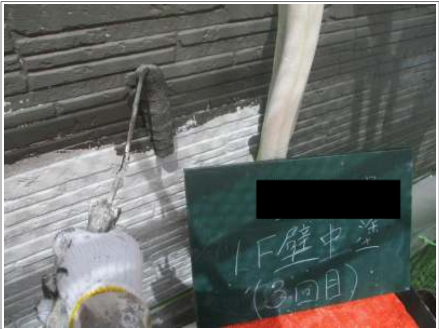
外壁 中塗り施工中
