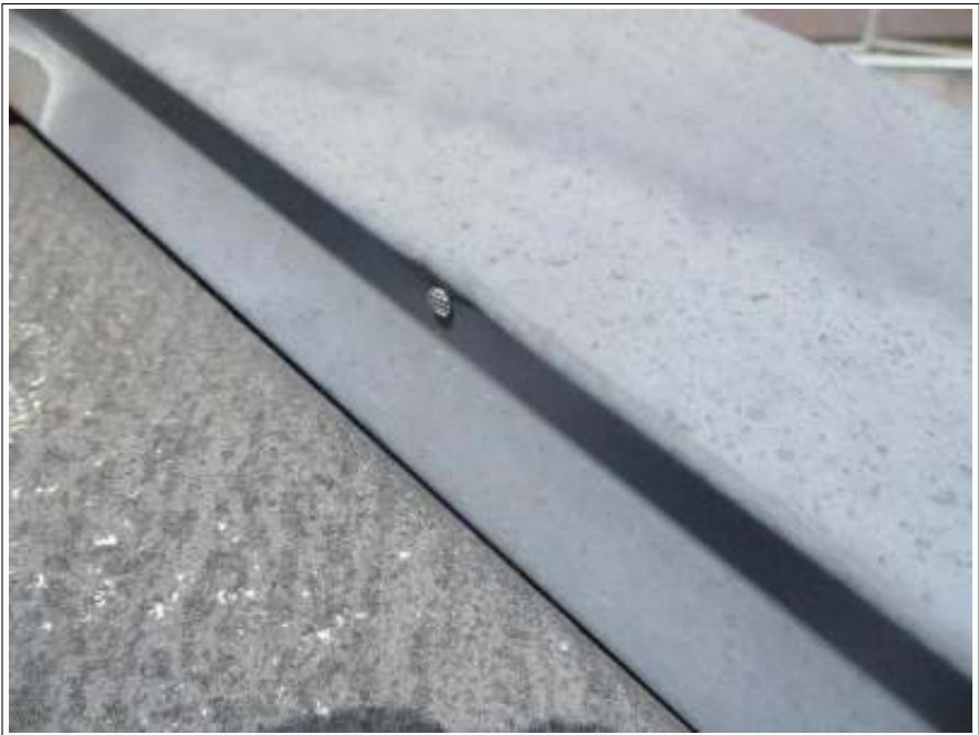
棟鉄板 釘打ち施工後
