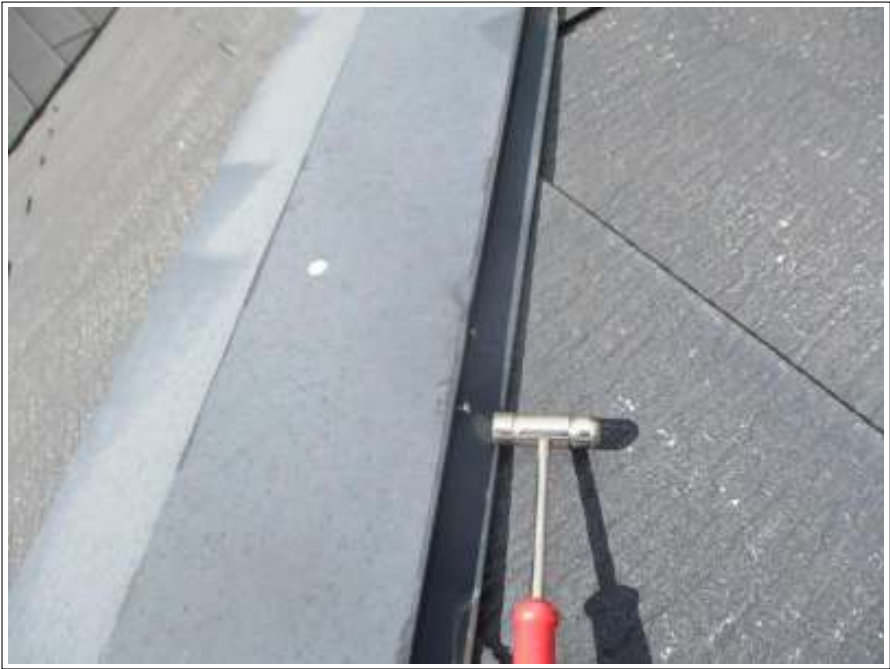
棟鉄板 釘打ち施工中
