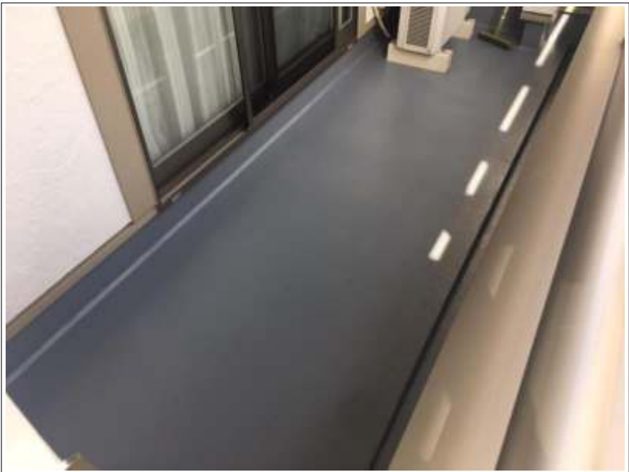
ベランダ床 上塗り施工完了
