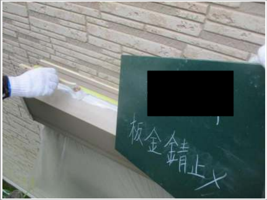
シャッターBOX サビ止め施工中
