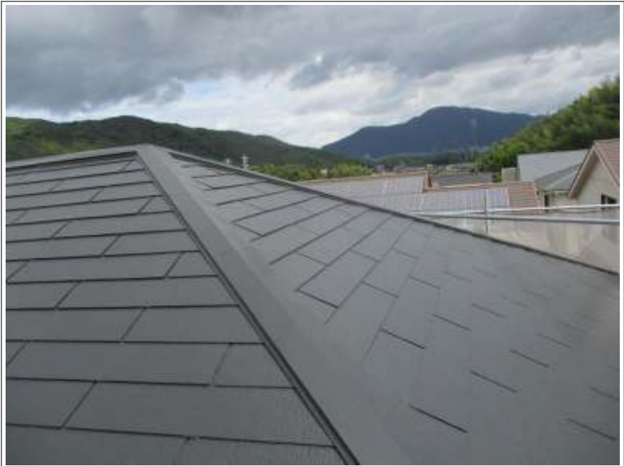
屋根 上塗り施工完了
