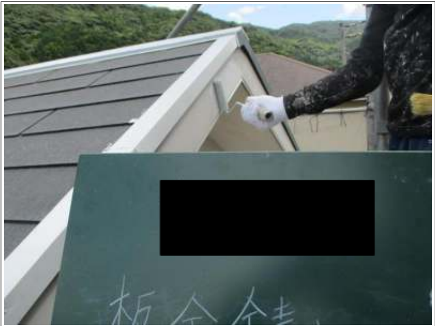
破風板 上塗り施工中
