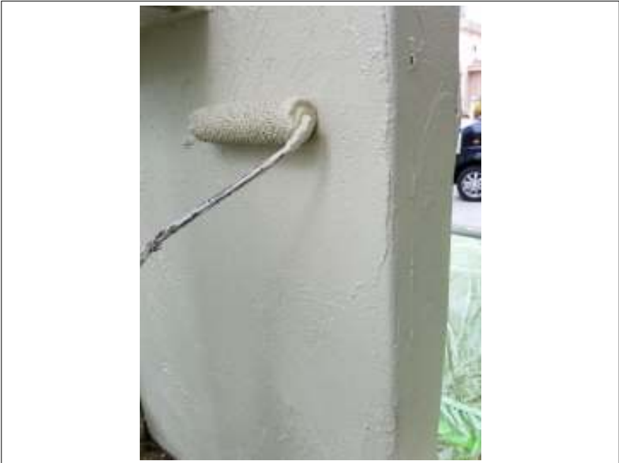
塀 上塗り施工中
