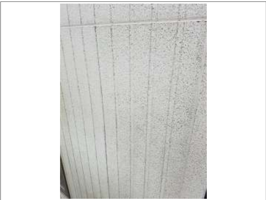
外壁 高压洗净中
