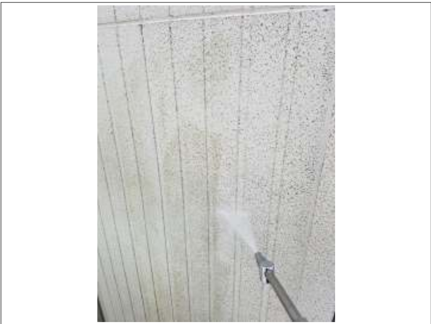
外壁 高压洗净中
