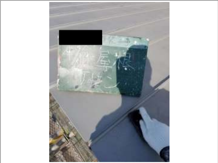
屋根 ケレン処理
