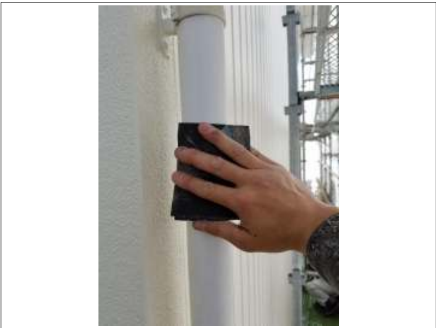
樋 目粗し施工中
