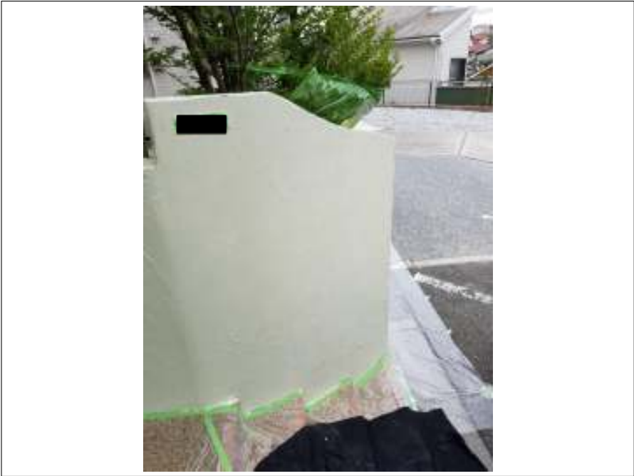
塀 下塗り施工後
