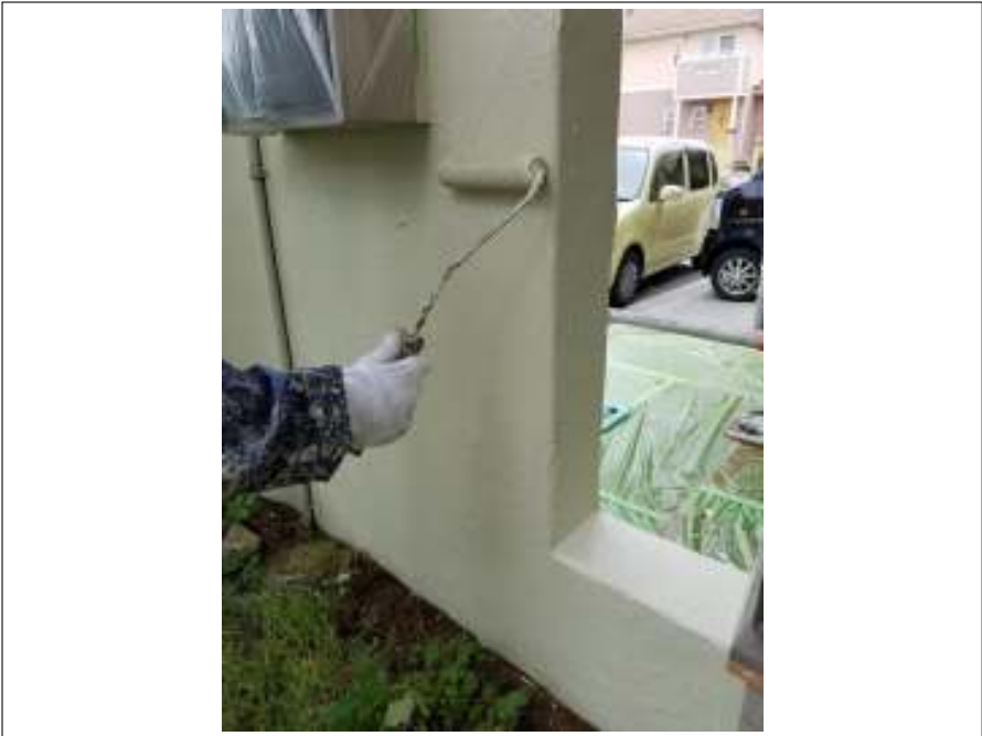
塀 上塗り施工中
