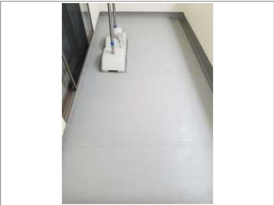
ベランダ 施工後
