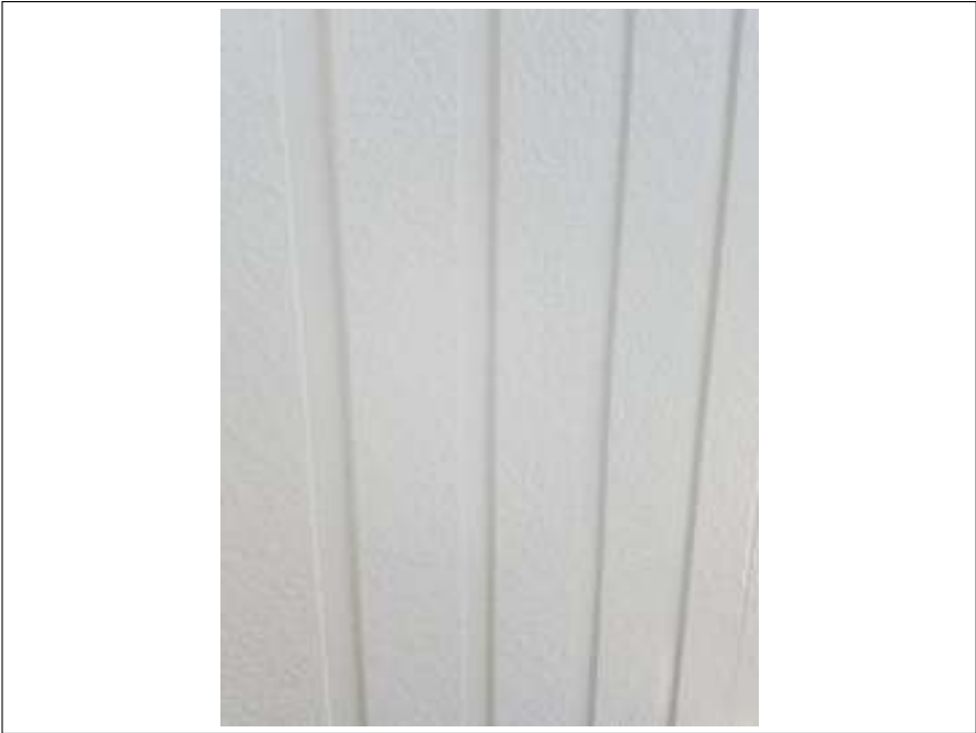
外壁 施工完了
