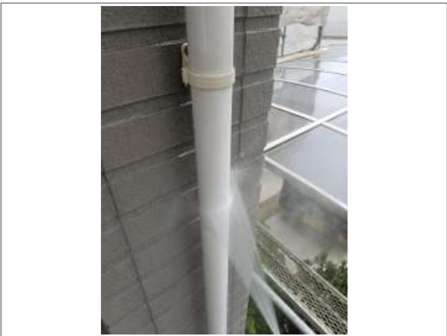
樋 高压洗净中
