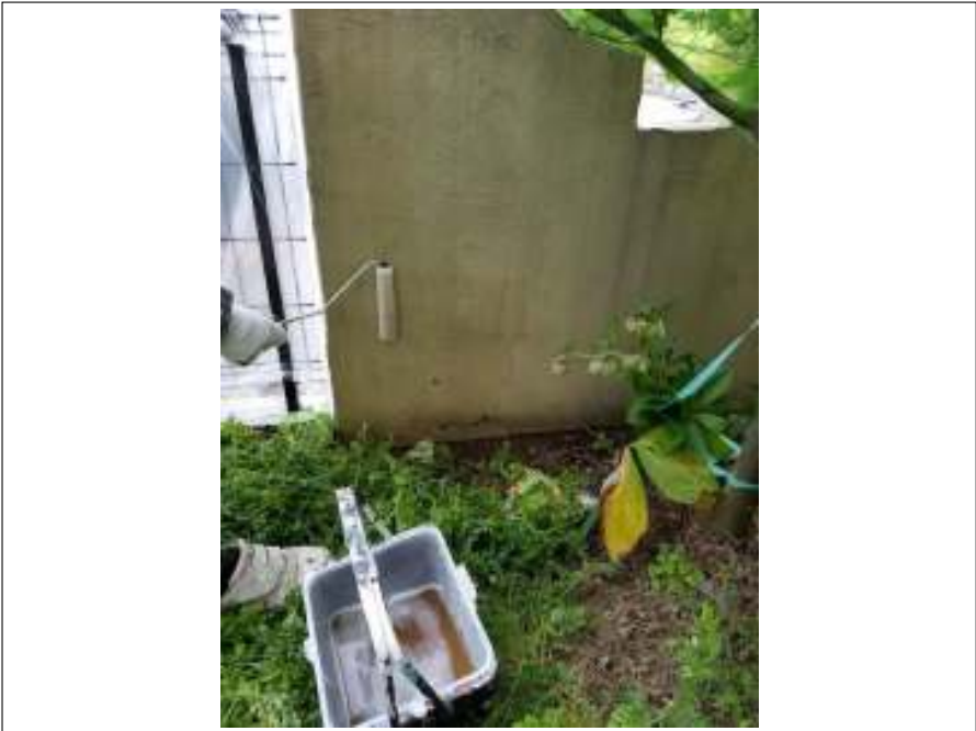
塀 下塗り施工中
