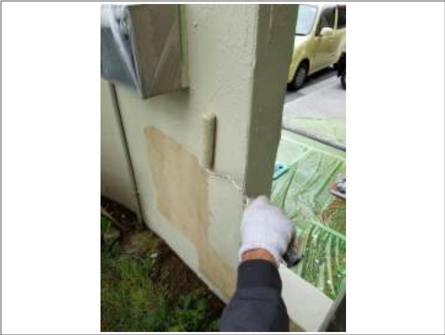
塀 下塗り施工中
