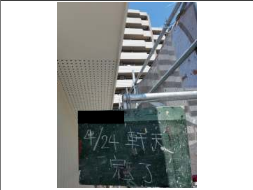
軒天 施工完了
