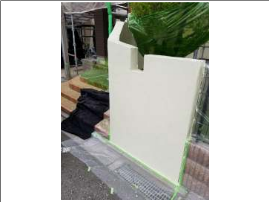
塀 下塗り施工後
