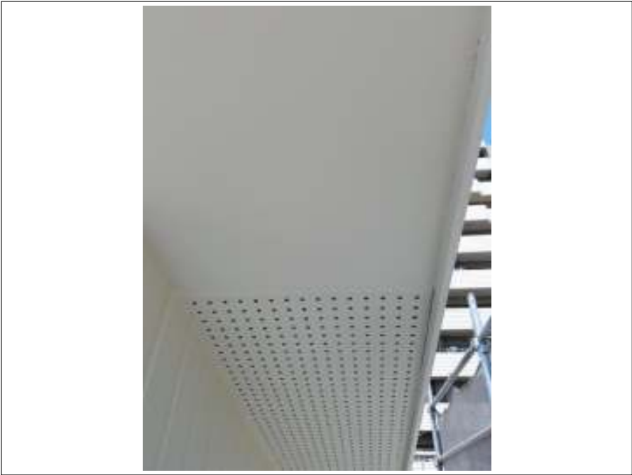
軒天 施工完了
