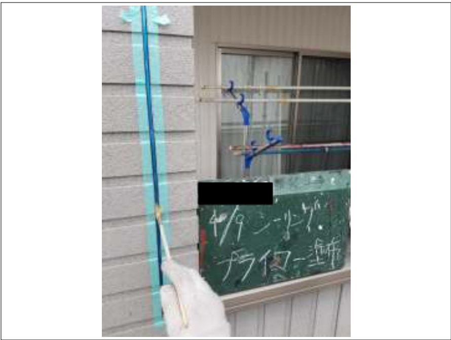
プライマー塗布
