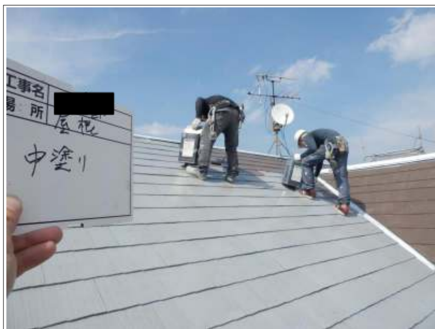
屋根 中塗り施工中
