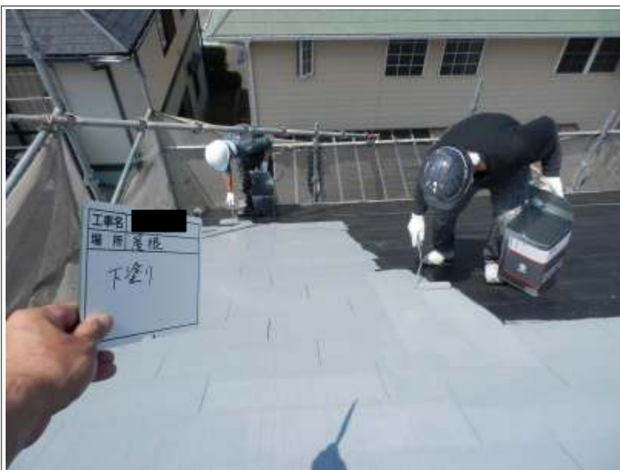
屋根 下塗り施工中
