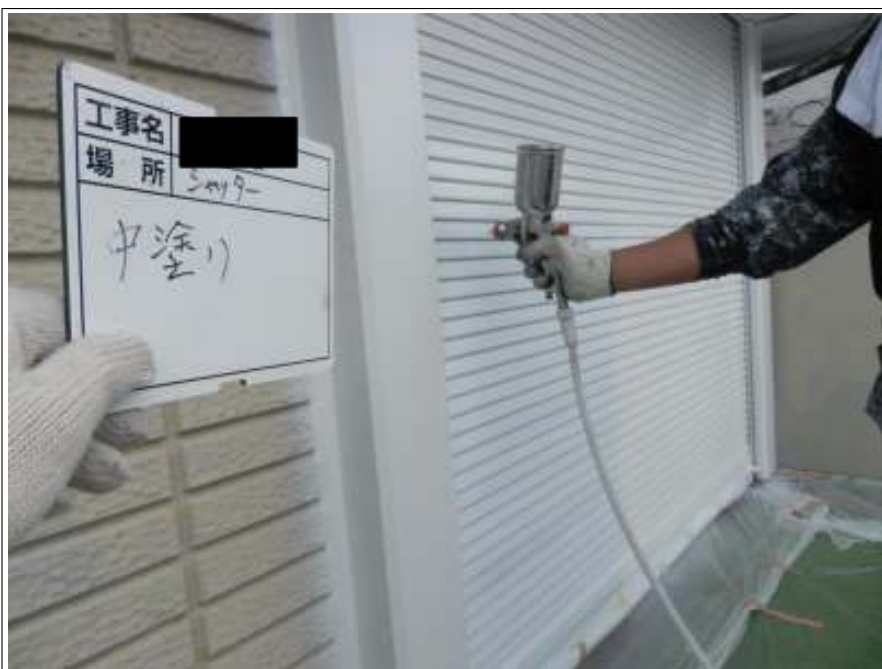
シャッター 中塗り施工中
