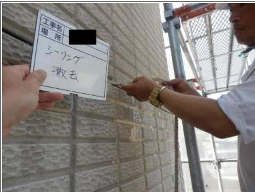
既存シーリング撤去
