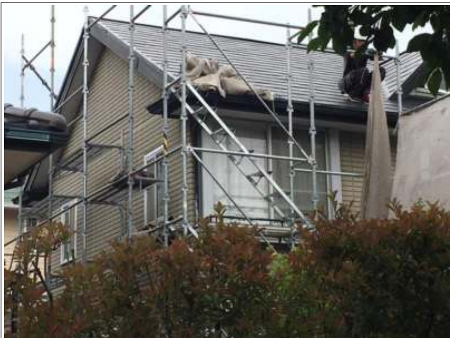
仮設足場組立
