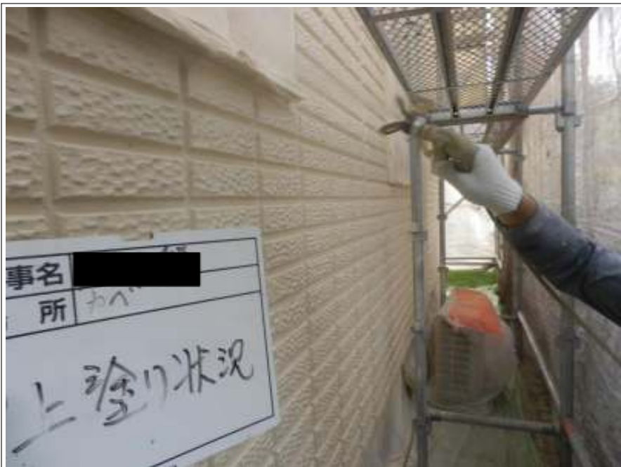
外壁 上塗り施工中
