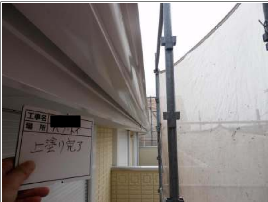
破風板・樋 上塗り施工後
