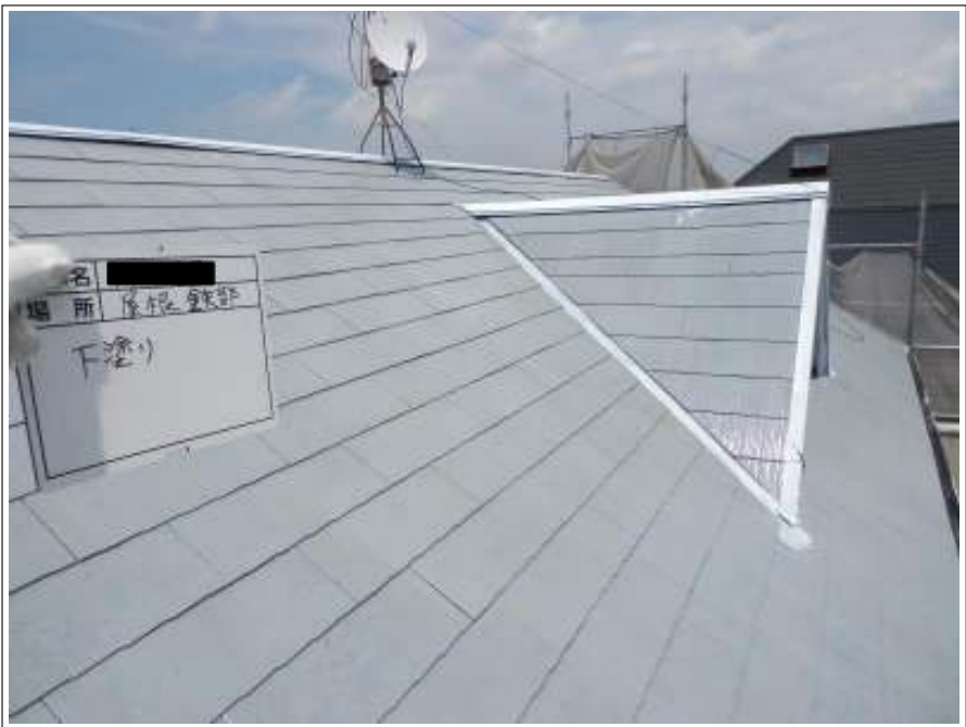
屋根 下塗り施工後
