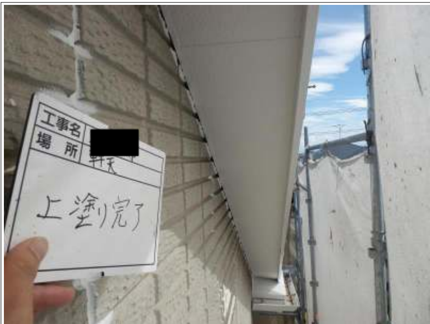
軒天 上塗り施工後
