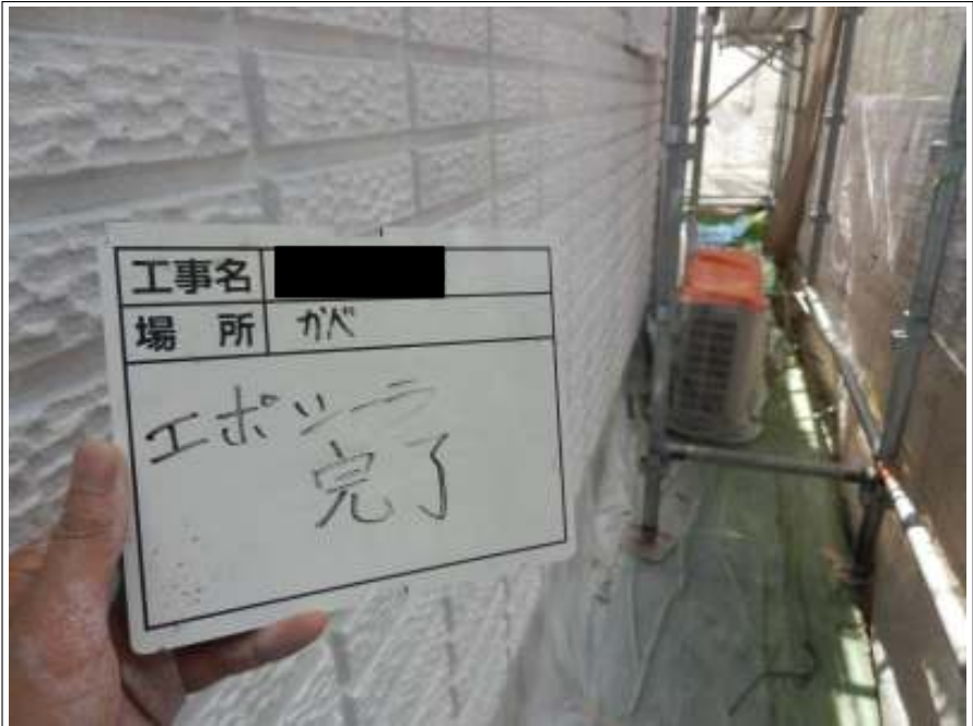
外壁 下塗り（1回目）施工後
