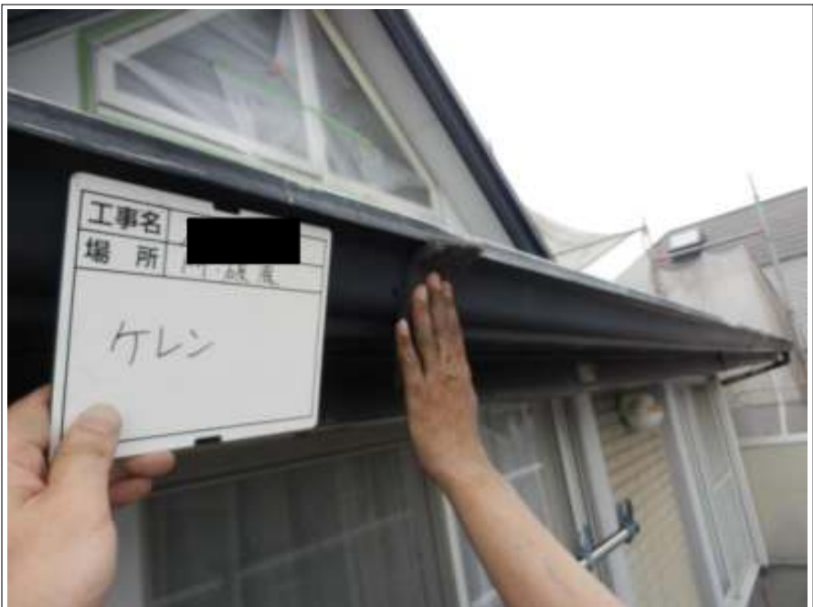
破風板・樋 ケレン処理施工中
