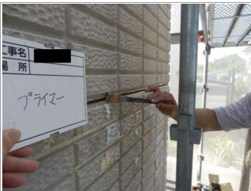
プライマー塗布
