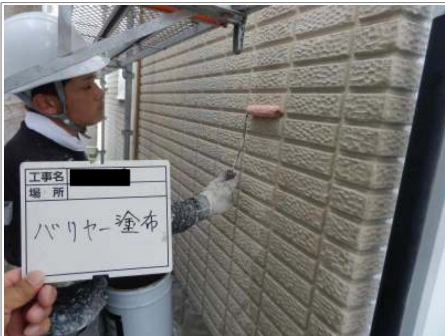
外壁 バリヤー塗布
