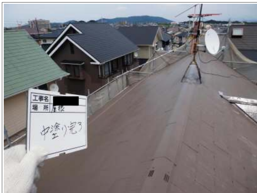
屋根 中塗り施工後
