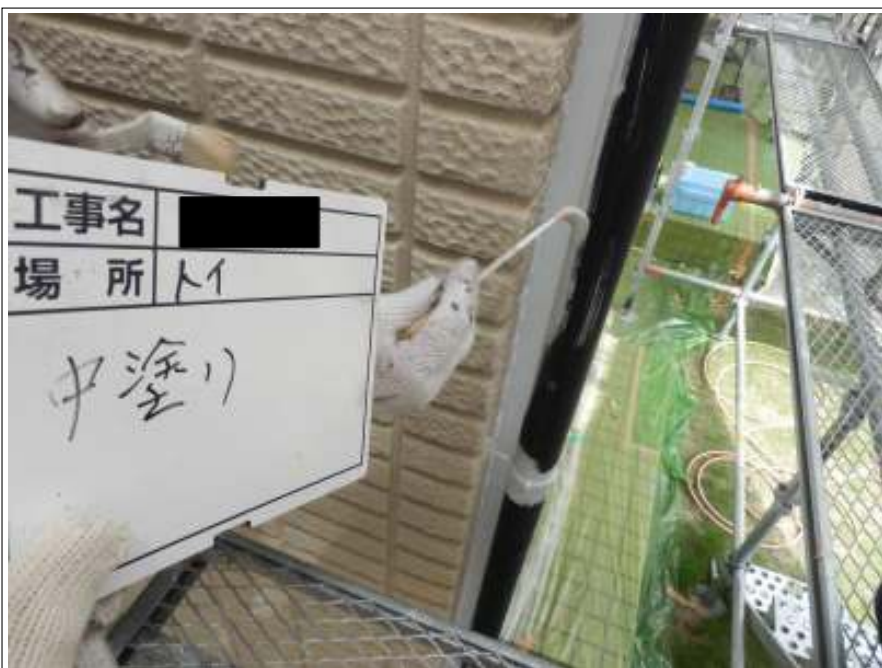
樋 中塗り施工中
