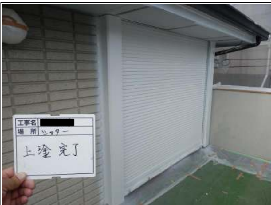
シャッター 上塗り施工後
