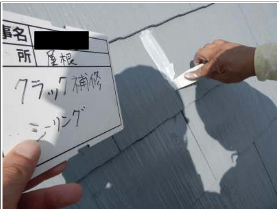
屋根 クラック補修施工中
