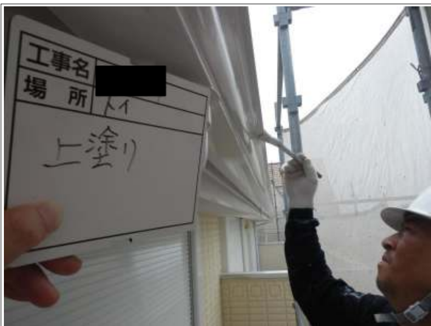
樋 上塗り施工中
