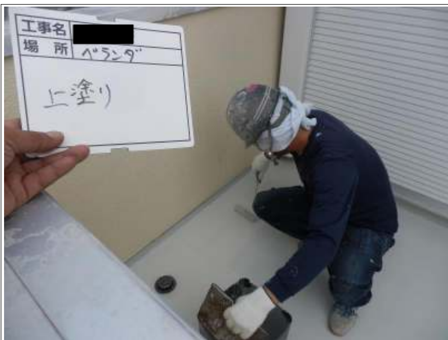
ベランダ床 上塗り施工中
