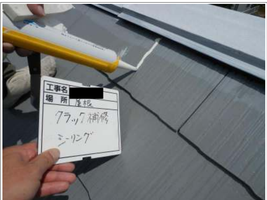
屋根 クラック補修施工中
