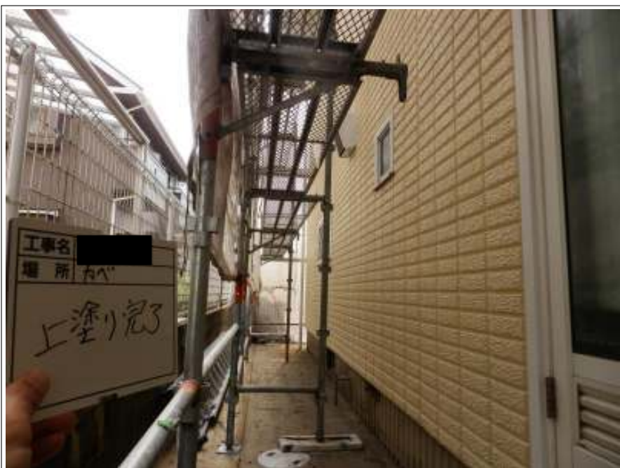
外壁 上塗り施工後
