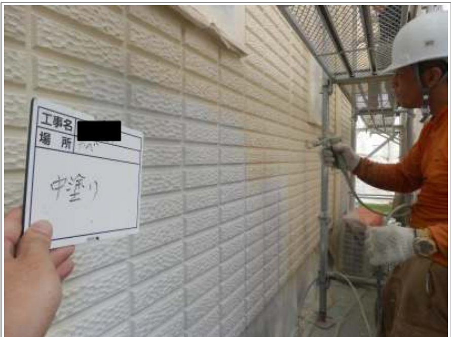
外壁 中塗り施工中
