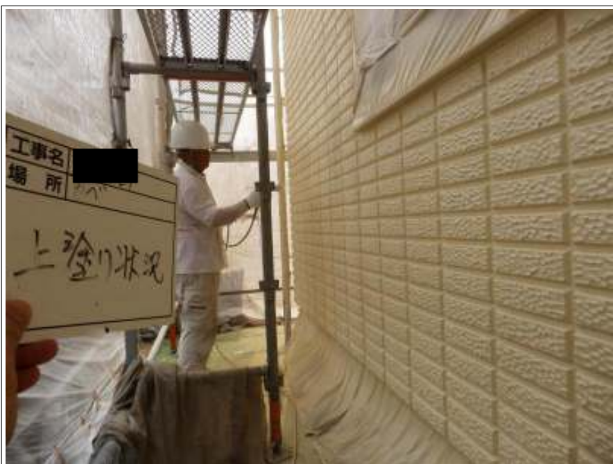
外壁 上塗り施工中
