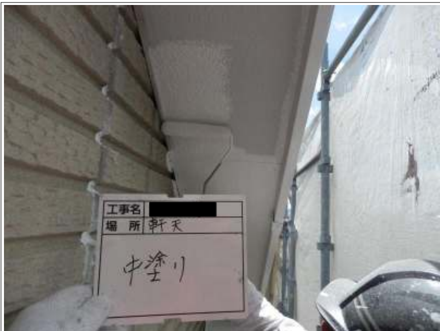
軒天 中塗り施工中
