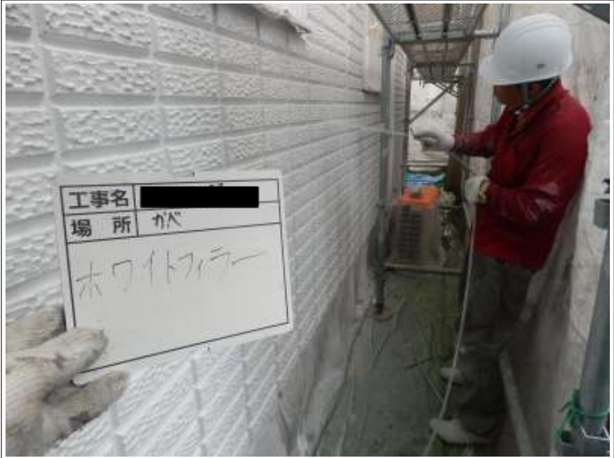
外壁 下塗り（2回目）施工中
