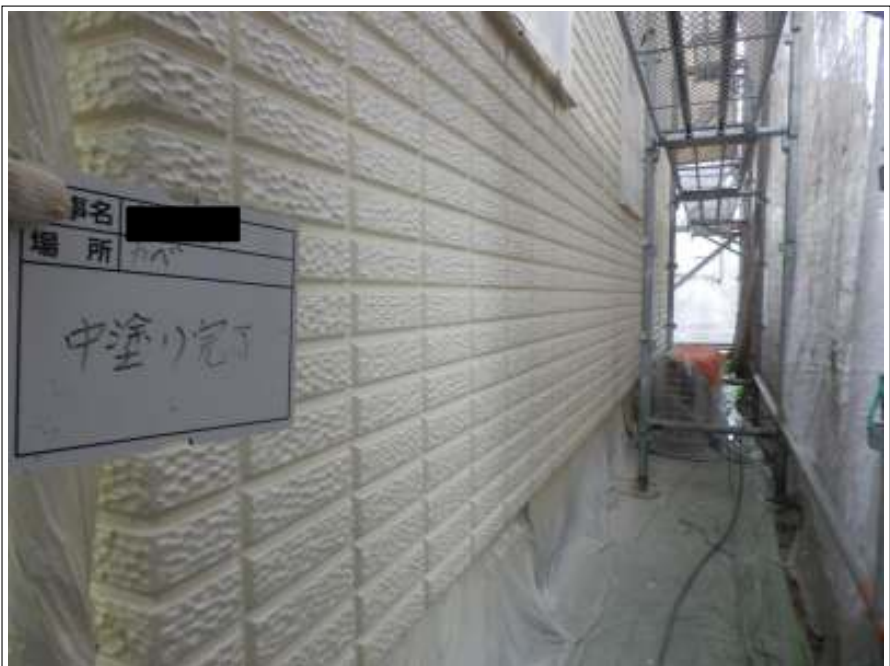
外壁 中塗り施工後
