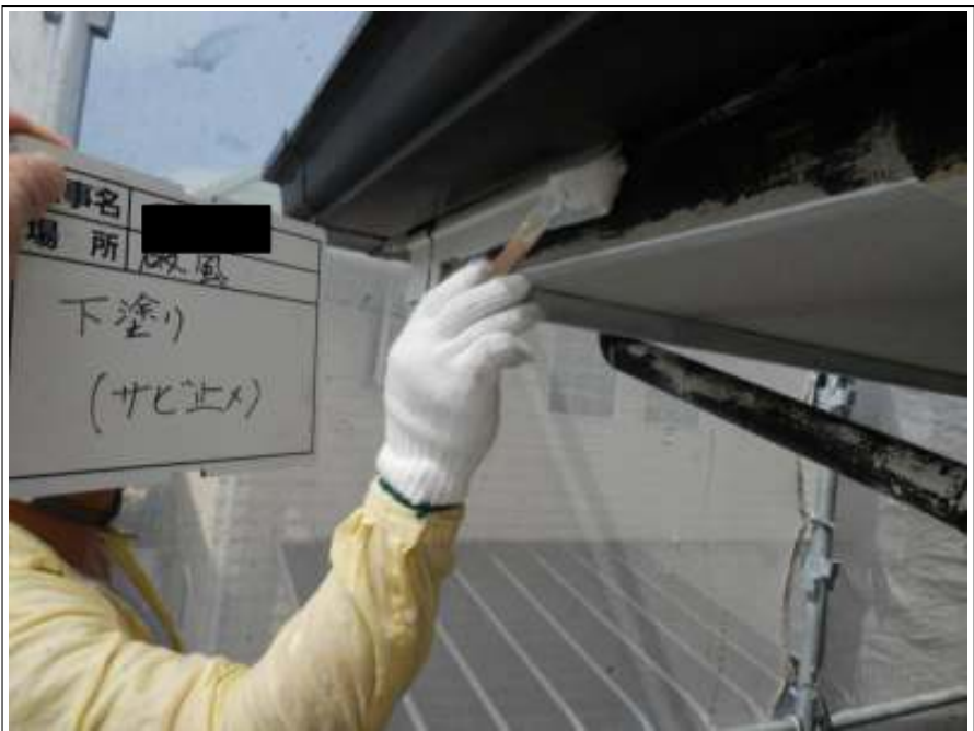
破風板 サビ止め塗布
