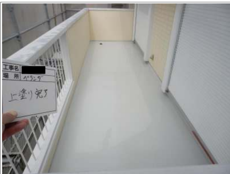
ベランダ床 上塗り施工後
