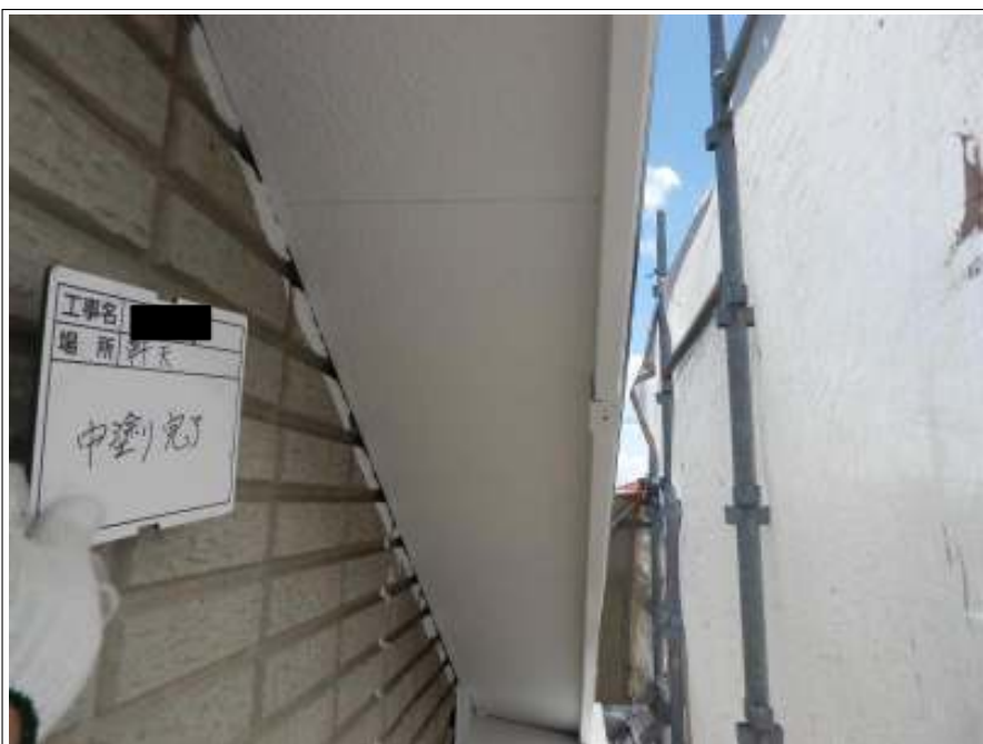
軒天 中塗り施工後
