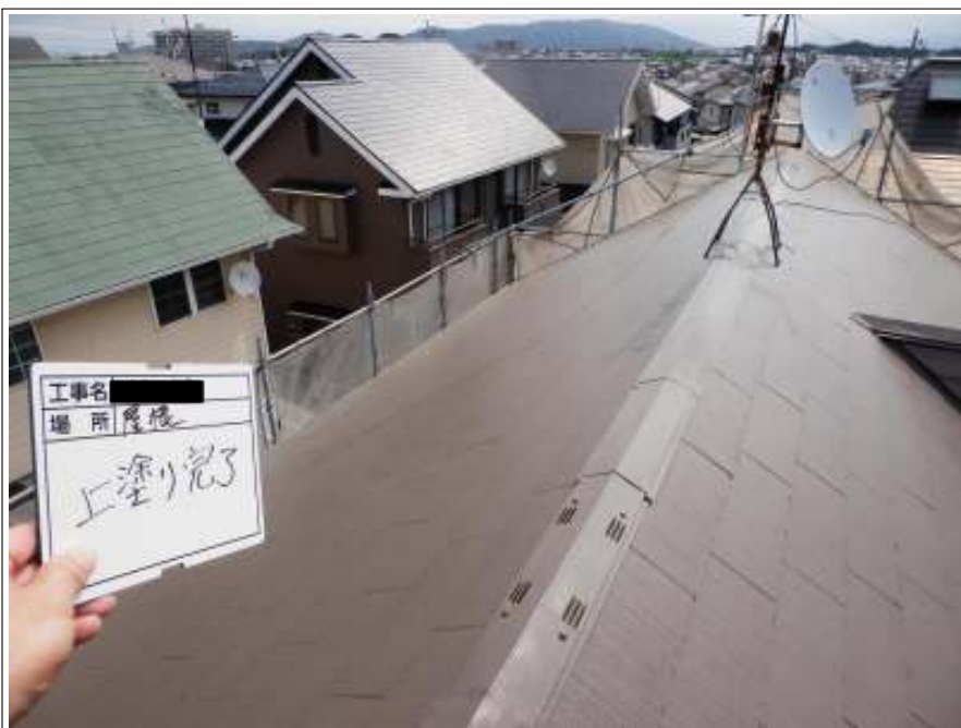
屋根 上塗り施工後
