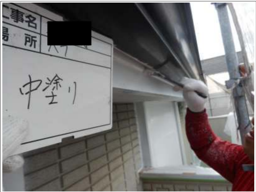
破風板 中塗り施工中
