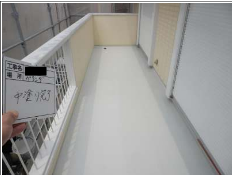
ベランダ床 中塗り施工後
