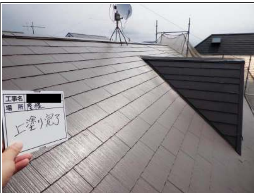
屋根 上塗り施工後
