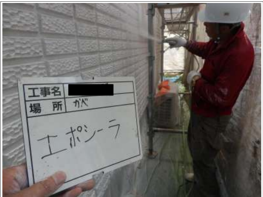
外壁 下塗り（1回目）施工中
