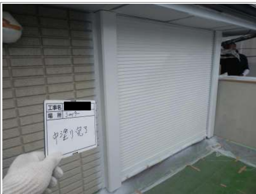
シャッター 中塗り施工後
