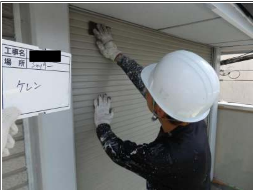
シャッター ケレン処理施工中
