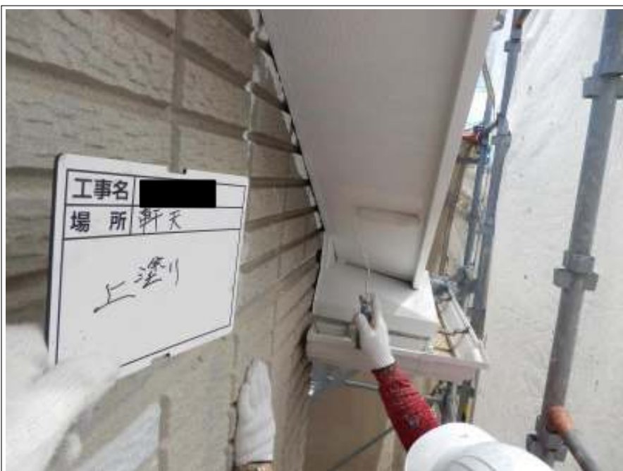
軒天 上塗り施工中
