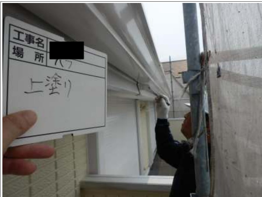
破風板 上塗り施工中
