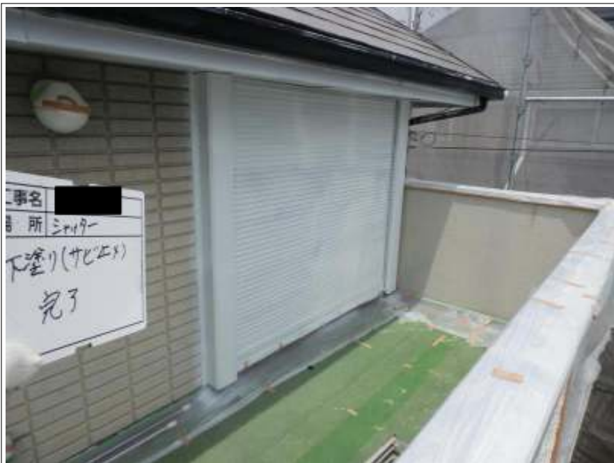
シャッター サビ止め塗布 施工後
