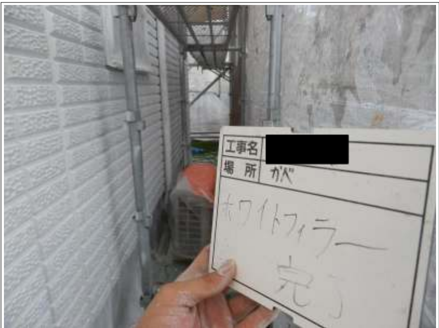
外壁 下塗り（2回目）施工後
