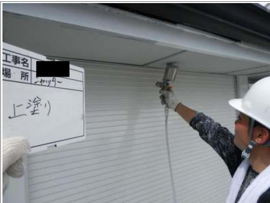
シャッター 上塗り施工中
