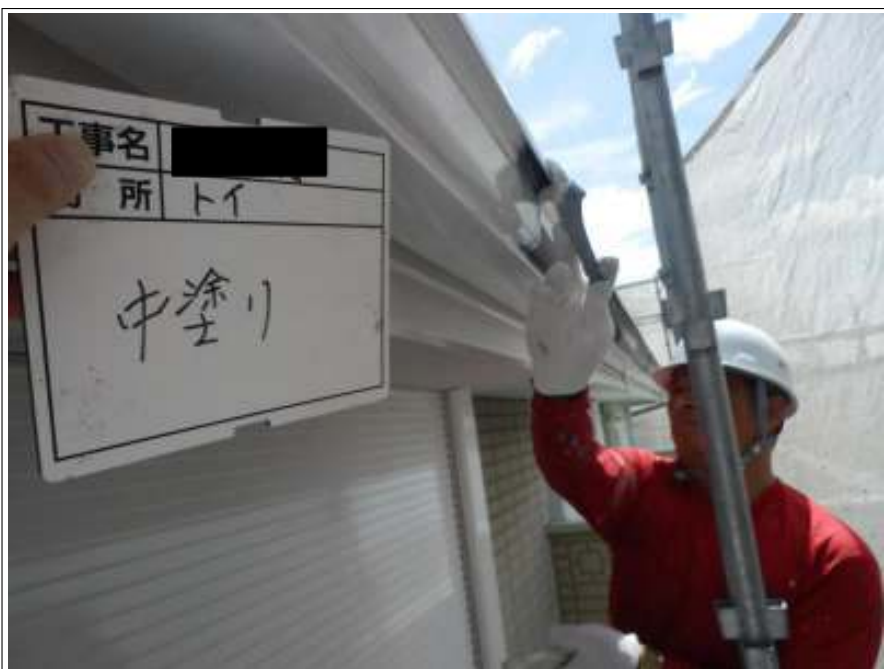
樋 中塗り施工中
