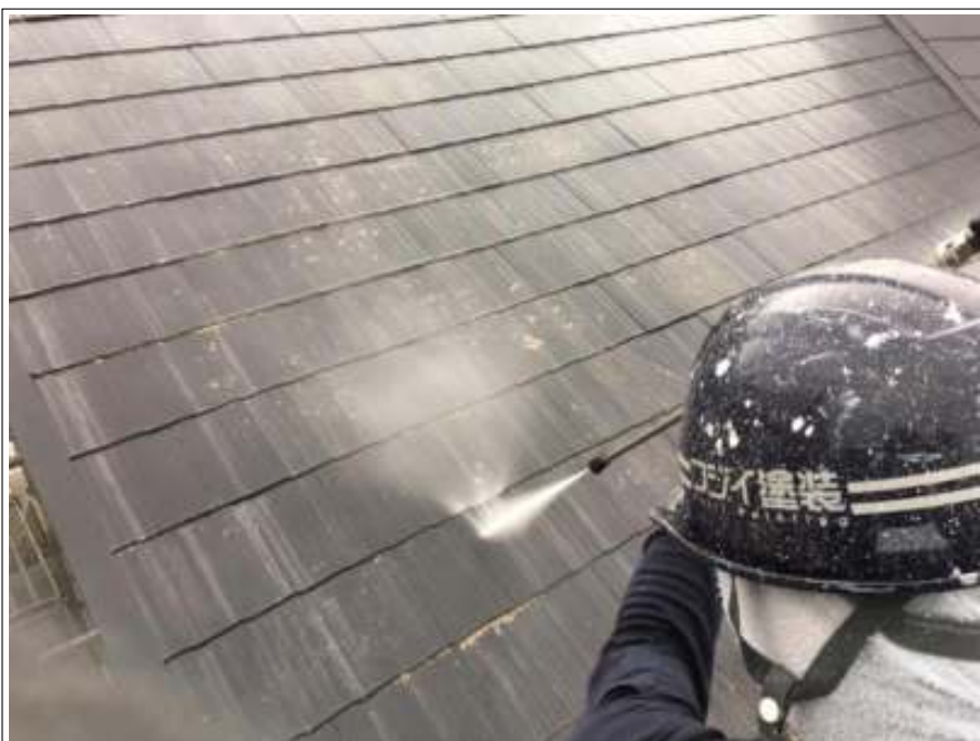
屋根 高圧洗浄中
