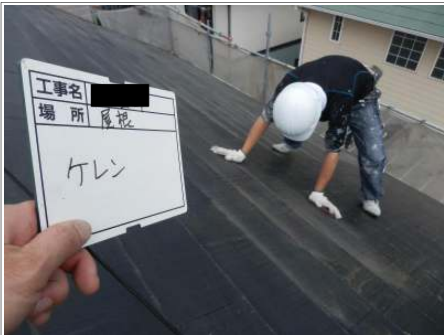
屋根 ケレン処理施工中
