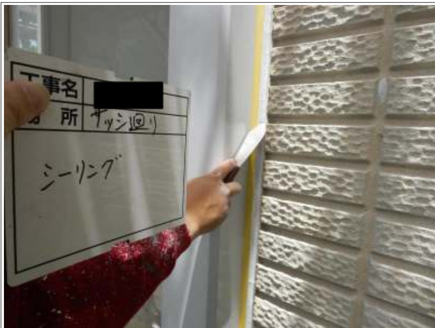
プライマー塗布
