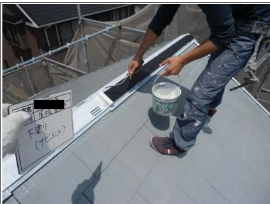
屋根板金部 サビ止め塗布施工中
