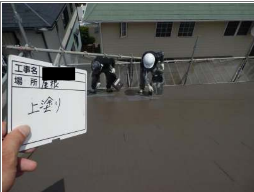
屋根 上塗り施工中
