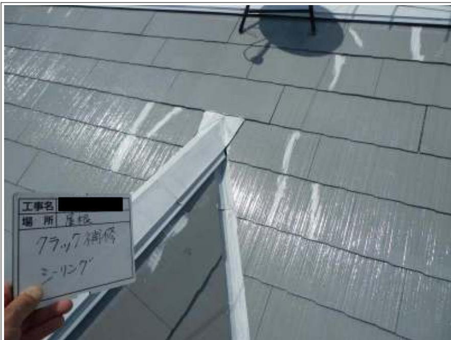
屋根 クラック補修施工後
