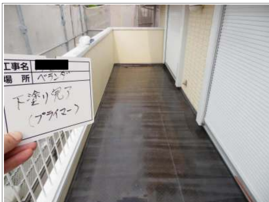
ベランダ床 下塗り施工後
