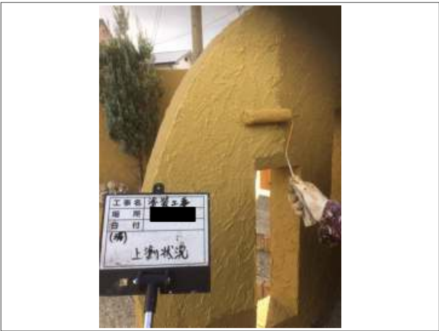
塀 上塗り施工中
