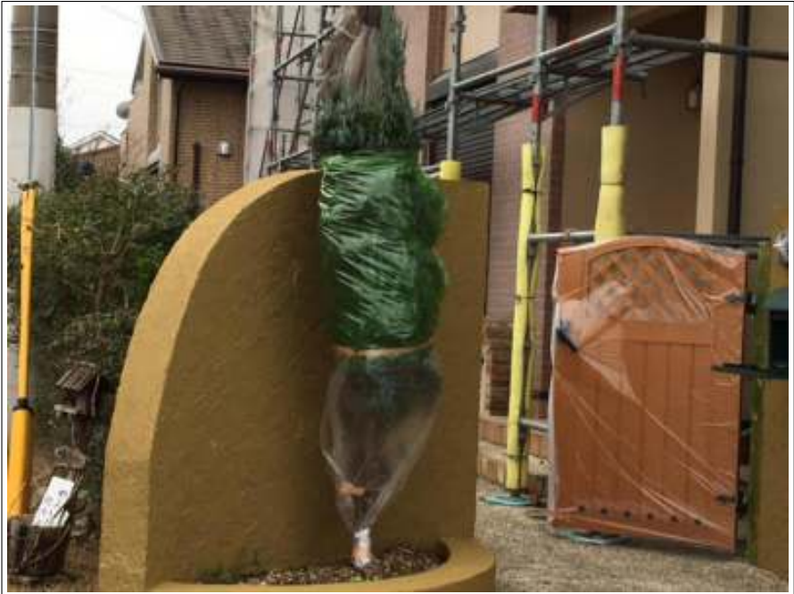
塀 上塗り施工完了
