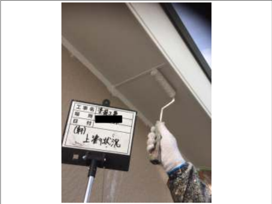
軒天 上塗り（2回目）施工中
