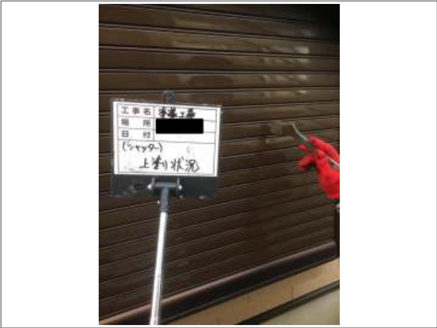
シャッター 上塗り(2回目) 施工中
