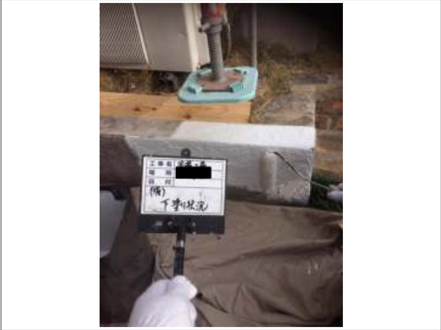
塀 下塗り施工中
