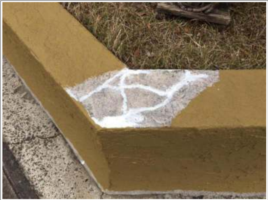
塀 下地補修中
