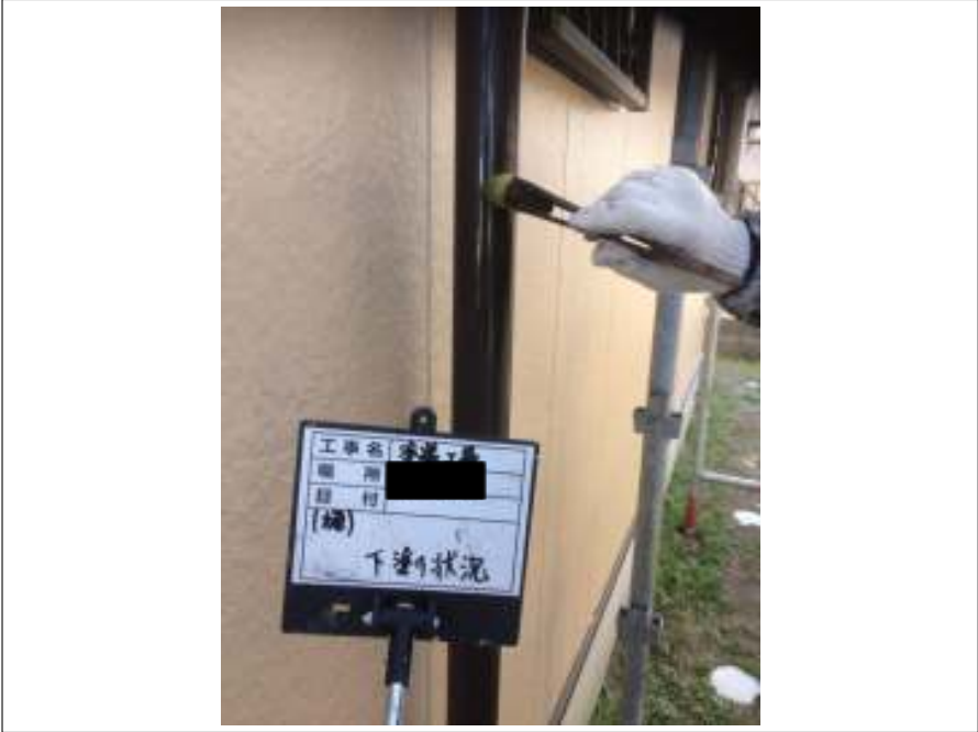
樋 下塗り施工中
