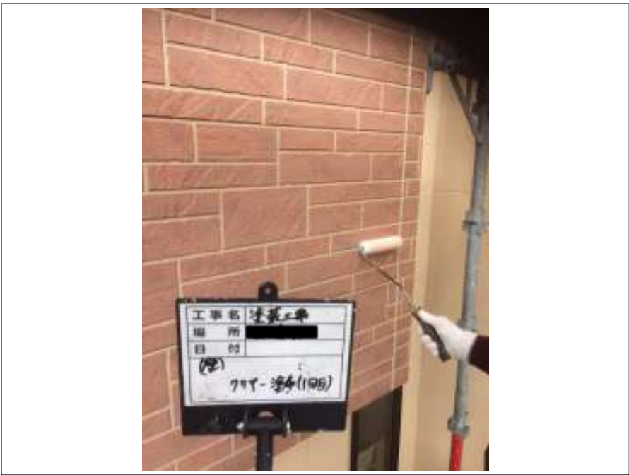
外壁 クリアー塗布（1回目）
