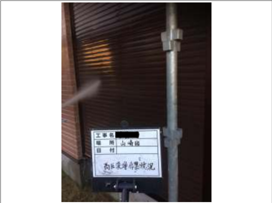
シャッター 高圧洗浄中
