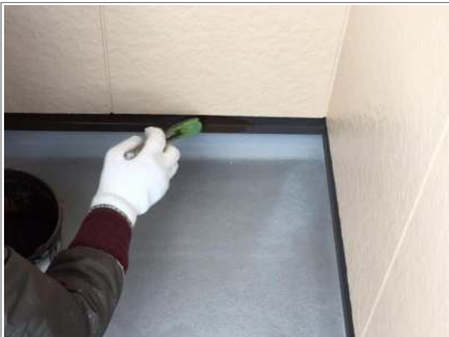
水切り 上塗り施工中
