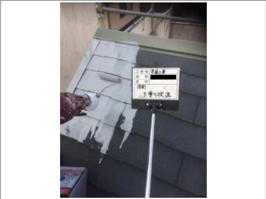
屋根 下塗り施工中
