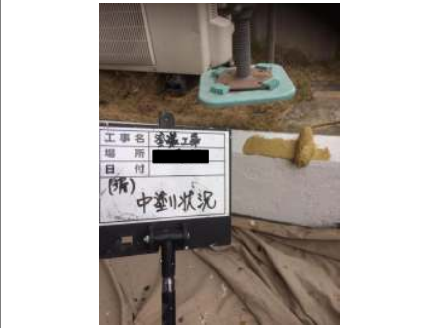
塀 中塗り施工中
