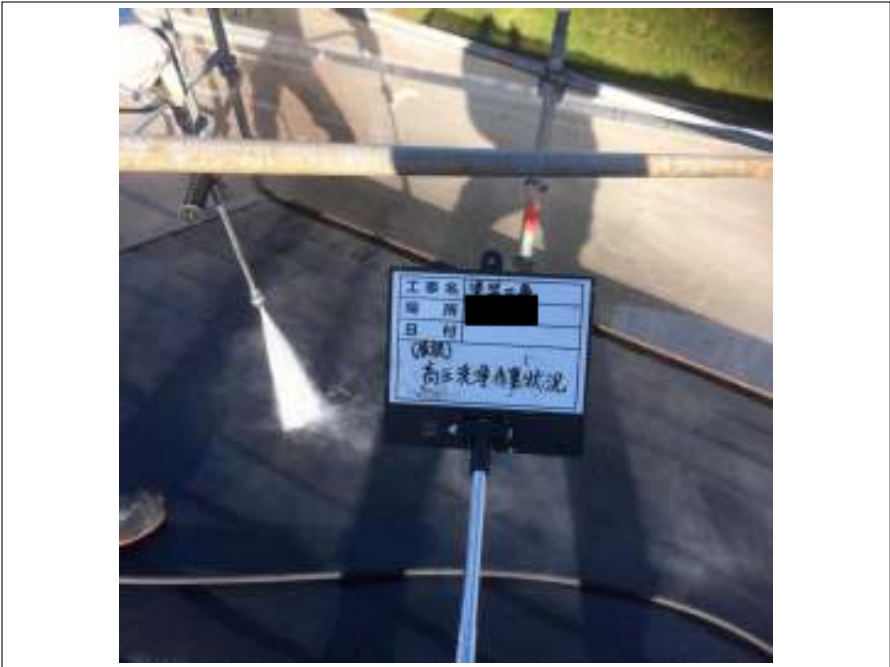
屋根 高圧洗浄中
