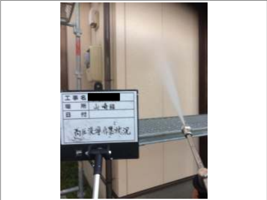
外壁 高圧洗浄中
