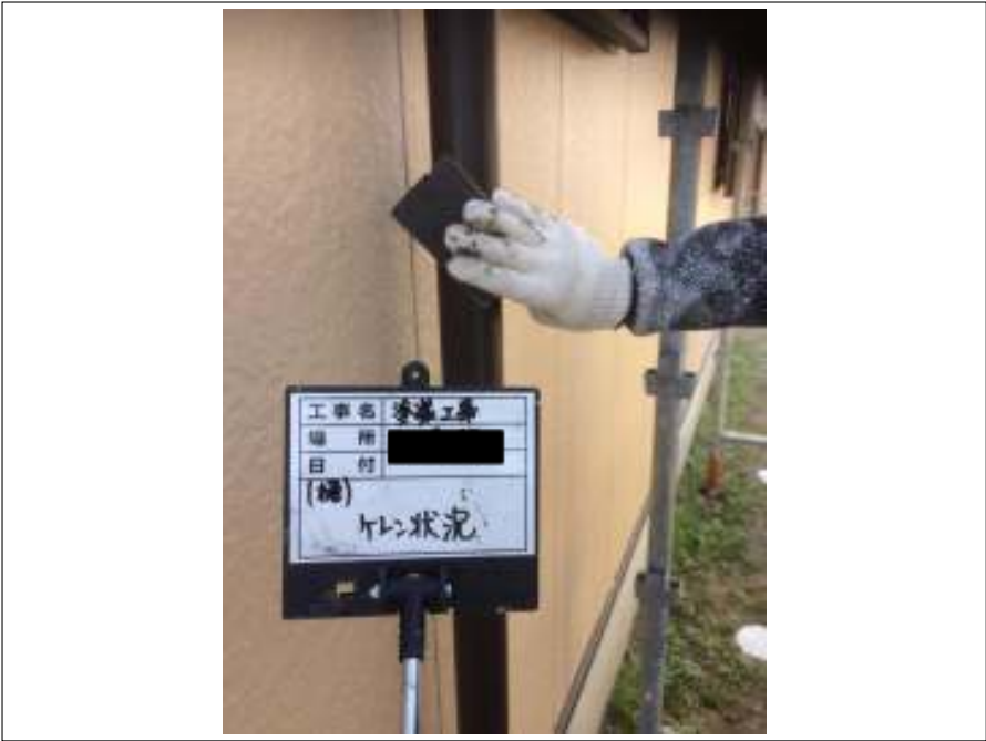
樋 ケレン作業
