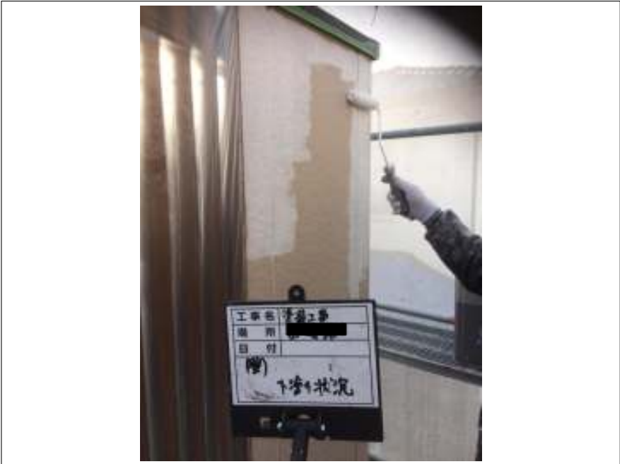
外壁 下塗り施工中
