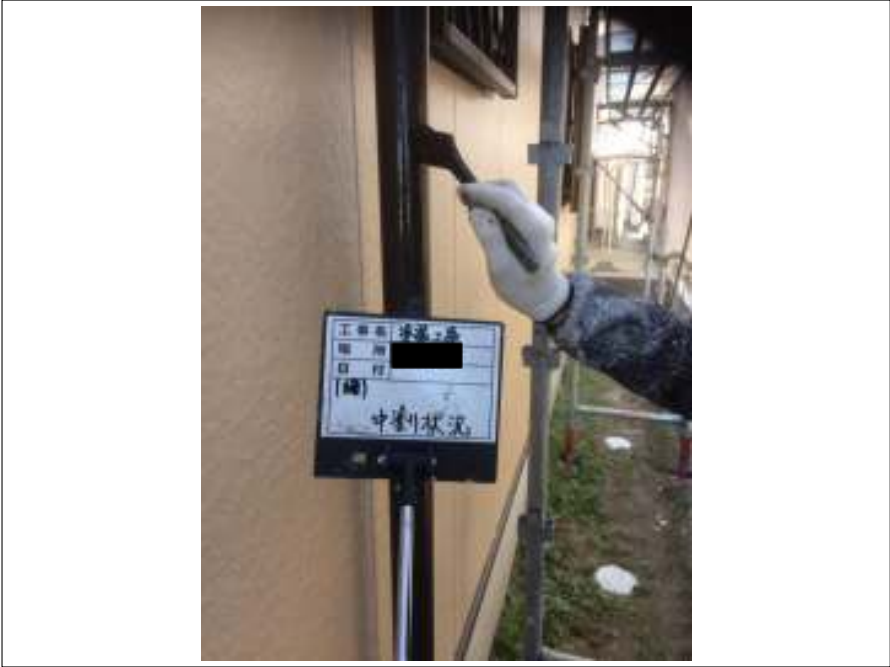
樋 中塗り施工中
