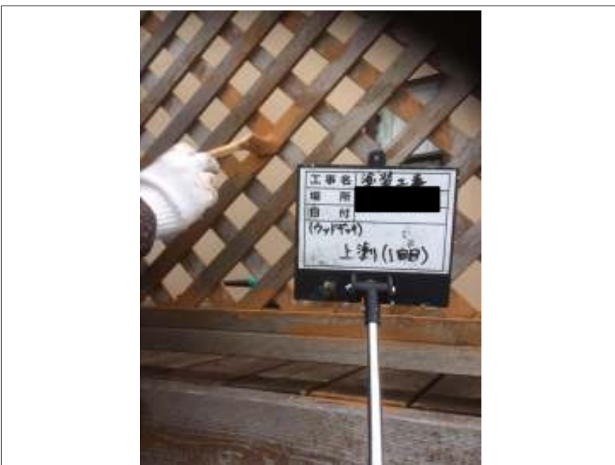
ウッドデッキ 上塗り（1回目）施工中
