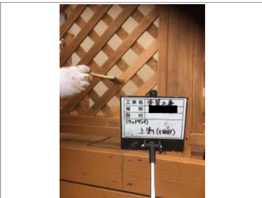
ウッドデッキ 上塗り（2回目）施工中
