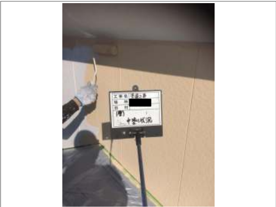
外壁 中塗り施工中
