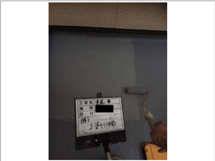
ベランダ床 上塗り(1回目) 施工中
