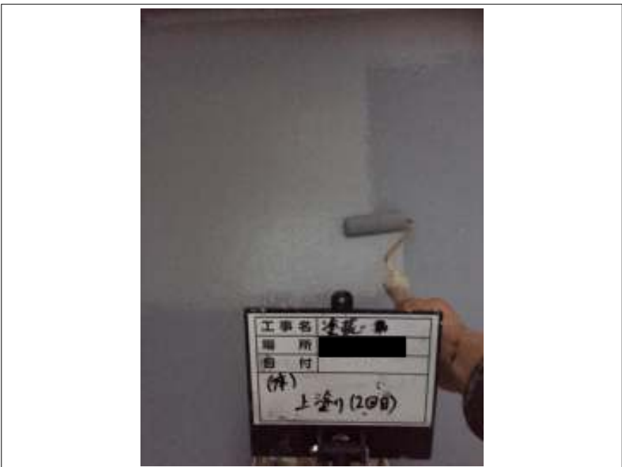
ベランダ床 上塗り(2回目) 施工中
