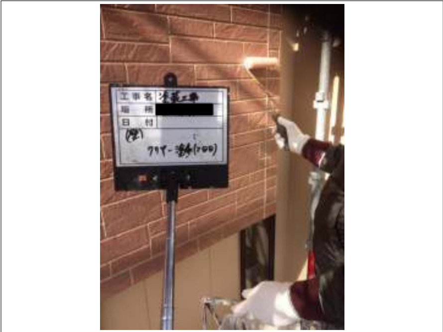
外壁 クリアー塗布（2回目）
