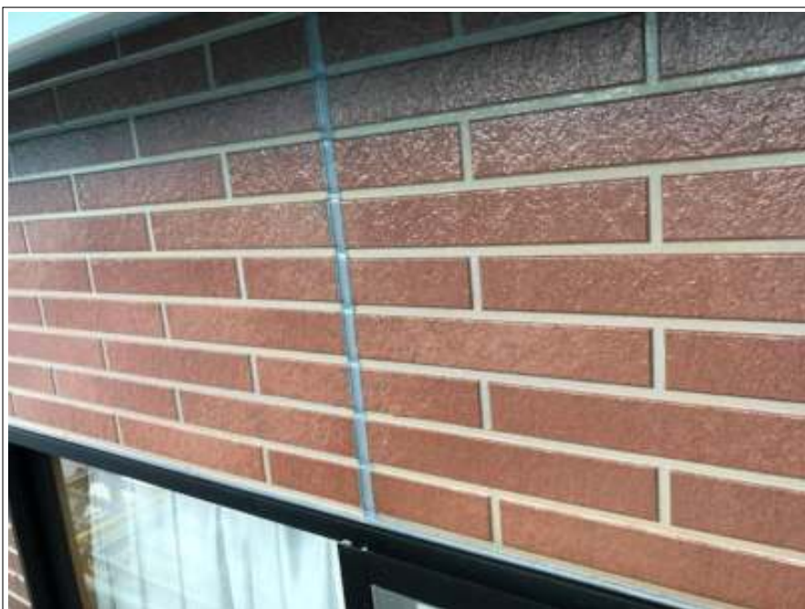
外壁クリヤー部 シーリング施工後
