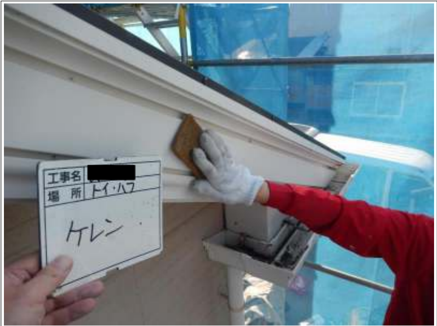
破風板 ケレン処理施工中
