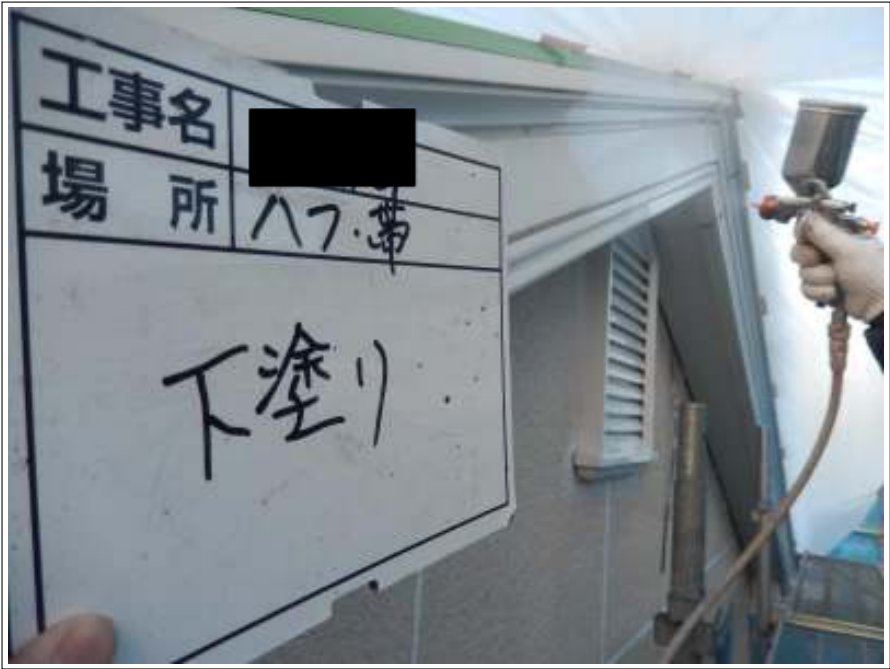
破風板 下塗り施工中
