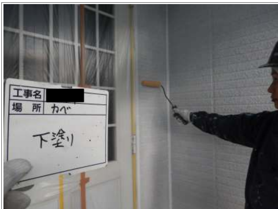
外壁 下塗り施工中
