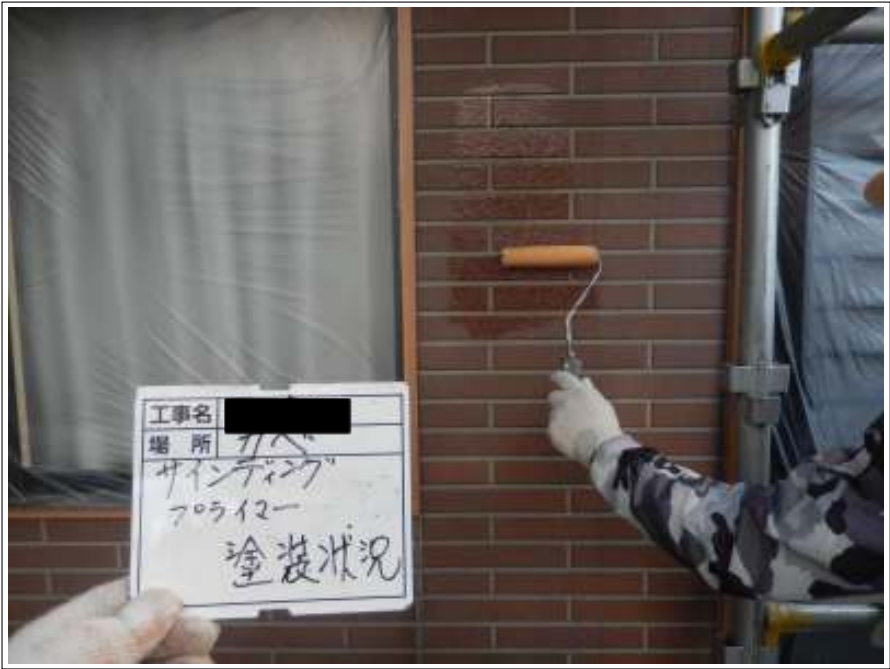
外壁クリヤー部 下塗り施工中
