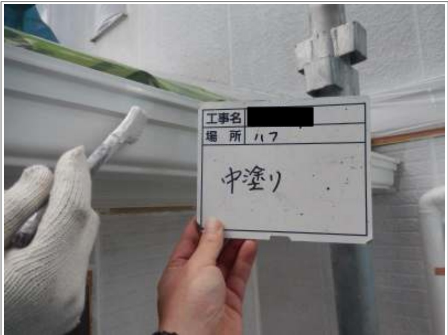
破風板 中塗り施工中
