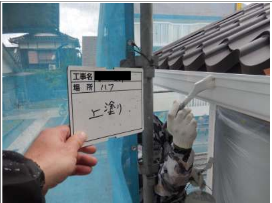
破風板 上塗り施工中
