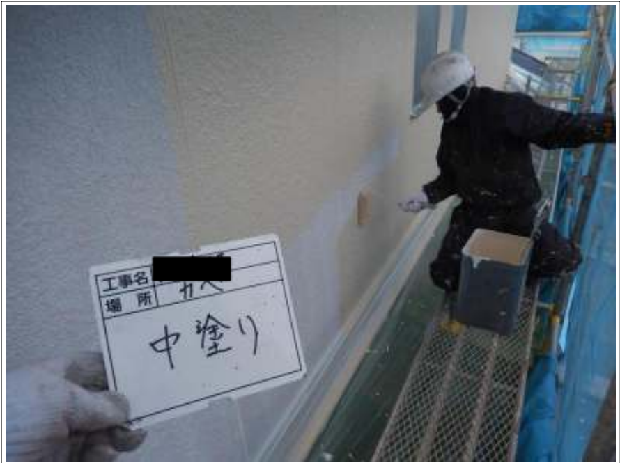
外壁 中塗り施工中
