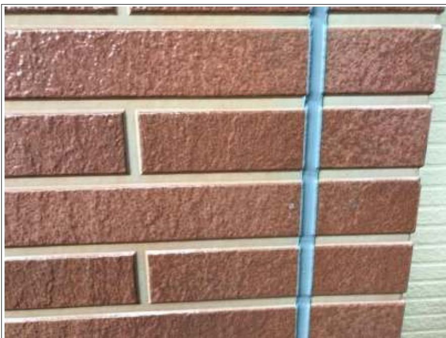
外壁クリヤー部 シーリング施工後
