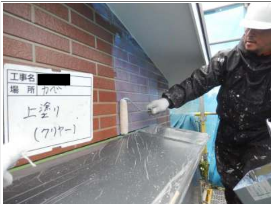
外壁クリヤー部 上塗り施工中
