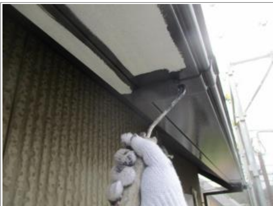
樋 上塗り施工後
