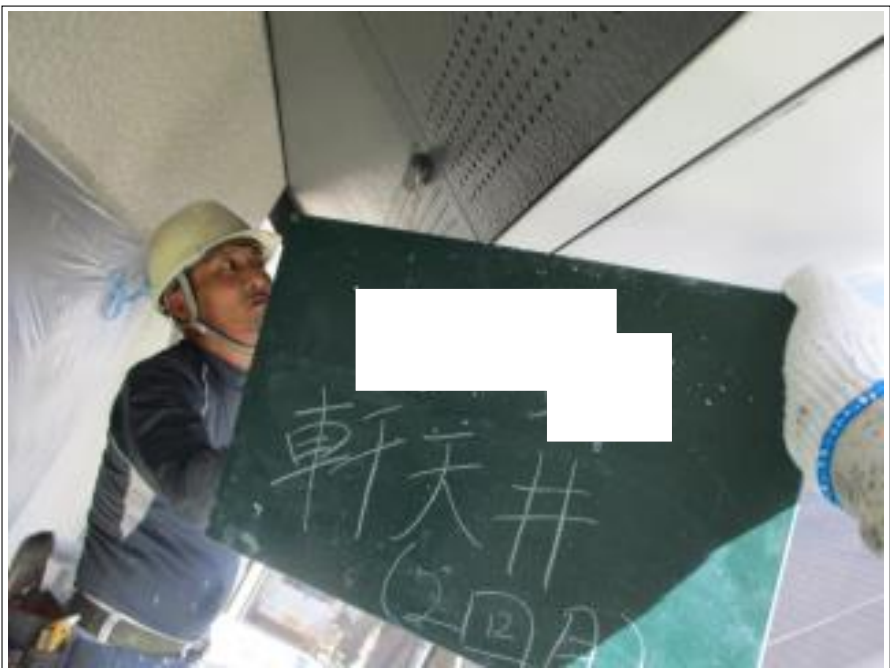
軒天 上塗り（2回目）施工中
