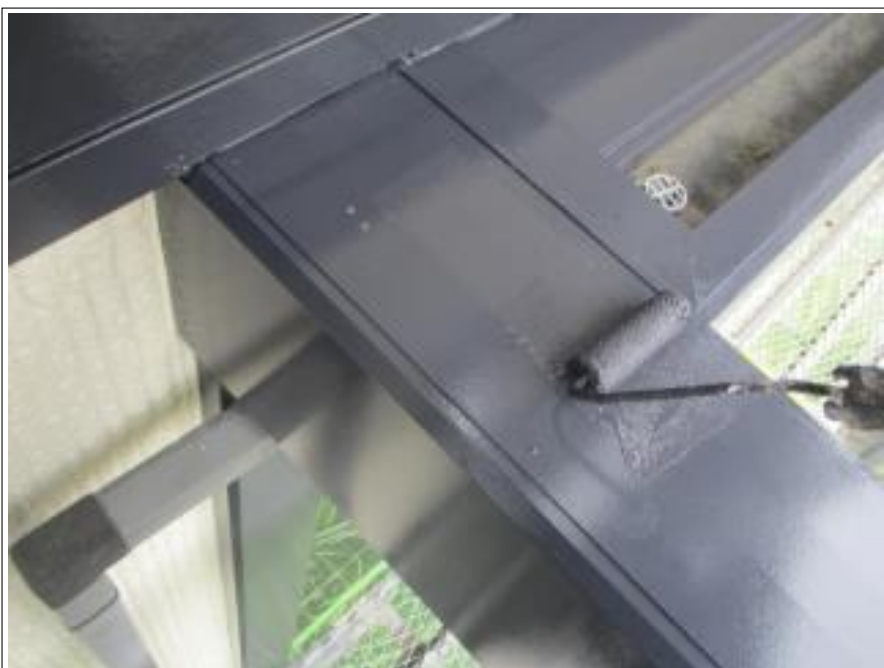
鉄部 上塗り施工中
