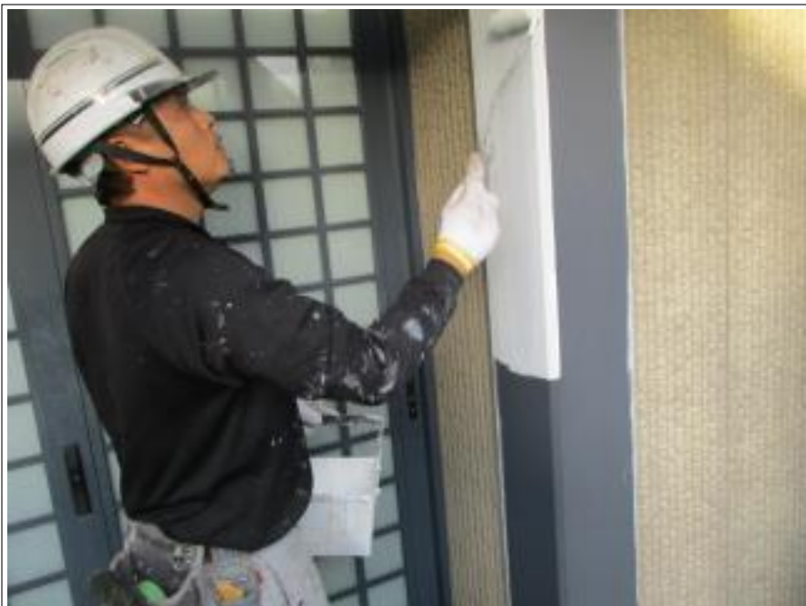
鉄部 下塗り施工中
