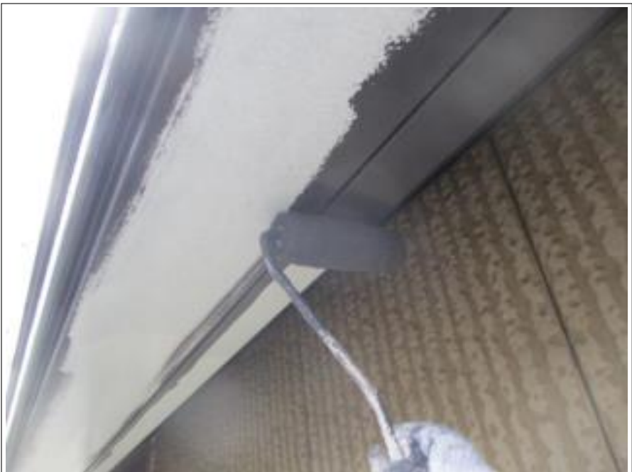
樋 上塗り施工後
