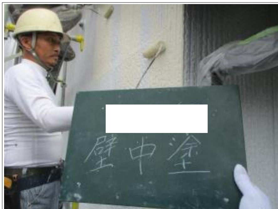
外壁 中塗り施工中
