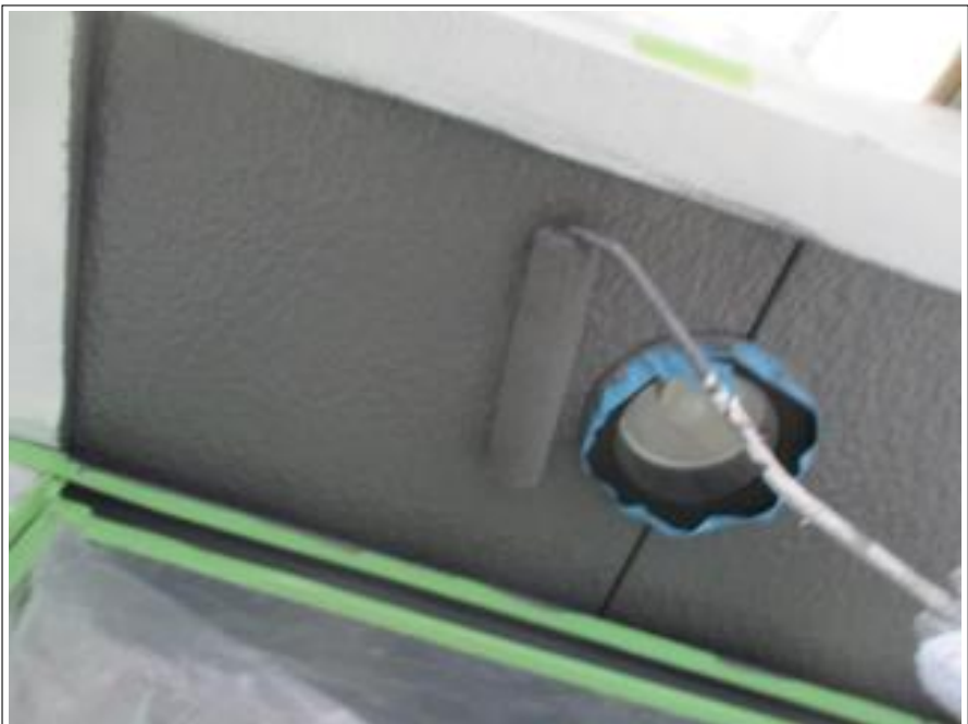
軒天 上塗り（2回目）施工中
