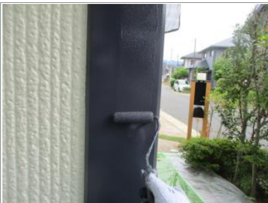
鉄部 中塗り施工中
