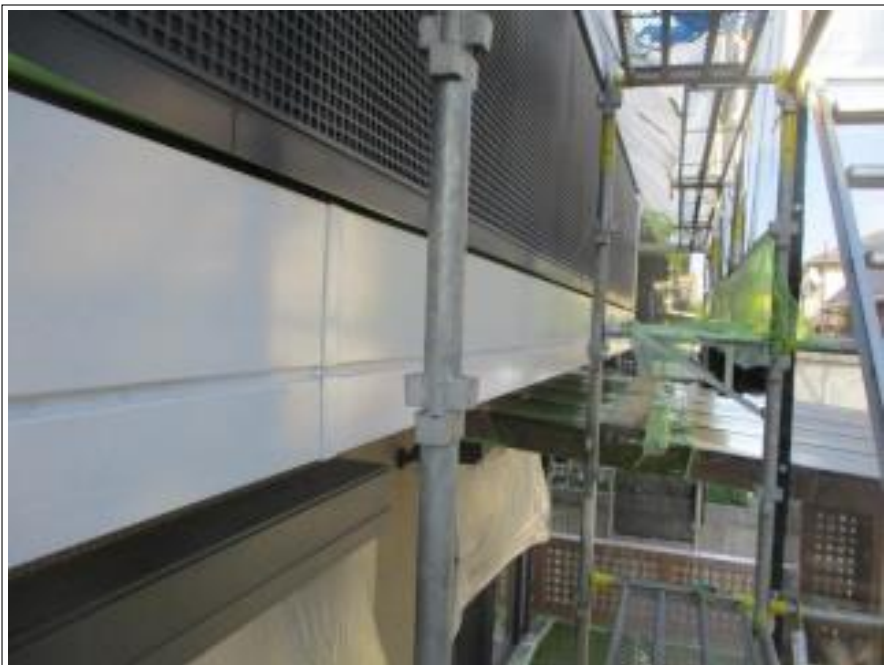
帯 下塗り施工後
