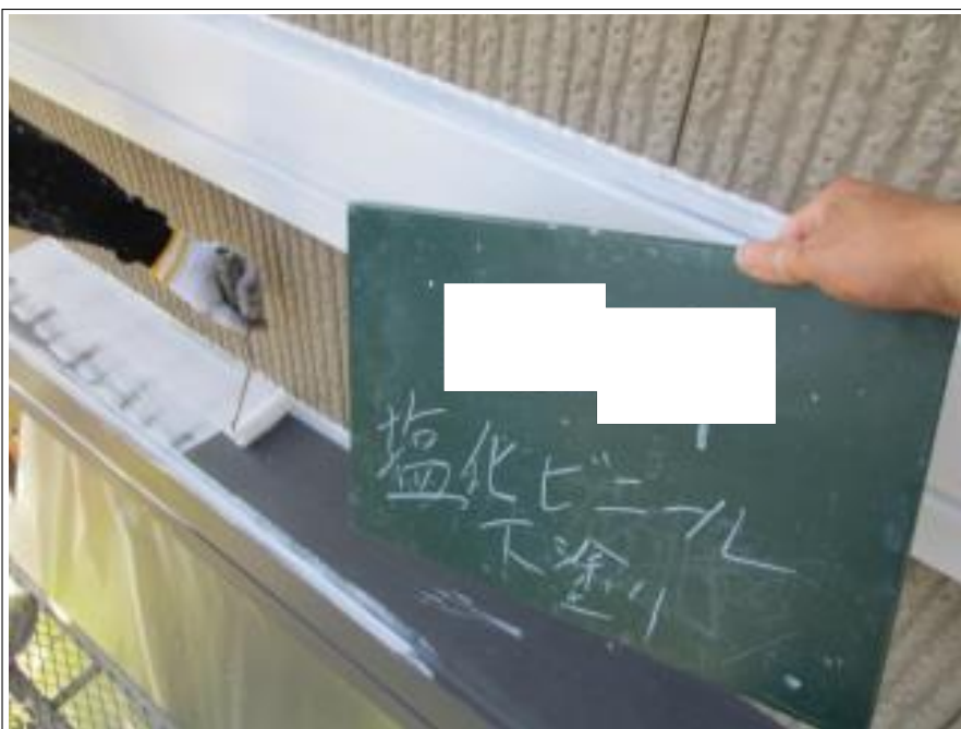
シャッターBOX 下塗り施工中
