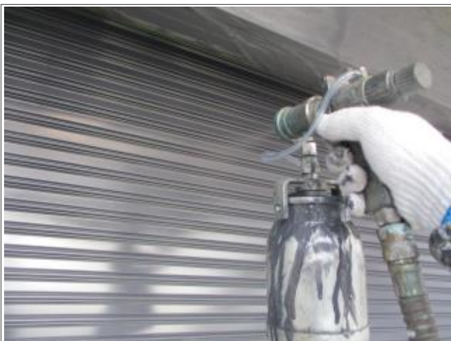
シャッター 上塗り施工中
