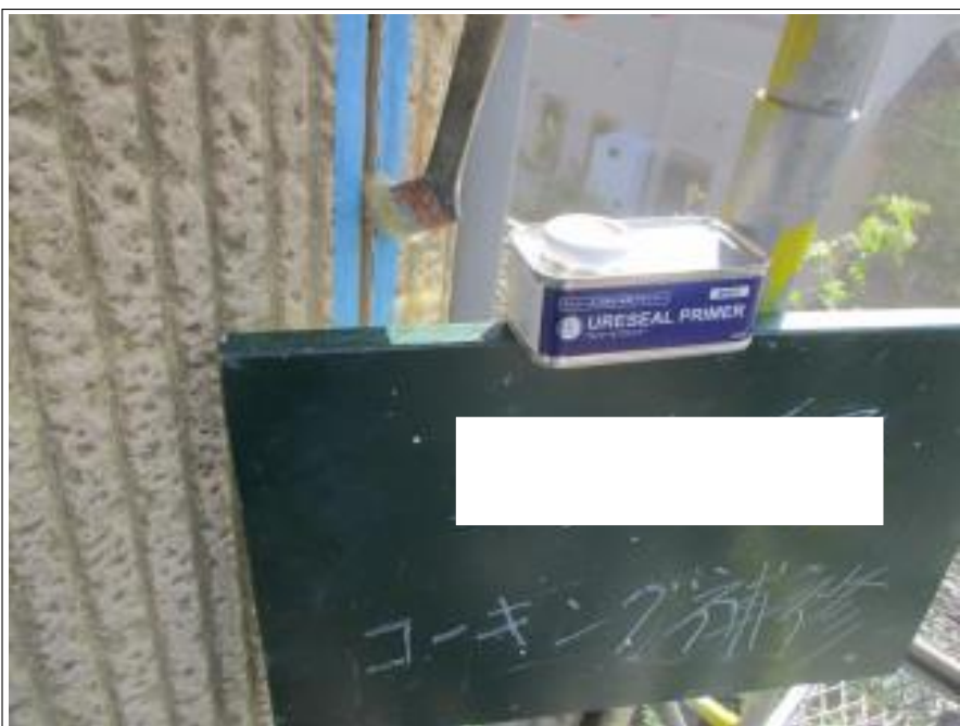
プライマー塗布
