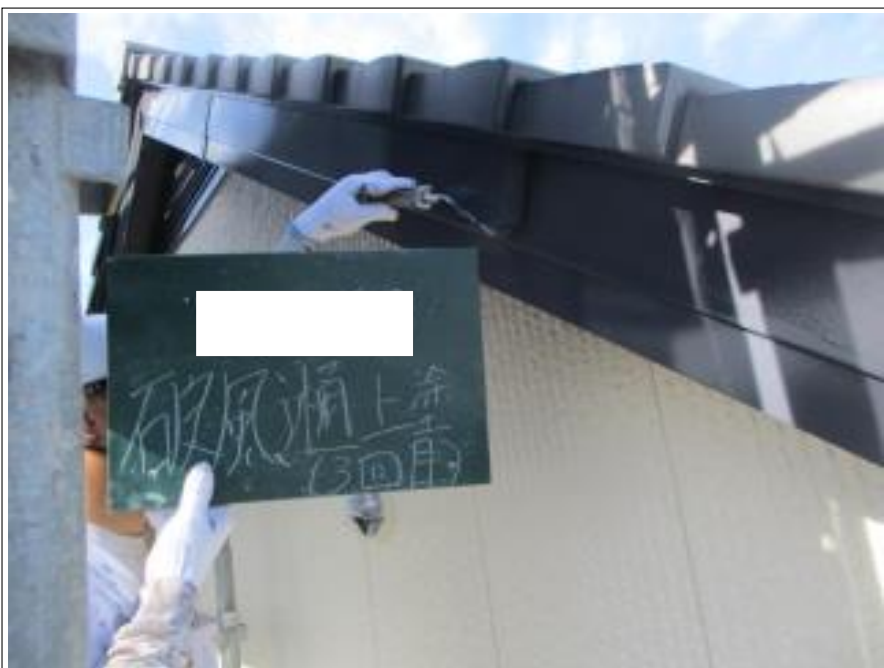
破風板 上塗り施工中
