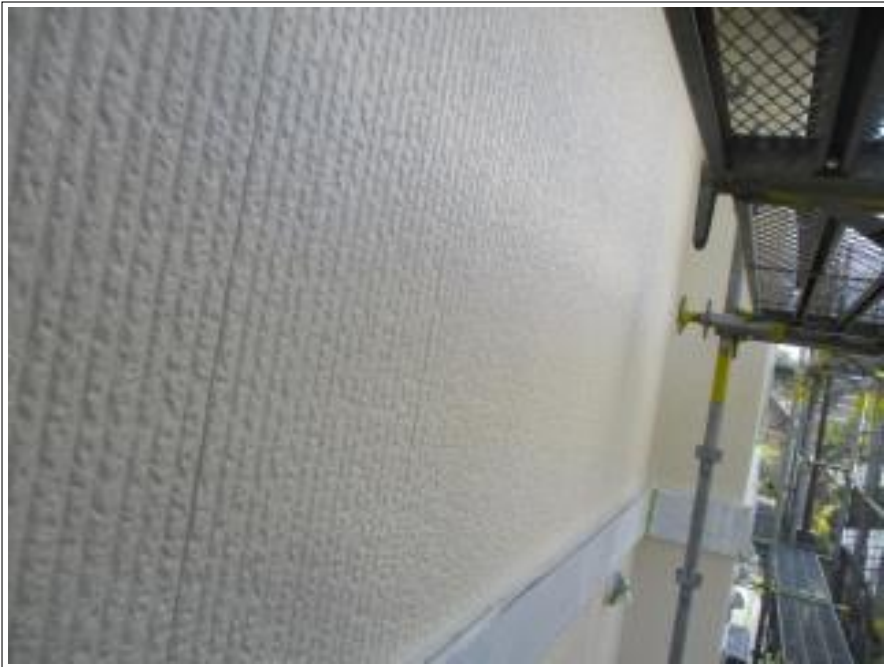
外壁 中塗り施工後
