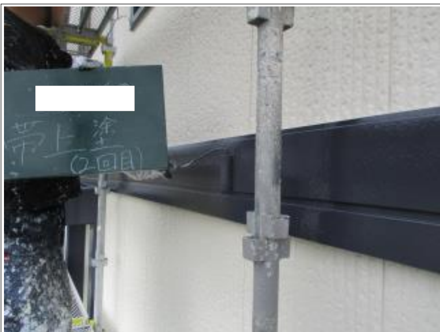
外壁 上塗り施工中
