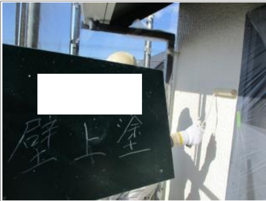
外壁 上塗り施工中
