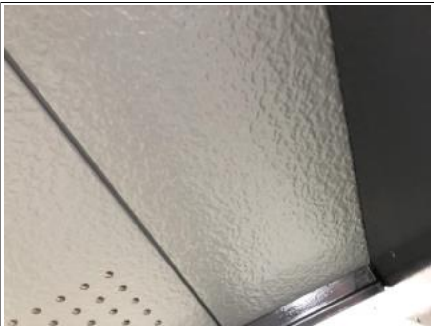
軒天 施工完了
