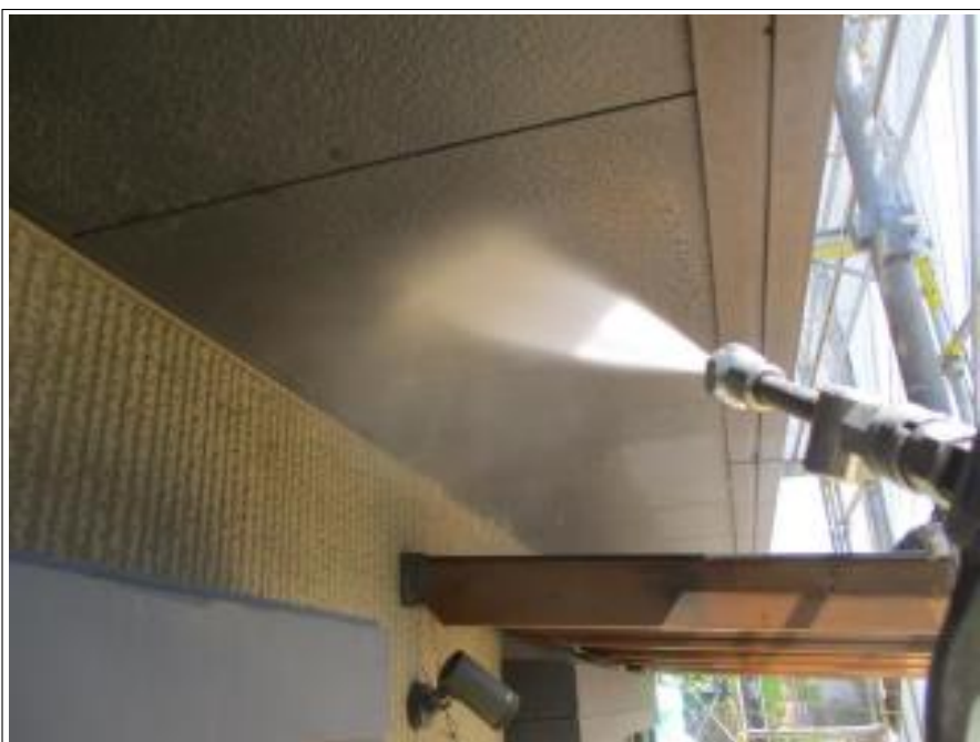
軒天 高圧洗浄中
