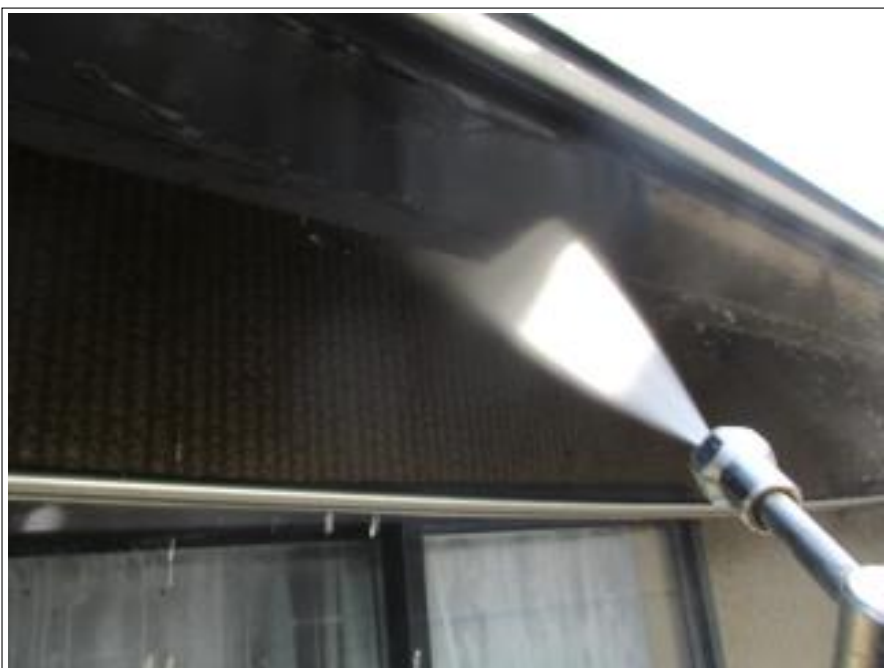
破風板・樋 高圧洗浄中
