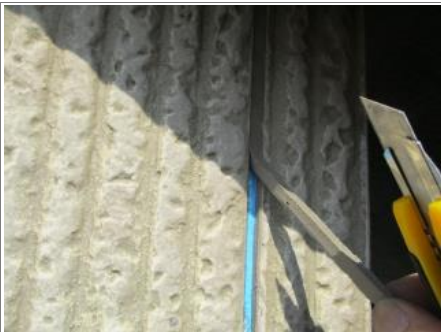
既存シーリング 撤去
