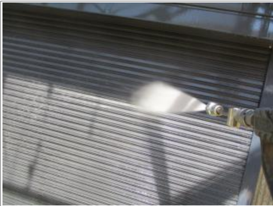
シャッター 高圧洗浄中
