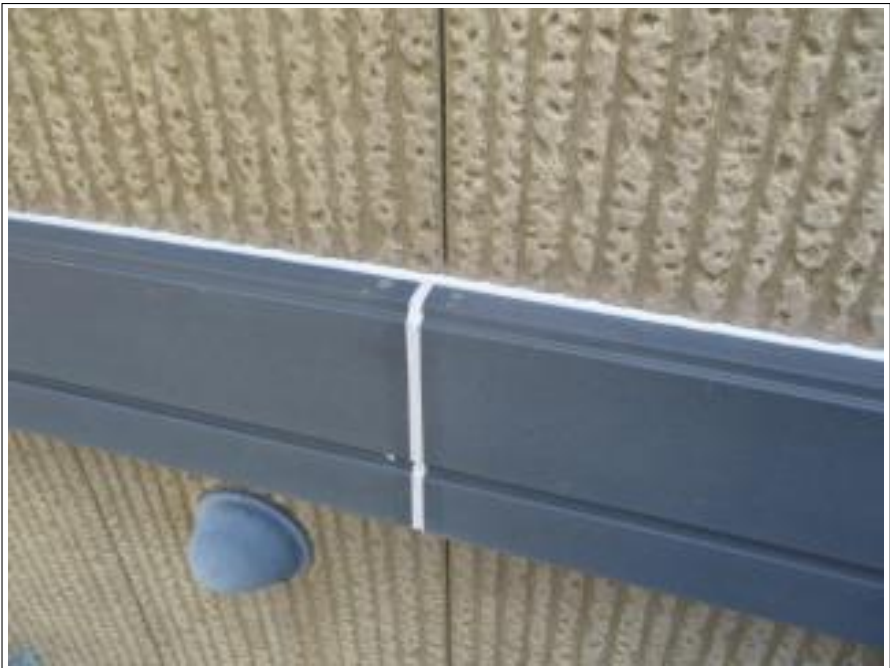
シーリング打ち替え 施工後
