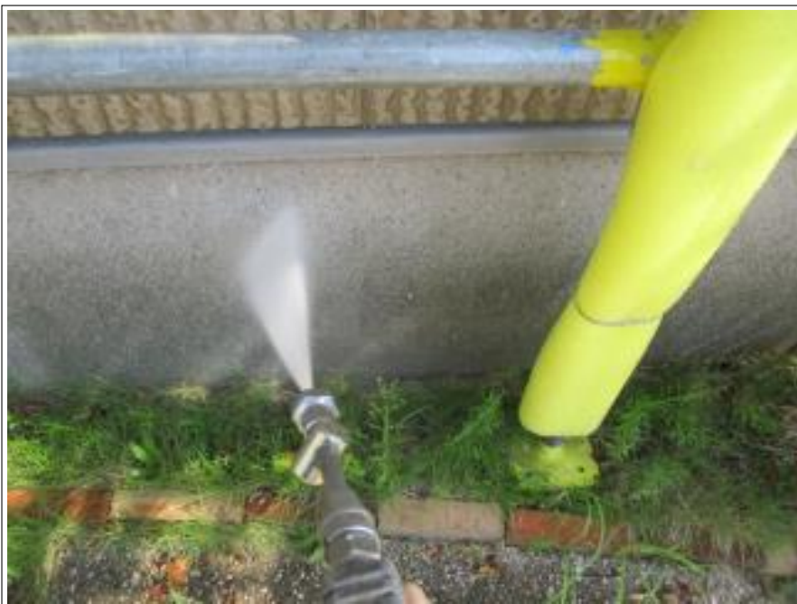
基礎 高圧洗浄中
