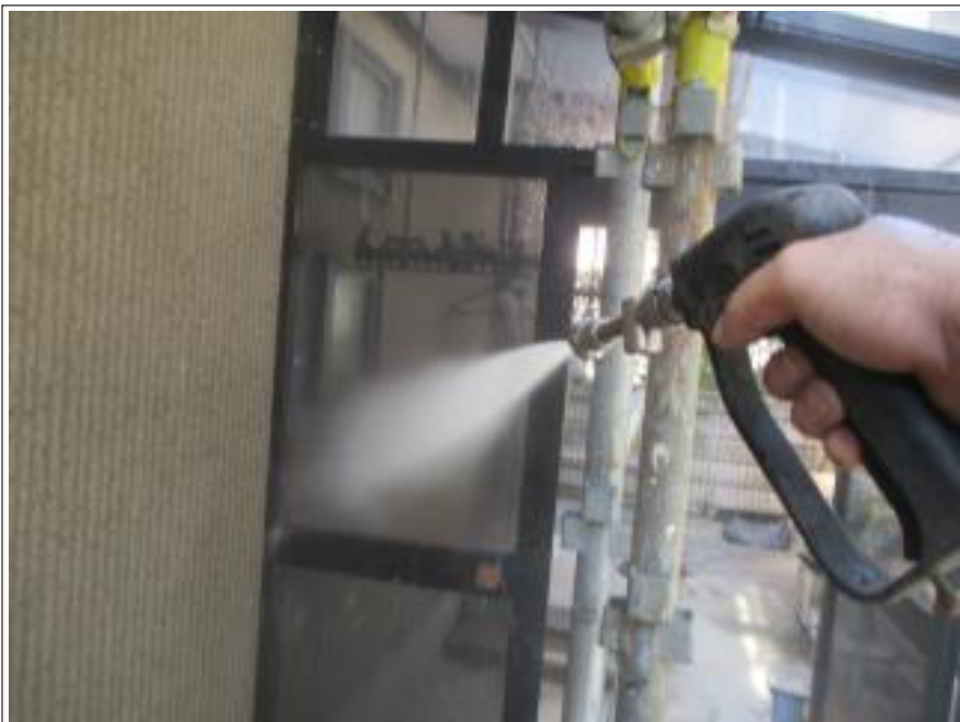
外壁 高圧洗浄中
