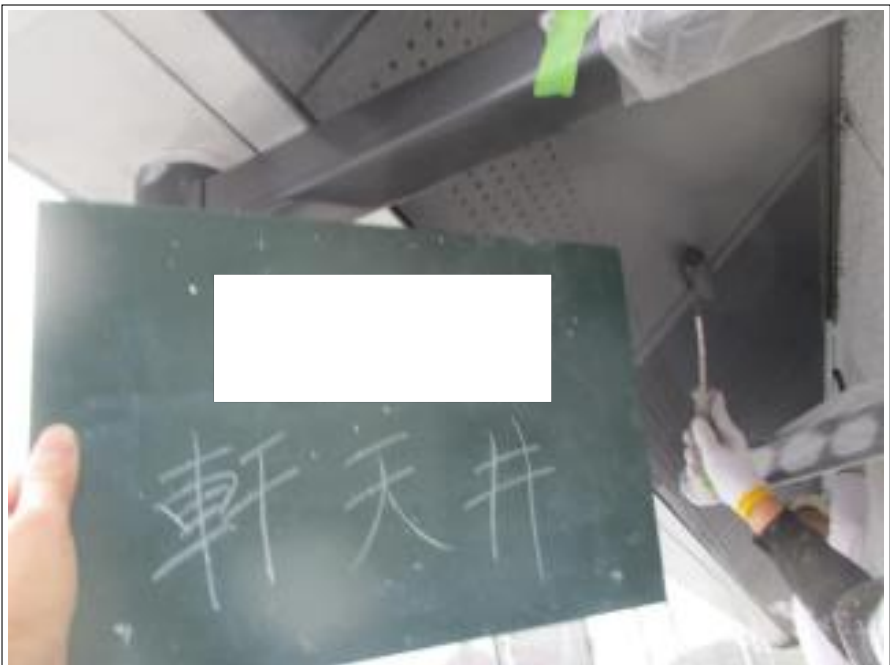
軒天 上塗り（1回目）施工中
