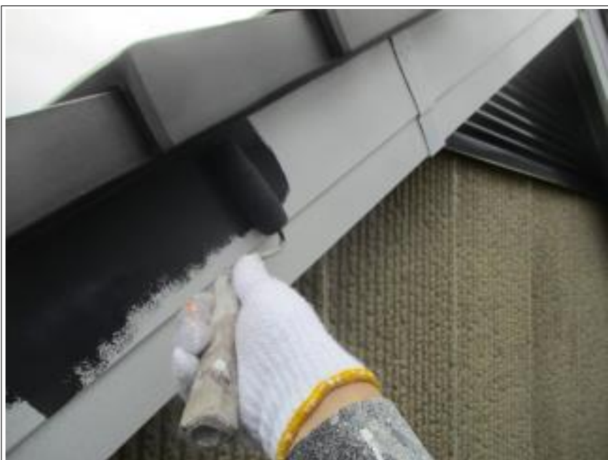
破風板 中塗り施工中
