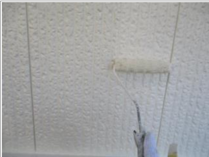
外壁 上塗り施工中
