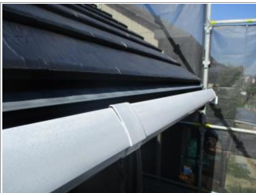
樋 下塗り施工後
