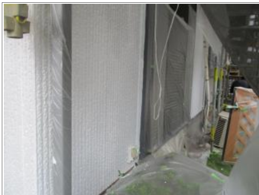
外壁 下塗り施工後
