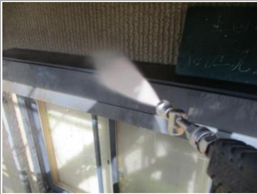
シャッターBOX 高圧洗浄中
