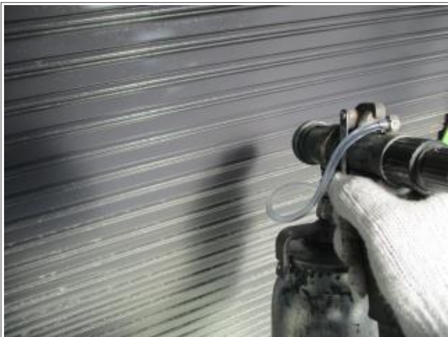
シャッター 中塗り施工中
