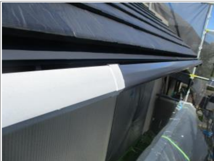
樋 下塗り施工中
