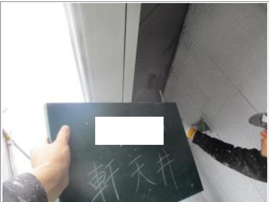
軒天 上塗り（1回目）施工中
