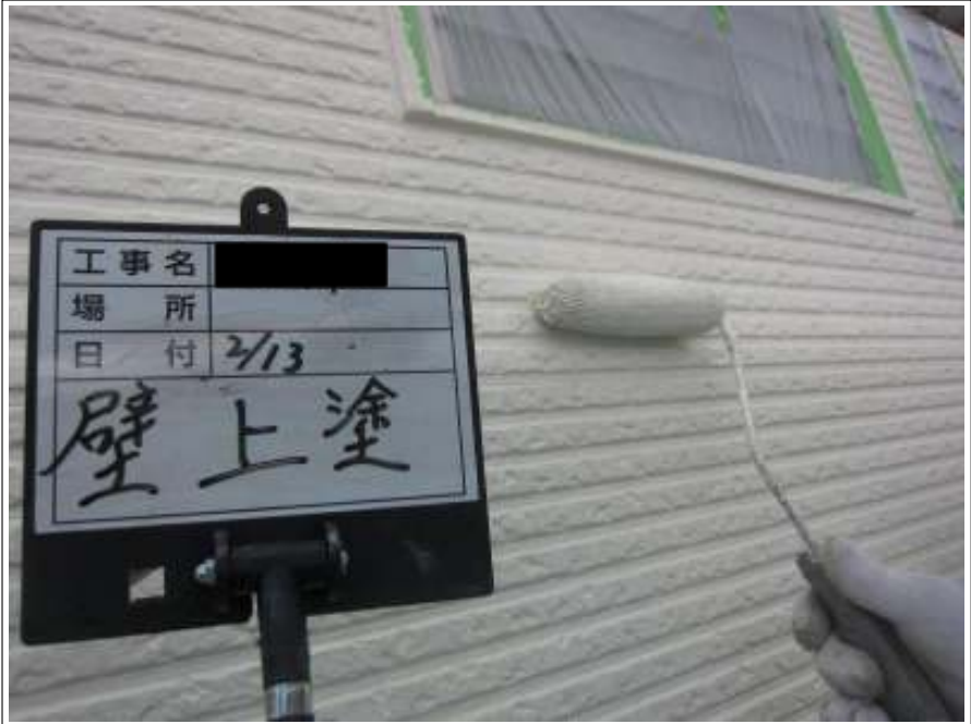
外壁 上塗り施工中
