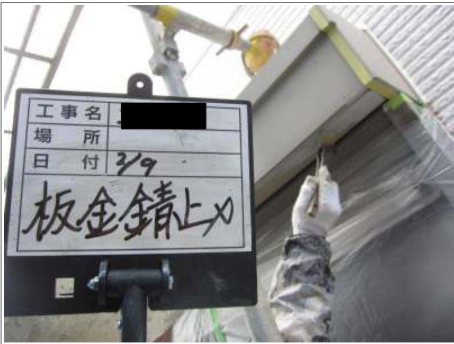
シャッターBOX サビ止め塗布中
