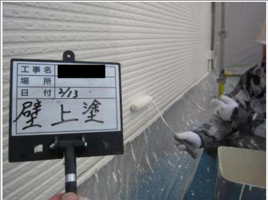
外壁 上塗り施工中
