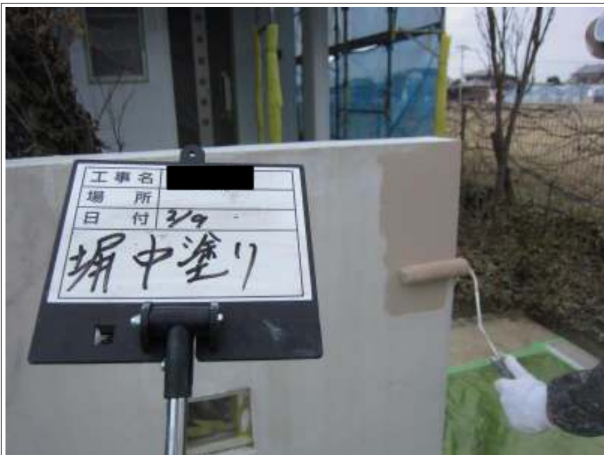
塙 中塗り施工中
