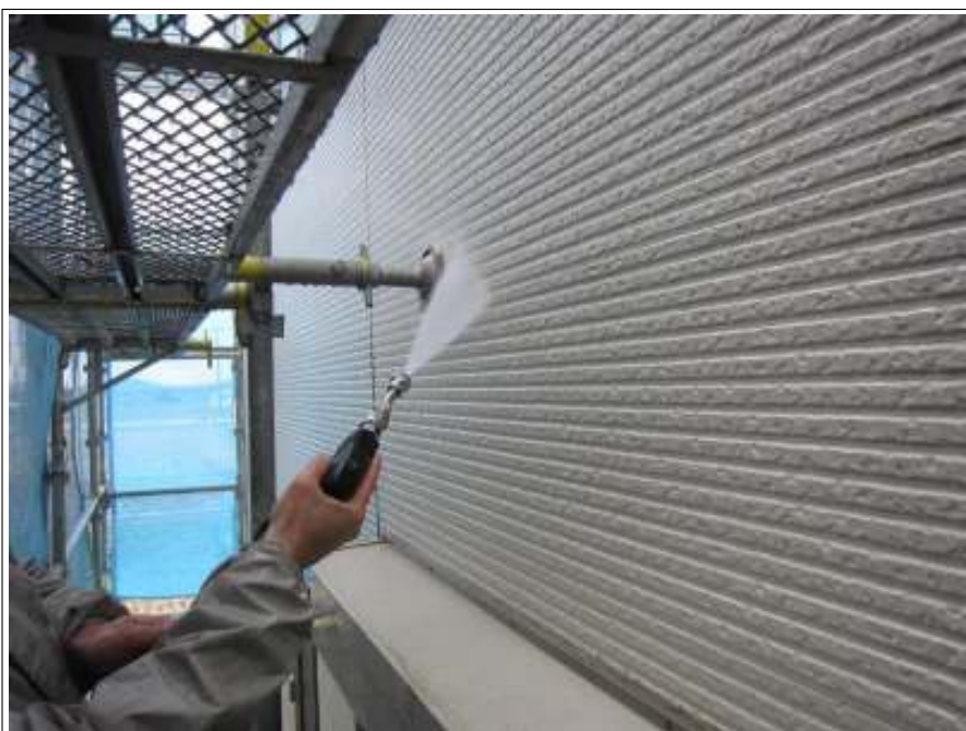
外壁 高圧洗浄中
