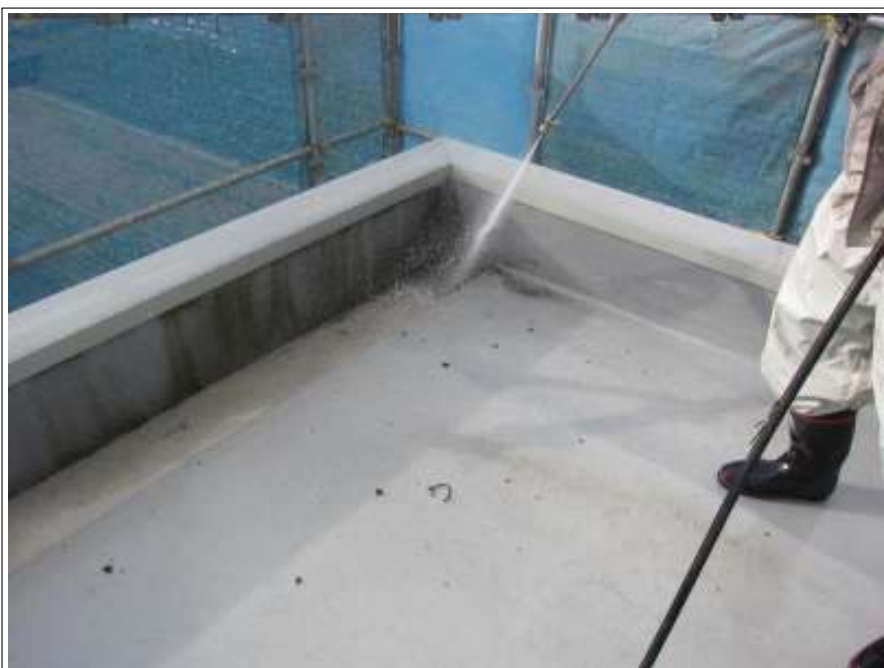
屋根 高圧洗浄中
