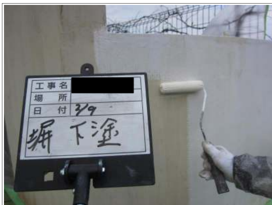
塀 下塗り施工中
