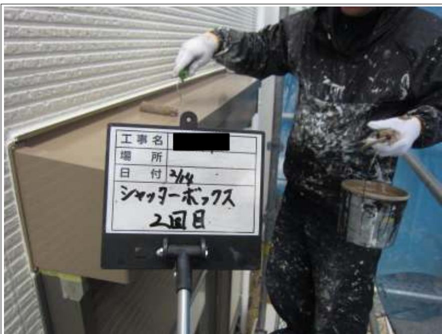
シャッターBOX 上塗り施工中
