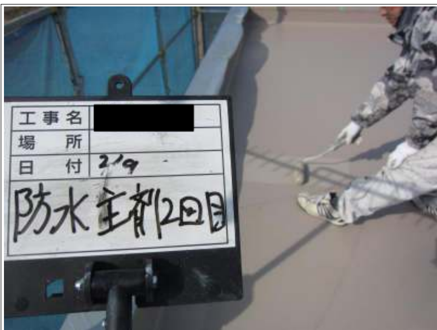
屋根 中塗り施工中 (2回目)
