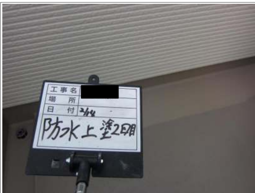
ベランダ 上塗り（2回目）施工中
