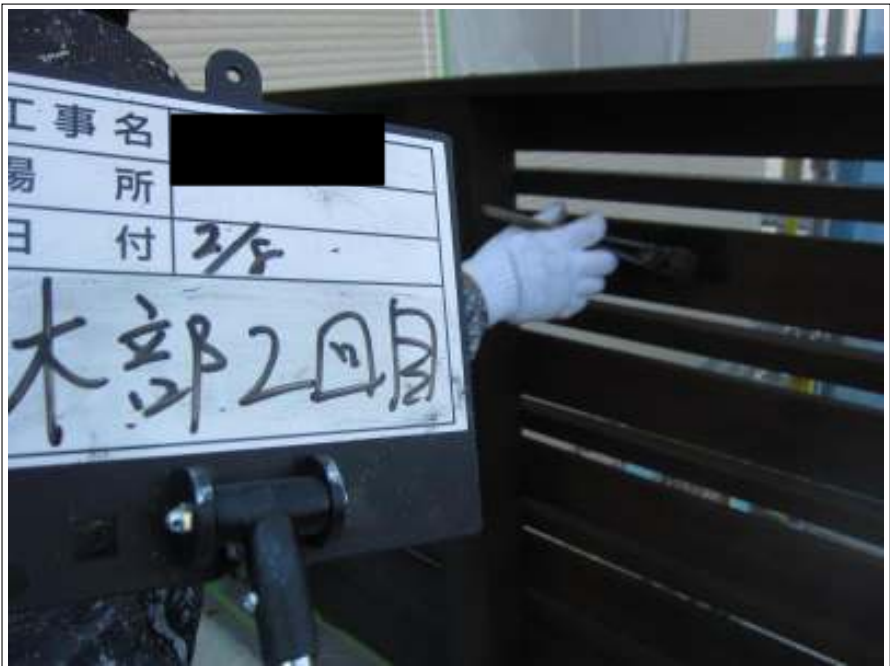
木部 上塗り（2回目）施工中
