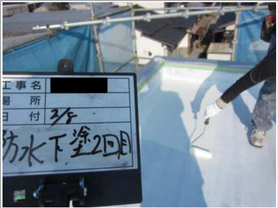
屋根 下塗り施工中（2回目）
