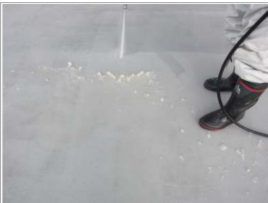
屋根 高圧洗浄中
