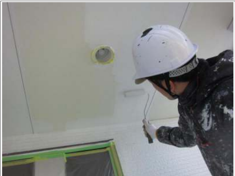
軒天 上塗り（1回目）施工中
