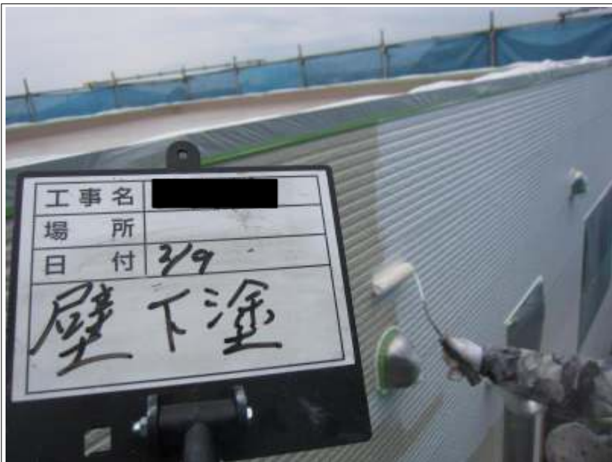
外壁 下塗り施工中
