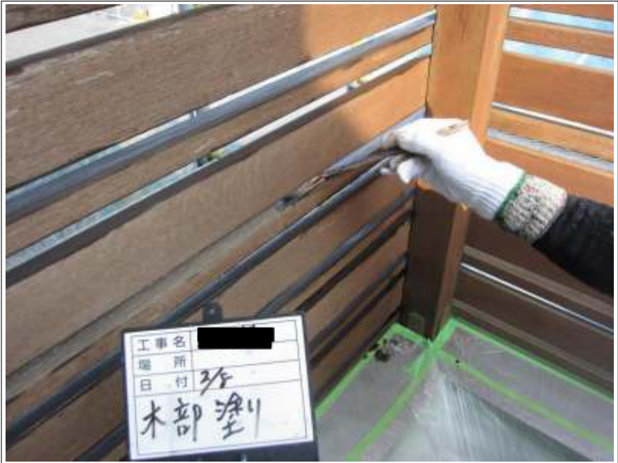
木部 上塗り（1回目）施工中
