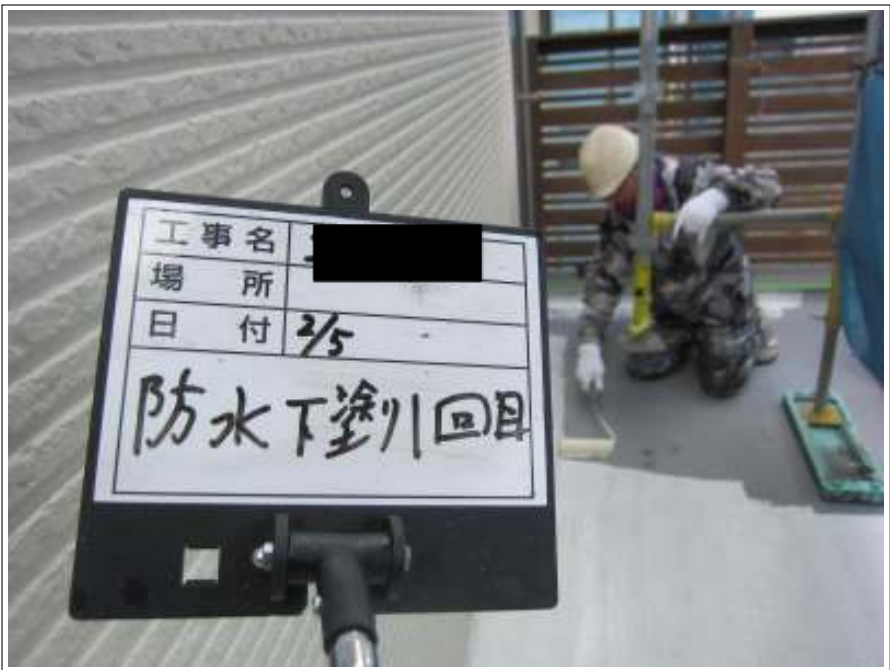
ベランダ 下塗り施工中
