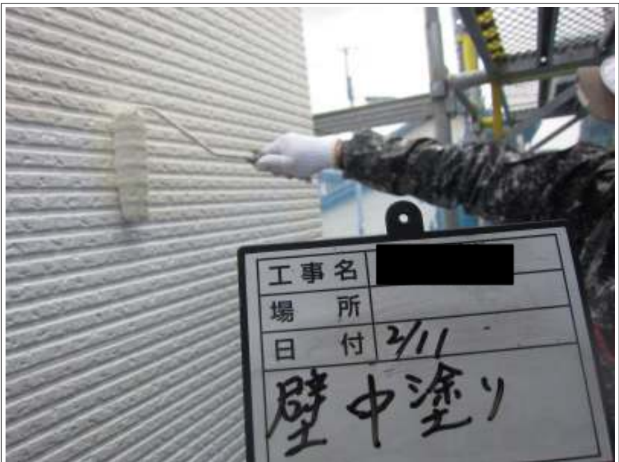
外壁 中塗り施工中
