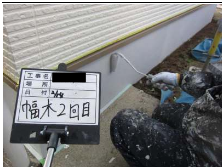
基礎 上塗り（2回目）施工中
