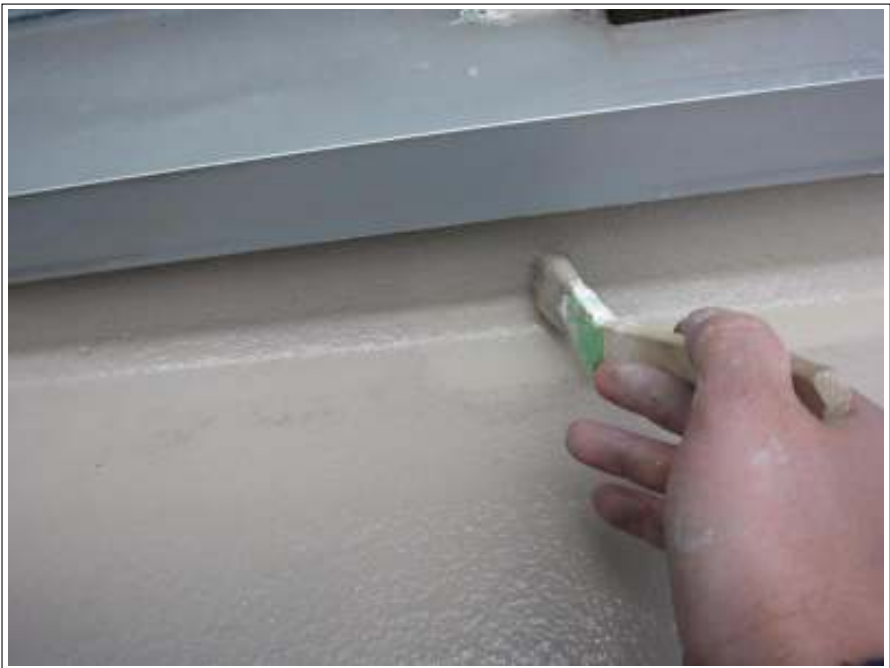
ベランダ 下塗り施工中
