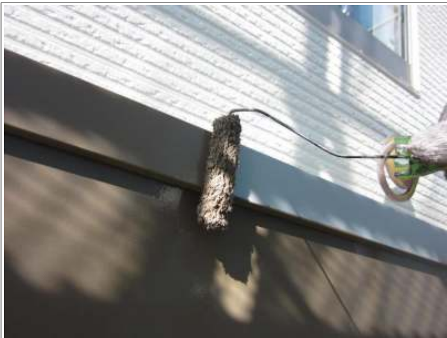
シャッターBOX 上塗り施工中
