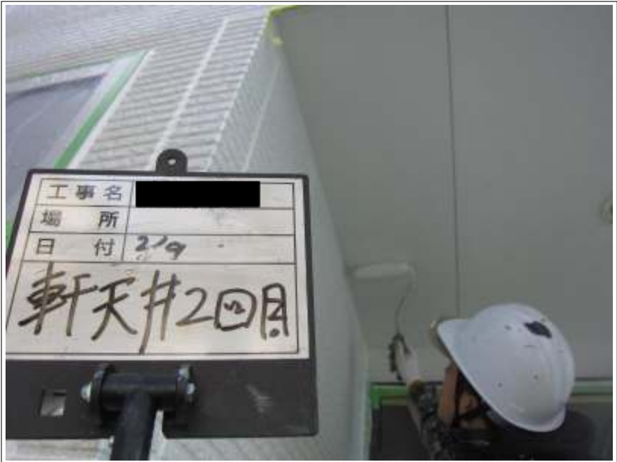
軒天 上塗り（2回目）施工中
