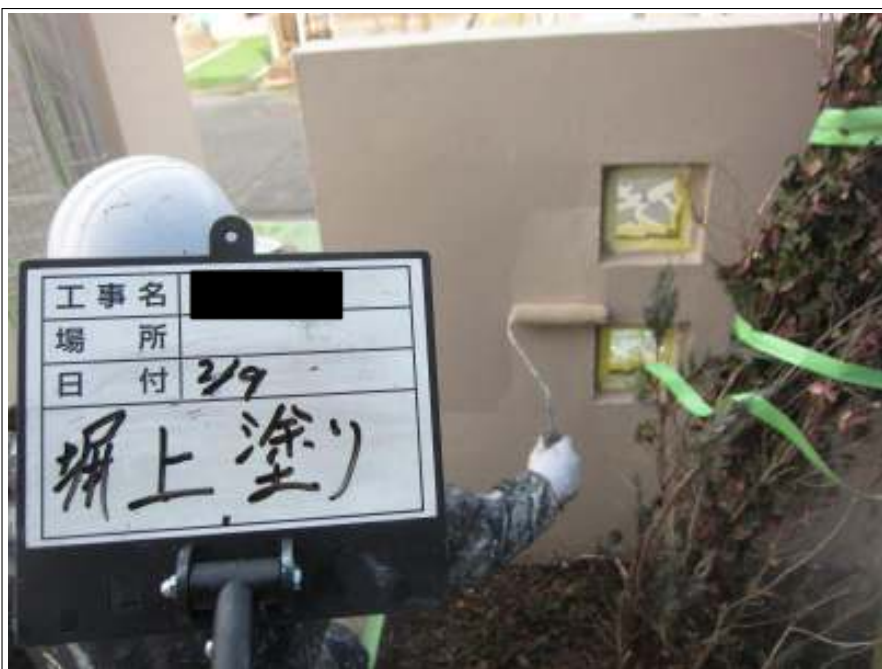
塙 上塗り施工中
