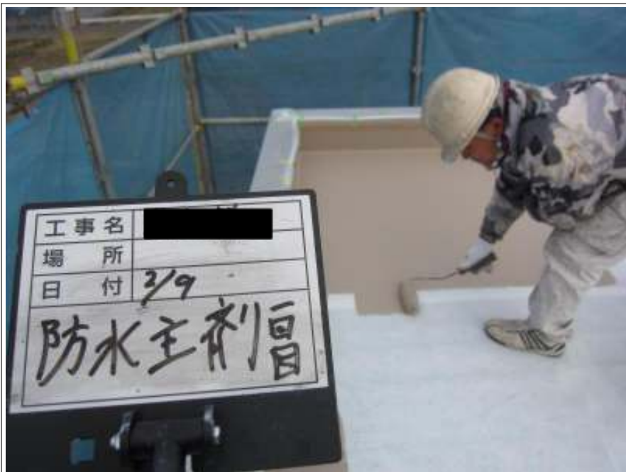
屋根 中塗り施工中 (1回目)
