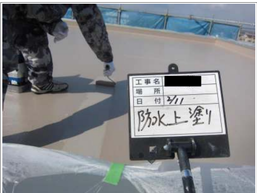
屋根 上塗り施工中
