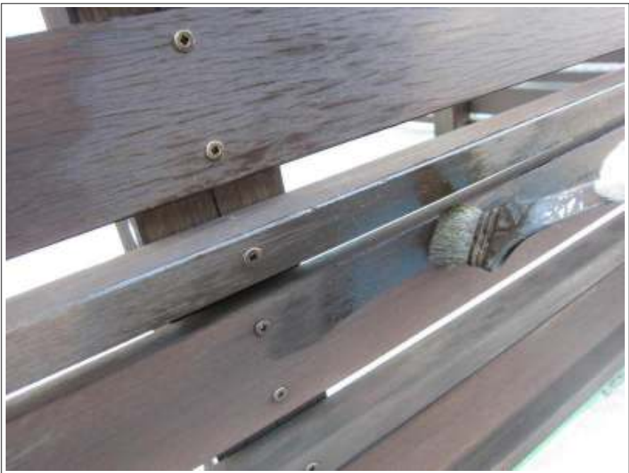
木部 上塗り（2回目）施工中
