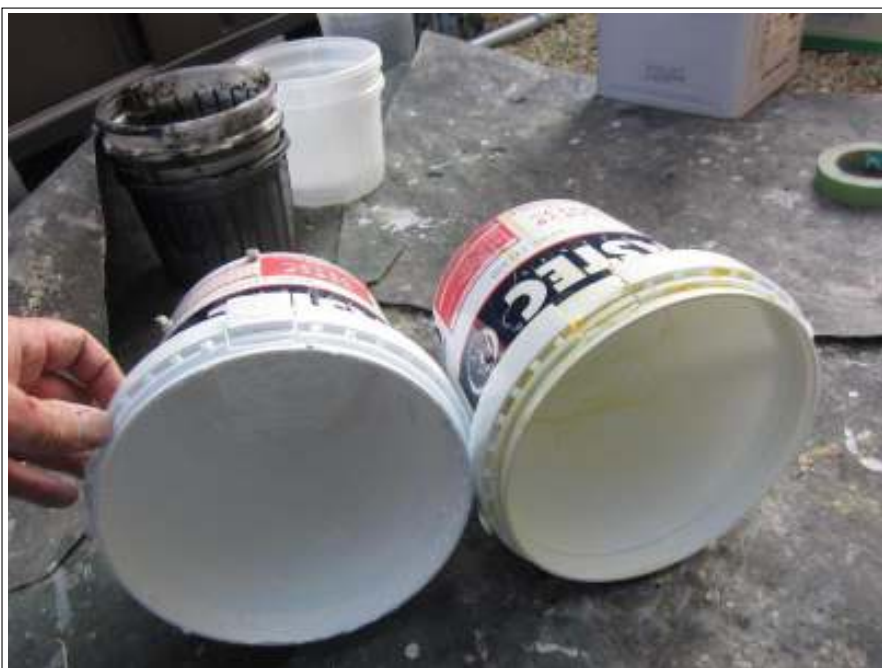
屋根 下塗り使用材料空缶
