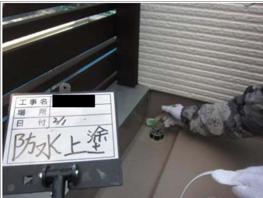
ベランダ 上塗り（1回目）施工中
