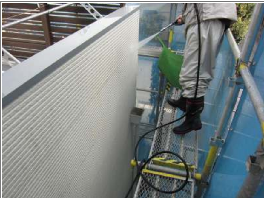
外壁 高圧洗浄中
