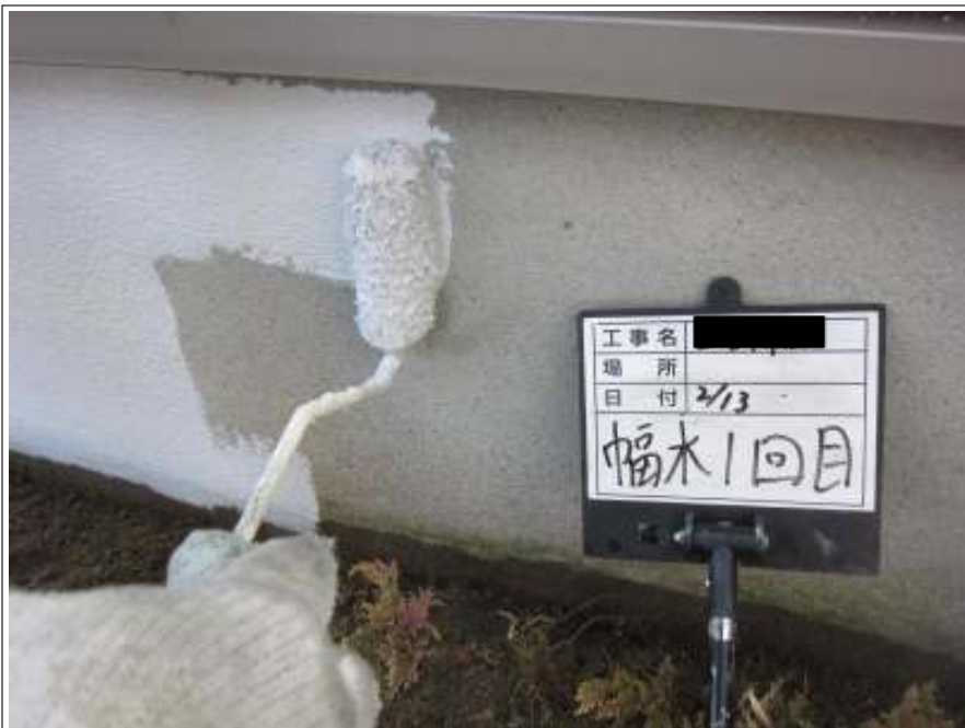
基礎 上塗り（1回目）施工中
