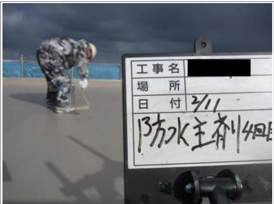
屋根 中塗り施工中 (4回目)
