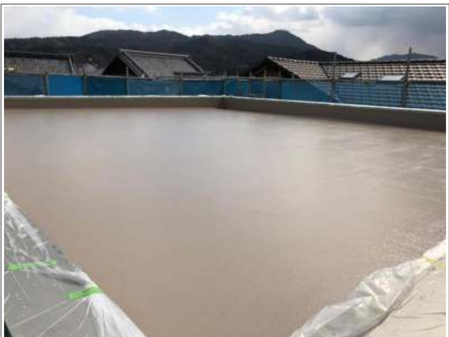
屋根 施工完了
