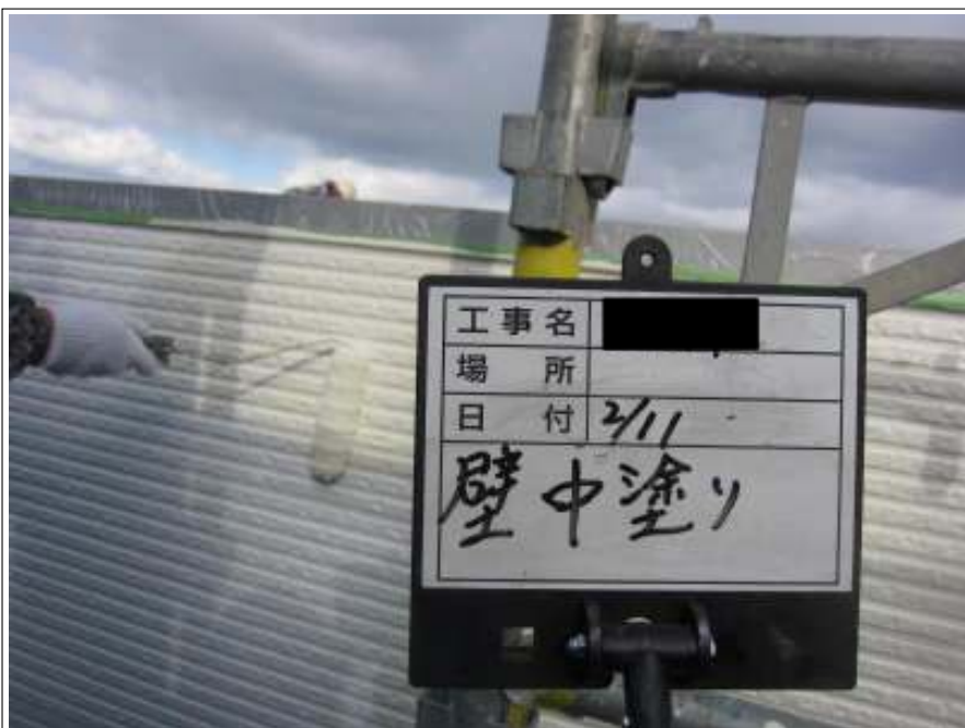
外壁 中塗り施工中
