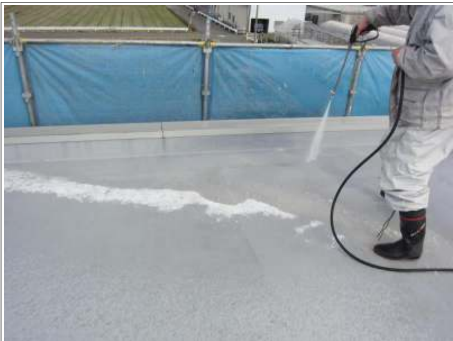
屋根 高圧洗浄中
