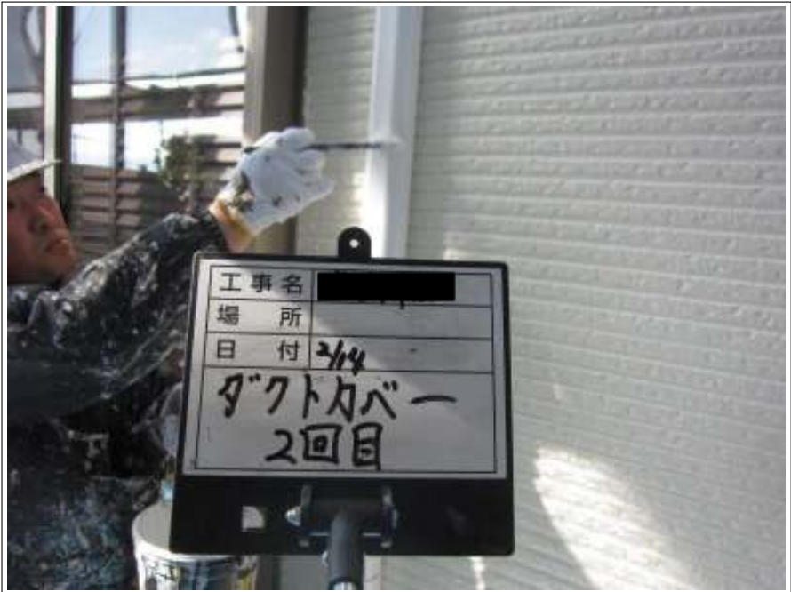
ダクトカバー上塗り (2回目) 施工中
