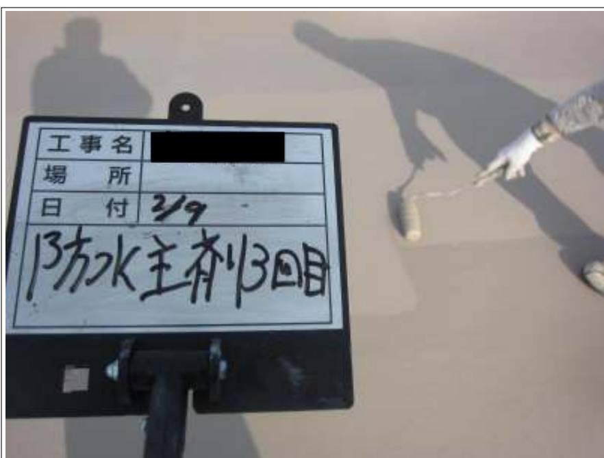
屋根 中塗り施工中 (3回目)
