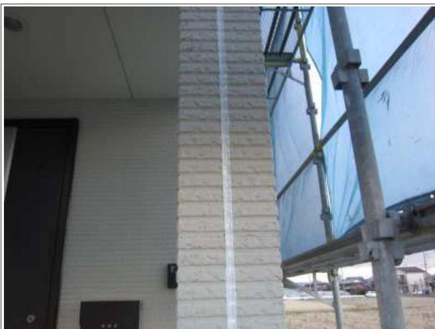
コーキング打ち替え 施工後
