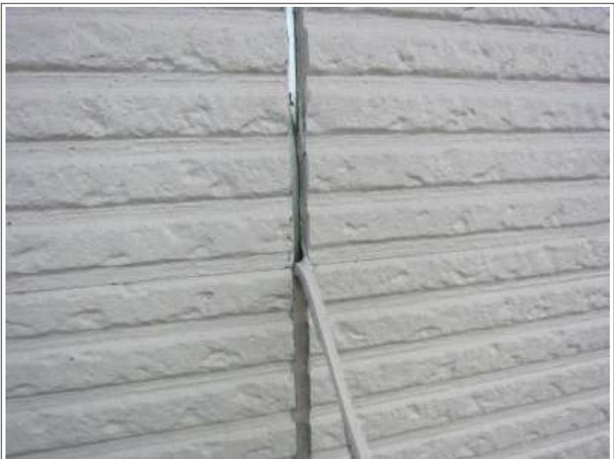
既存シーリング撤去
