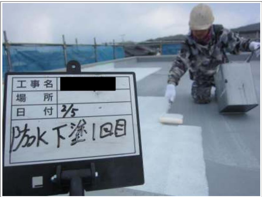
屋根 下塗り施工中（1回目）
