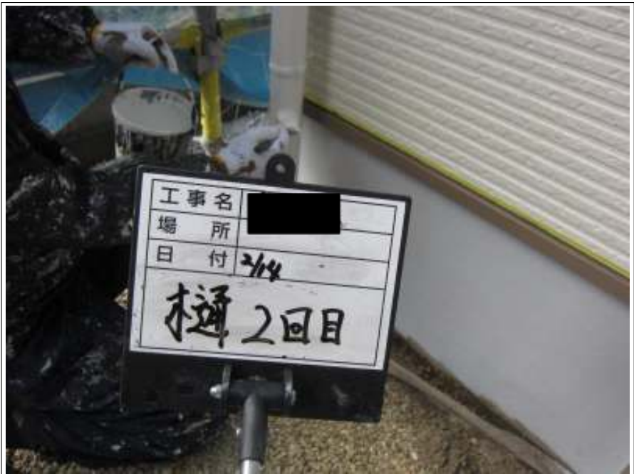
樋 上塗り (2回目) 施工中
