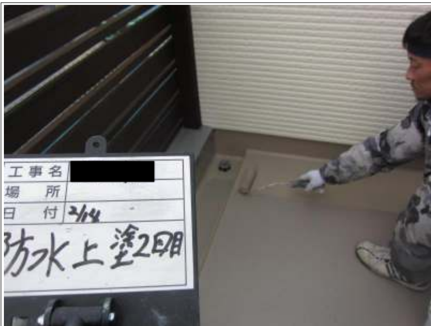
ベランダ 上塗り（2回目）施工中
