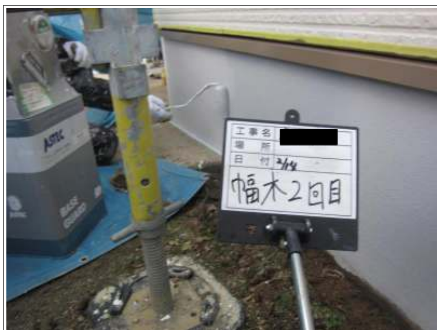
基礎 上塗り（2回目）施工中
