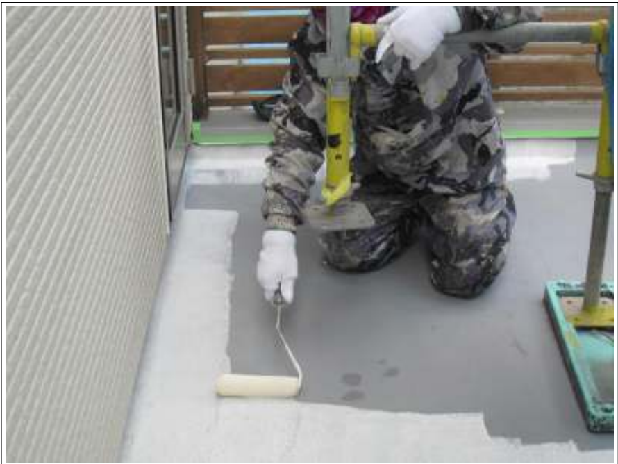
ベランダ 下塗り施工中
