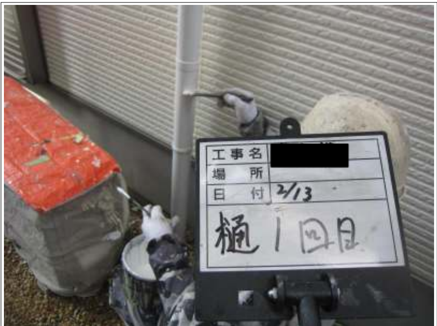
樋 上塗り (1回目) 施工中
