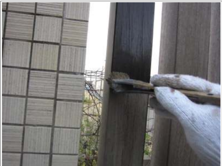
塀 木部 上塗り施工中
