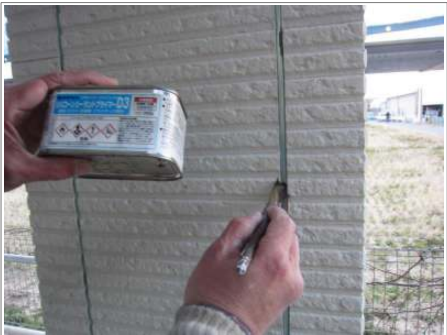
プライマー塗布
