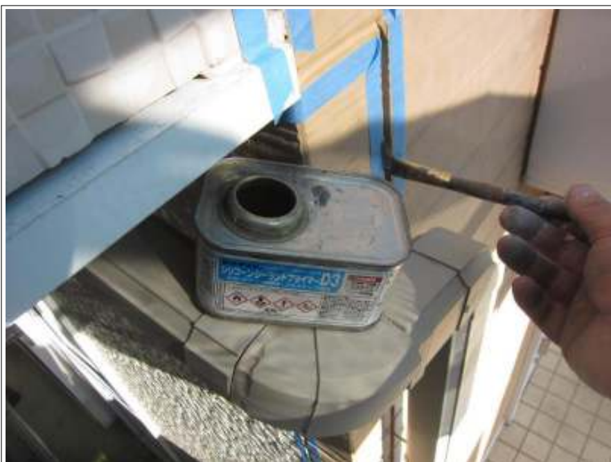
プライマー塗布
