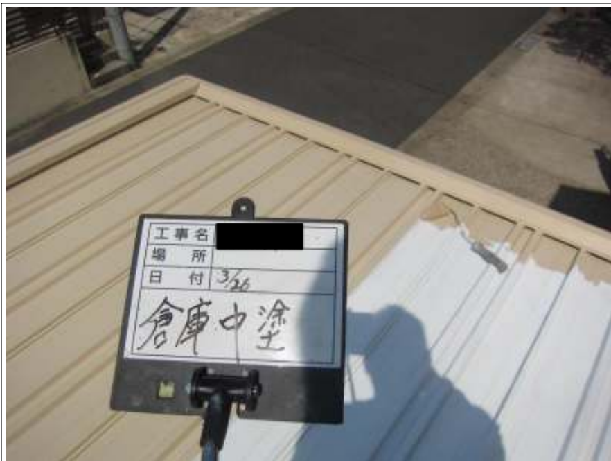
倉庫屋根 中塗り施工中
