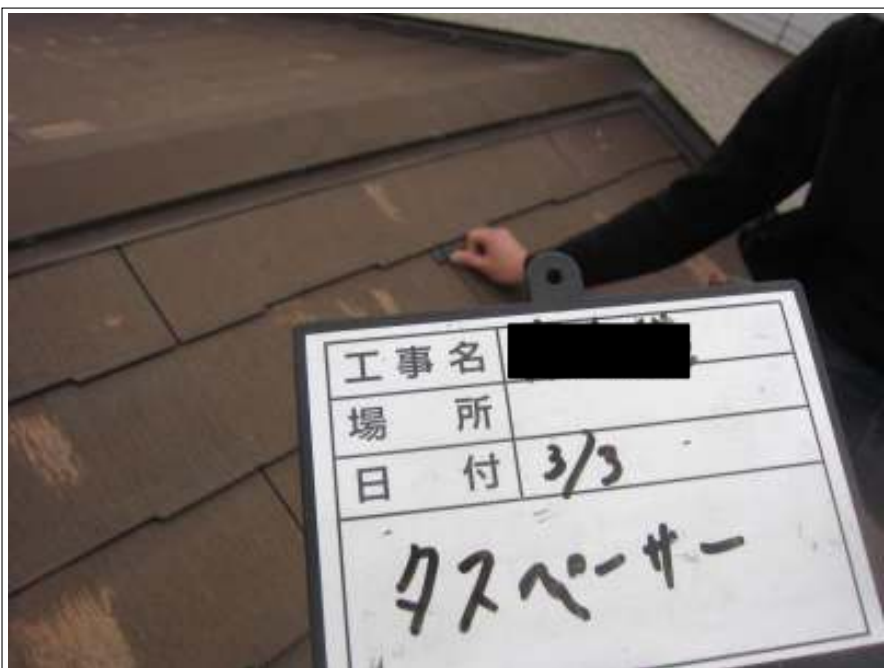
タスペーサー取付
