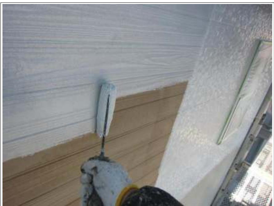
外壁 下塗り施工中
