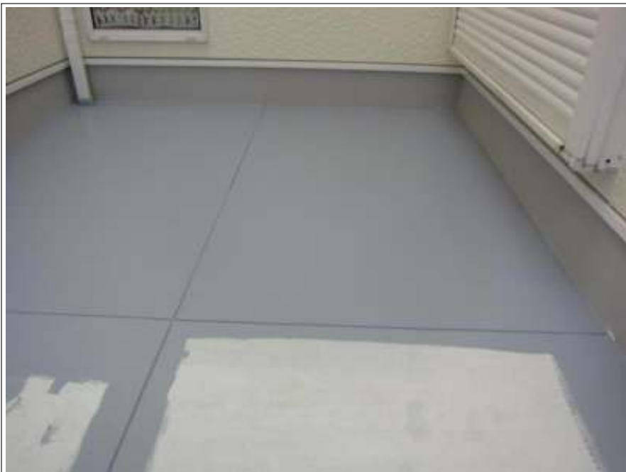
ベランダ床 中塗り施工後
