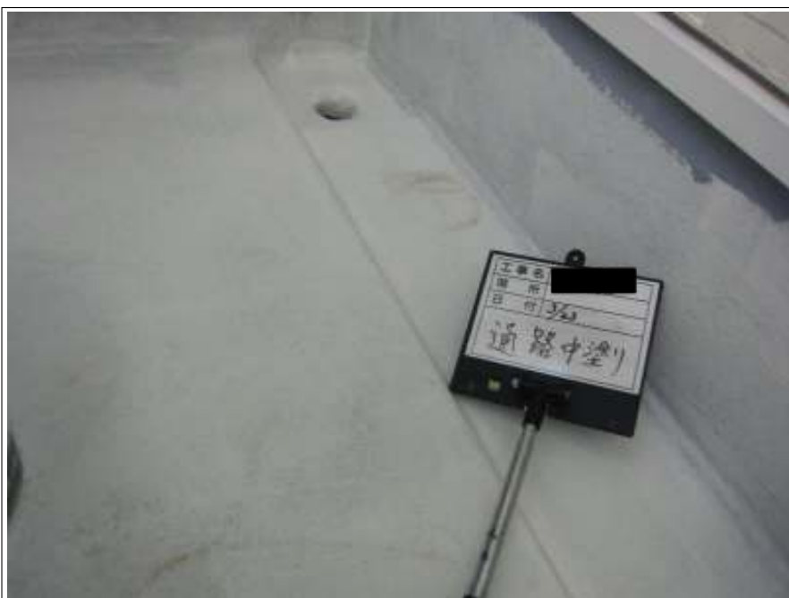
通路 中塗り施工中
