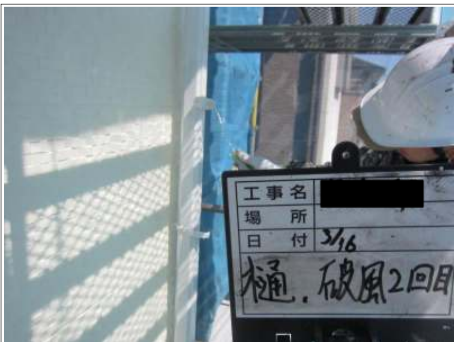
雨樋 上塗り（2回目）施工中
