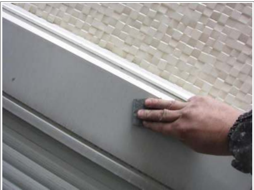
シャッターBOX ケレン処理
