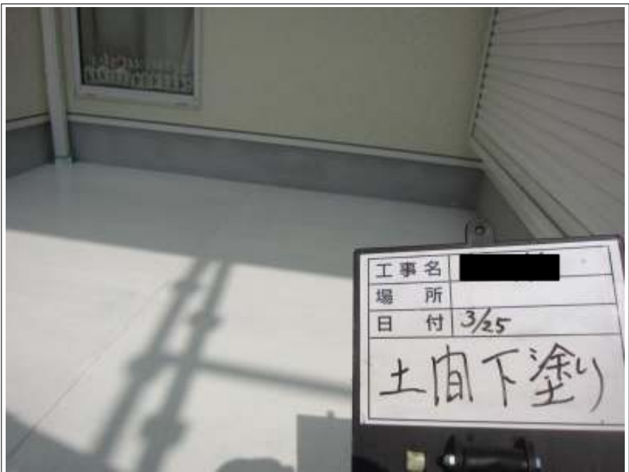
ベランダ床 下塗り施工後
