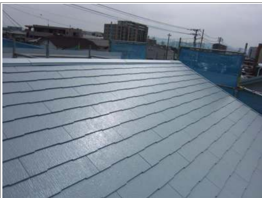
屋根 下塗り施工後
