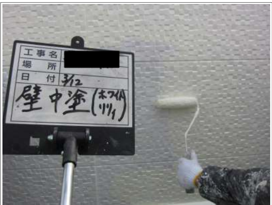
外壁 中塗り施工中
