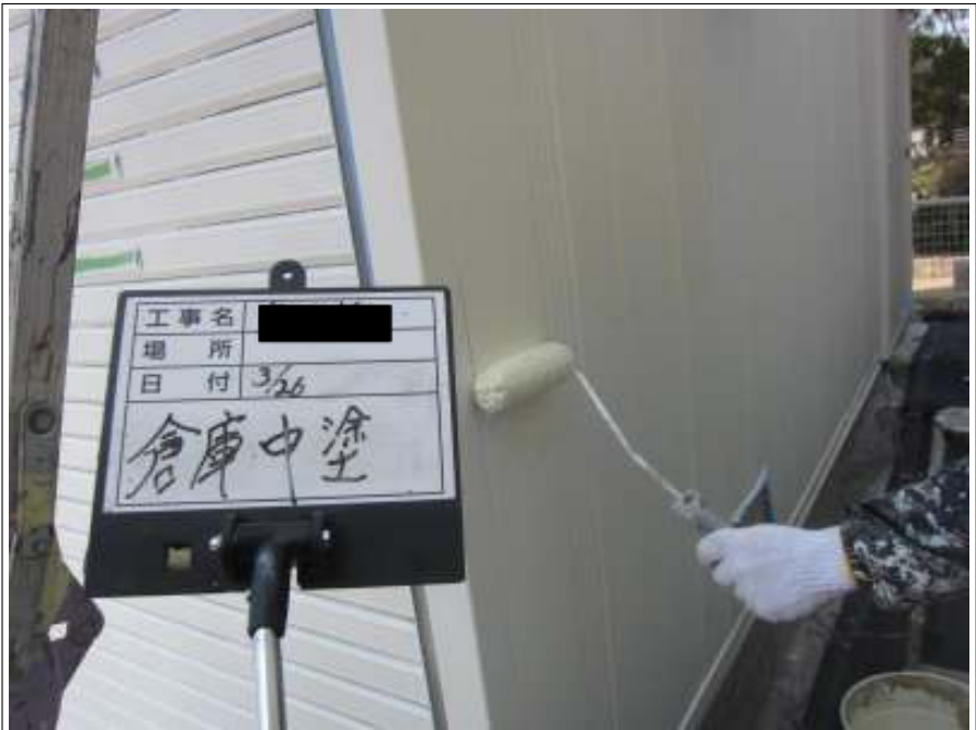
倉庫外壁 中塗り施工中
