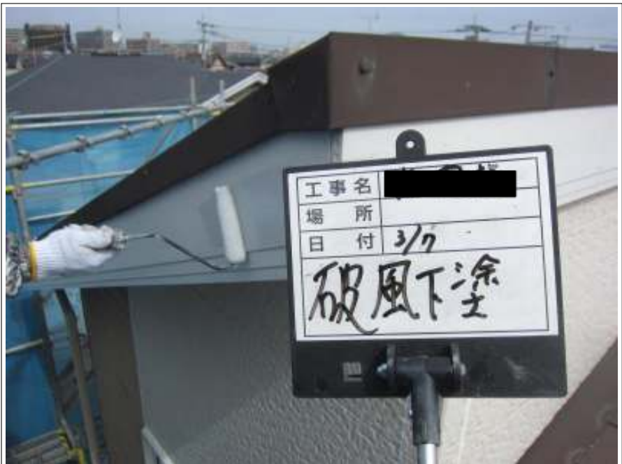
破風板 下塗り施工中
