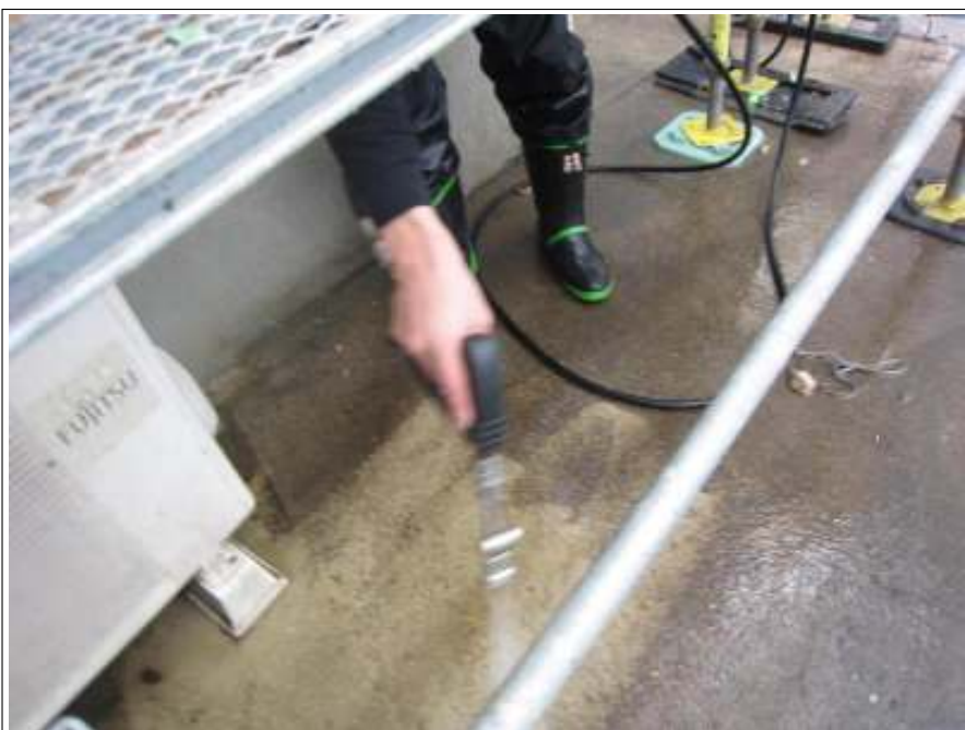
土間コンクリート 高压洗浄中
