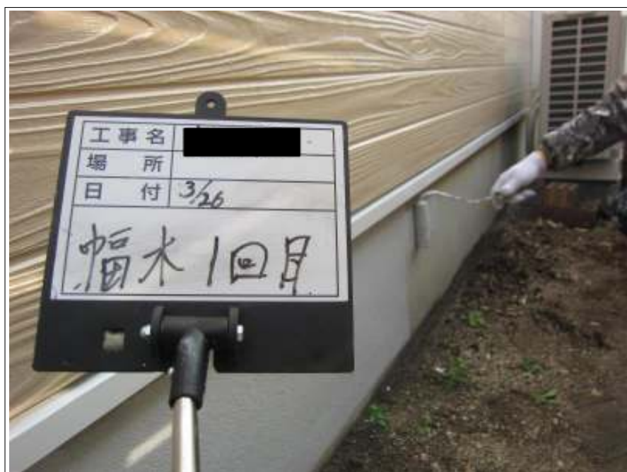
基礎 上塗り（1回目）施工中
