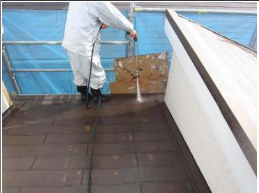
屋根 高圧洗浄中
