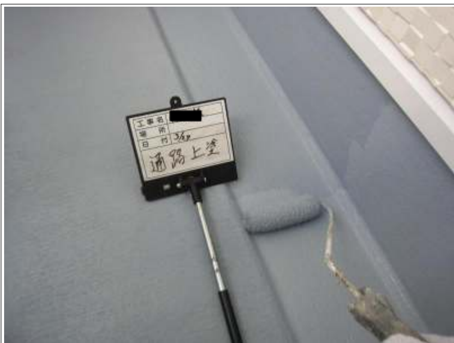
通路 上塗り施工中
