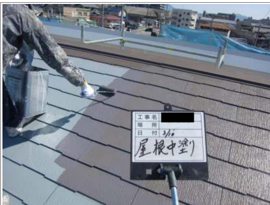
屋根 中塗り施工中
