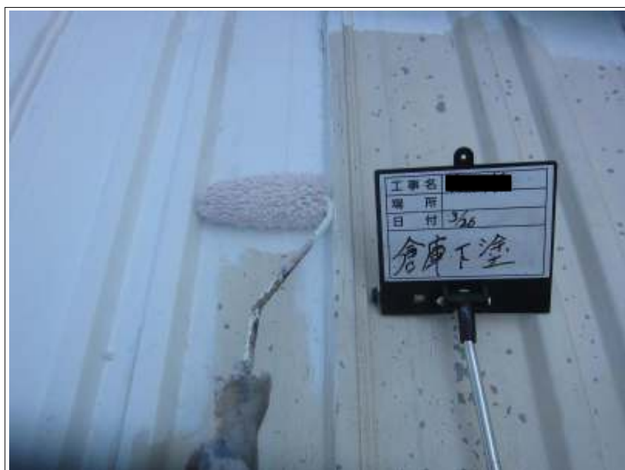
倉庫屋根 下塗り施工中
