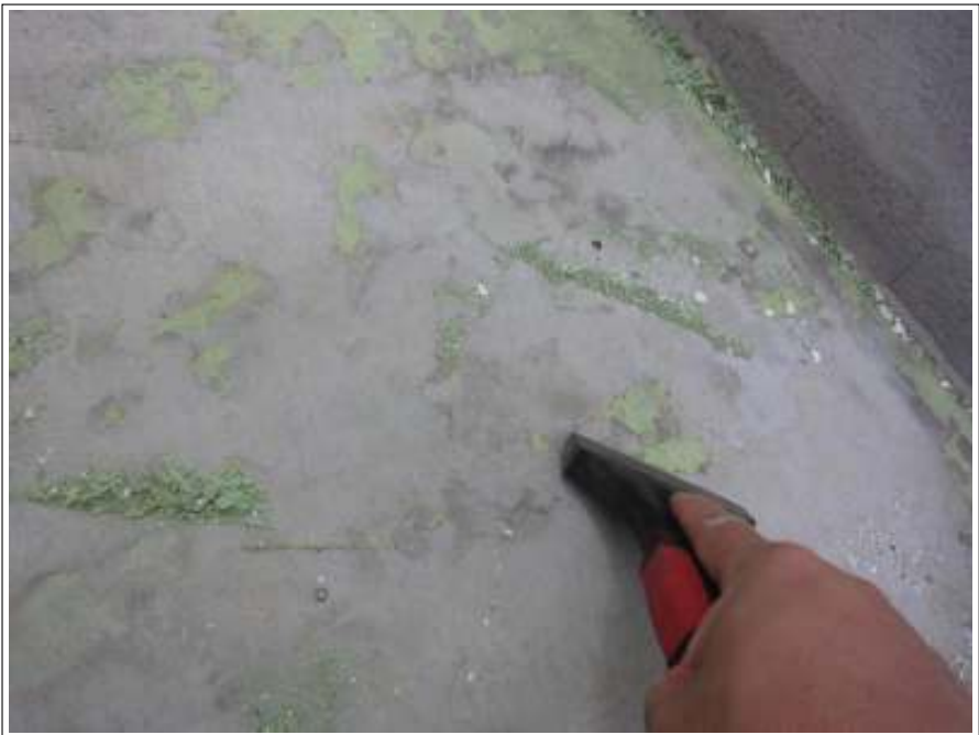
ベランダ床 ケレン処理
