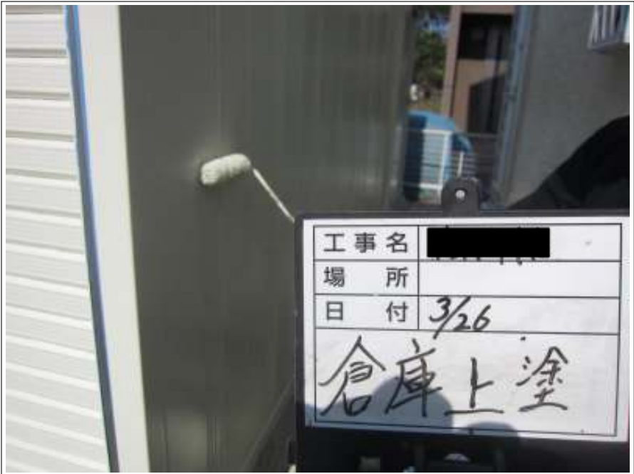
倉庫外壁 上塗り施工中
