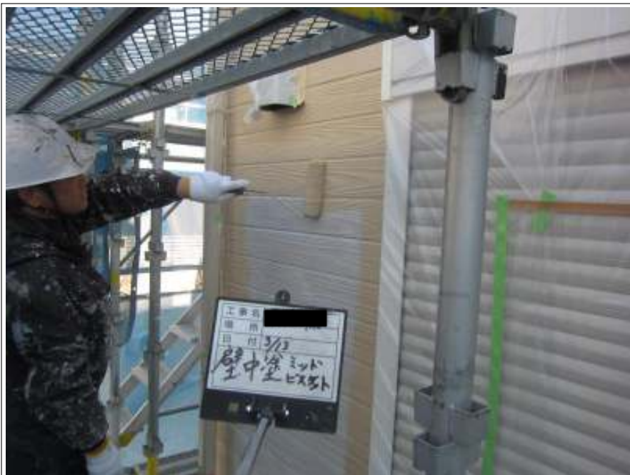
外壁 中塗り施工中
