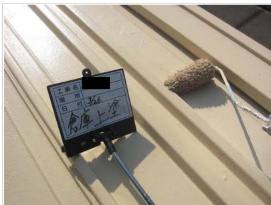
倉庫屋根 上塗り施工中
