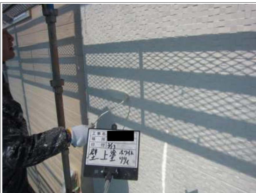
外壁 上塗り施工中
