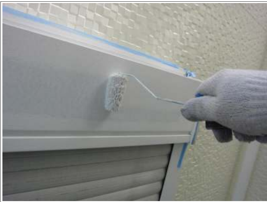
シャッターBOX 上塗り施工中
