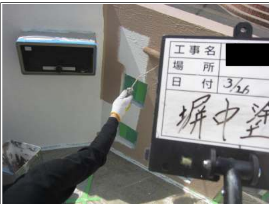
塀 中塗り施工中
