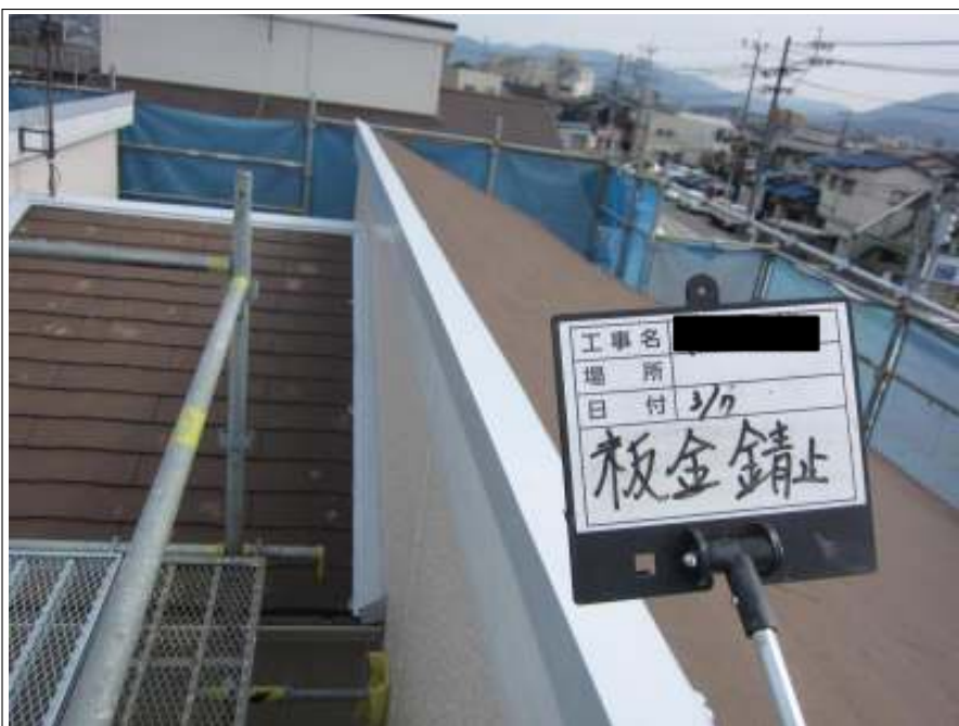
屋根板金部 サビ止め塗布後
