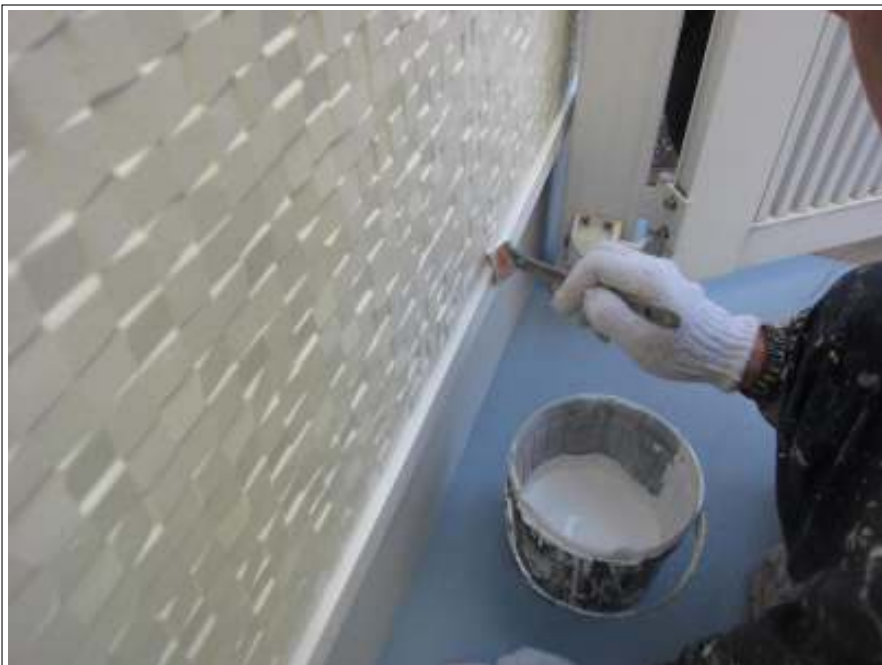
水切り 上塗り施工中
