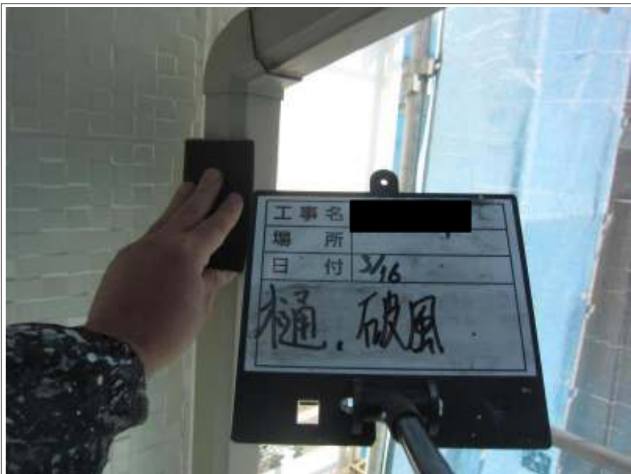
雨樋 ケレン処理
