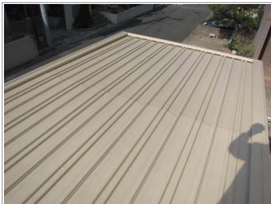
倉庫屋根 施工完了
