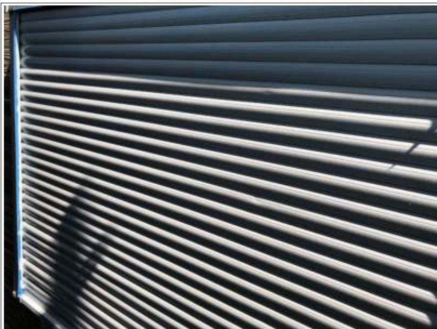
シャッター 上塗り施工後
