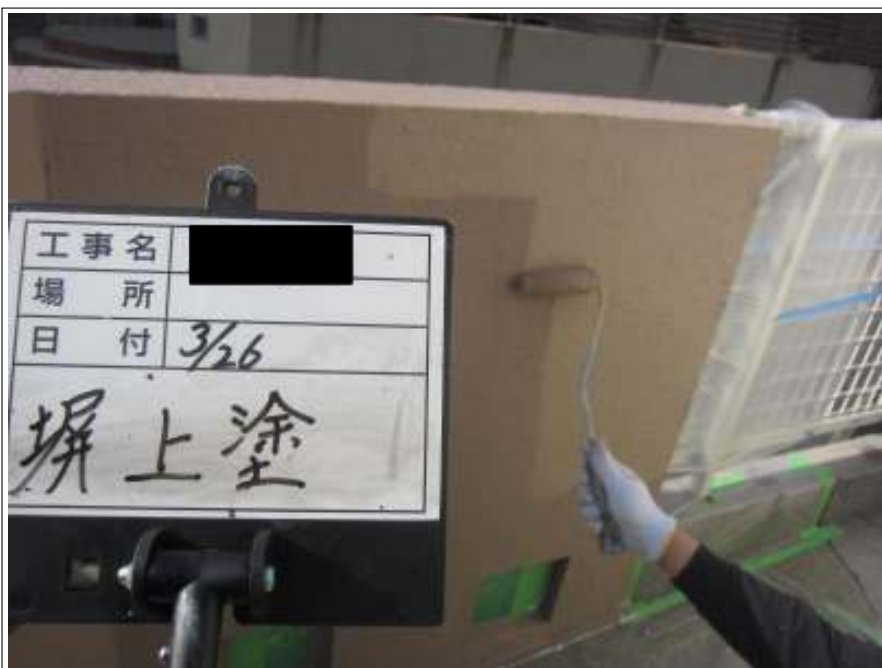
塀 上塗り施工中
