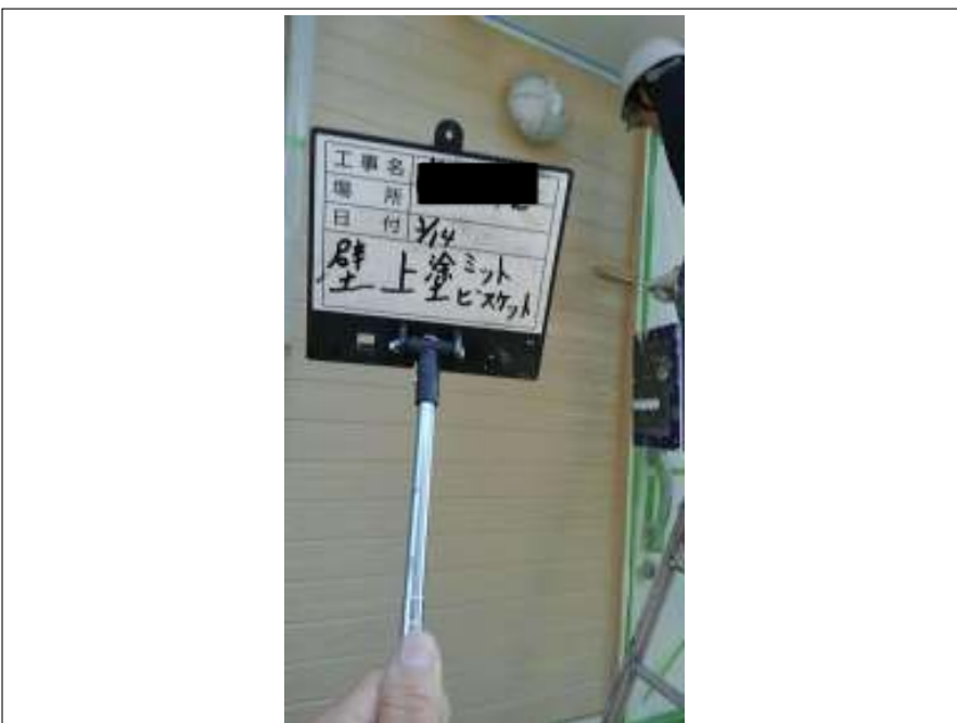
外壁 上塗り施工中
