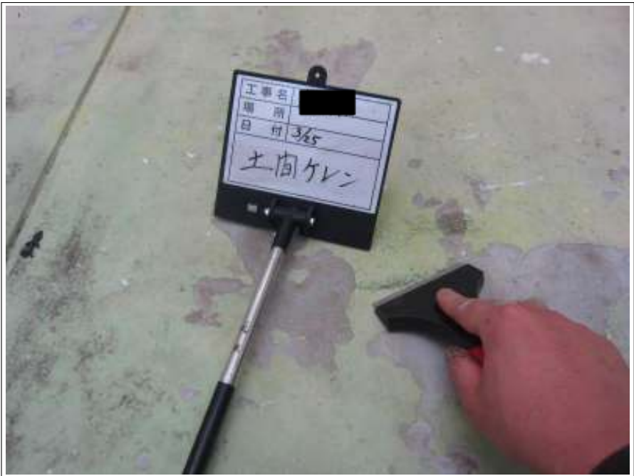
ベランダ床 ケレン処理
