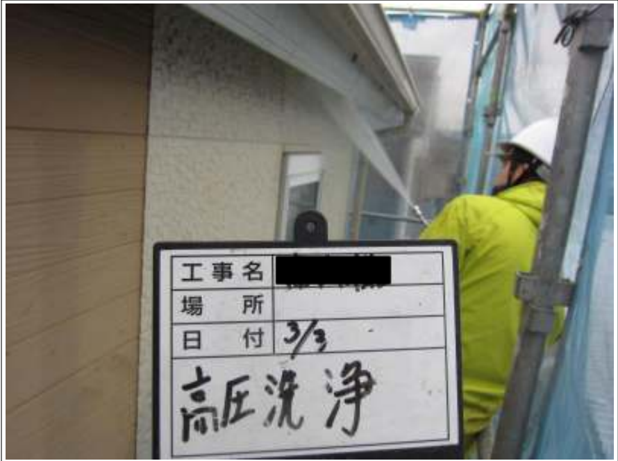
外壁 高圧洗浄中
