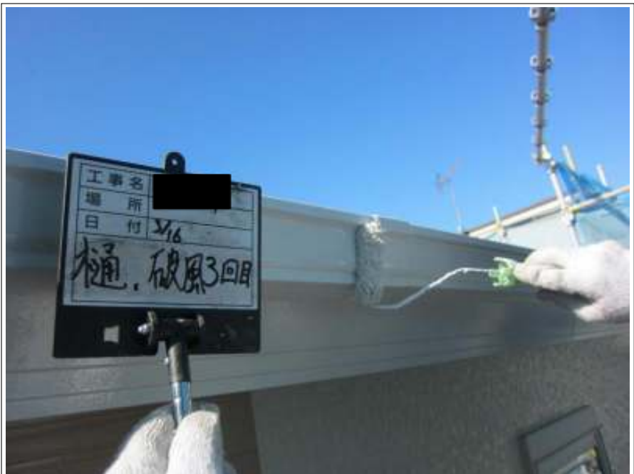
雨樋 上塗り（3回目）施工中
