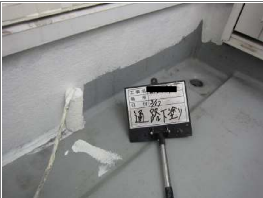
通路 下塗り施工中
