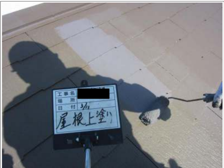
屋根 上塗り施工中
