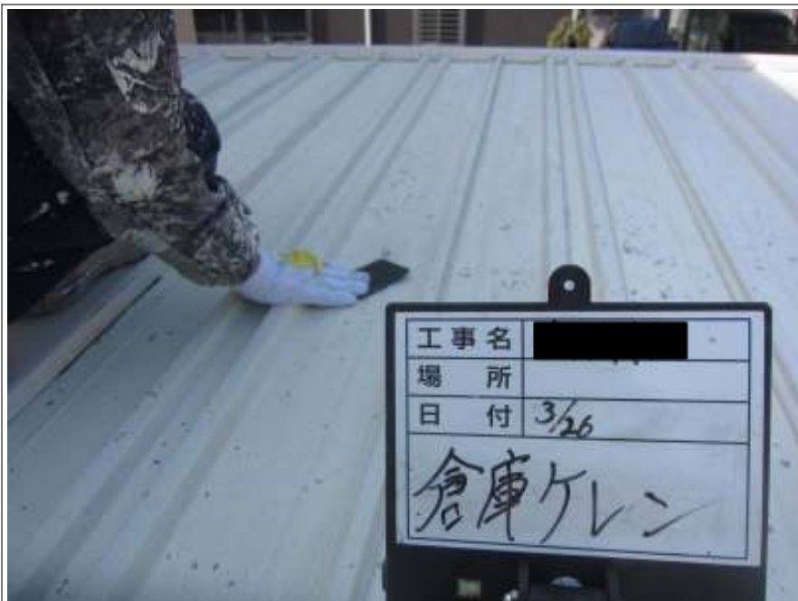
倉庫屋根 ケレン処理
