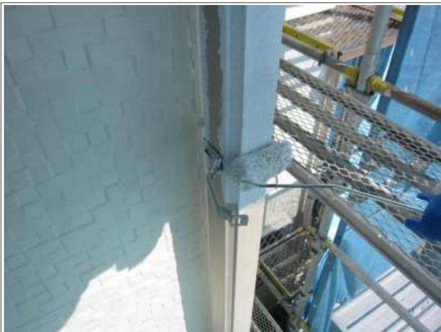
雨樋 上塗り（1回目）施工中
