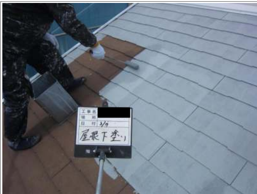
屋根 下塗り施工中
