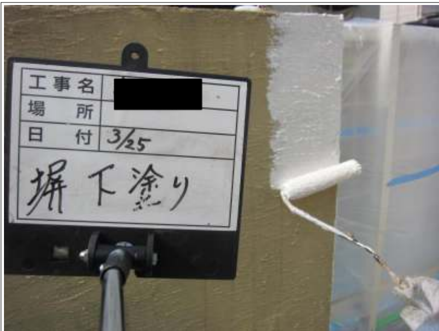
塀 下塗り施工中
