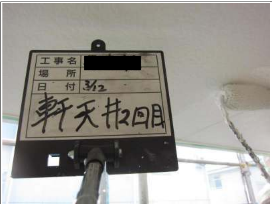
軒天 上塗り（2回目）施工中
