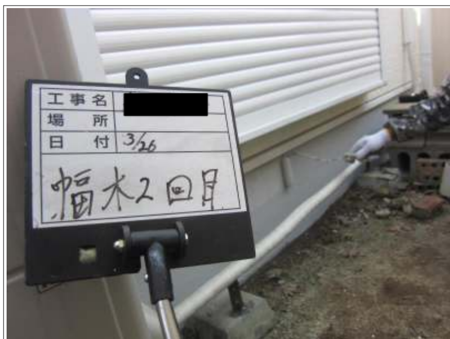
基礎 上塗り（2回目）施工中
