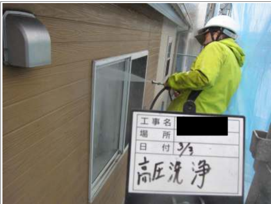
外壁 高压洗浄中
