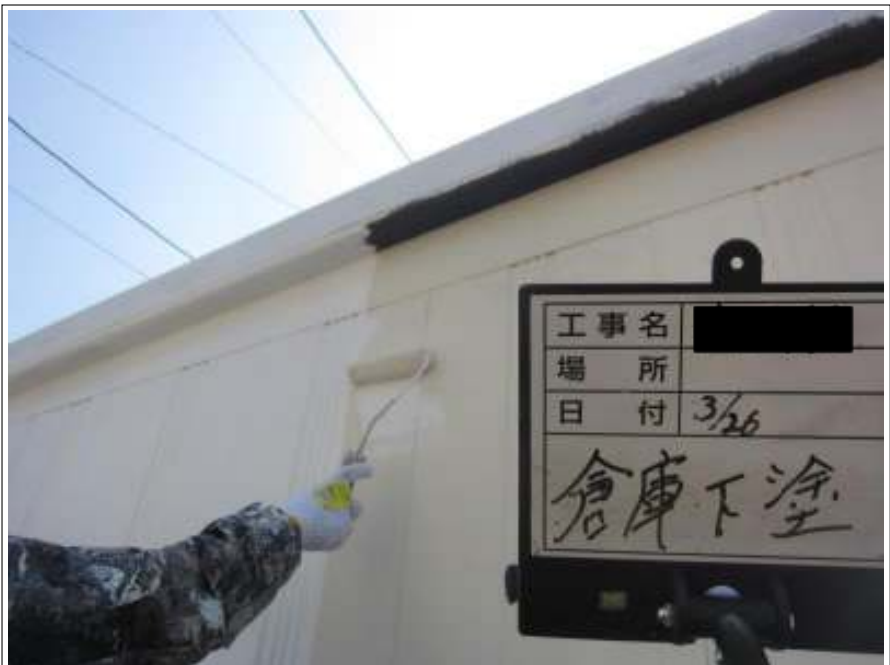
倉庫外壁 下塗り施工中
