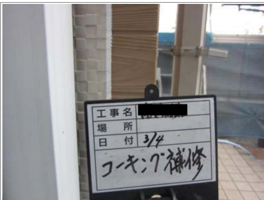
コーキング補修 施工後
