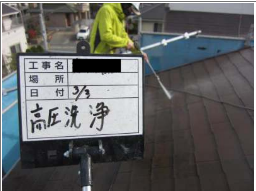
屋根 高圧洗浄中
