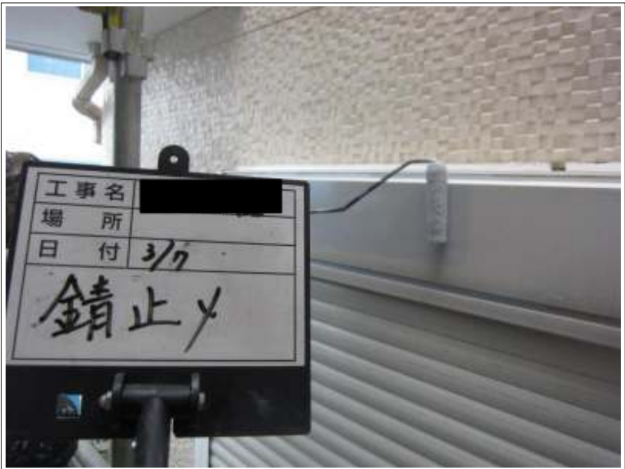
シャッターBOX サビ止め塗布
