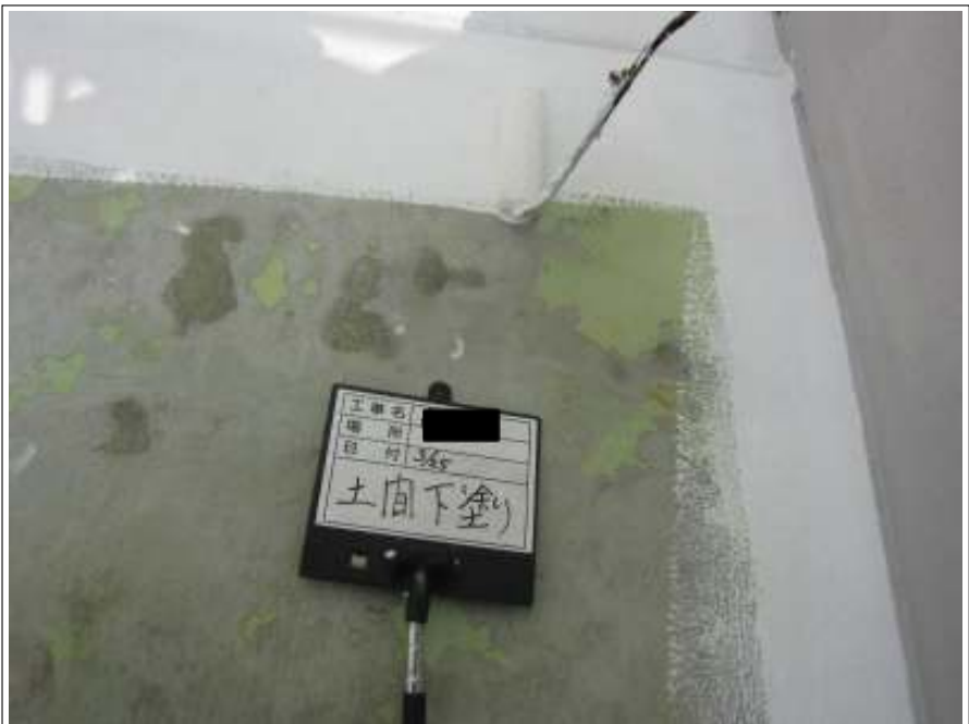
ベランダ床 下塗り施工中
