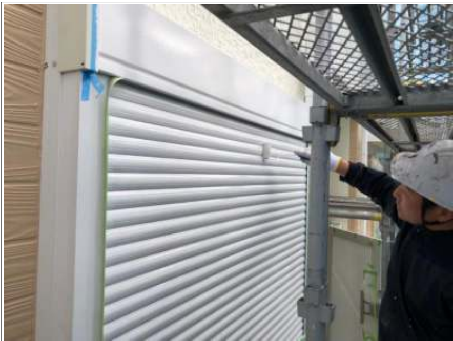
シャッター 上塗り施工中
