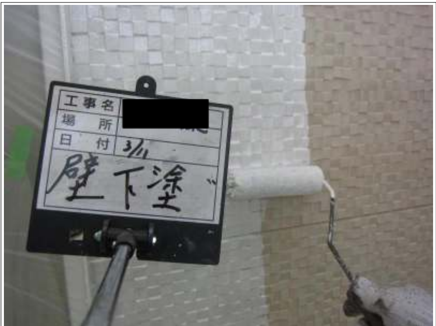
外壁 下塗り施工中
