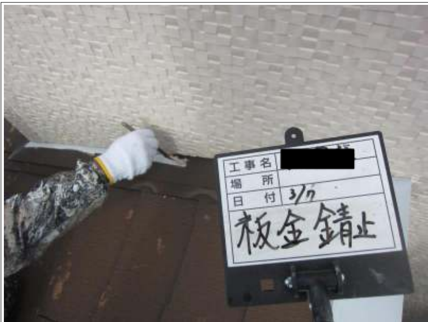
屋根板金部 サビ止め塗布
