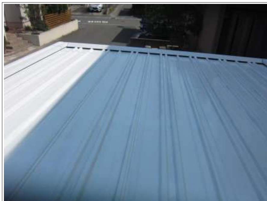
倉庫屋根 下塗り施工後
