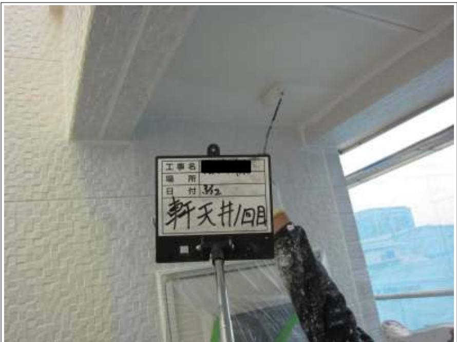
軒天 上塗り（1回目）施工中
