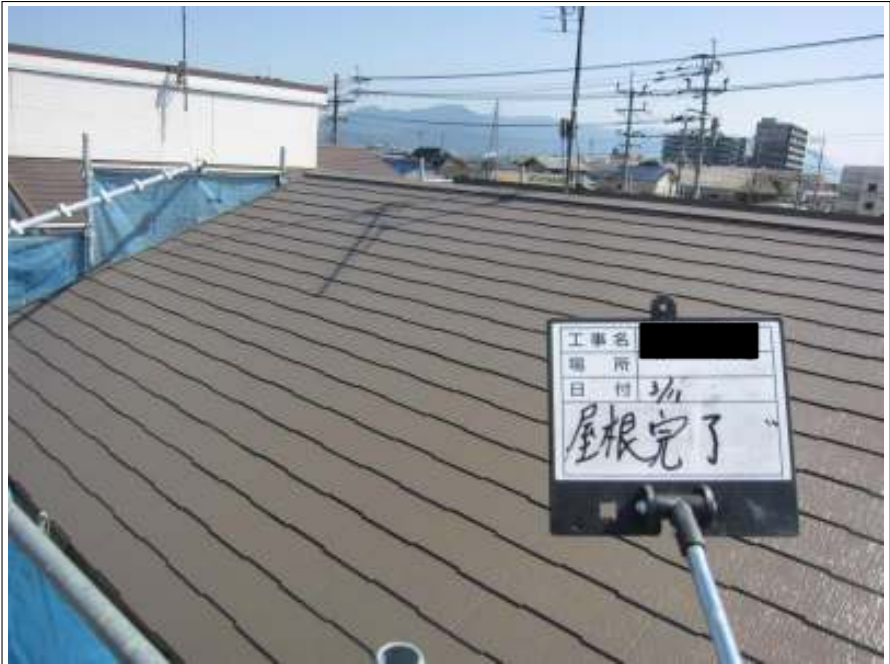
屋根 施工完了
