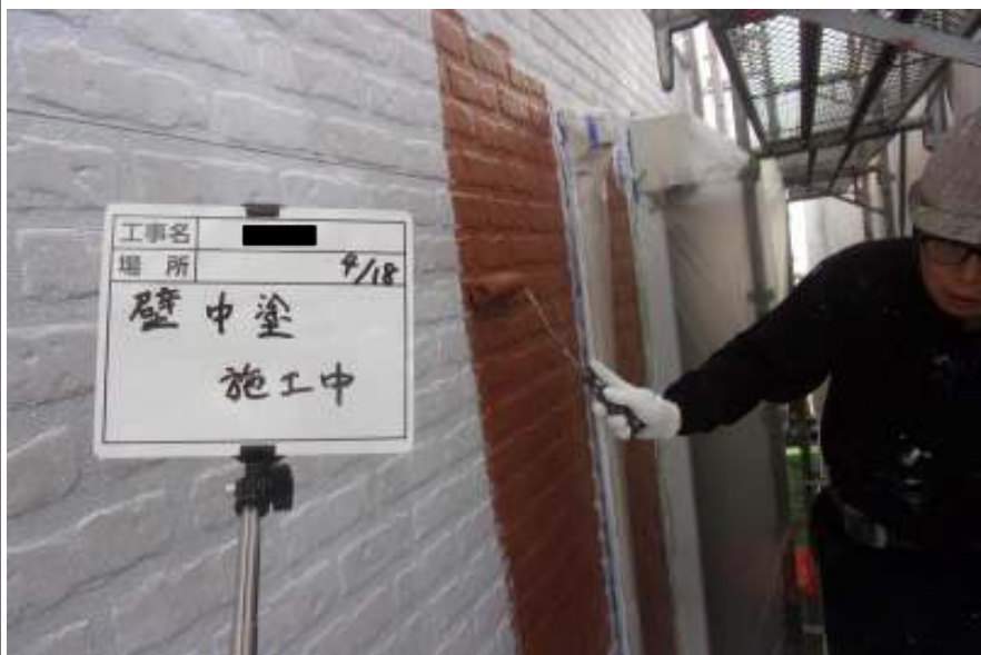
外壁（1F） 中塗り施工中
