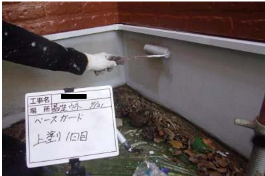
基礎 上塗り（1回目）施工中
