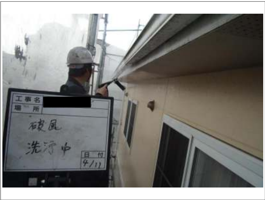
破風板 高圧洗浄中
