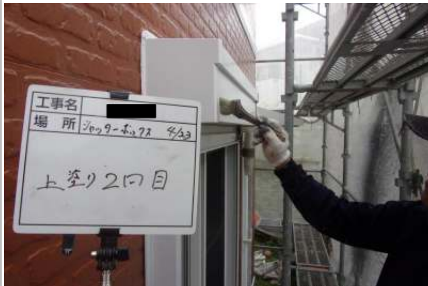
シャッターBOX 上塗り施工中
