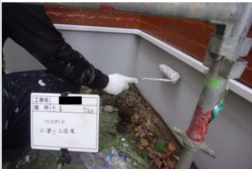
基礎 上塗り（2回目）施工中
