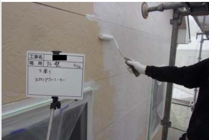
外壁 下塗り施工中
