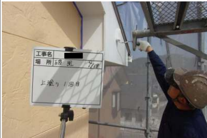
破風板 上塗り（1回目）施工中
