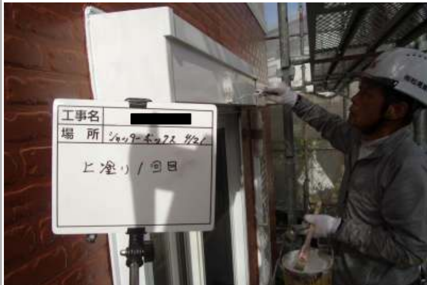
シャッターBOX 上塗り施工中
