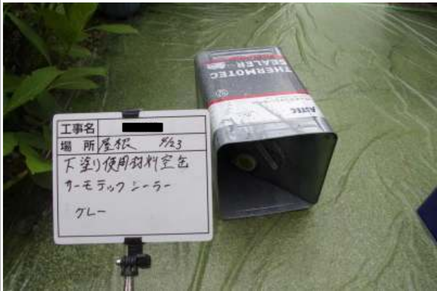
屋根 下塗り使用材料空缶
