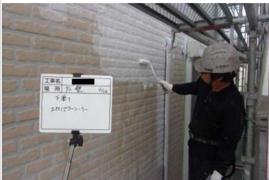
外壁 下塗り施工中
