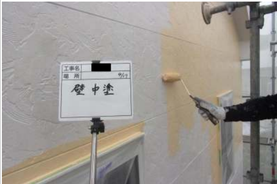
外壁（2F） 中塗り施工中
