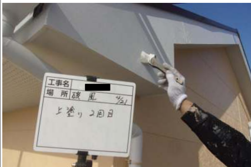
破風板 上塗り（2回目）施工中
