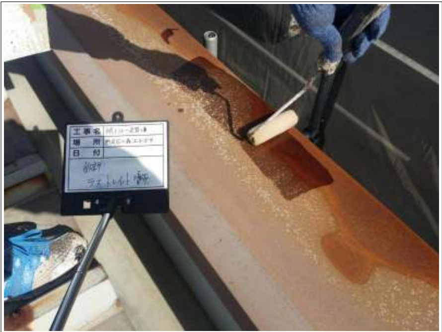
鉄部 下塗り施工中
