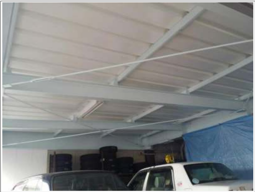
デッキプレート 施工完了
