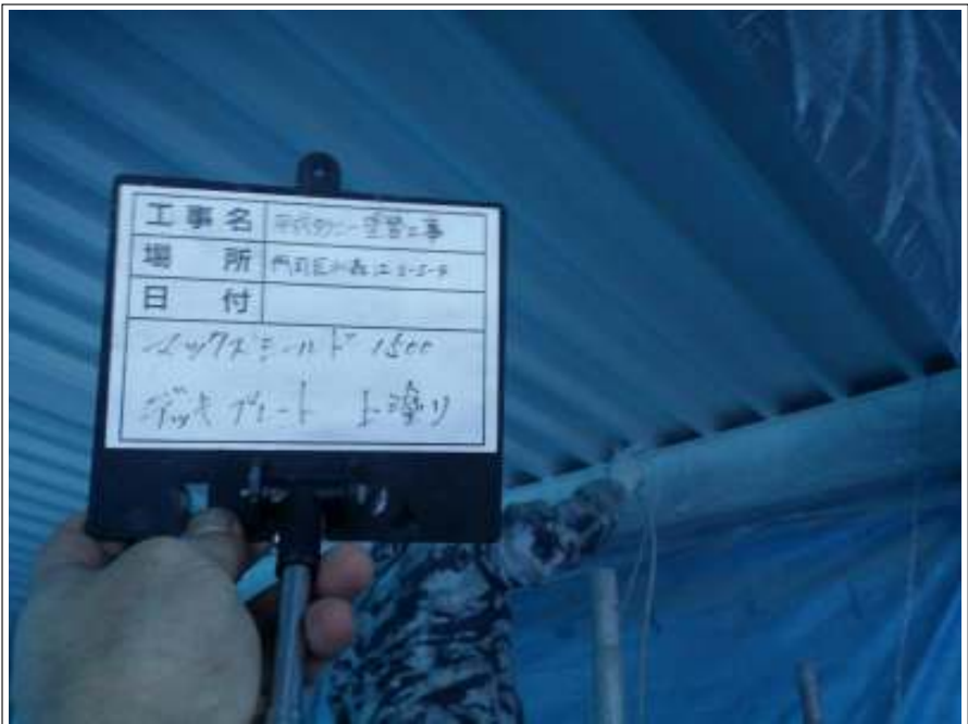
デッキプレート 上塗り施工中
