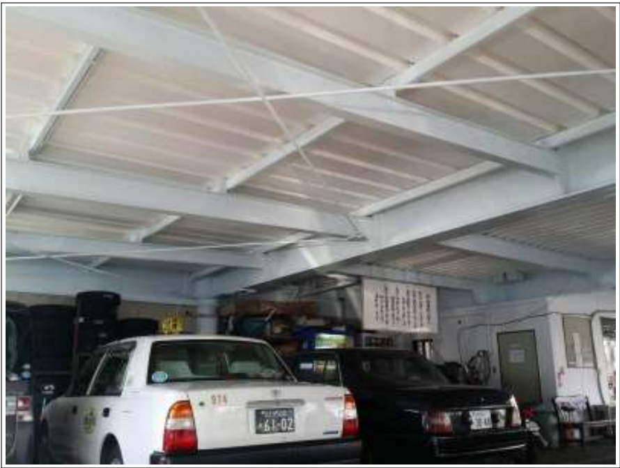
デッキプレート 施工完了
