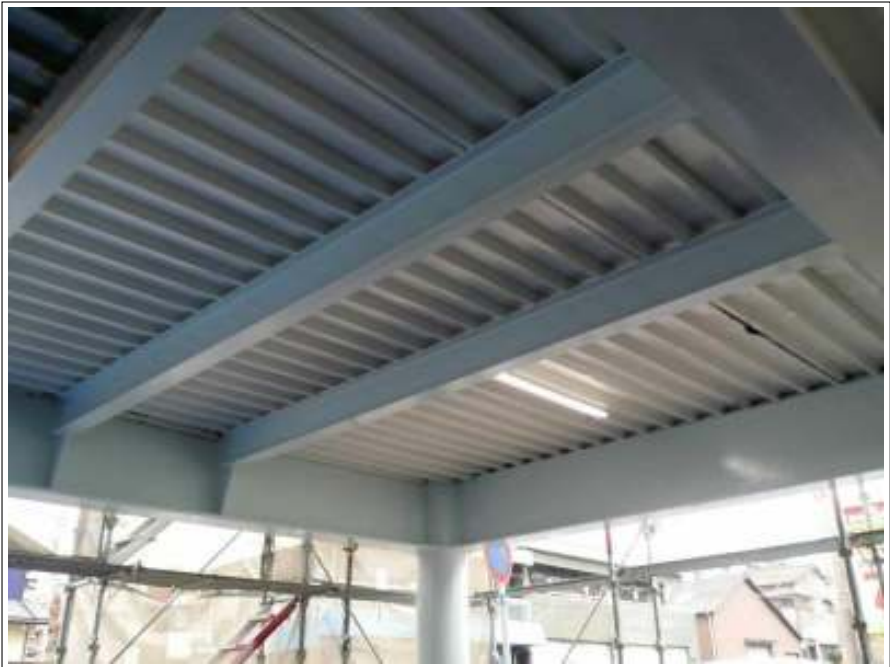
デッキプレート 施工完了
