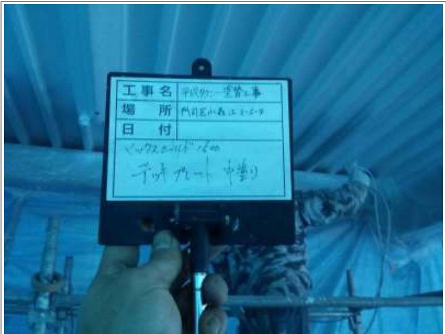
デッキプレート 中塗り施工中
