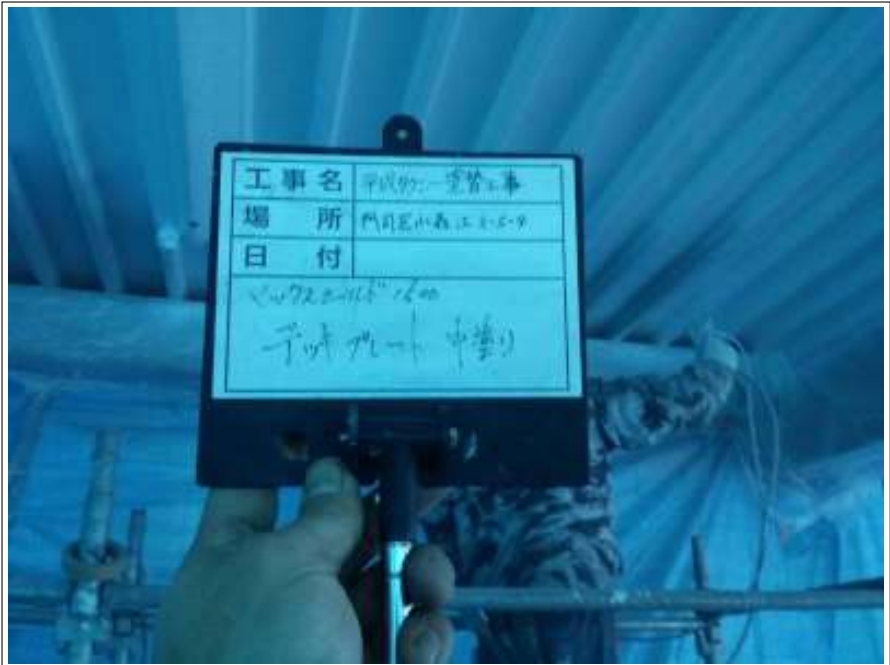
デッキプレート 中塗り施工中
