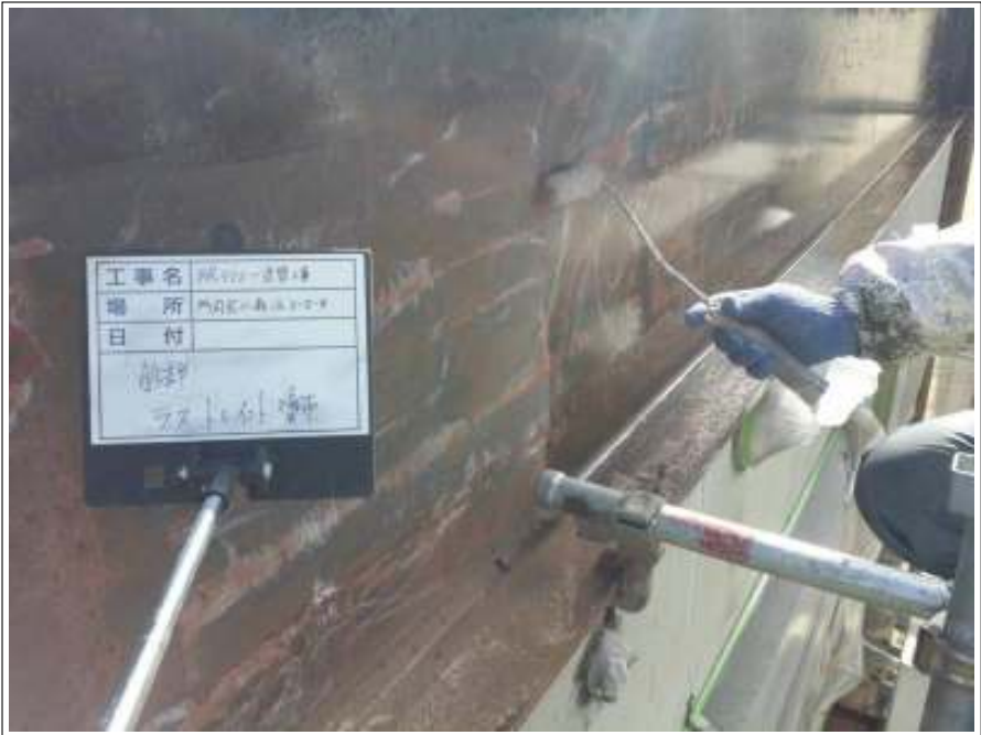
鉄部 下塗り施工中
