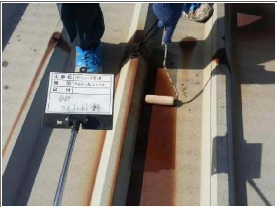
鉄部 下塗り施工中
