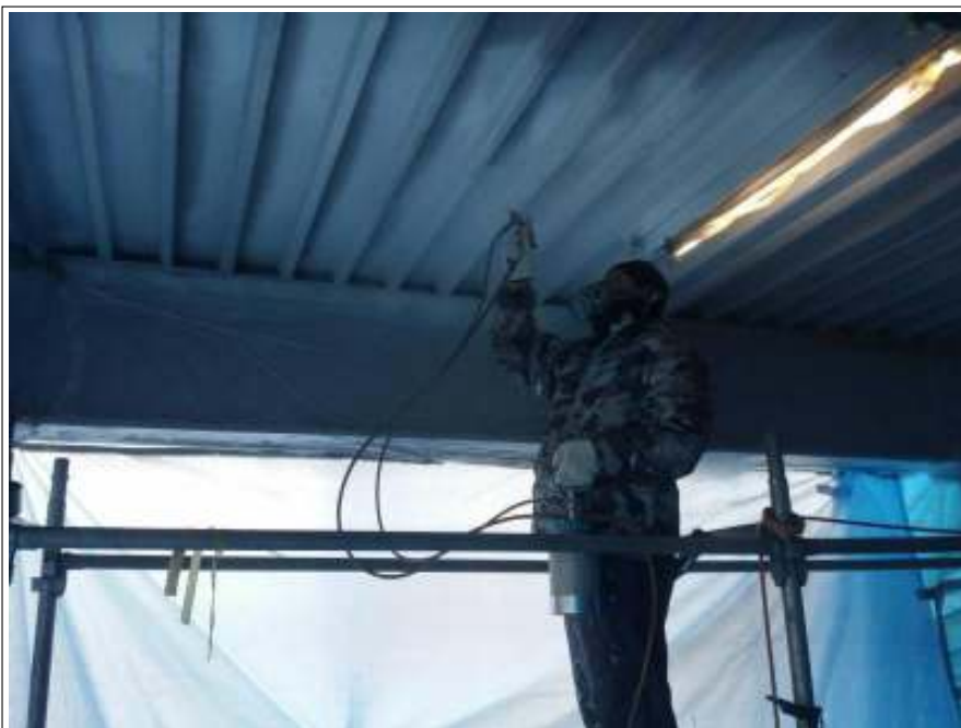
デッキプレート 中塗り施工中
