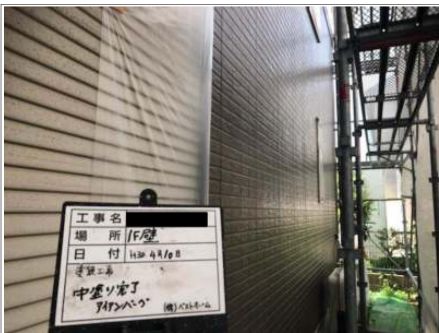
外壁（1F） 中塗り施工後
