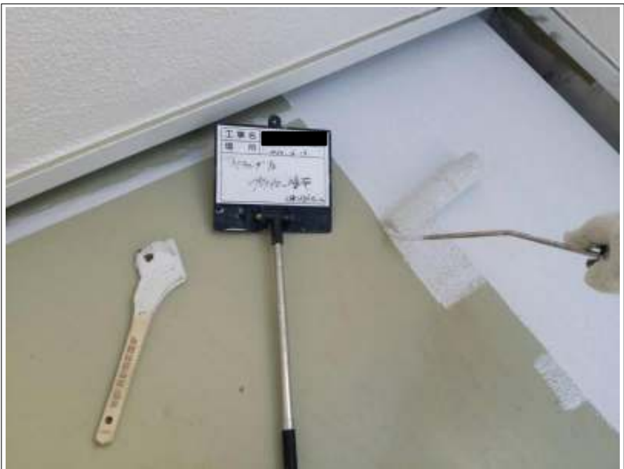
ベランダ 下塗り施工中
