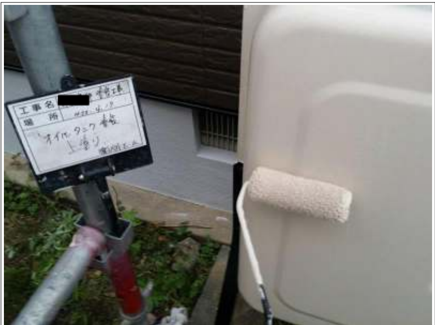
オイルタンク 上塗り(2回目) 施工中
