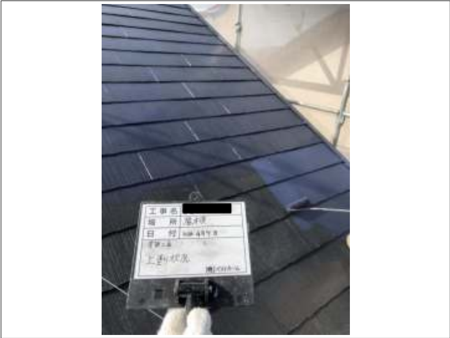
屋根 上塗り施工中
