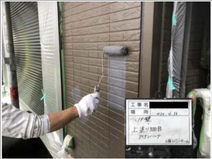
外壁（1F） 上塗り施工中
