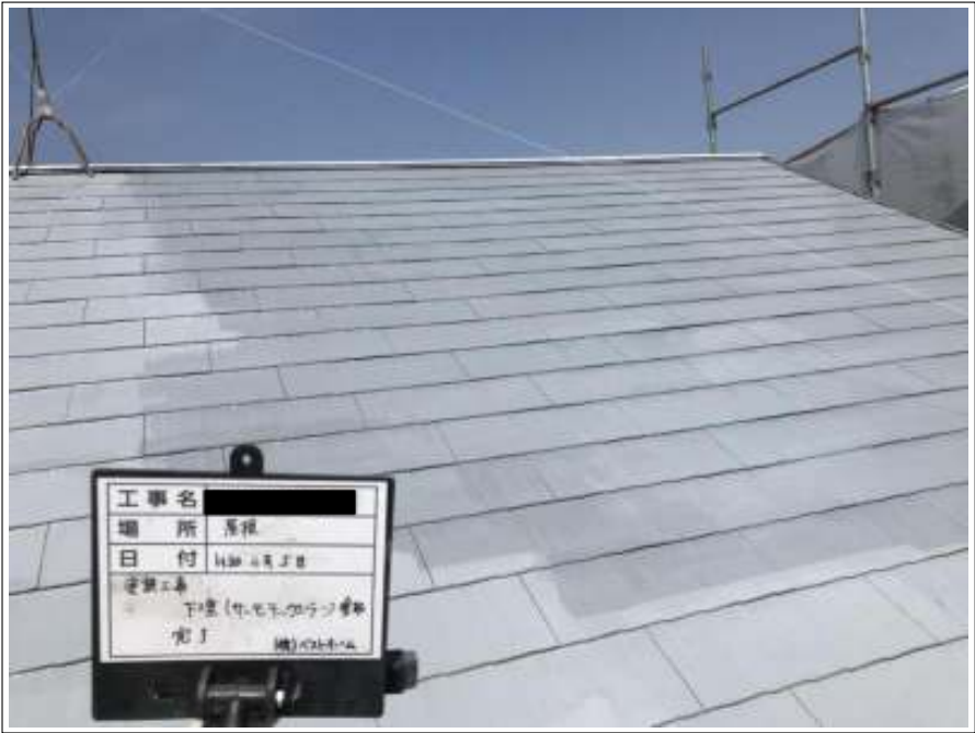
屋根 下塗り施工後
