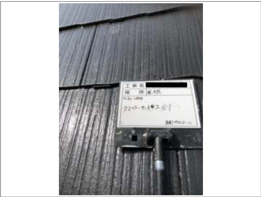
屋根 タスペーサー取付後
