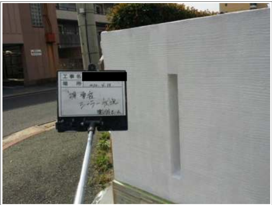
塀 下塗り施工後
