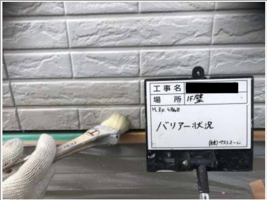
外壁 バリヤー塗布
