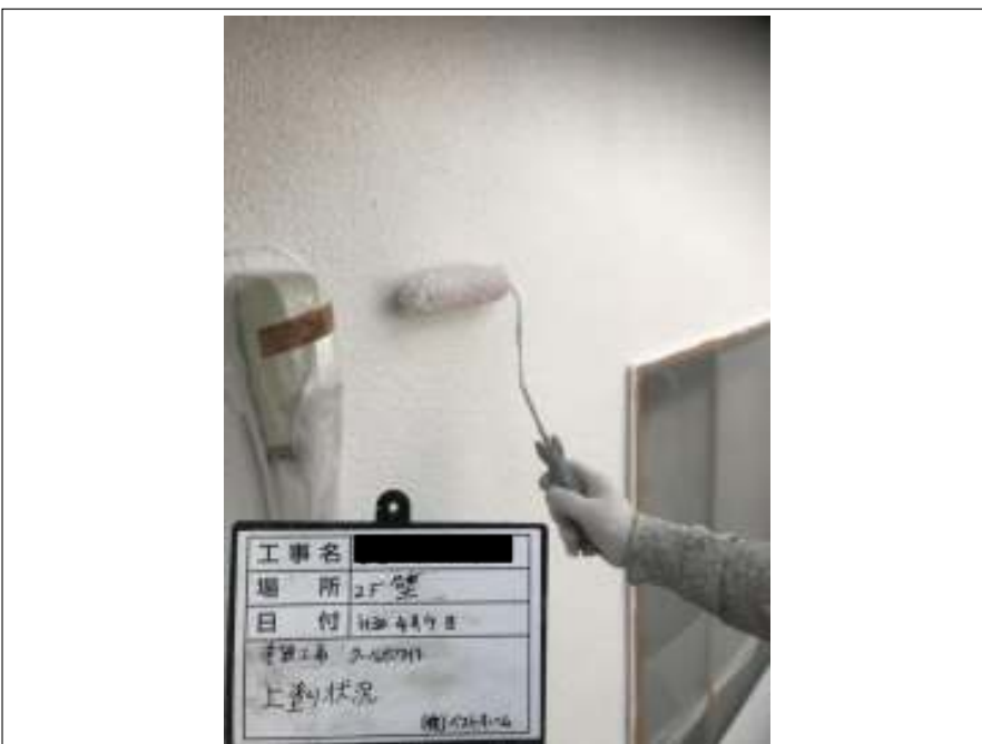
外壁（2F） 上塗り施工中
