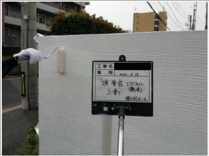
塀 上塗り施工中
