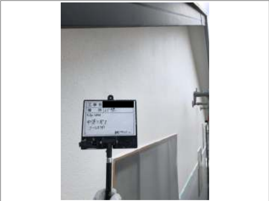
外壁（2F） 中塗り施工後
