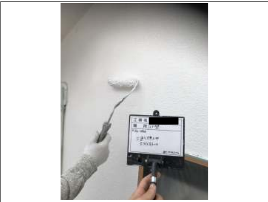
外壁 下塗り施工中
