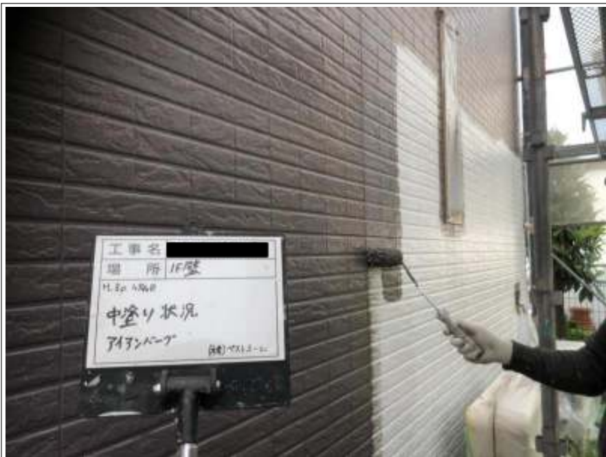
外壁（1F） 中塗り施工中
