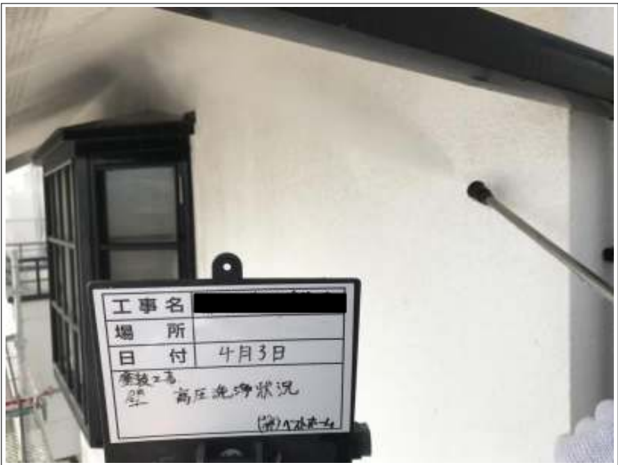
外壁 高圧洗浄中
