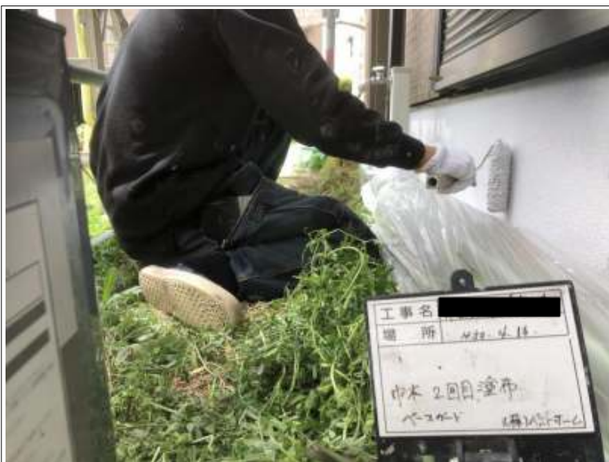
基礎 上塗り（2回目）施工中
