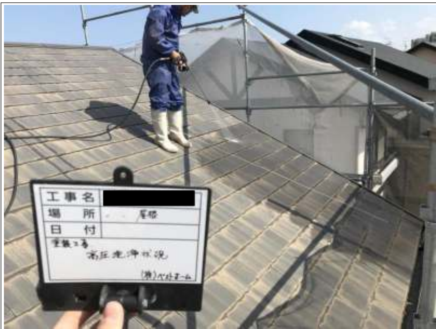
屋根 高圧洗浄中
