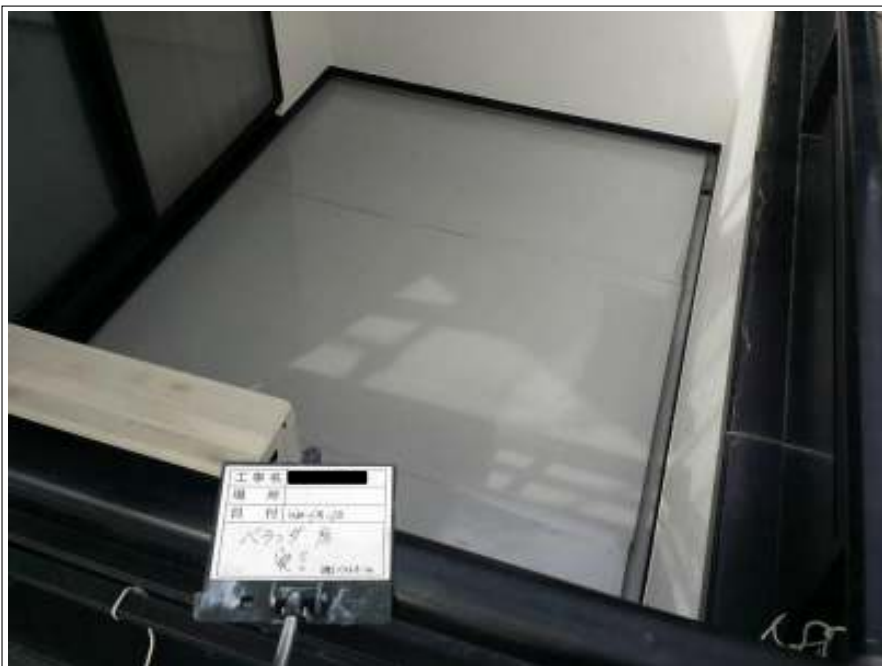
ベランダ 施工完了
