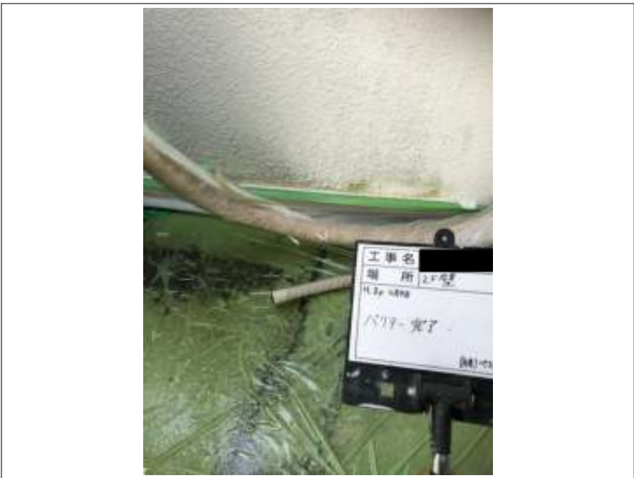
外壁 バリヤー塗布後
