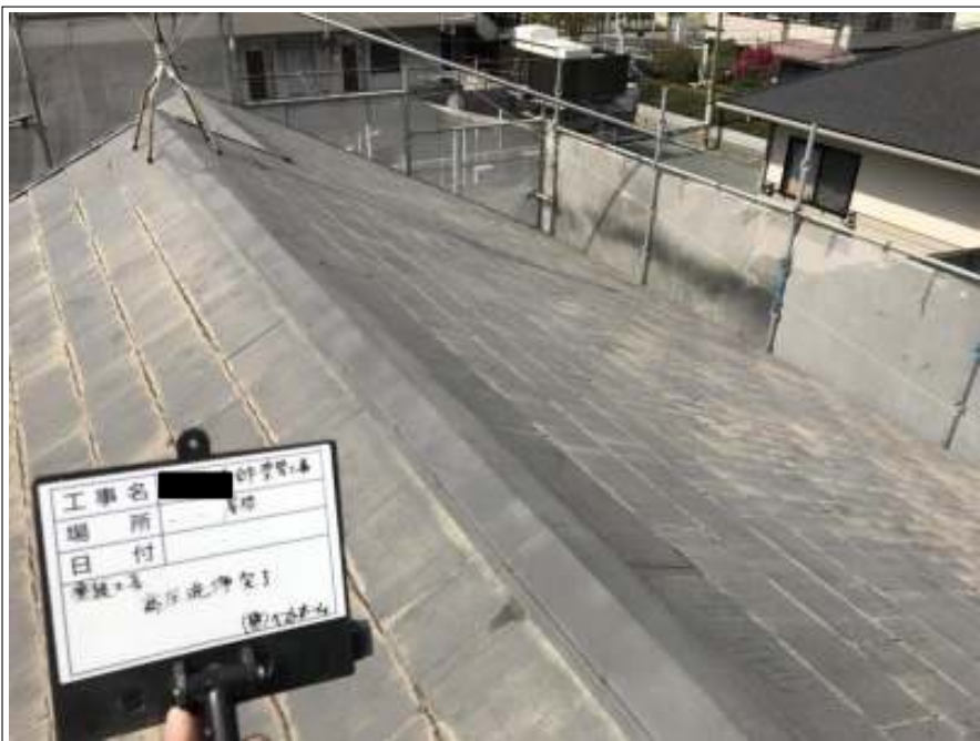
屋根 高圧洗浄後
