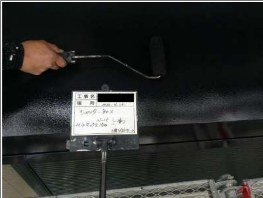
シャッターBOX 上塗り施工中
