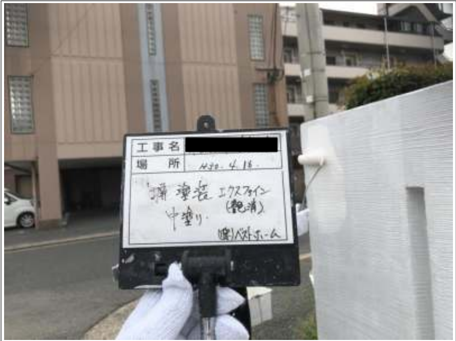
塀 中塗り施工中
