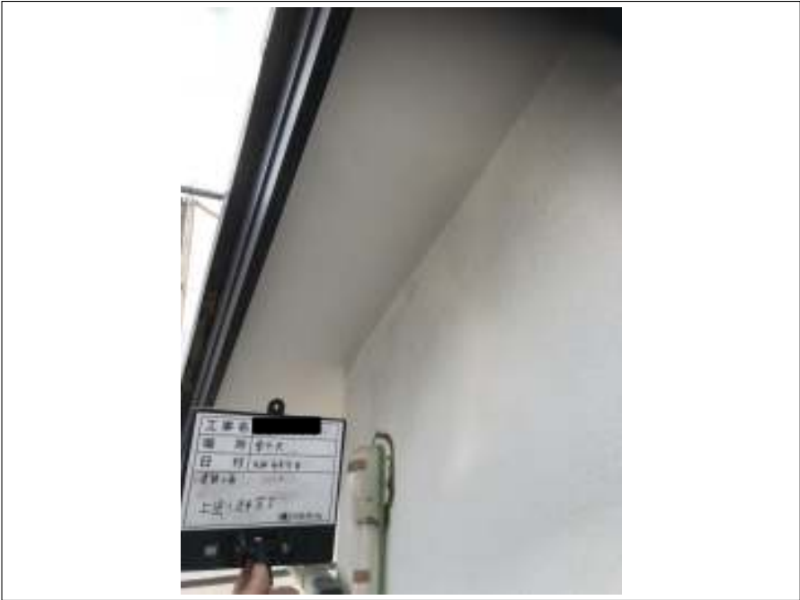
軒天 上塗り（2回目）施工後
