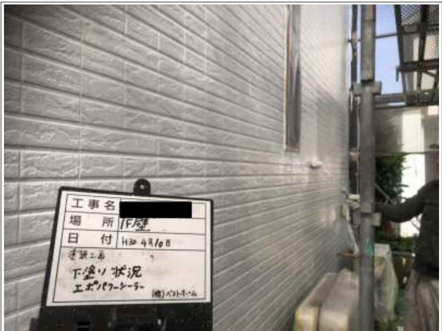
外壁 下塗り施工中
