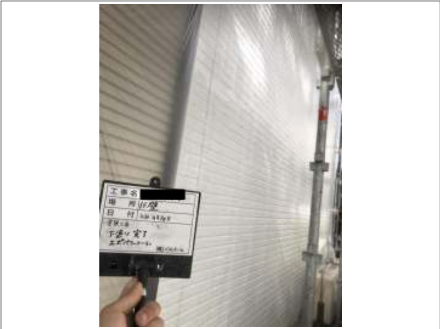
外壁 下塗り施工後
