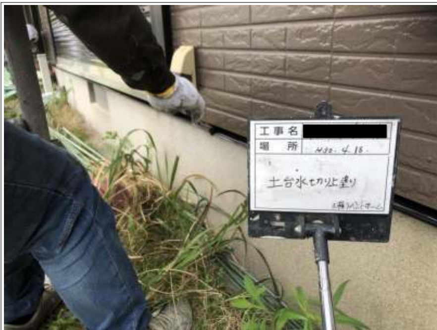
土台水切り 上塗り施工中
