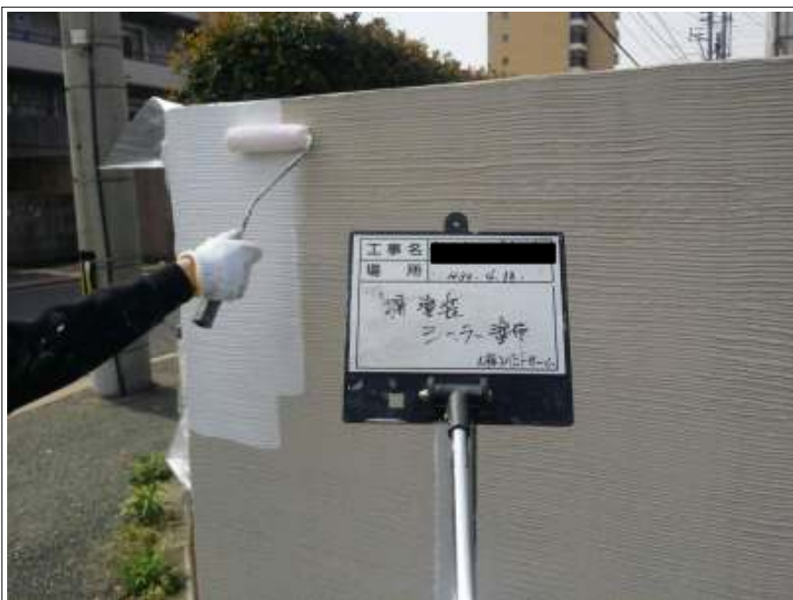
塀 下塗り施工中
