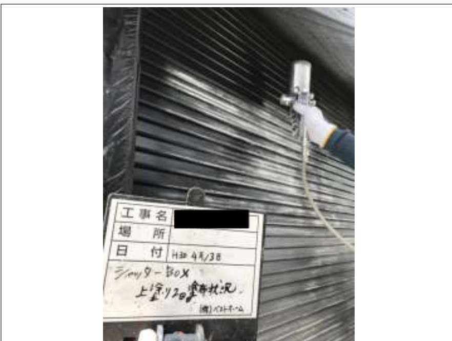
シャッター 上塗り施工中
