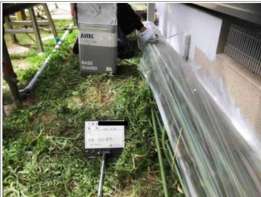
基礎 上塗り（1回目）施工中
