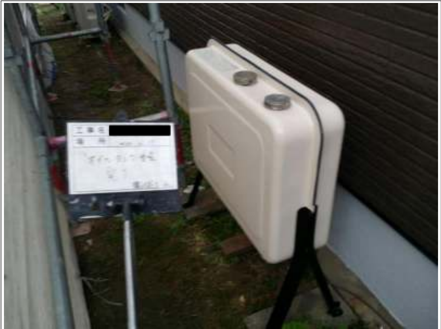
オイルタンク 施工完了
