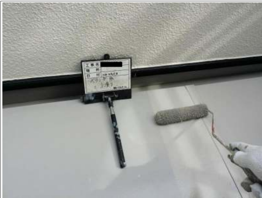
ベランダ 上塗り施工中
