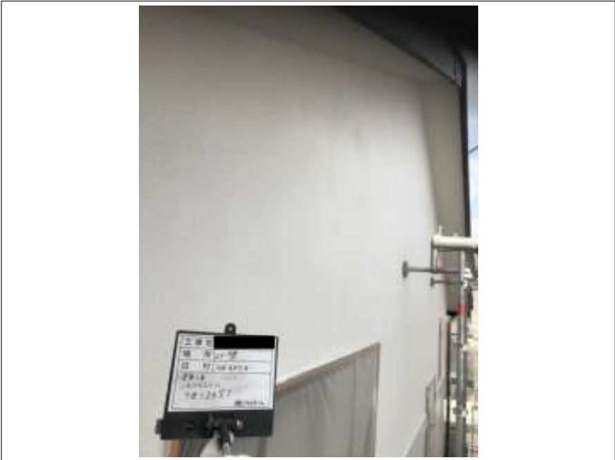
外壁 下塗り施工後
