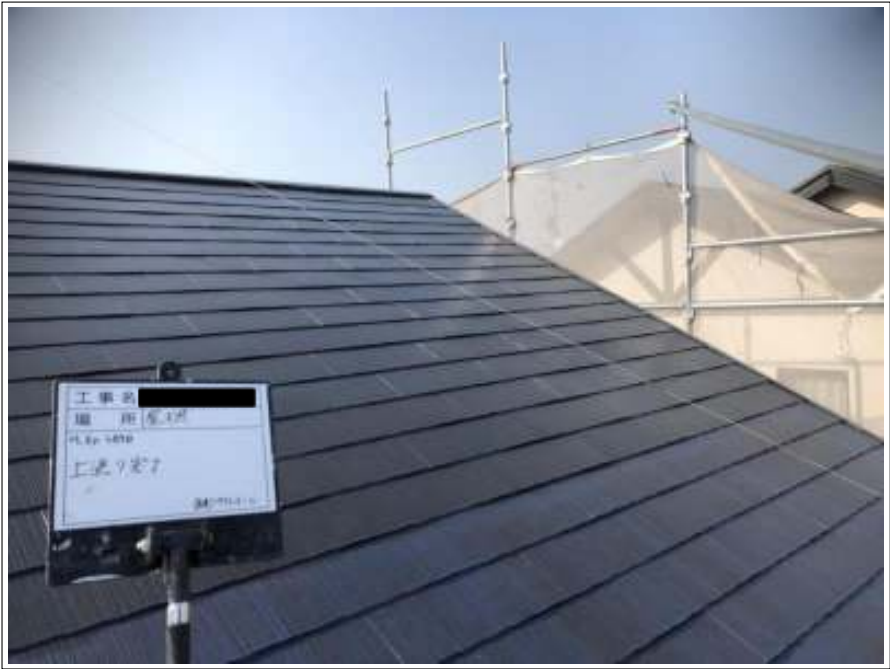
屋根 上塗り施工後
