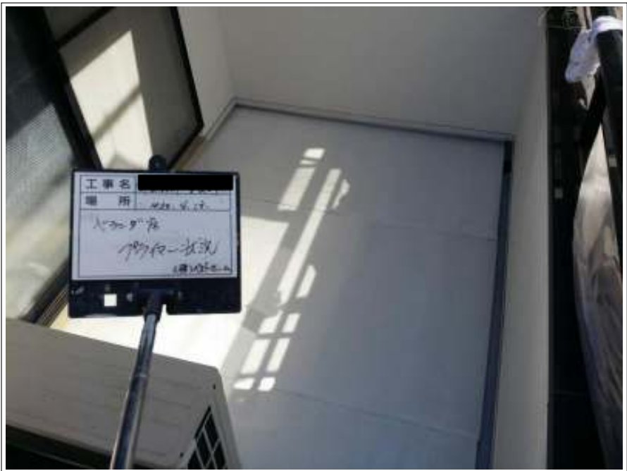
ベランダ 下塗り施工中
