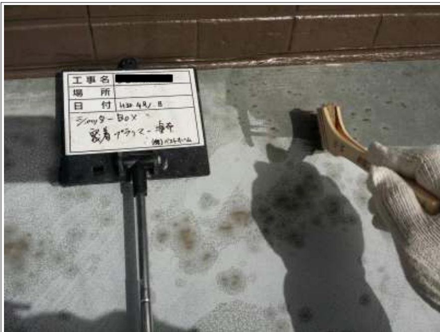
シャッターBOX 下塗り施工中
