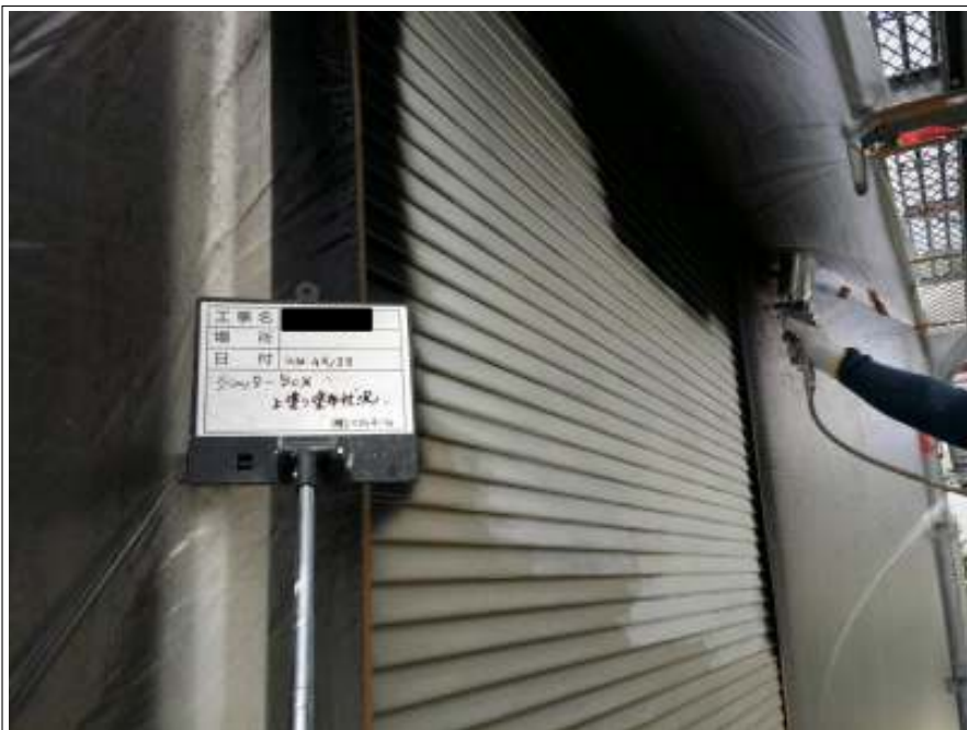
シャッター 中塗り施工中
