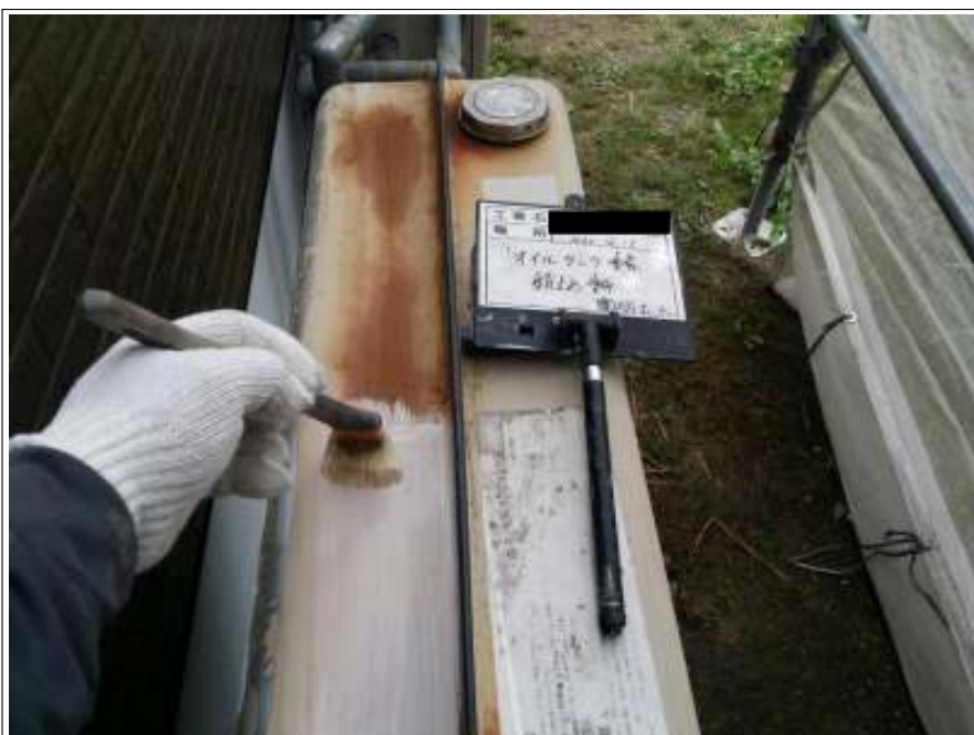
オイルタンク サビ止め塗布
