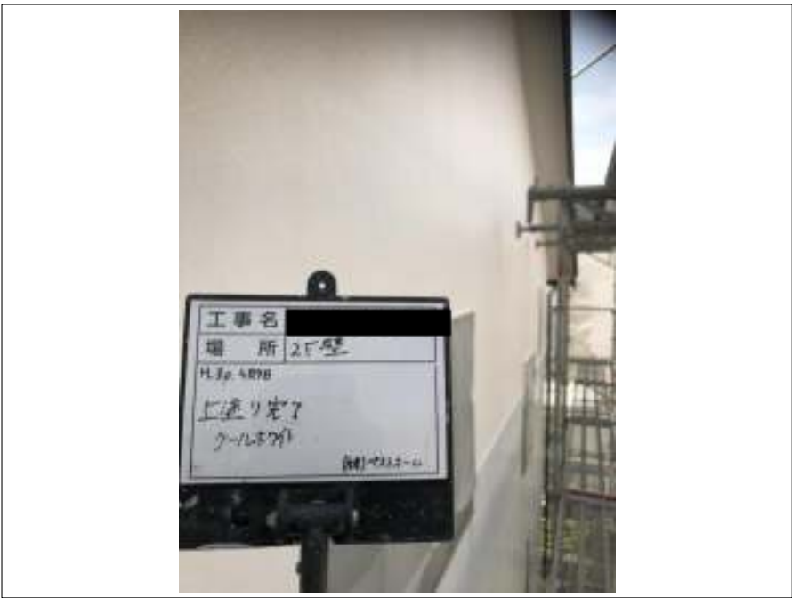
外壁（2F） 上塗り施工後
