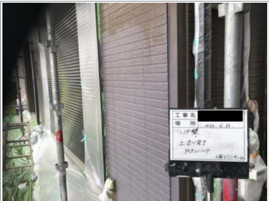
外壁（1F） 上塗り施工後
