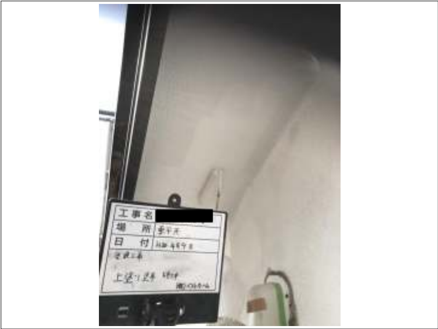
軒天 上塗り（2回目）施工中
