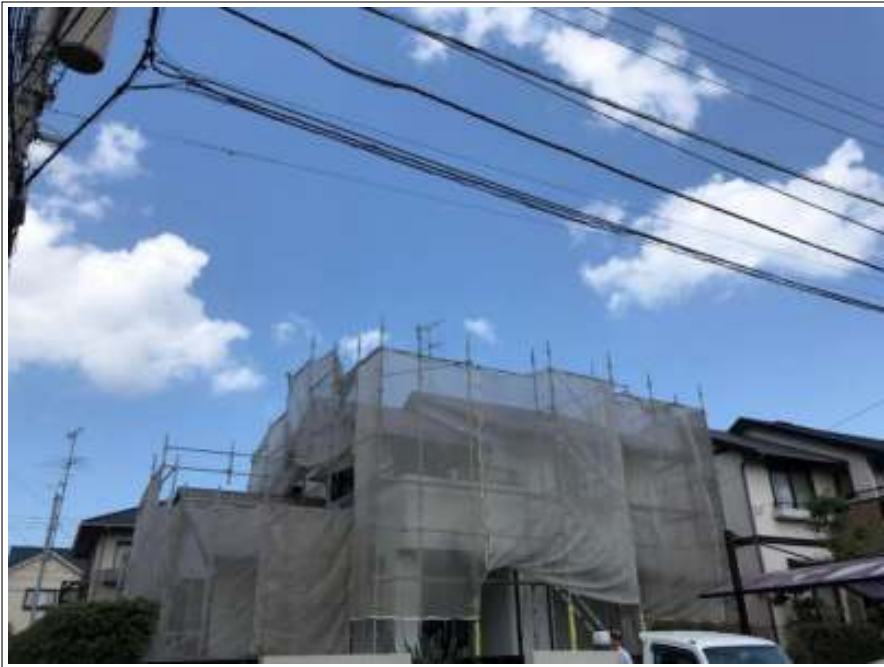
仮設足場組立
