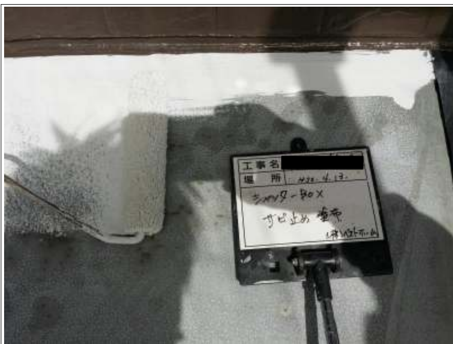
シャッターBOX サビ止め塗布
