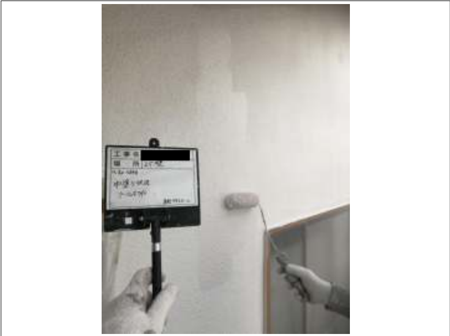
外壁（2F） 中塗り施工中
