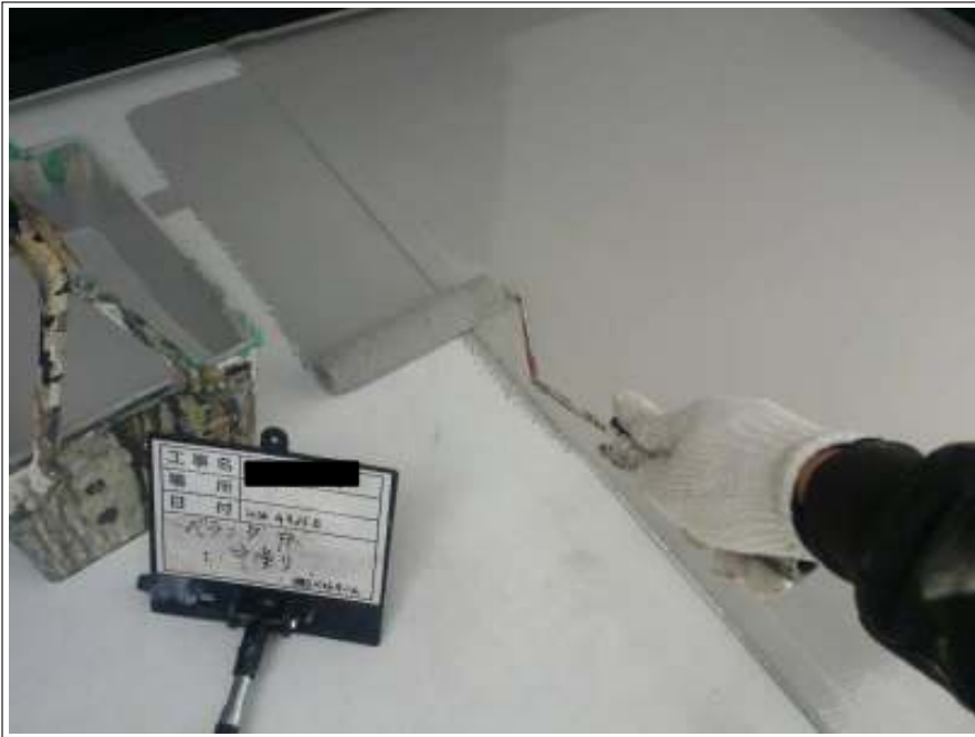
ベランダ 中塗り施工中
