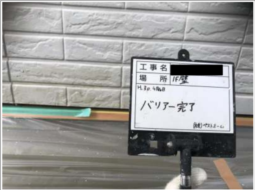
外壁 バリヤー塗布後
