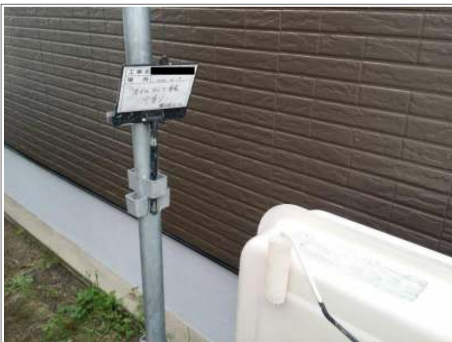
オイルタンク 上塗り(1回目) 施工中
