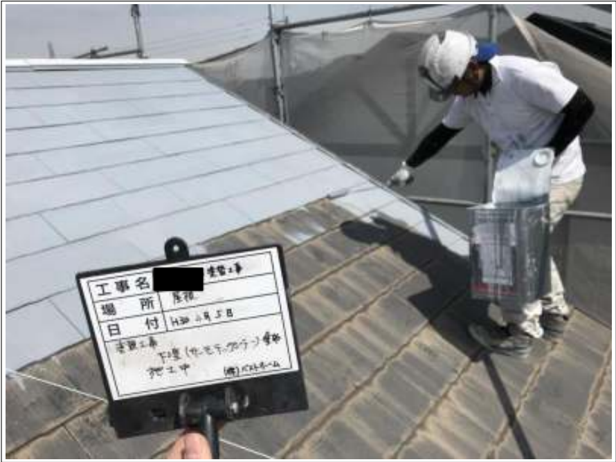
屋根 下塗り施工中
