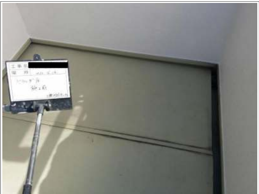
ベランダ 施工前
