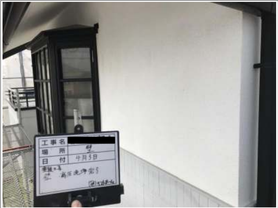
外壁 高圧洗浄後
