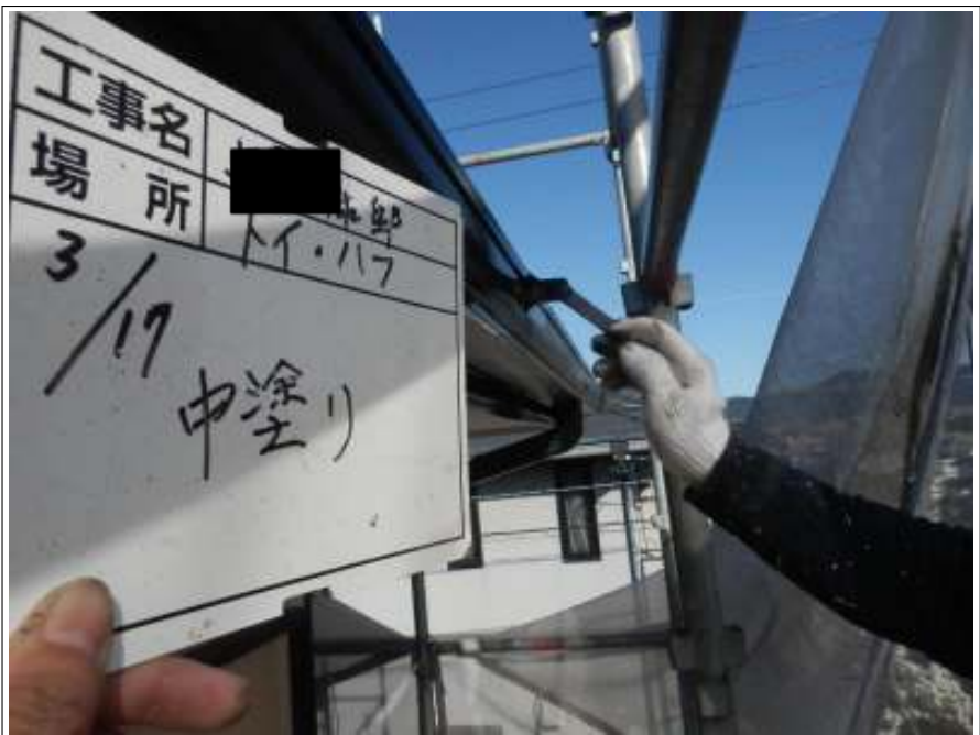
雨樋 上塗り（1回目）施工中
