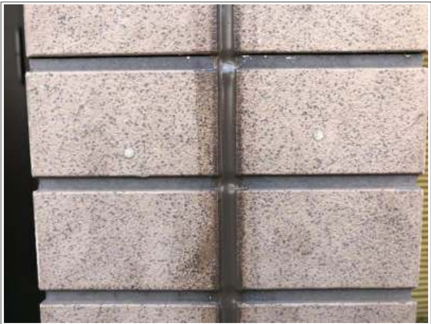
シーリング 施工完了
