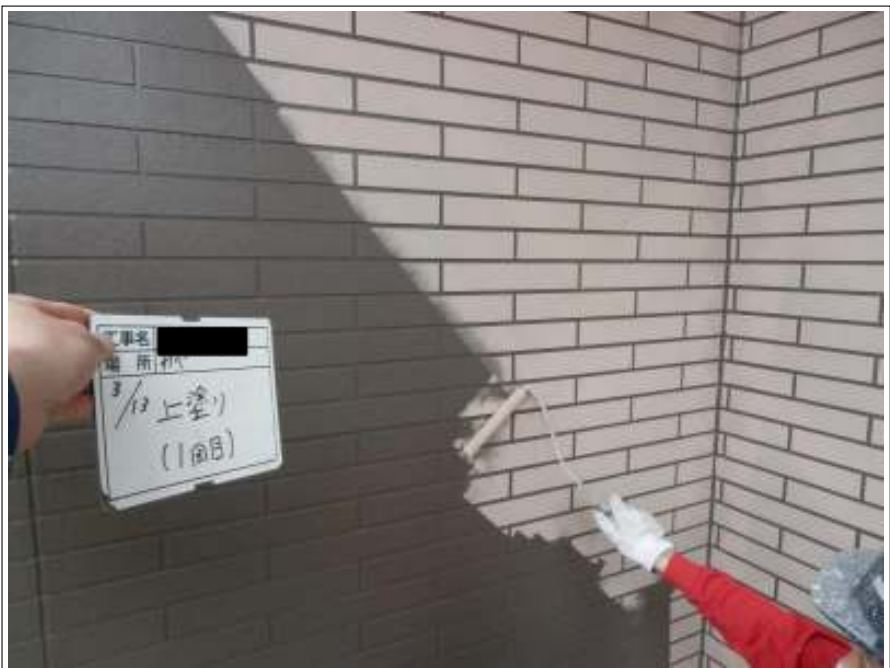
外壁 中塗り施工中
