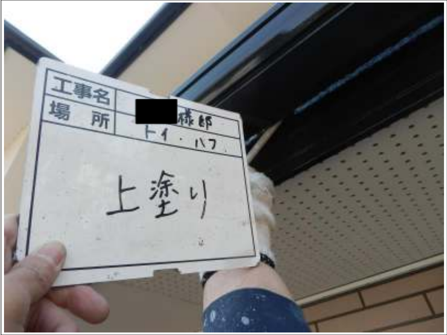
破風板 上塗り（2回目）施工中
