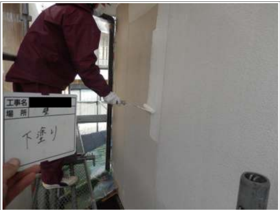
外壁 下塗り施工中
