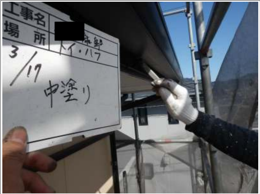
破風板 上塗り（1回目）施工中
