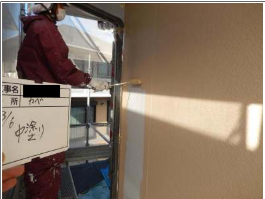
外壁 中塗り施工中
