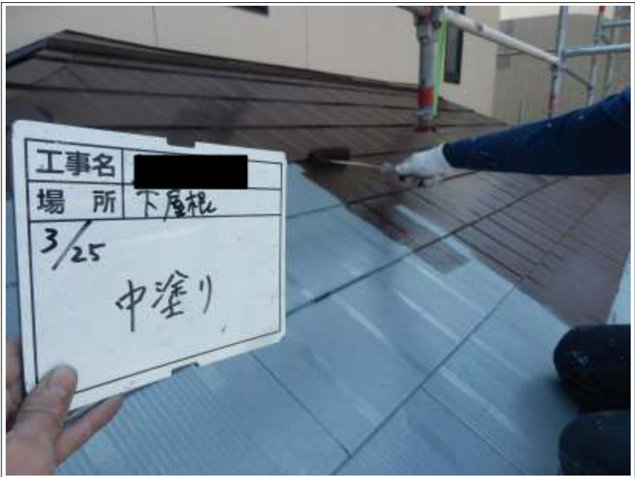
下屋根 中塗り施工中
