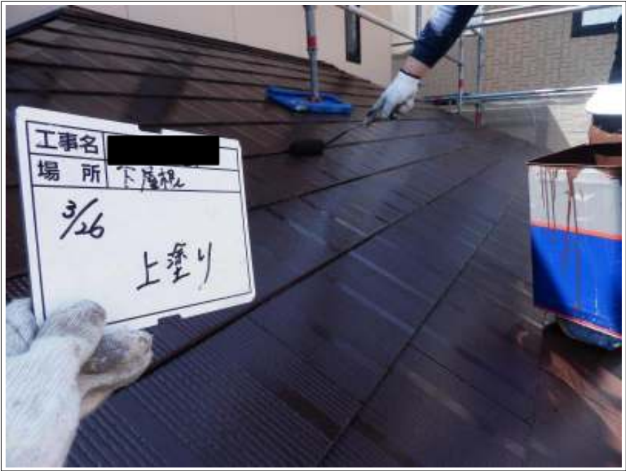
下屋根 上塗り施工中
