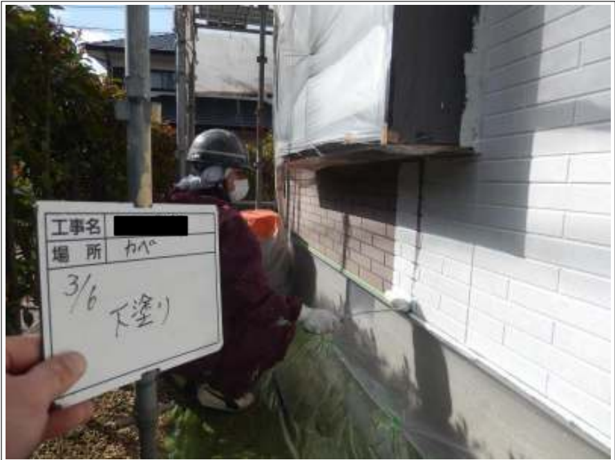
外壁 下塗り施工中
