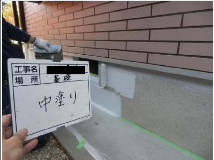
基礎 上塗り（1回目）施工中
