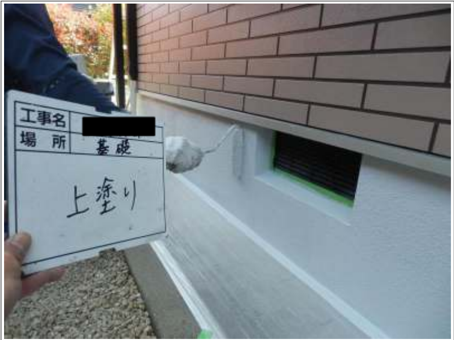
基礎 上塗り（2回目）施工中
