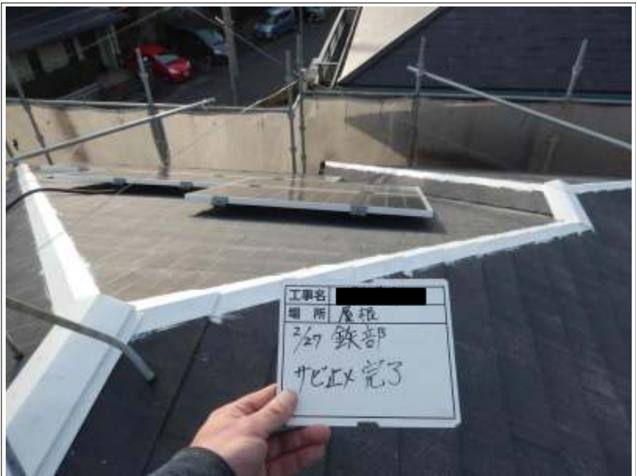
屋根板金部 サビ止め塗布完了
