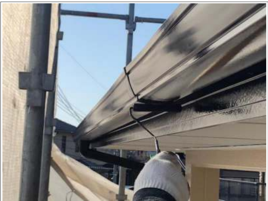
雨樋 上塗り（2回目）施工中
