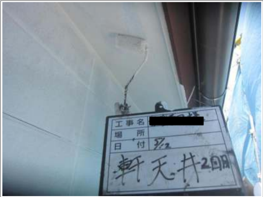
軒天 上塗り (2回目) 施工中
