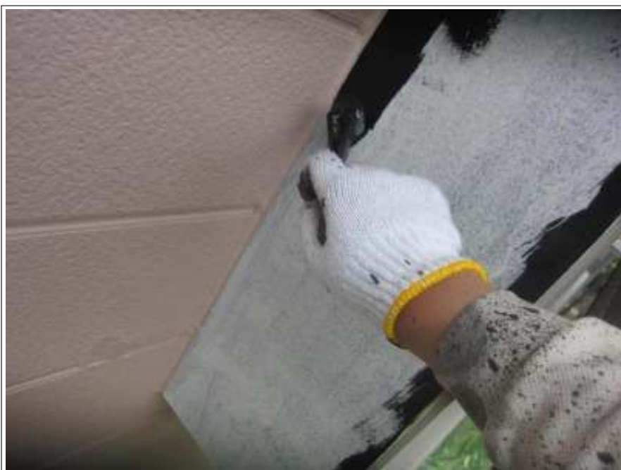
小庇 上塗り施工中
