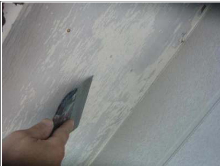
軒天 下地処理
