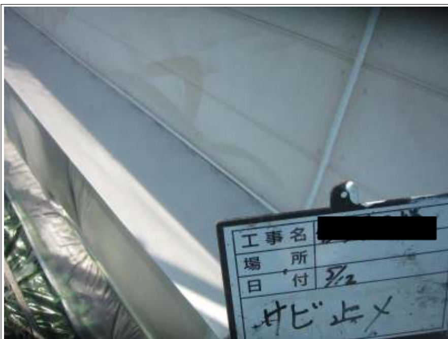
小庇 サビ止め塗布後
