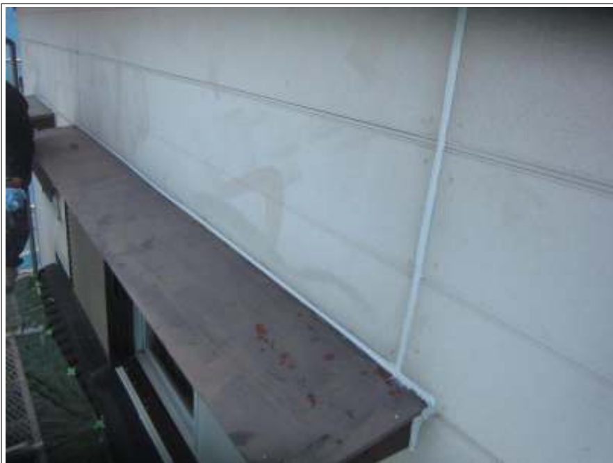
シーリング打ち替え 施工後
