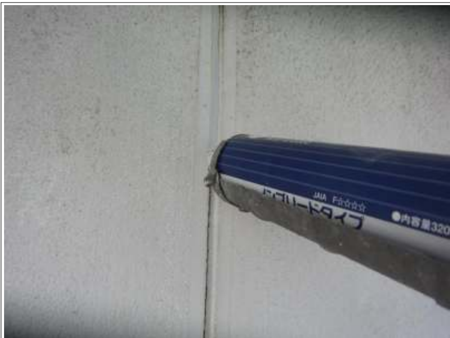
シーリング補修 施工中
