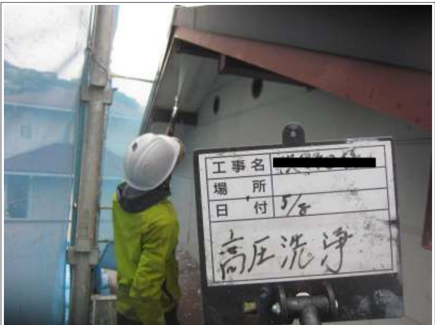
軒天 高压洗浄中
