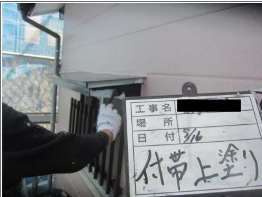
破風板 上塗り施工中
