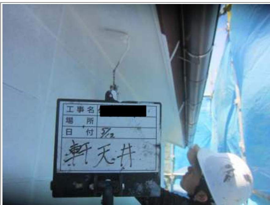
軒天 上塗り（1回目）施工中
