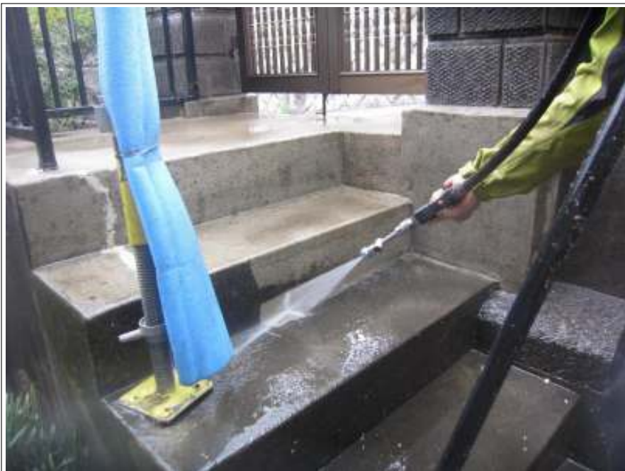
階段部 高圧洗浄中
