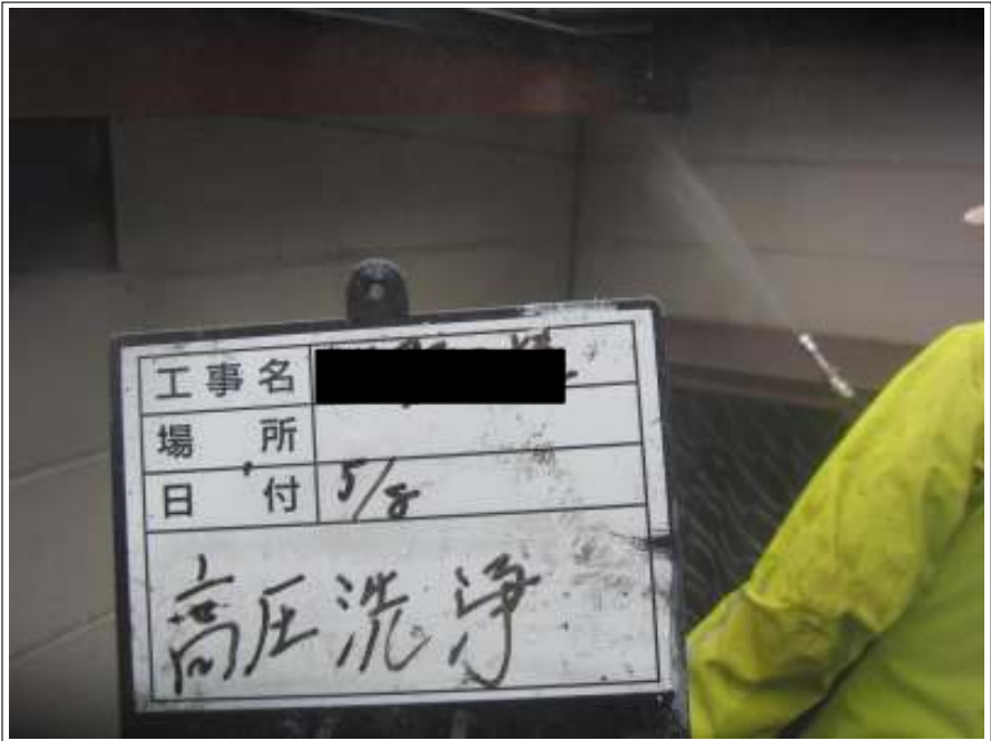
外壁 高压洗浄中
