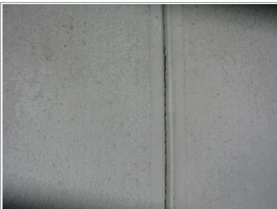
シーリング補修 施工前
