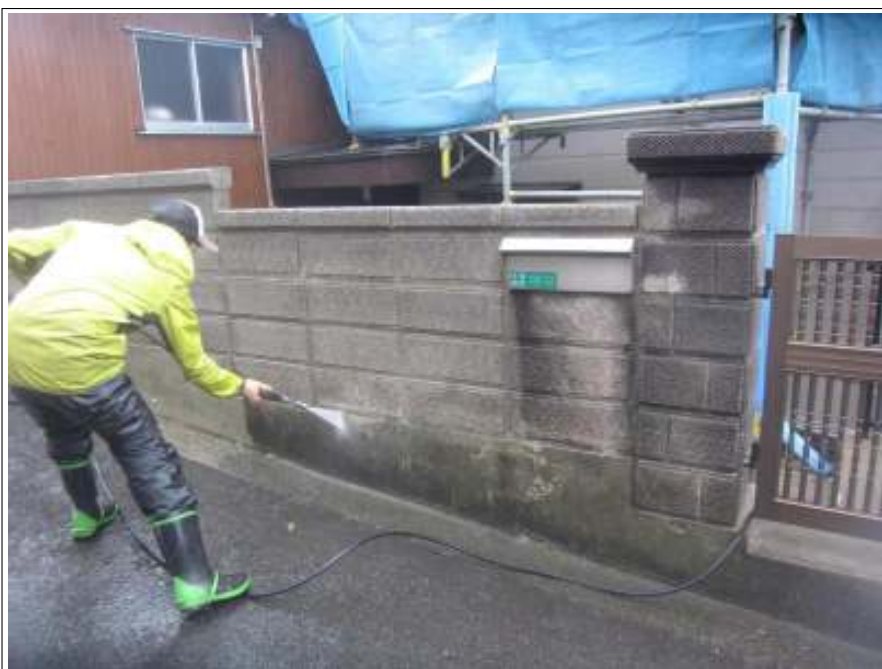
塀 高圧洗浄中
