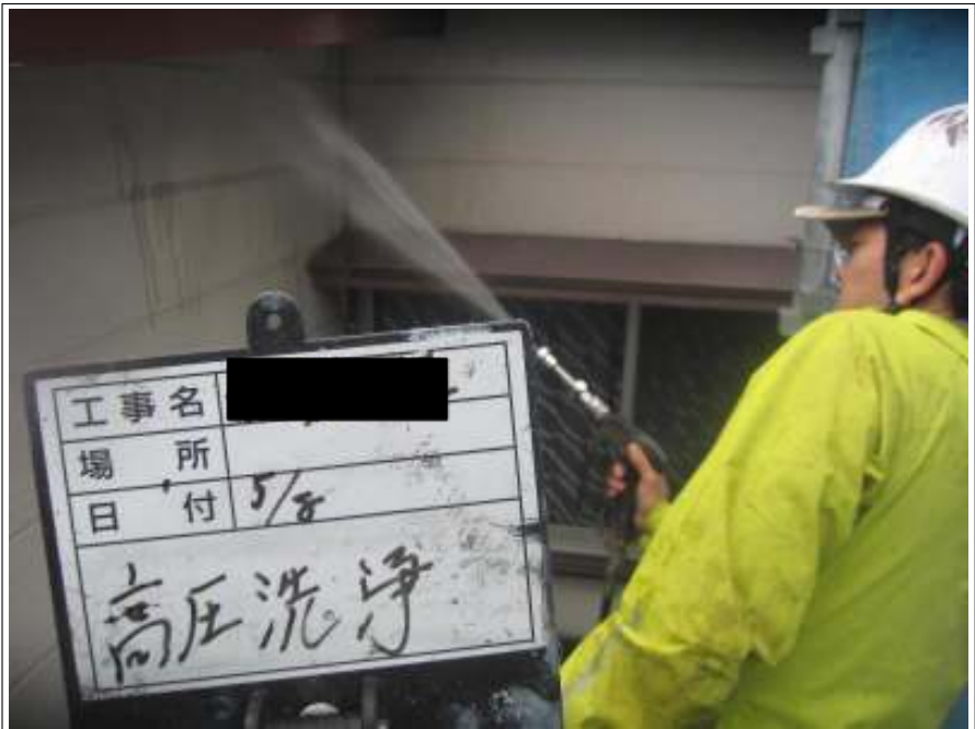
外壁 高压洗浄中
