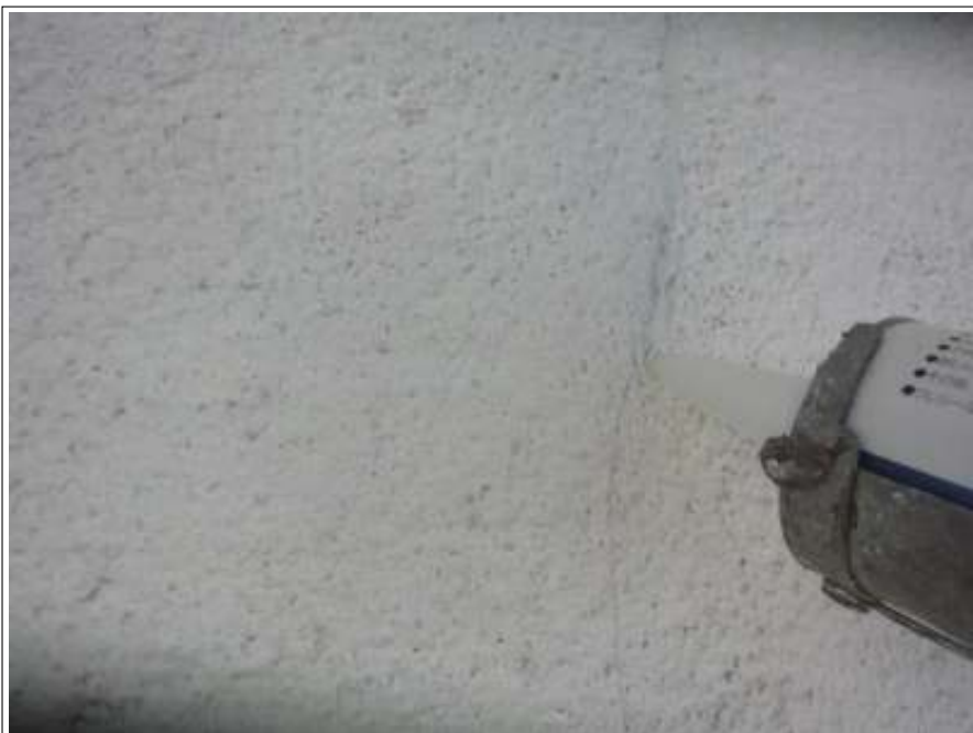
シーリング補修 施工中
