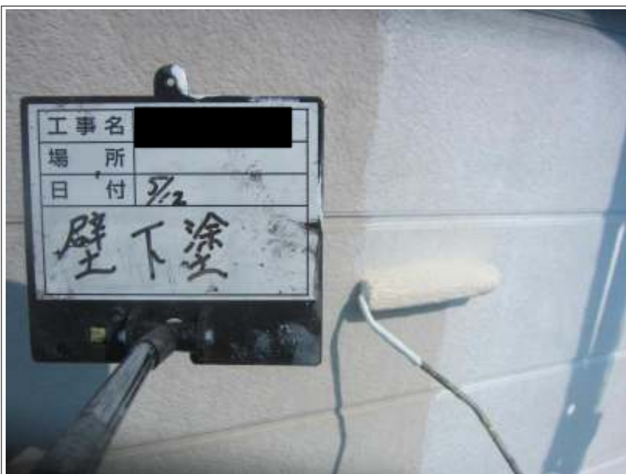
外壁 下塗り施工中
