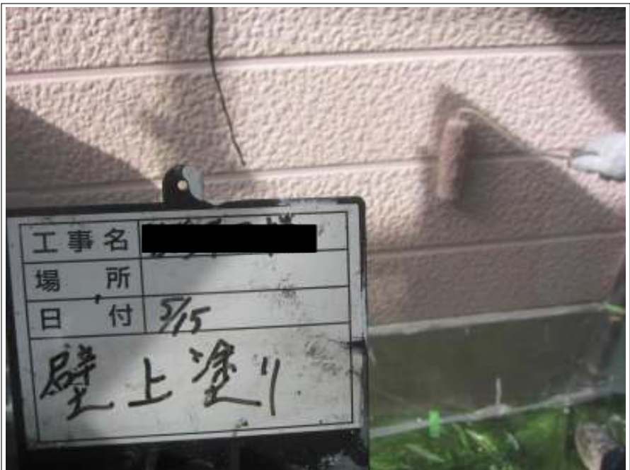
外壁 上塗り施工中
