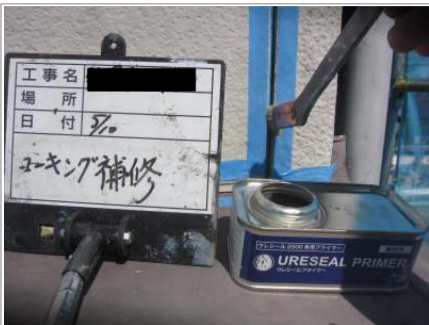
プライマー塗布
