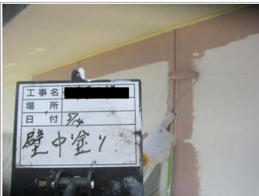
外壁 中塗り施工中
