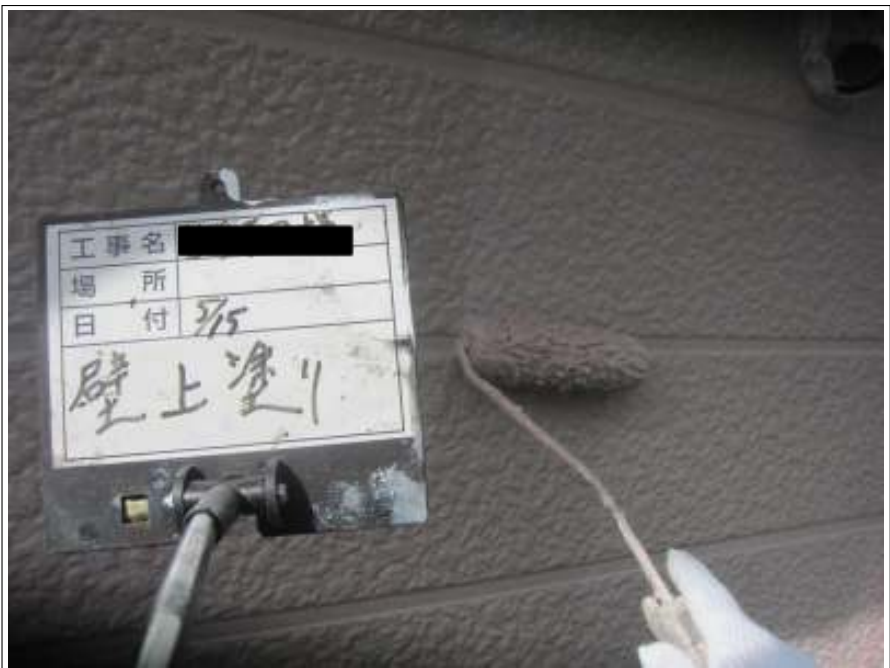
外壁 上塗り施工中
