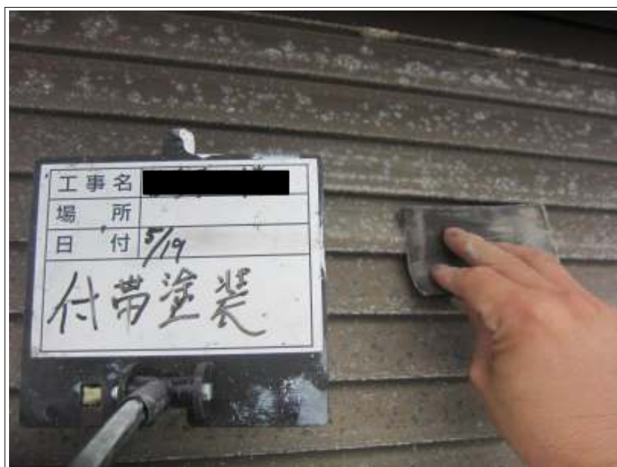
シャッター ケレン処理
