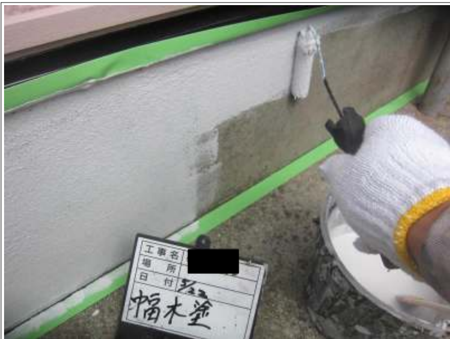
基礎 上塗り（1回目）施工中
