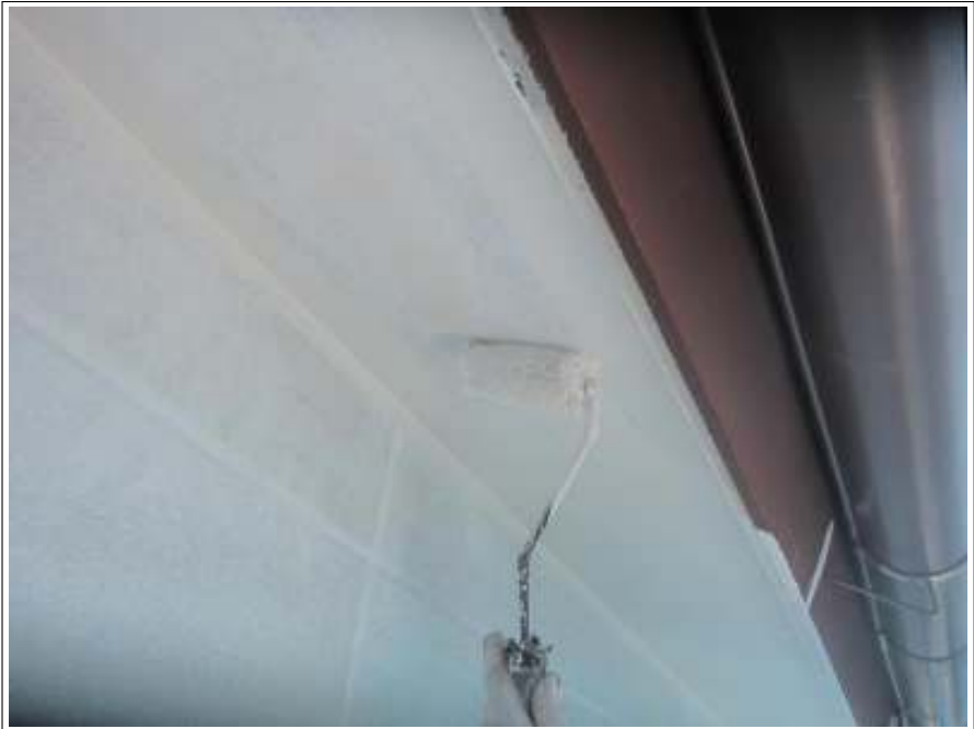
軒天 上塗り (2回目) 施工中
