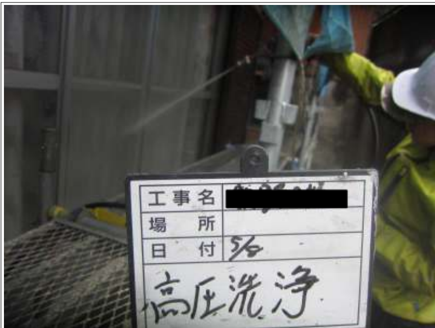
窓 高压洗浄中
