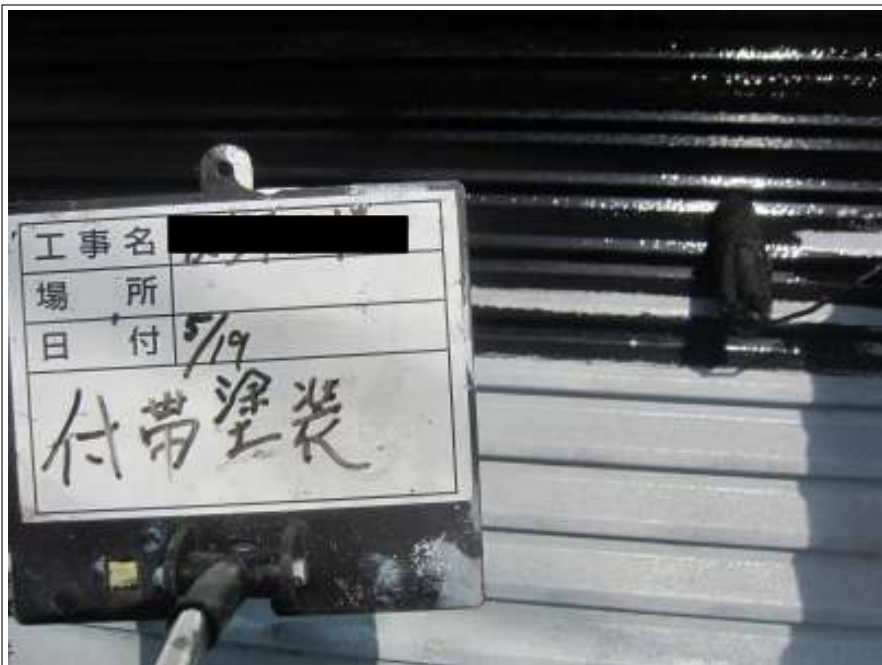
シャッター 上塗り施工中
