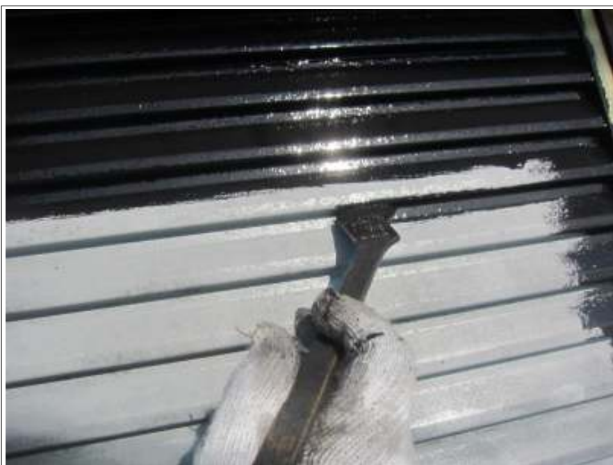
シャッター 上塗り施工中
