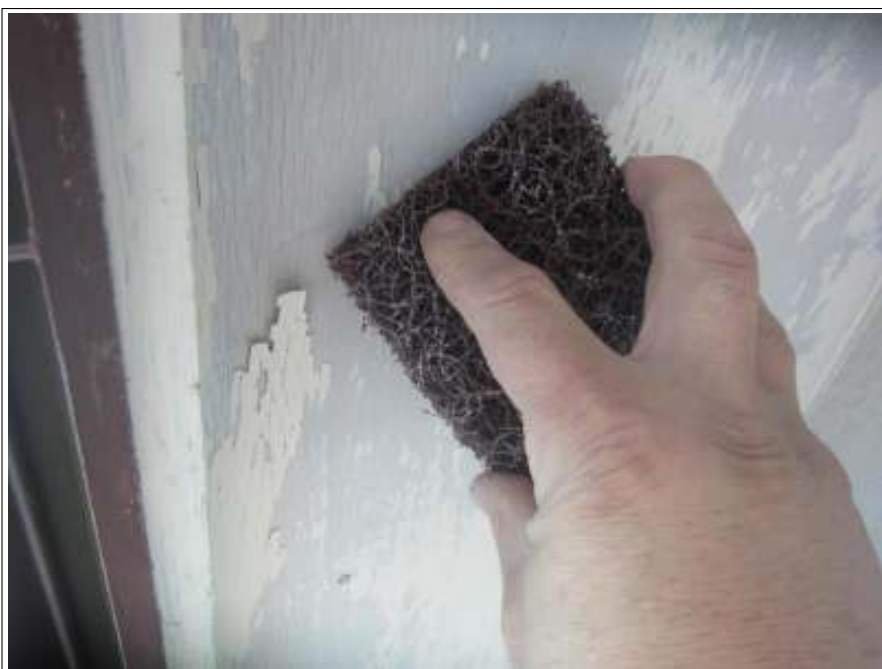
軒天 ケレン処理
