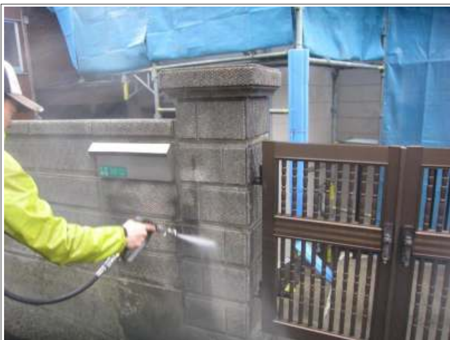
塀 高圧洗浄中
