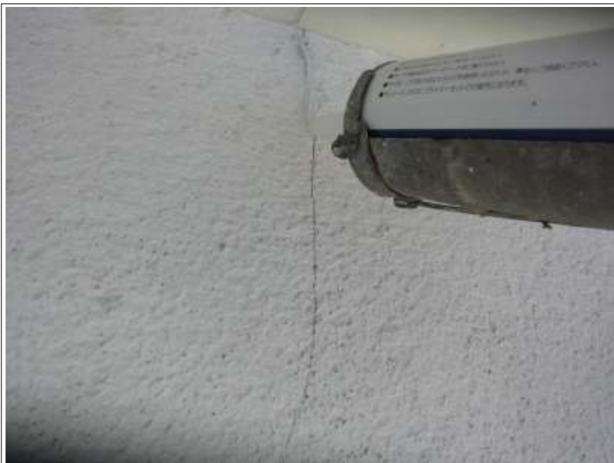
シーリング補修 施工中
