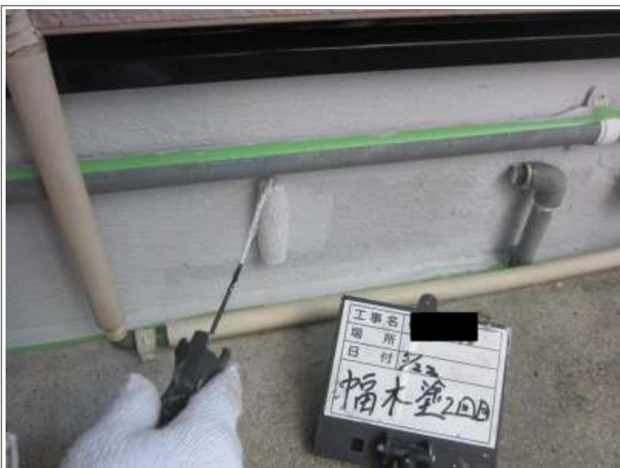
基礎 上塗り（2回目）施工中
