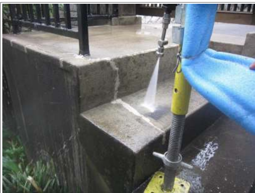
階段部 高压洗浄中
