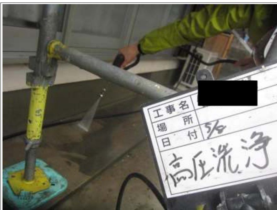
土間 高压洗浄中
