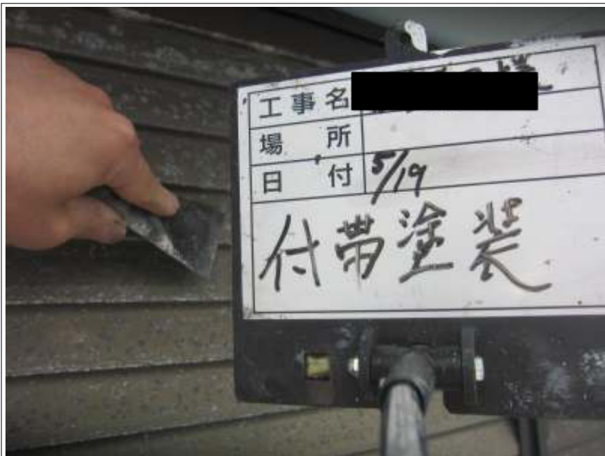
シャッター 下地処理
