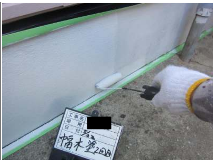
基礎 上塗り（2回目）施工中
