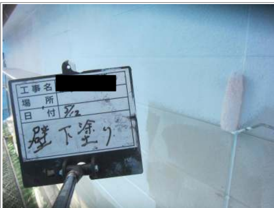
外壁 下塗り施工中
