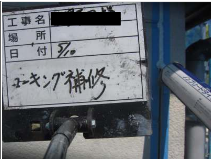
シーリング材充填
