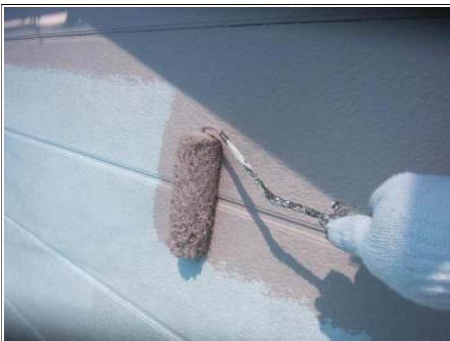
外壁 中塗り施工中
