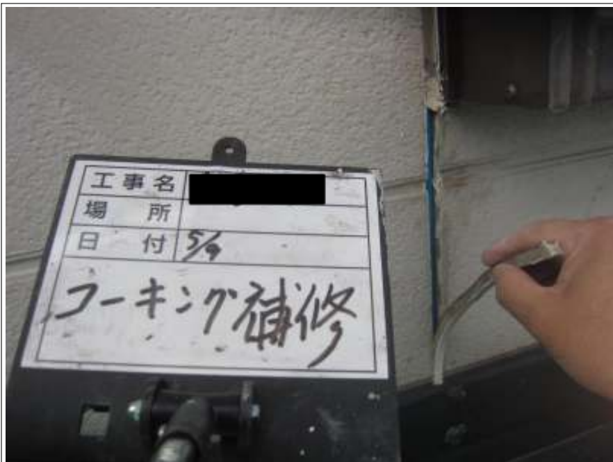
既存シーリング撤去
