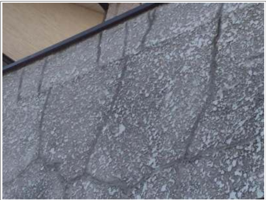
外壁 クラック補修部
