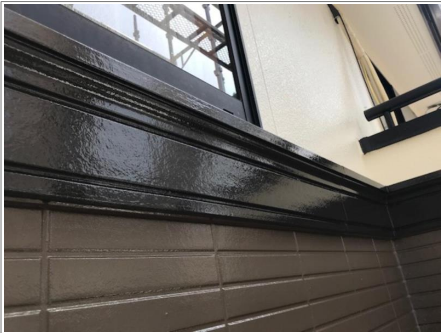
帯 上塗り施工後
