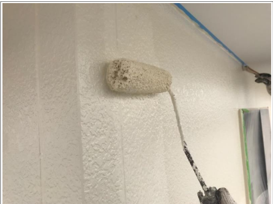
外壁 上塗り施工中
