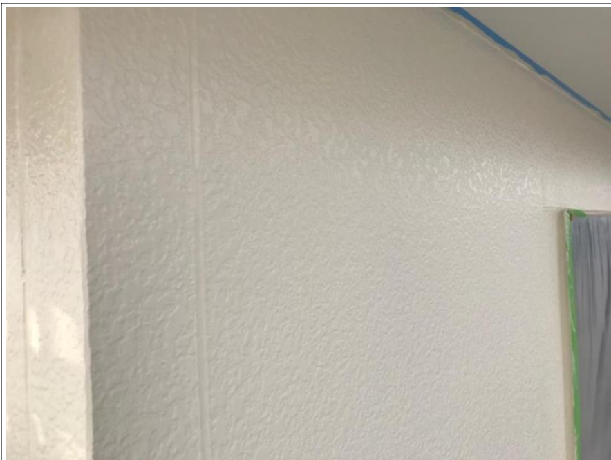
外壁 中塗り施工後
