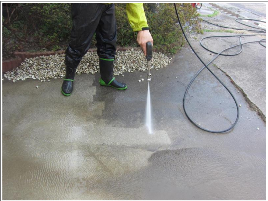
土間 高圧洗浄中
