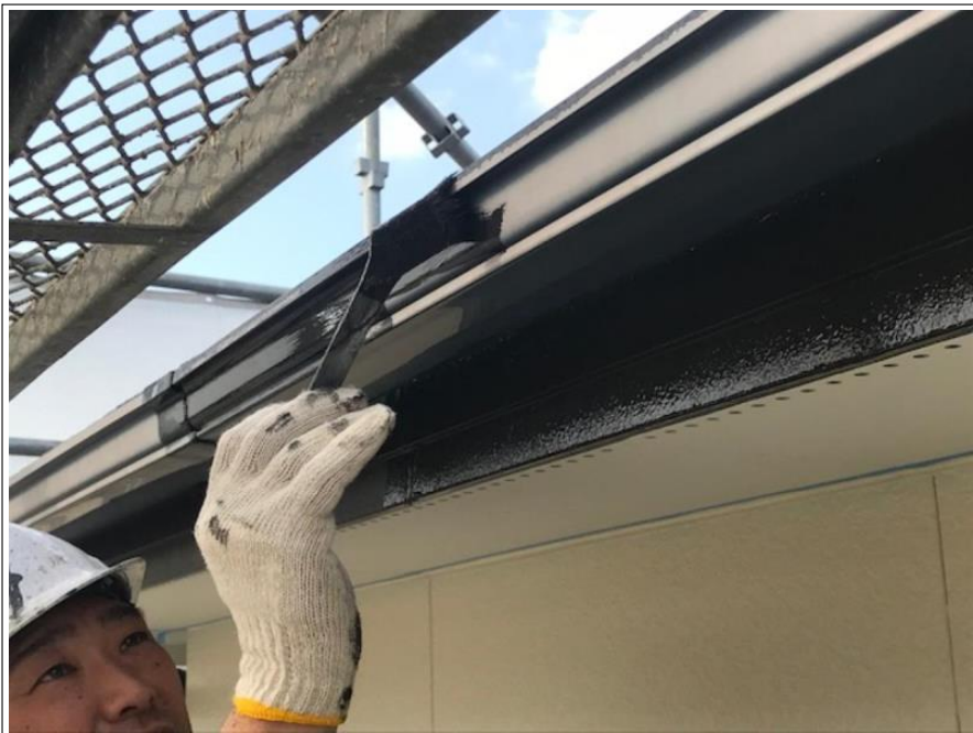
樋 上塗り（1回目）施工中
