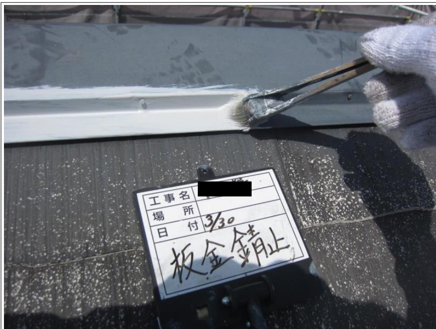
屋根板金部 錆止め塗布
