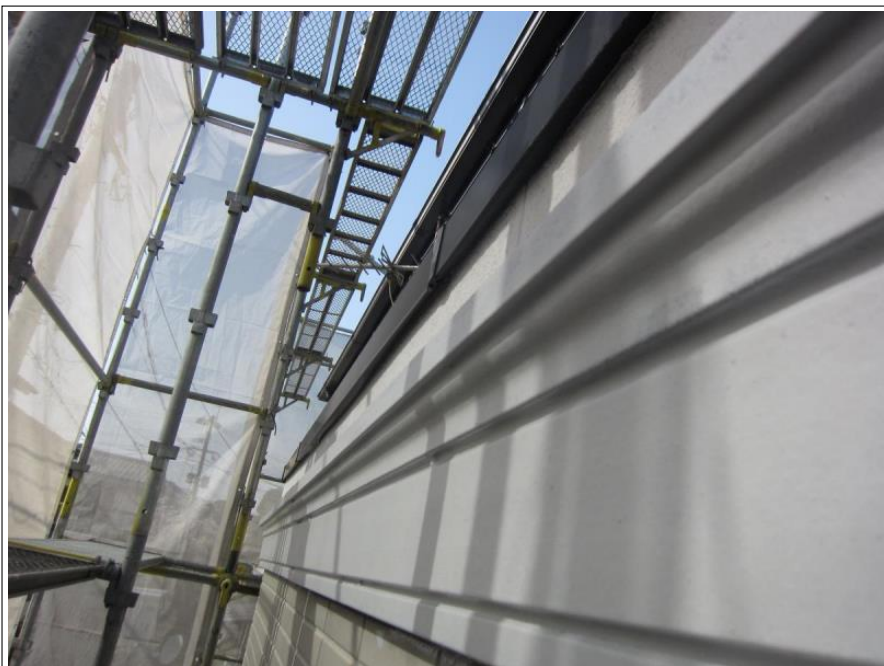
帯 下塗り施工後
