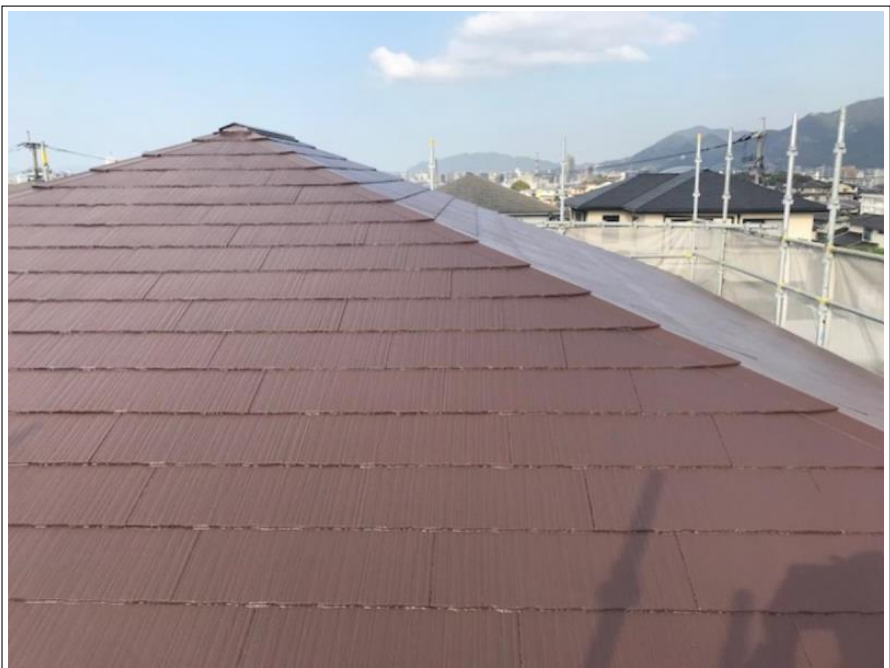
屋根 上塗り施工後
