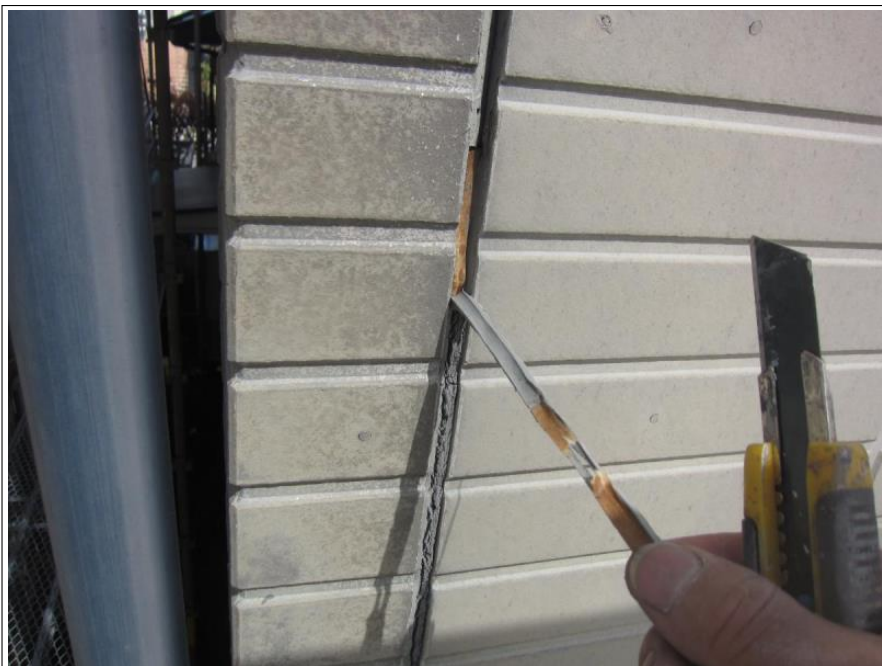
シーリング打替え 既存撤去
