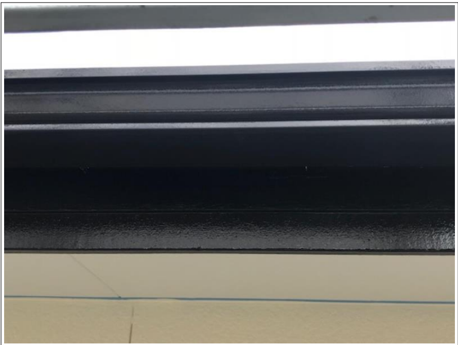
樋 上塗り（2回目）施工後
