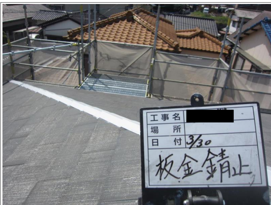
屋根板金部 錆止め塗布後
