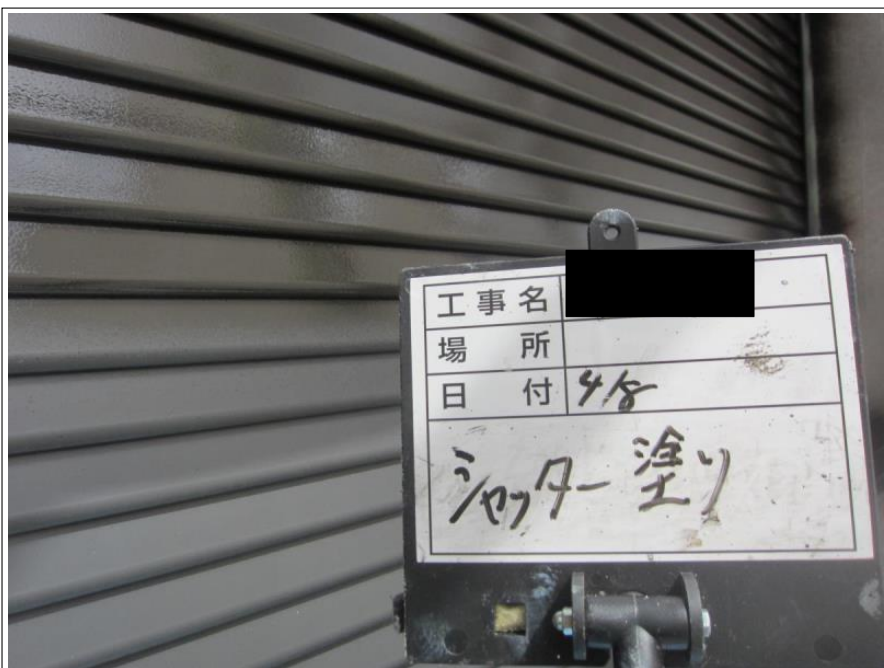
シャッター 上塗り(1回目)施工中
