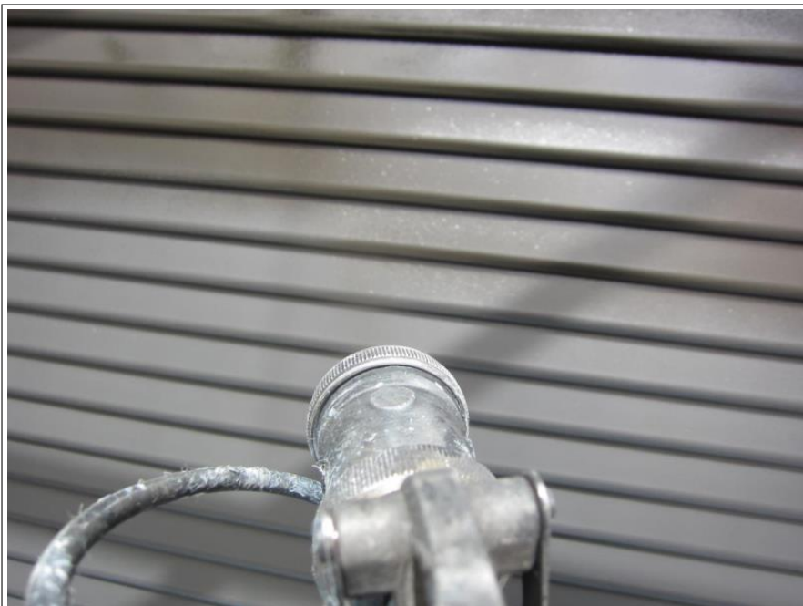
シャッター 上塗り(2回目) 施工中
