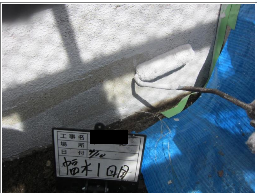
基礎 上塗り（1回目）施工中
