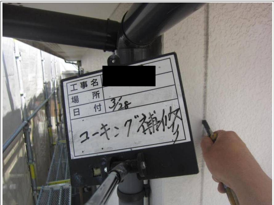
シーリング打替え 既存撤去
