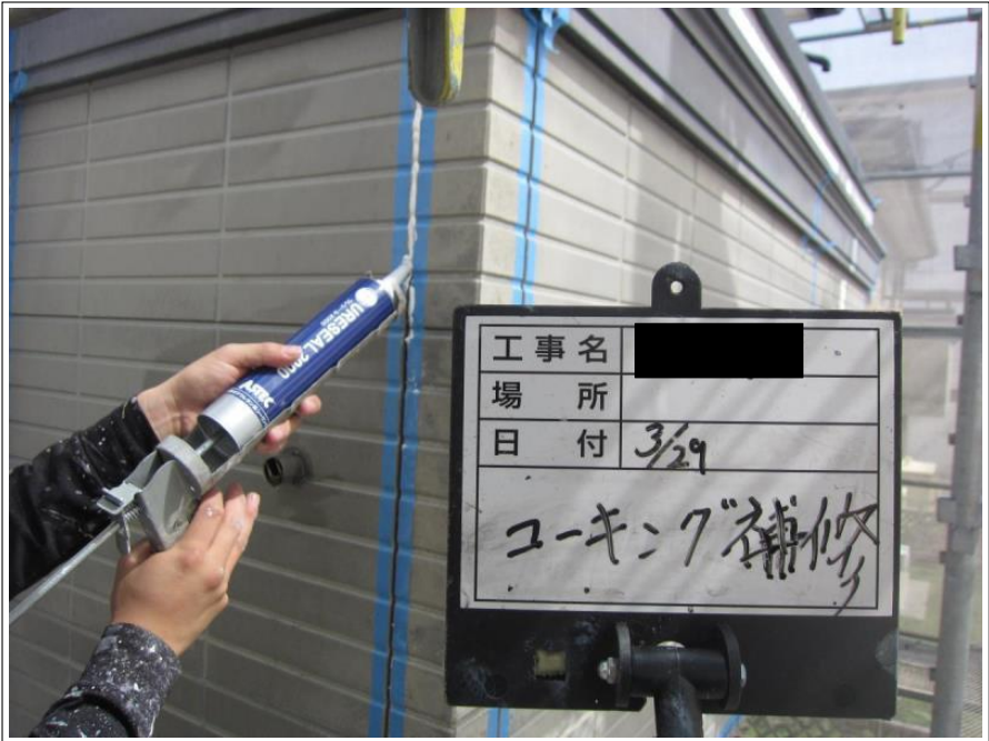
シーリング打替え 充填
