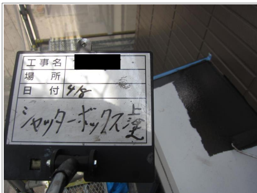
シャッターBOX 上塗り 施工中
