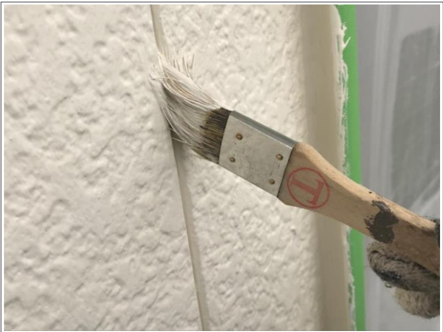
外壁 上塗り施工中
