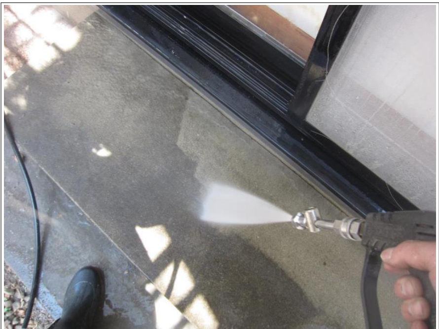
土間 高圧洗浄中
