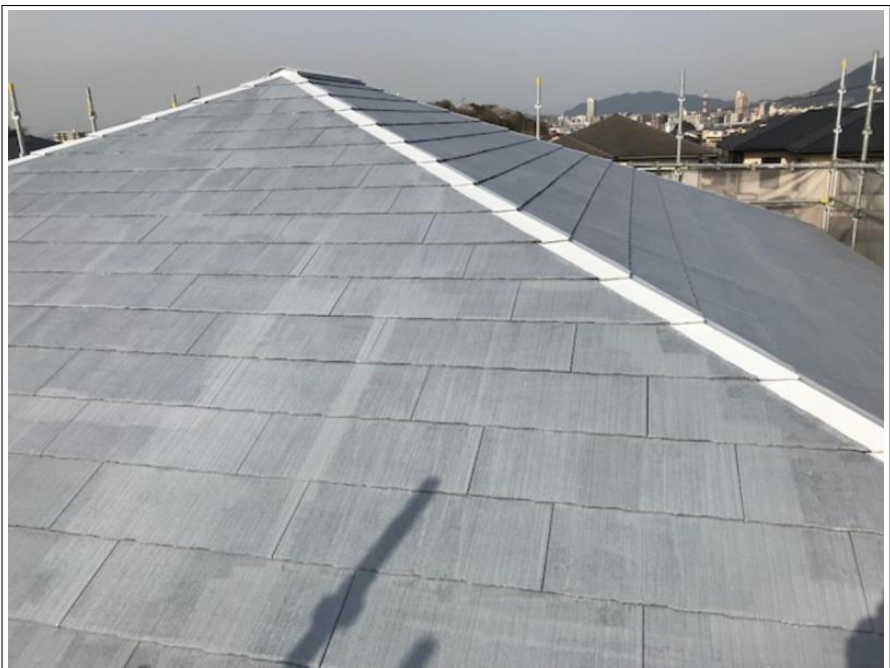
屋根 下塗り施工後
