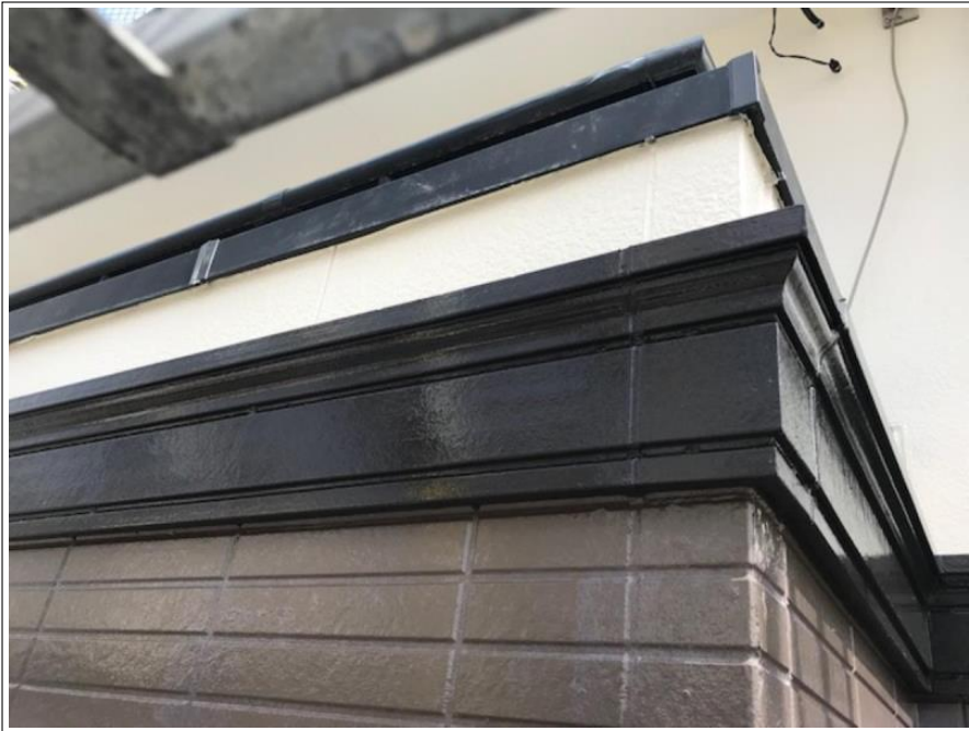
帯 上塗り施工後
