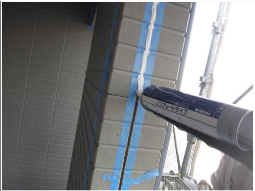
シーリング打替え 充填
