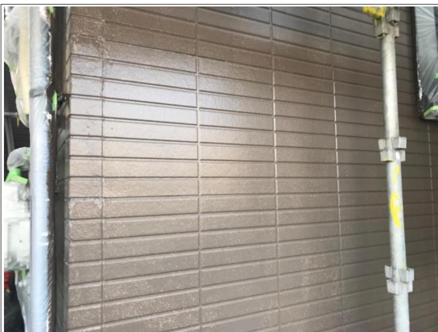
外壁 中塗り施工後
