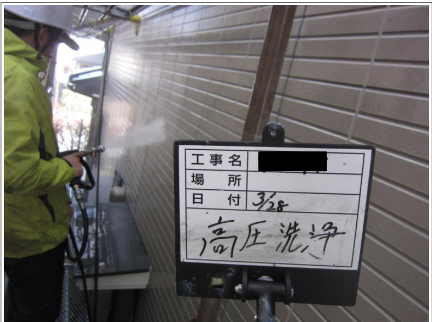
外壁 高圧洗浄中
