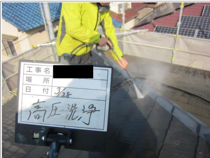
屋根 高压洗浄中
