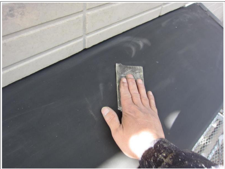
小庇 ケレン処理
