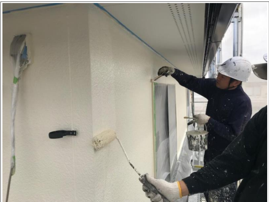
外壁 上塗り施工中
