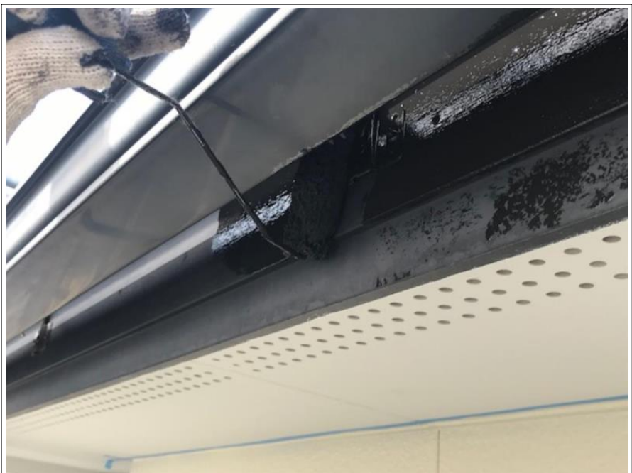
樋 上塗り（2回目）施工中
