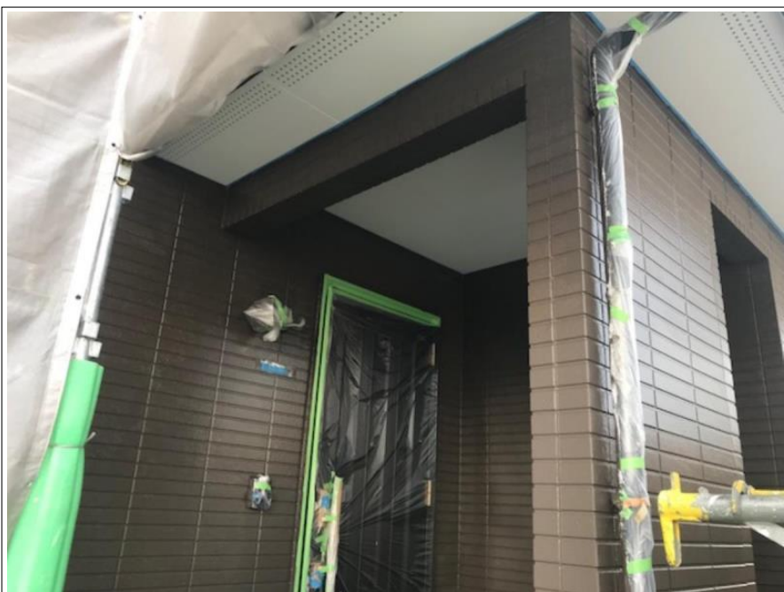
外壁 中塗り施工後
