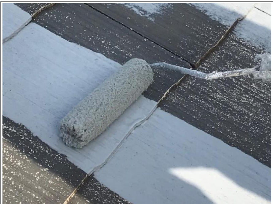
屋根 下塗り施工中
