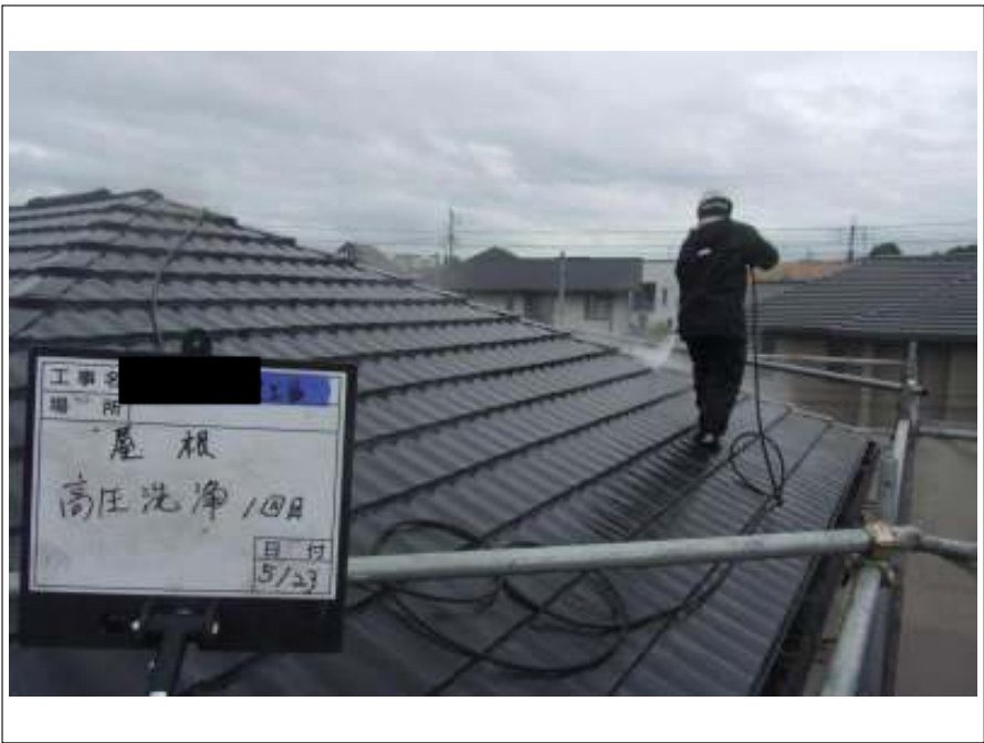
屋根 高圧洗浄中 (1回目)
