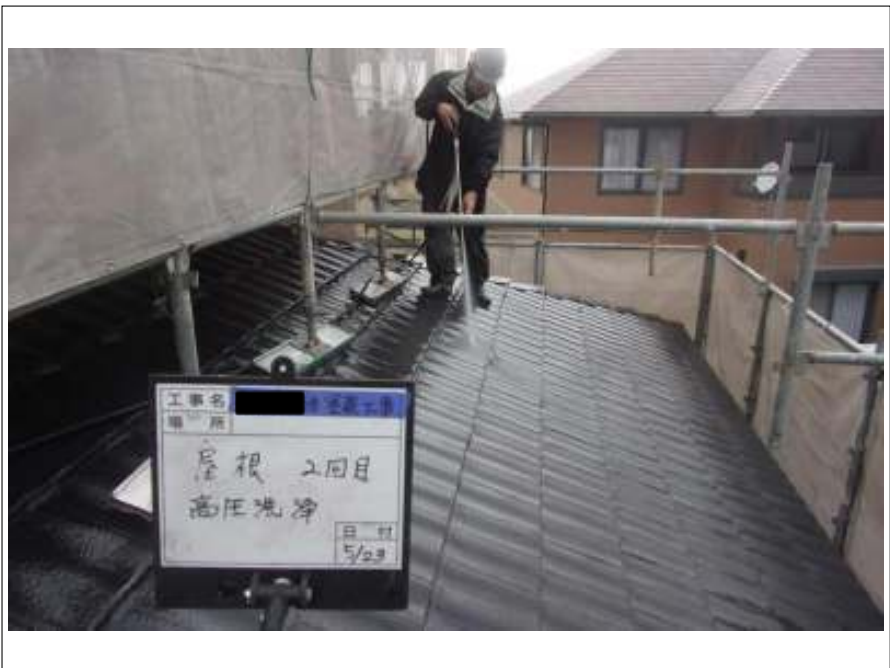
屋根 高圧洗浄中 (2回目)
