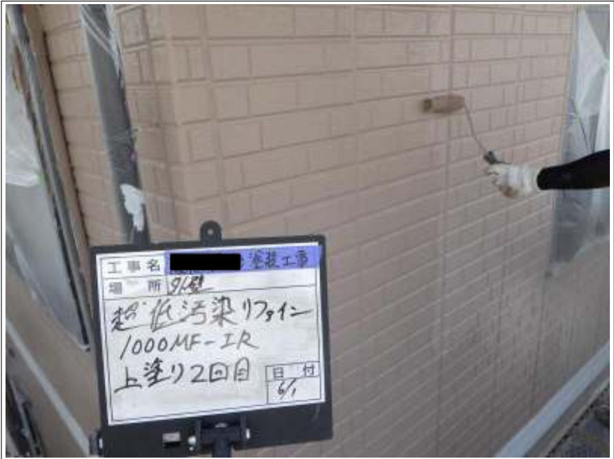
外壁 上塗り施工中
