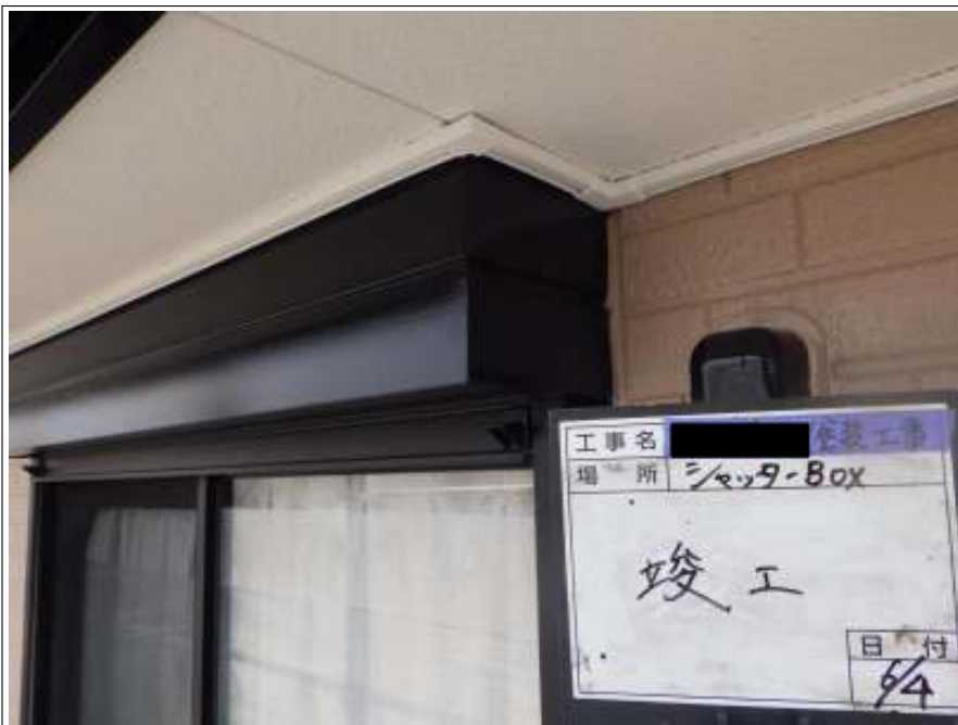
シャッターBOX 施工完了
