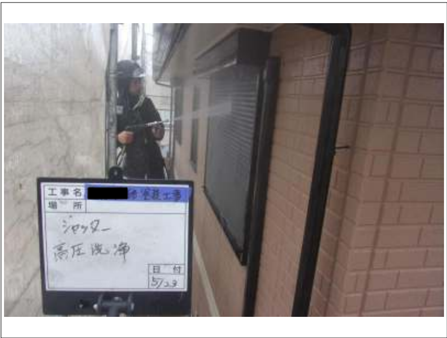
シャッター高圧洗浄中
