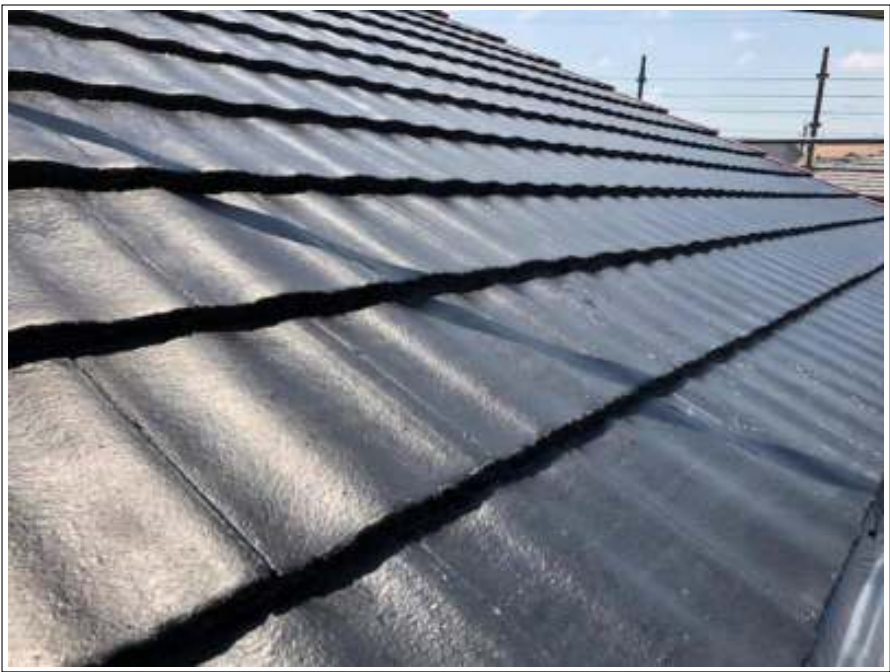
屋根 下塗り 施工完了
