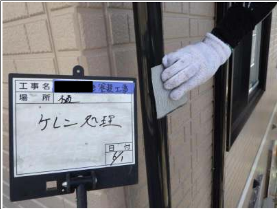
樋 ケレン処理
