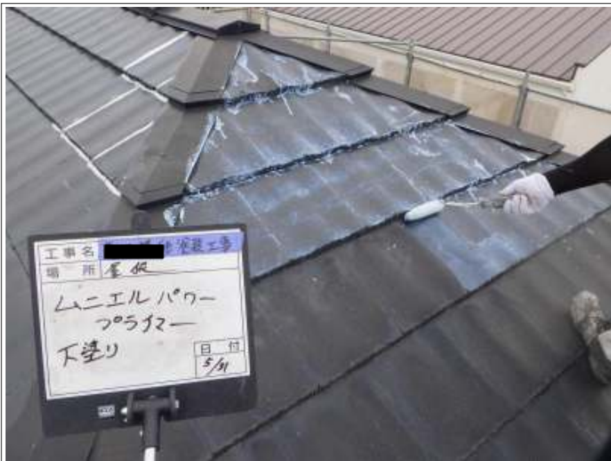
屋根 下塗り（1回目）施工中
