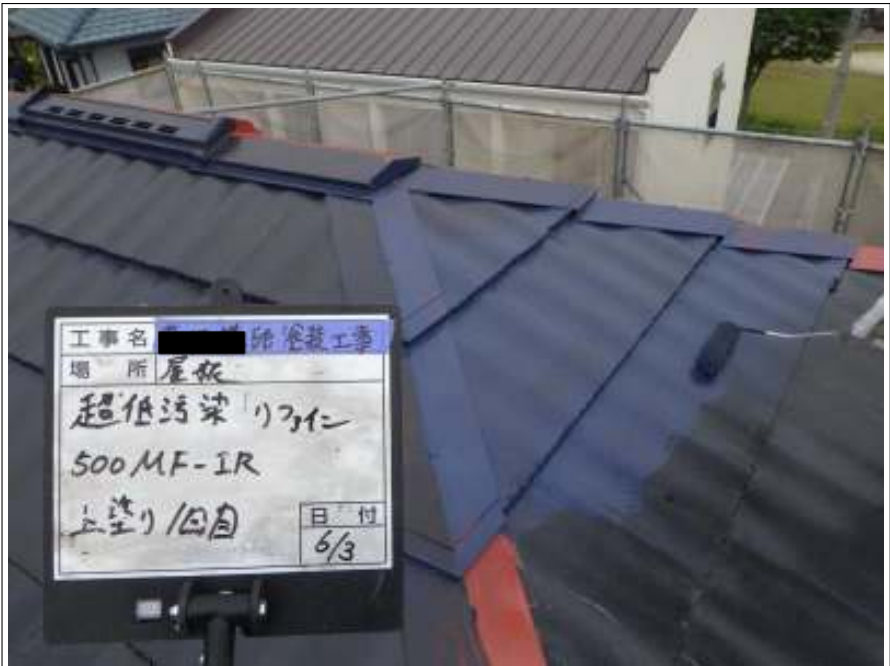
屋根 中塗り施工中
