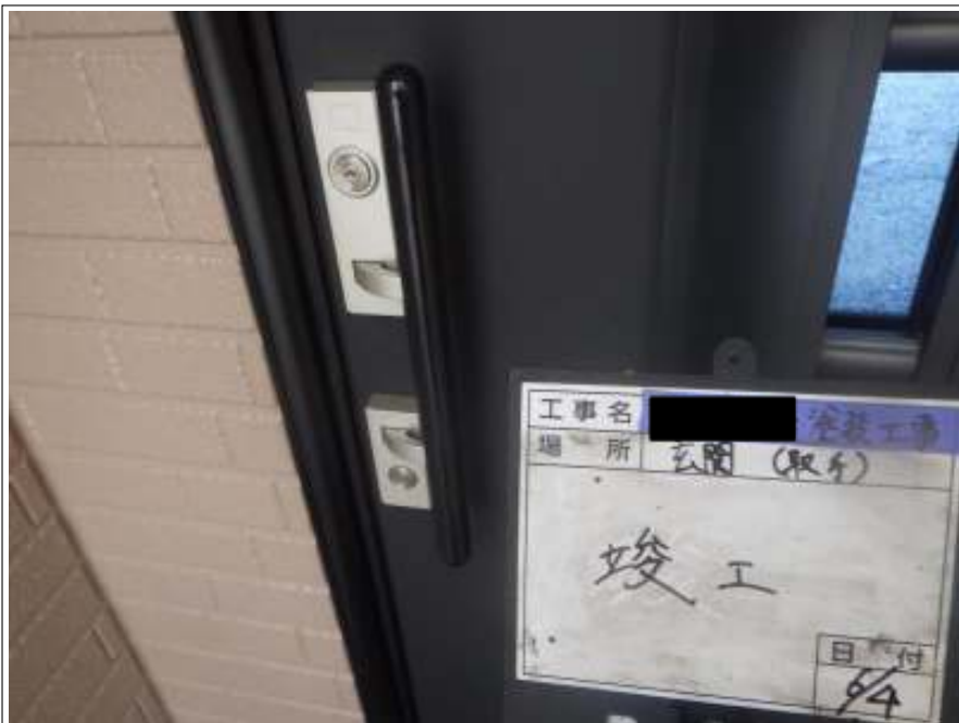
玄関取手 施工完了
