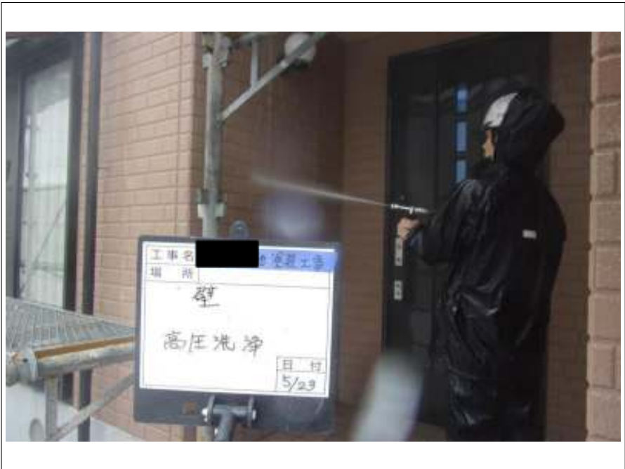
外壁 高压洗浄中
