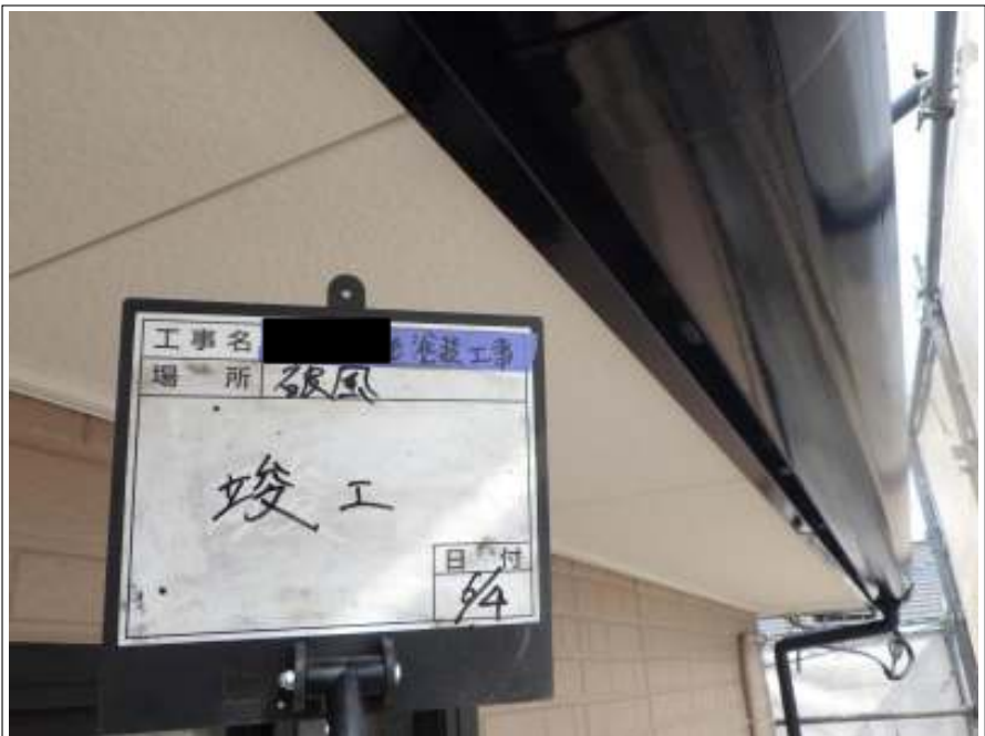
破風板 施工完了
