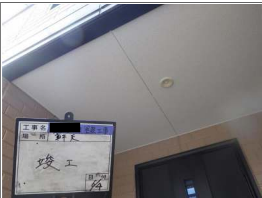
軒天 施工完了
