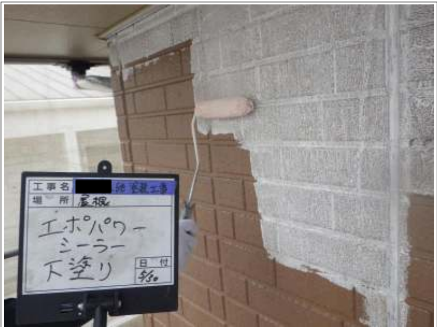
外壁 下塗り施工中
