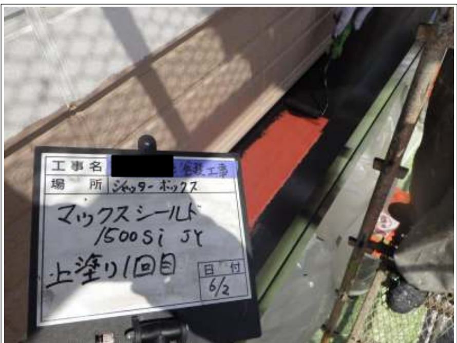
シャッターBOX 上塗り(1回目) 施工中
