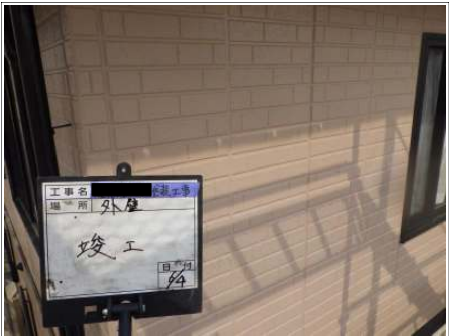
外壁 施工完了
