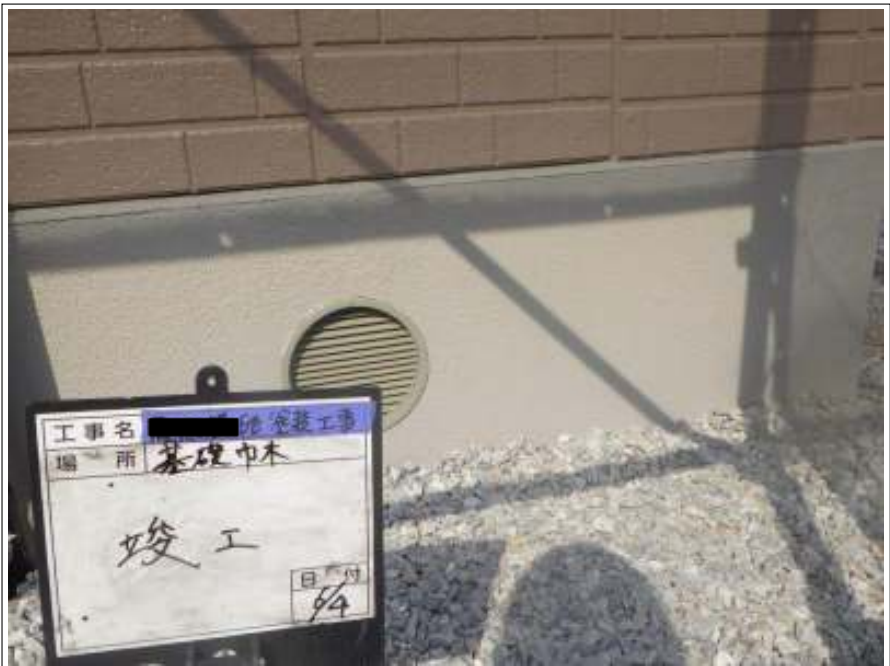
基礎 施工完了
