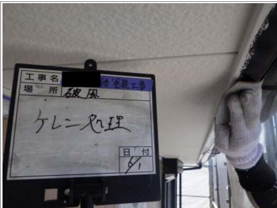
破風板 ケレン処理
