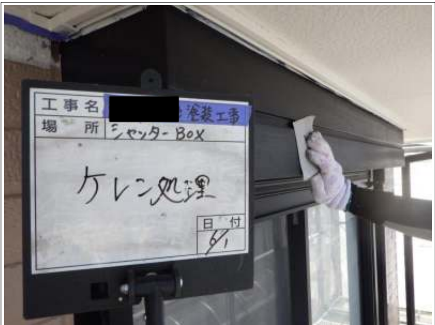
シャッターBOX ケレン処理
