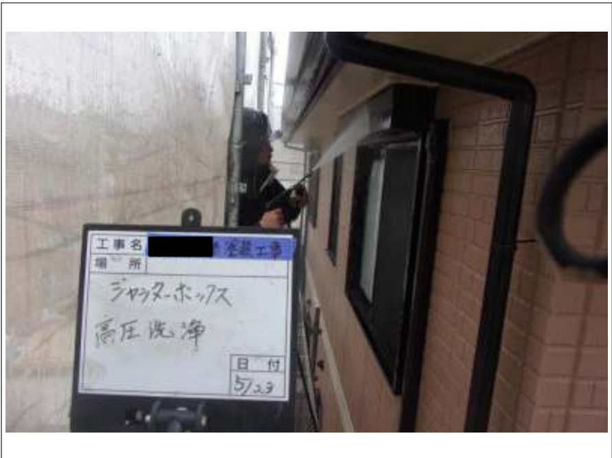
シャッターボックス高圧洗浄中
