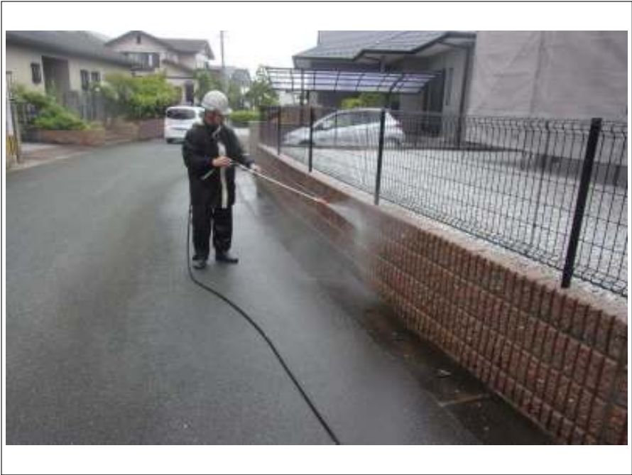
塀 高圧洗浄中
