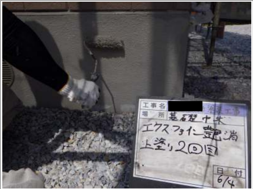
基礎 上塗り（2回目）施工中
