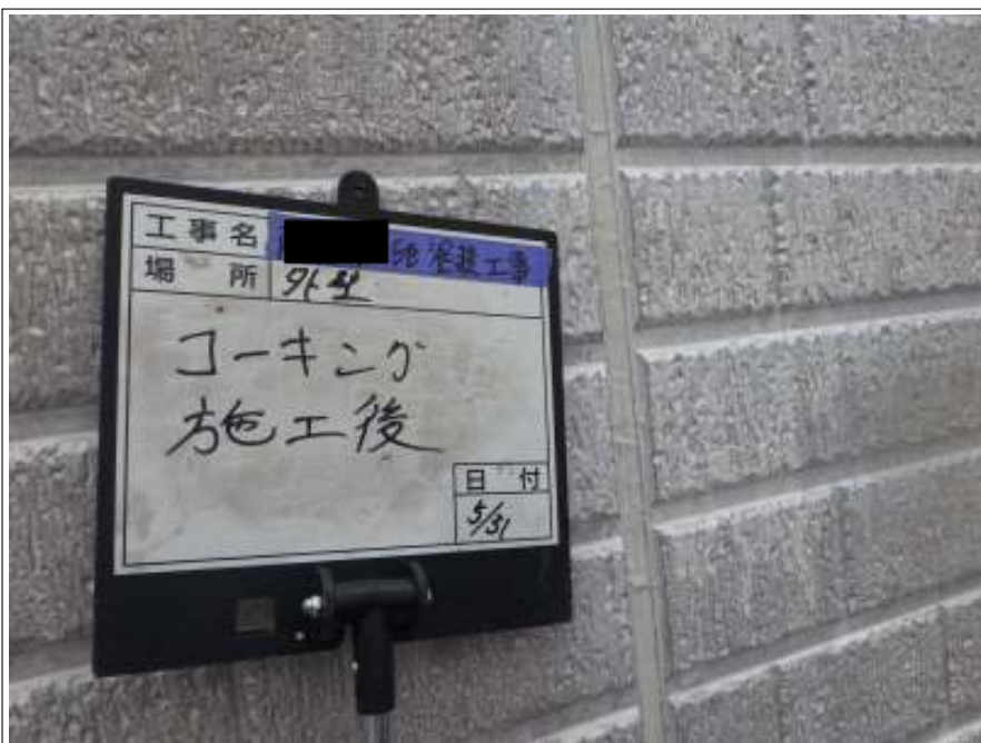
コーキング 施工完了
