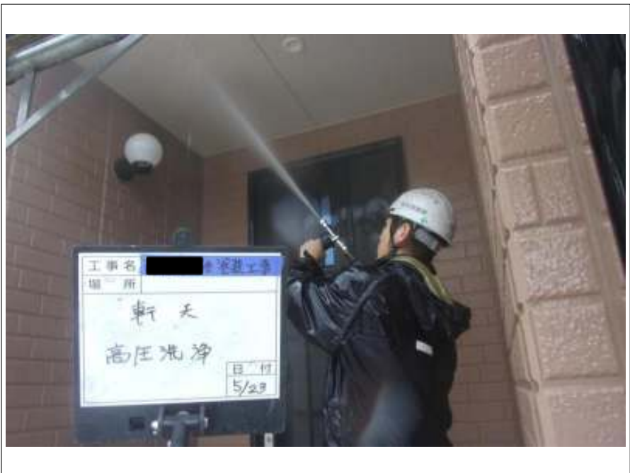
軒天 高压洗浄中
