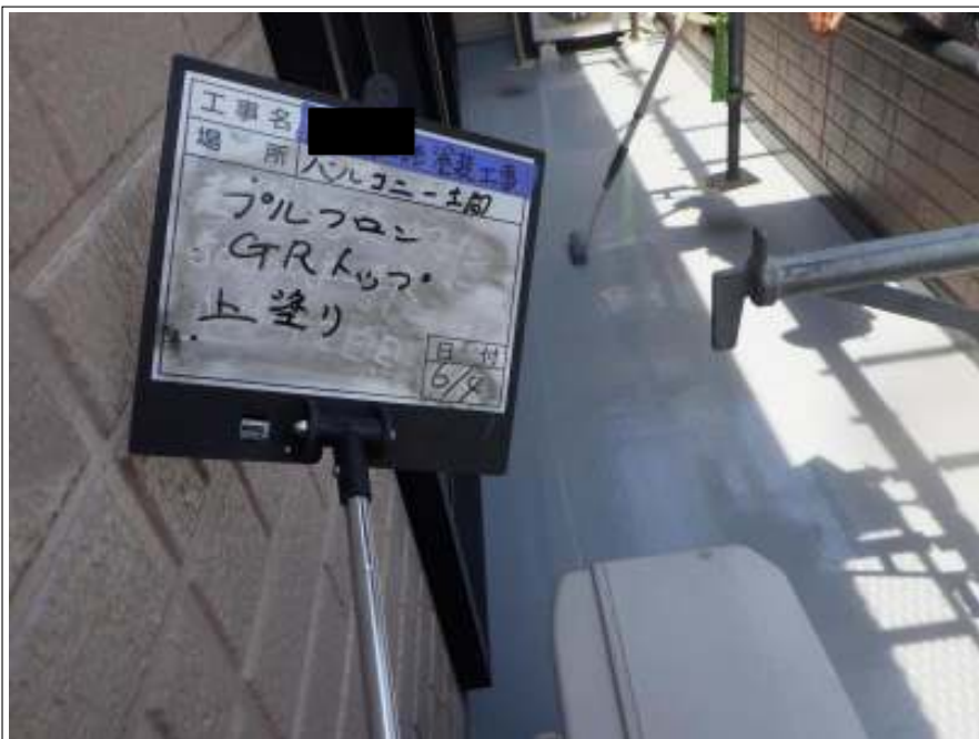
バルコニー土間 上塗り施工中
