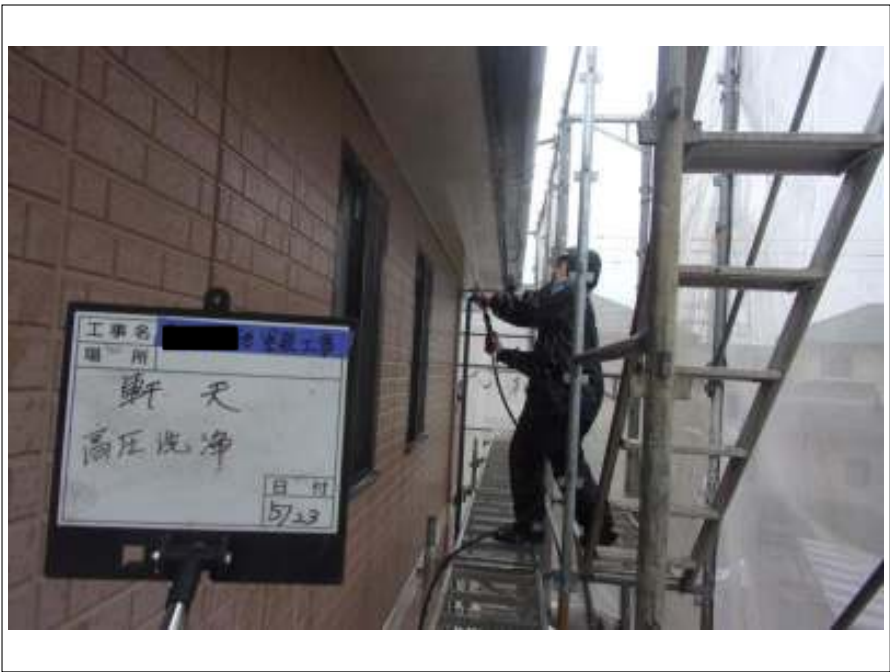
軒天 高圧洗浄中
