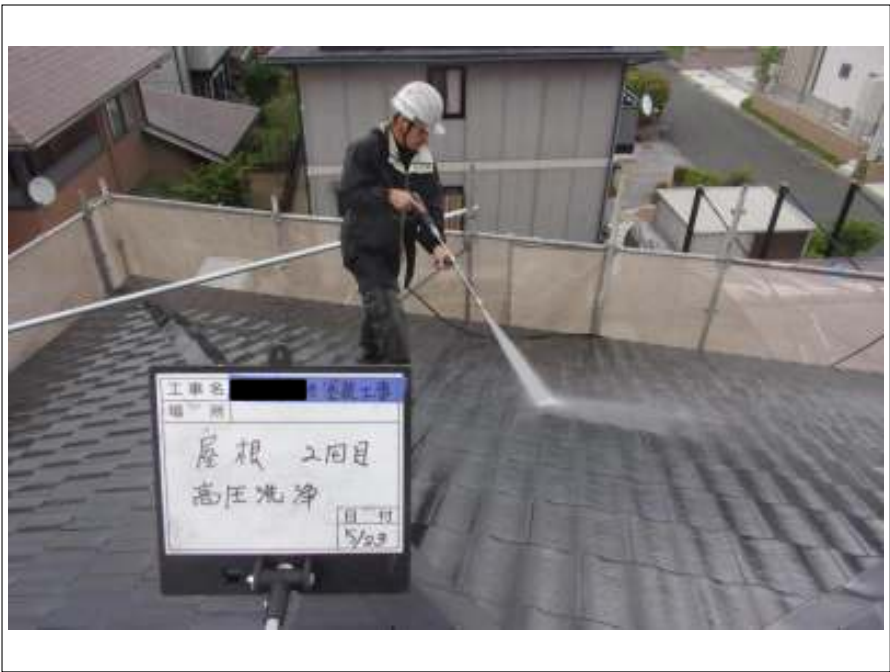
屋根 高压洗浄中 (2回目)
