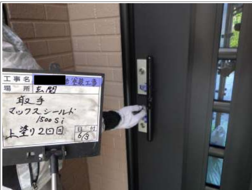
玄関取手 上塗り (2回目) 施工中
