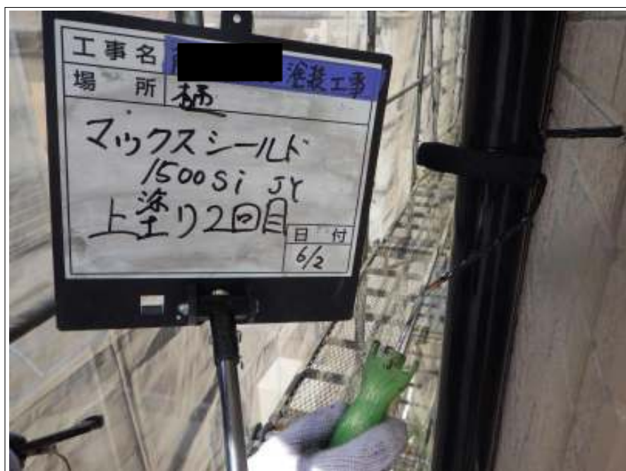
樋 上塗り (2回目) 施工中
