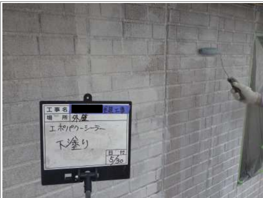
外壁 下塗り施工中
