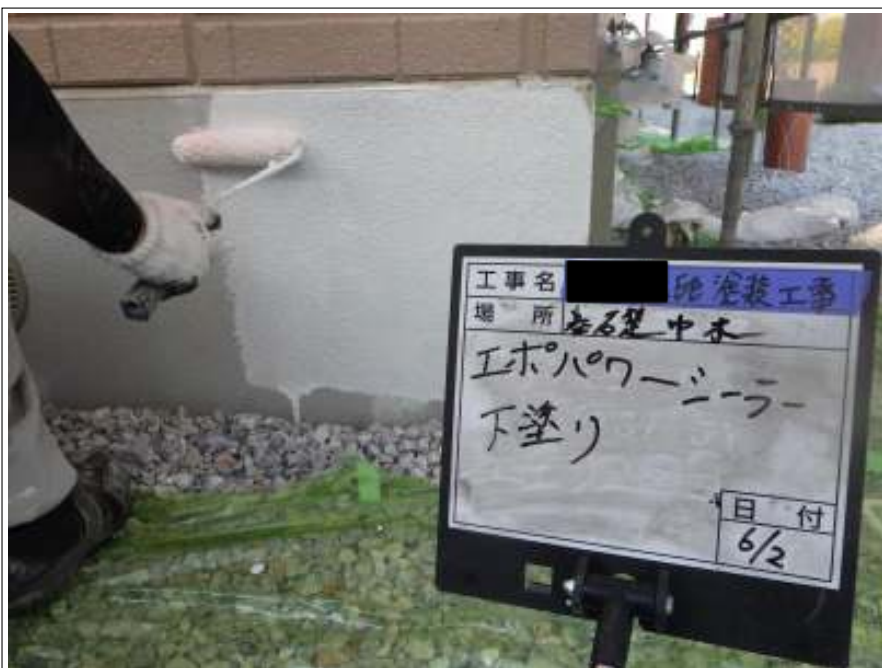
基礎 下塗り施工中
