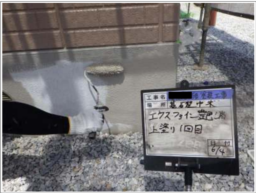
基礎 上塗り（1回目）施工中
