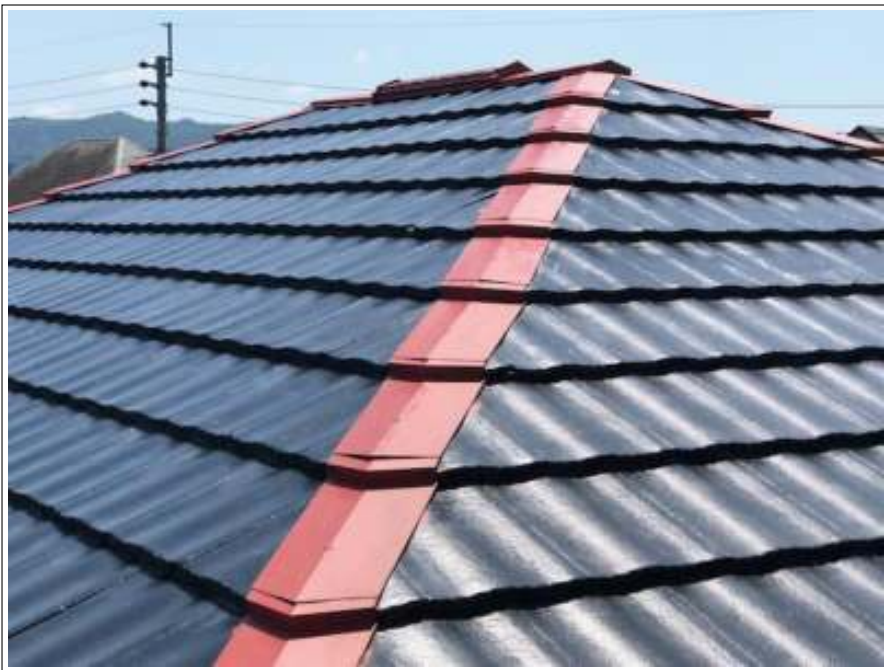
屋根 サビ止め 施工完了
