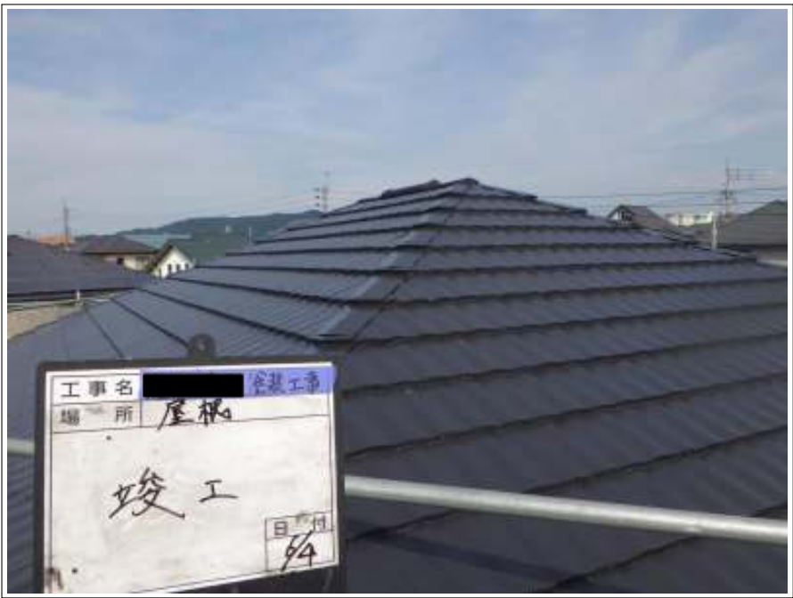
屋根 施工完了
