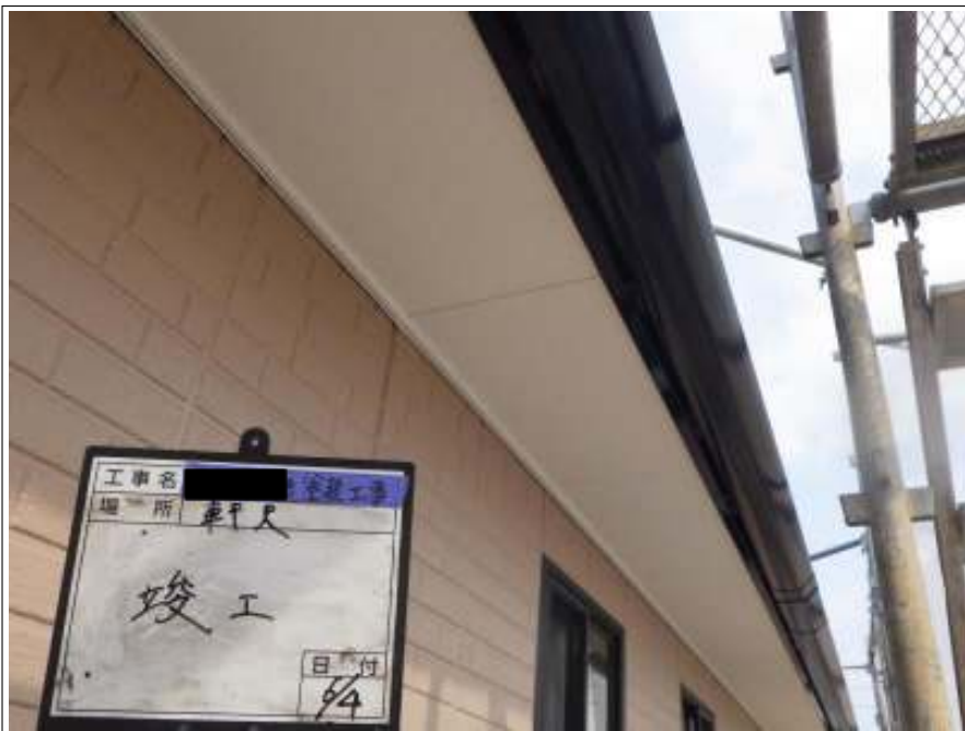
軒天 施工完了
