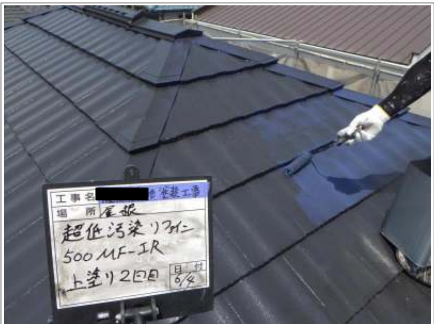
屋根 上塗り施工中
