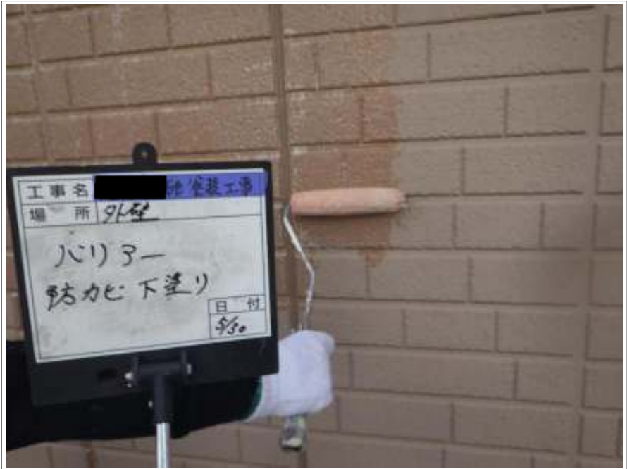
外壁 バリアー塗布
