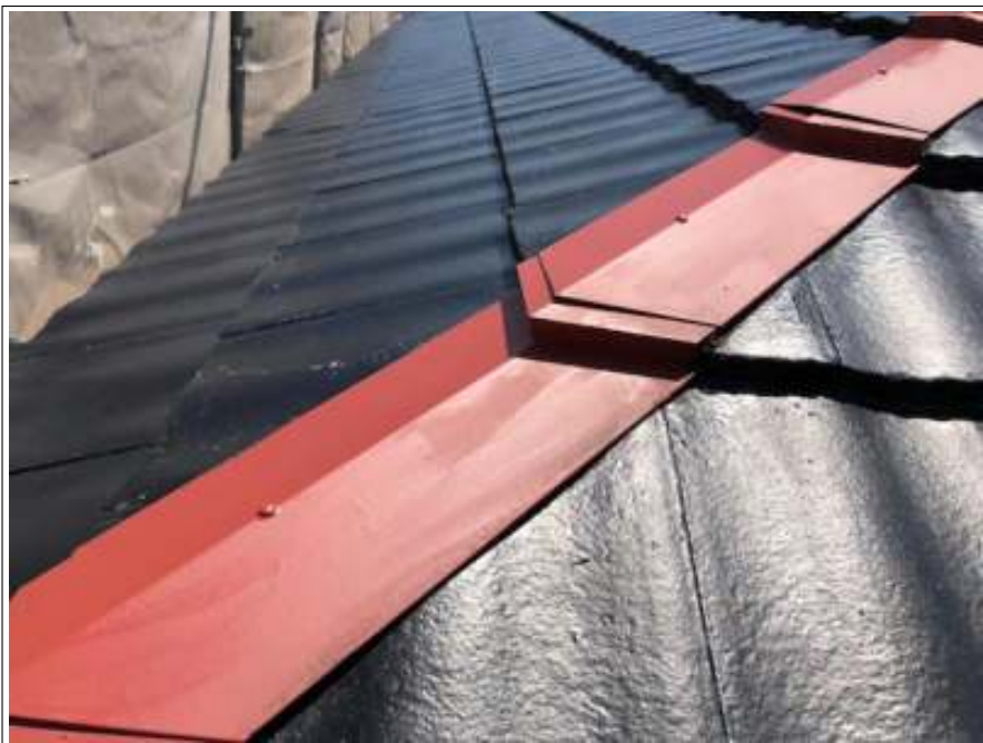
屋根 サビ止め 施工完了
