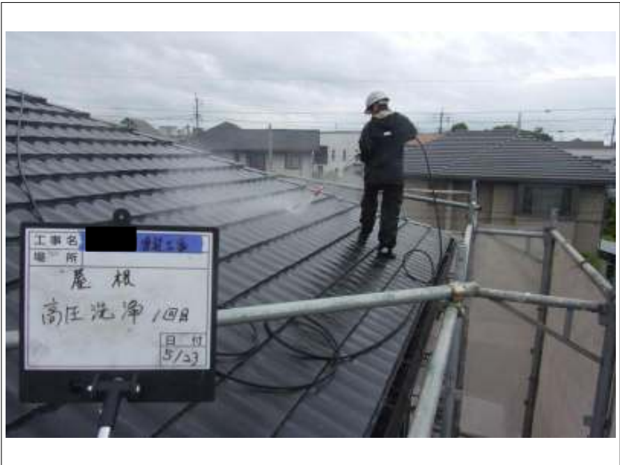
屋根 高圧洗浄中 (1回目)
