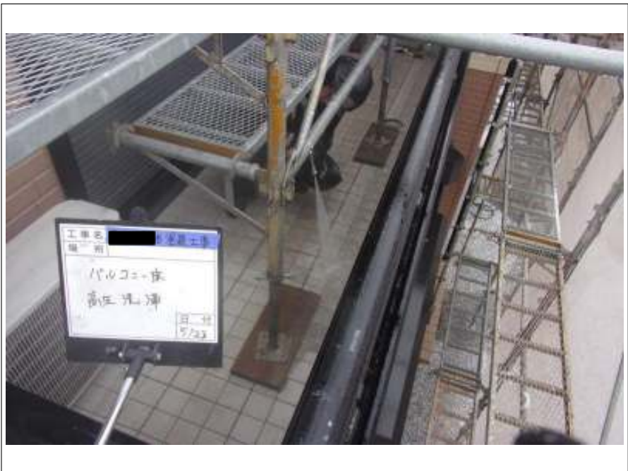
バルコニー床 高圧洗浄中
