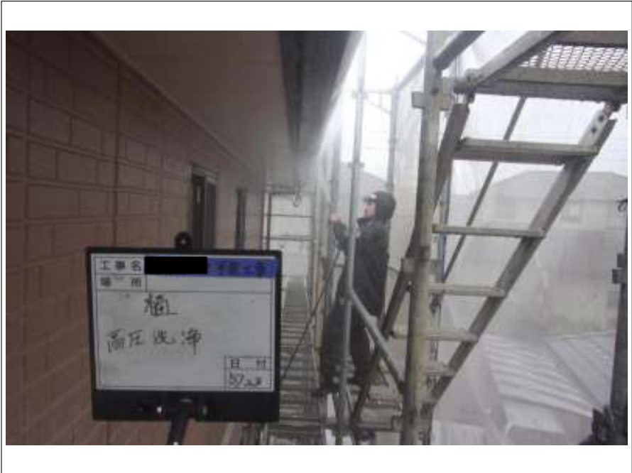
樋 高圧洗浄中
