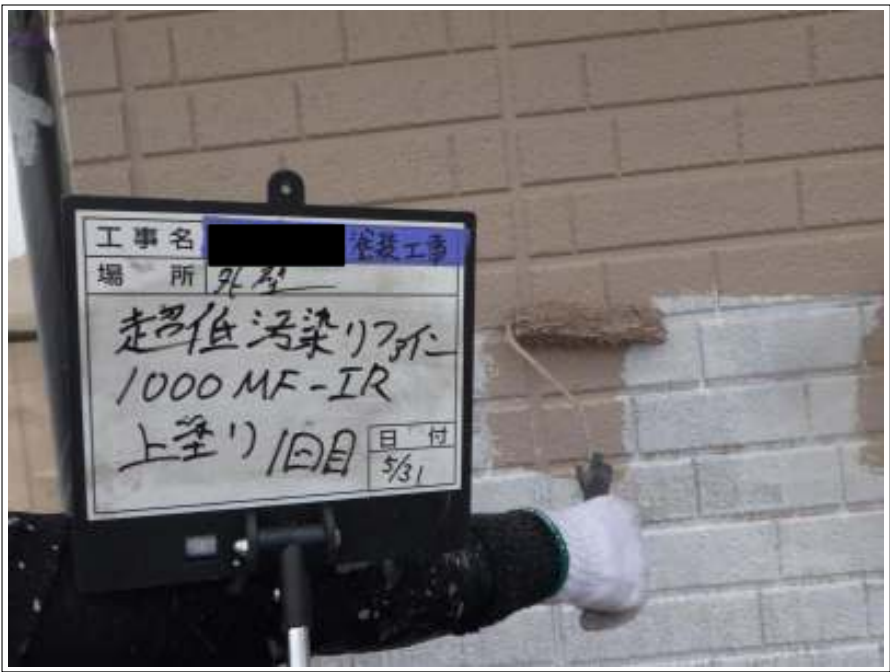
外壁 中塗り施工中
