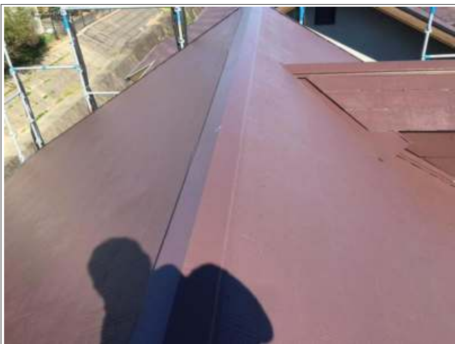
屋根 上塗り施工中
