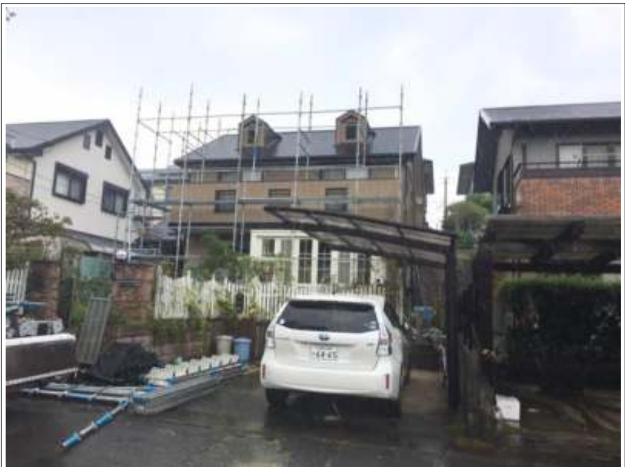
仮設足場組立
