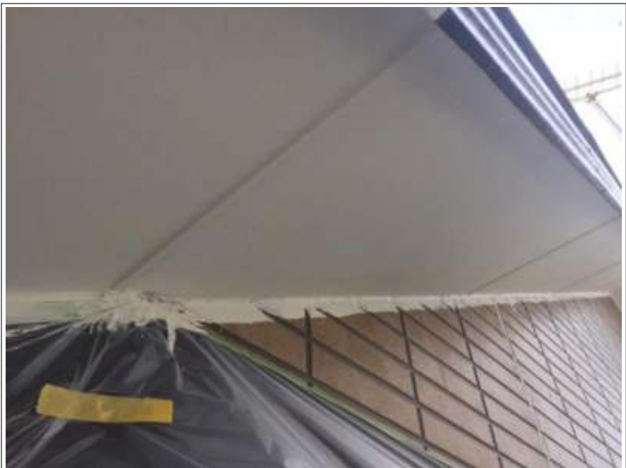
軒天 上塗り施工後
