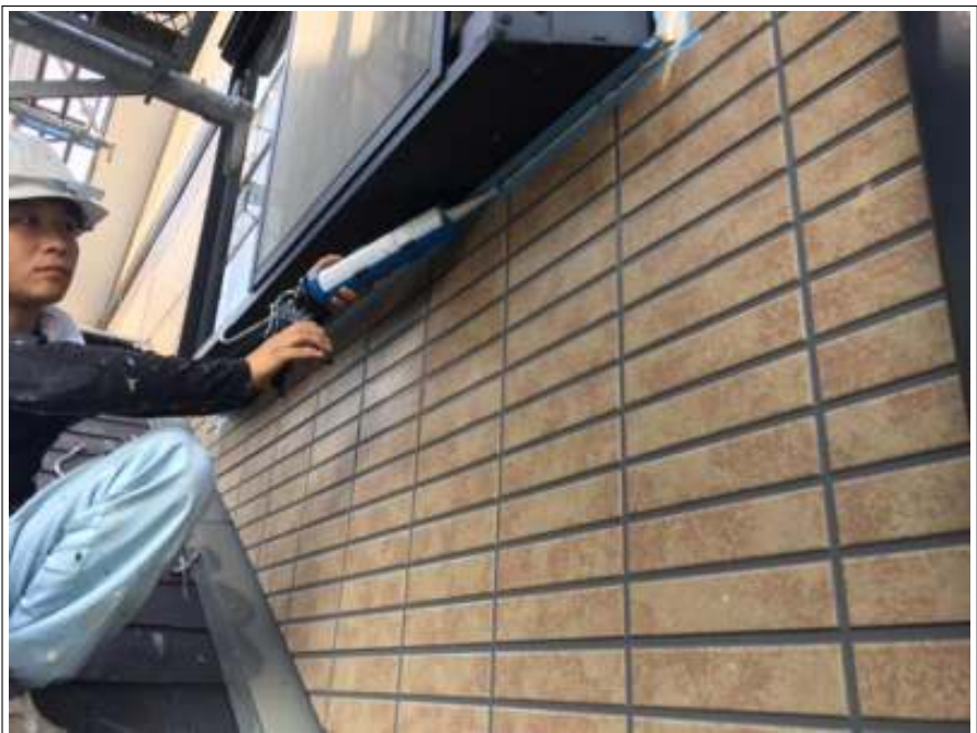
シーリング打ち増し 施工中
