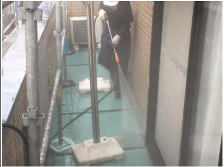
ベランダ 高圧洗浄中
