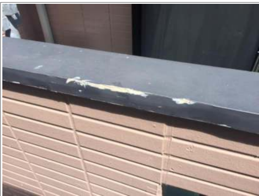
笠木補修 施工後
