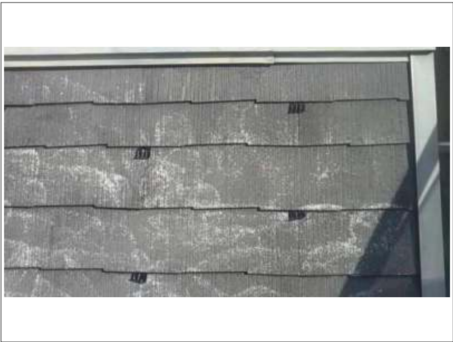
屋根 タスペーサー取付
