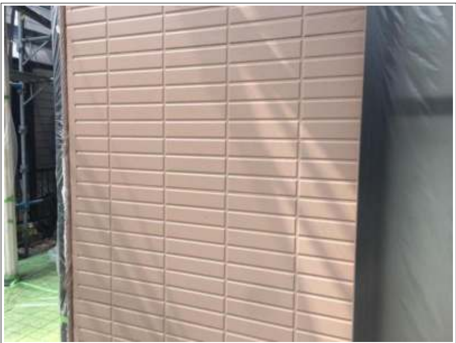
外壁 上塗り施工後
