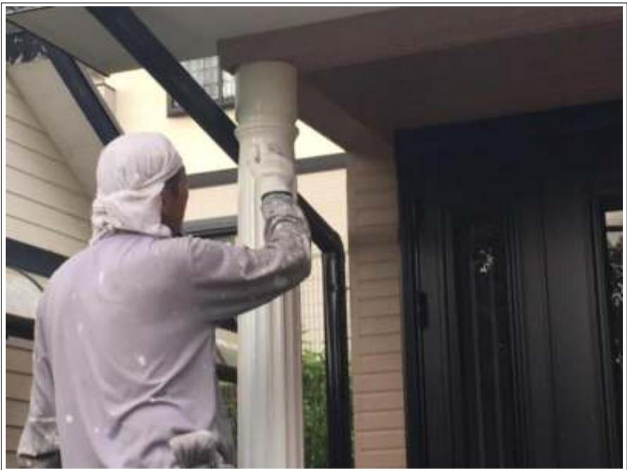
玄関柱 上塗り施工中
