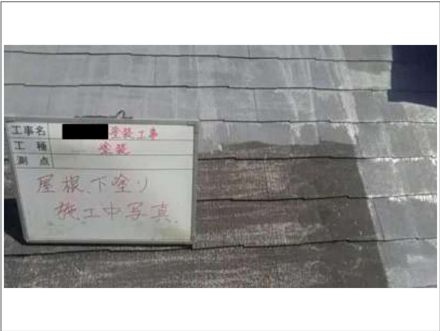
屋根 下塗り施工中
