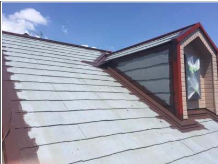
屋根 中塗り施工中
