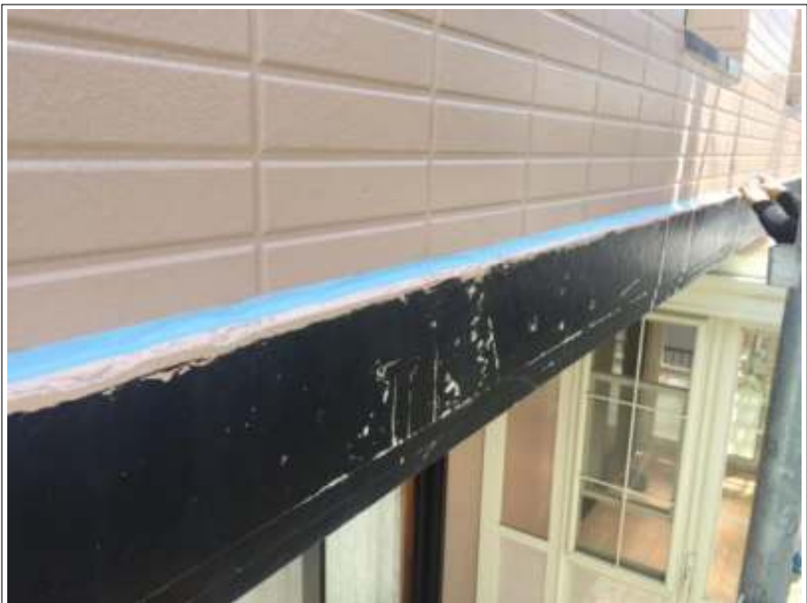
帯塗装 施工中
