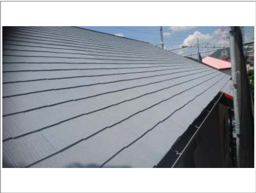
屋根 下塗り施工後
