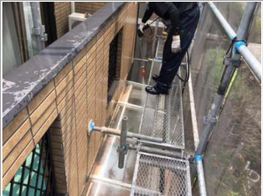
外壁 高圧洗浄中
