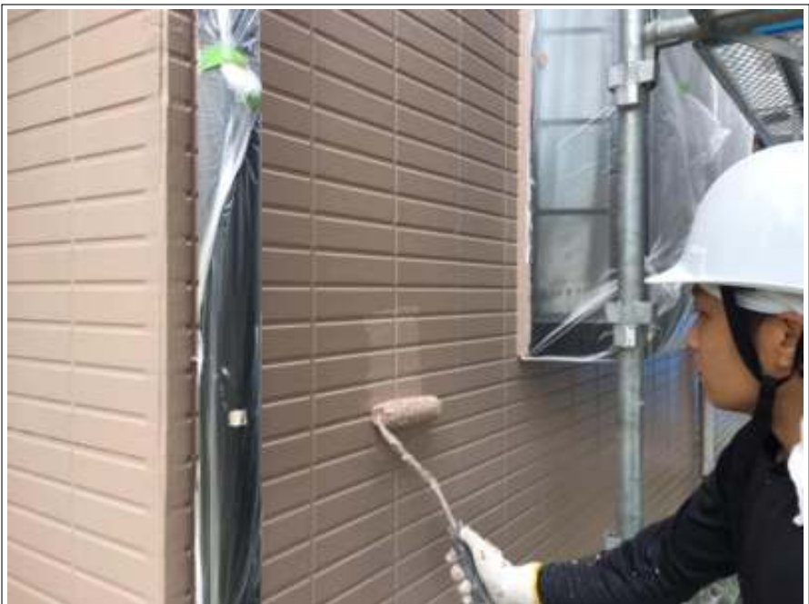
外壁 上塗り施工中
