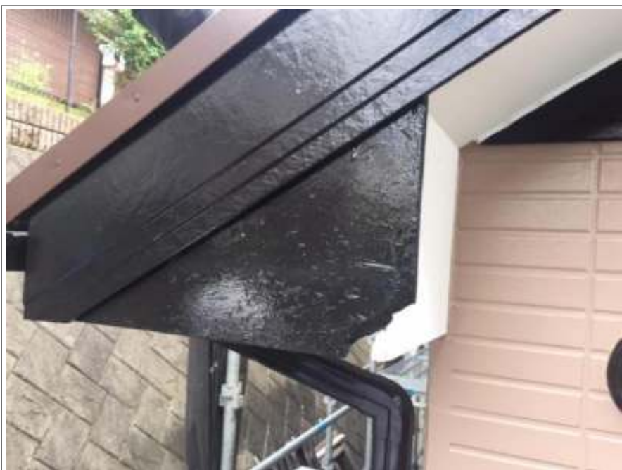
破風板 施工後
