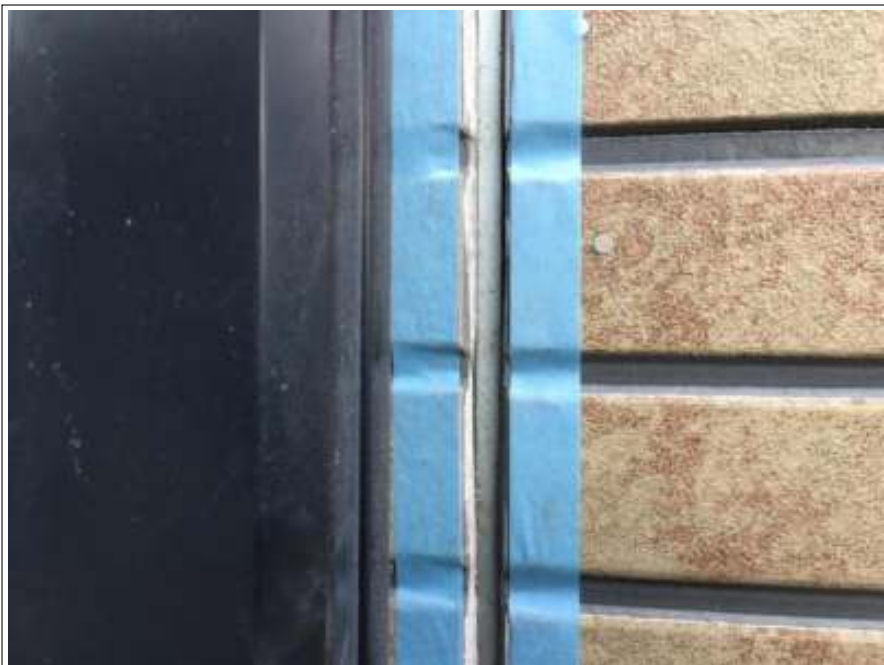
シーリング打ち替え 施工中
