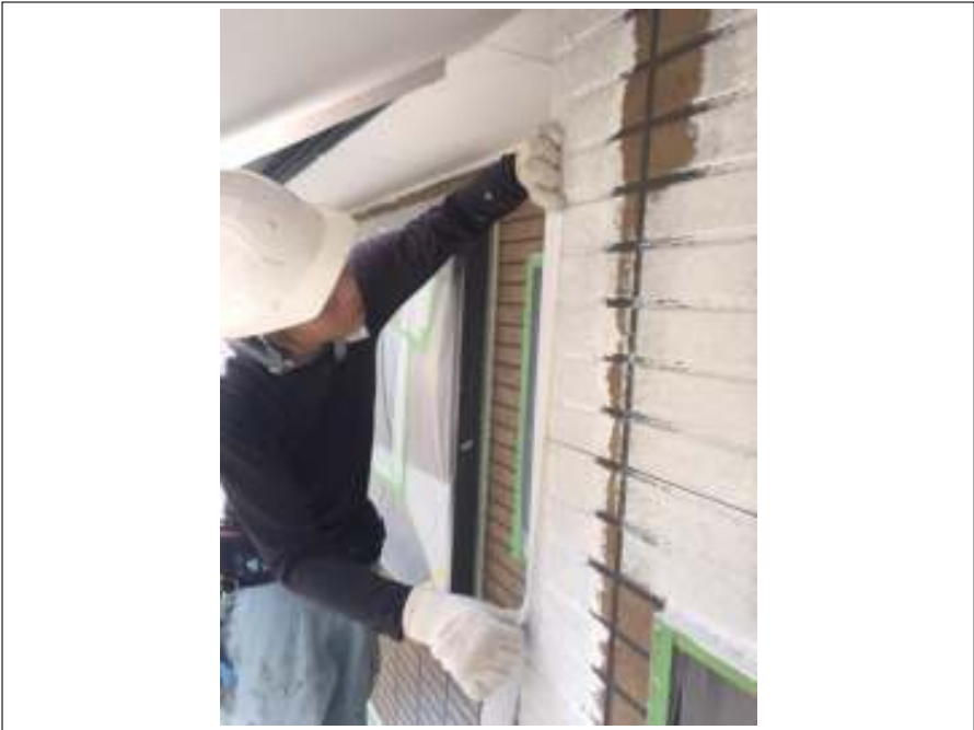
外壁 メッシュ補強施工
