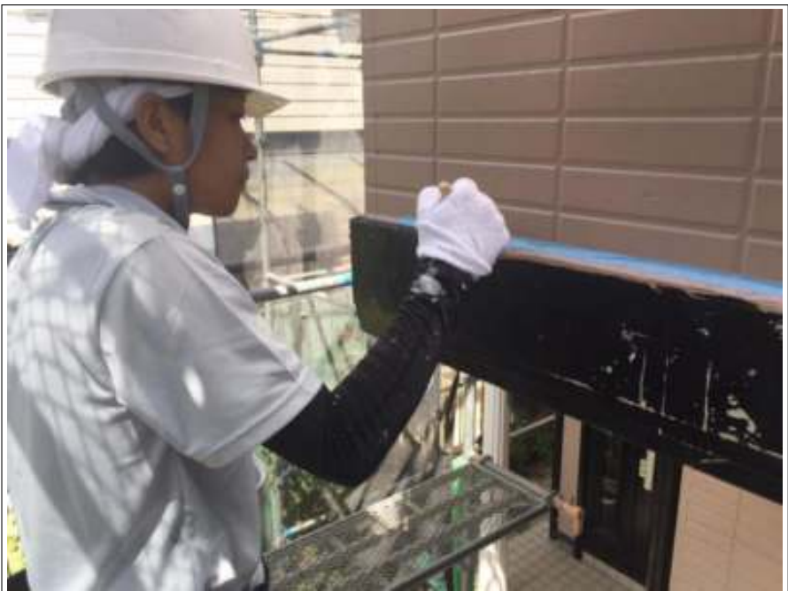
帯塗装 施工中
