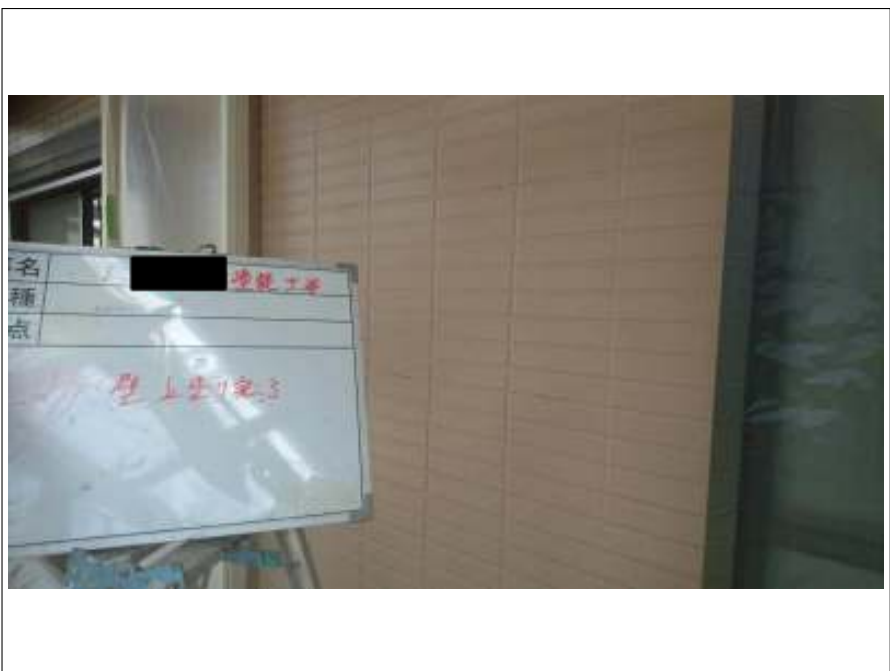
外壁 上塗り施工後
