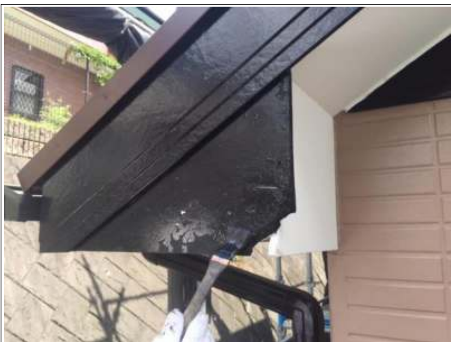
破風板 施工中
