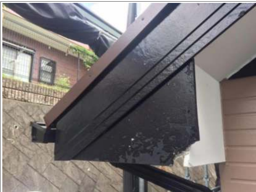
破風板 施工前
