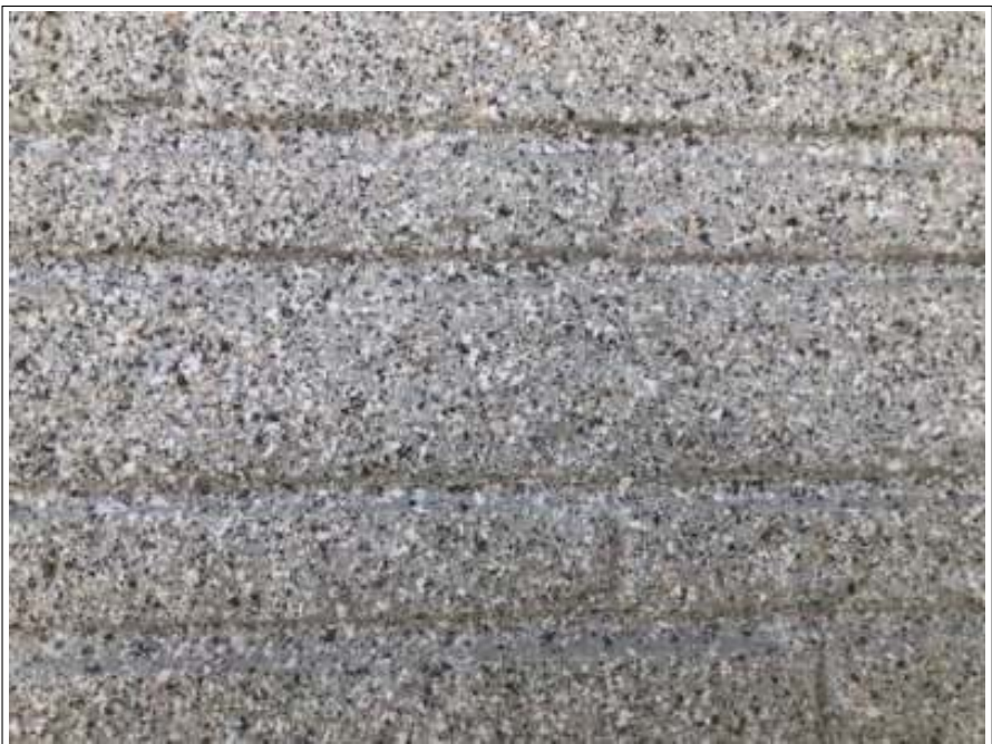
外壁 施工完了
