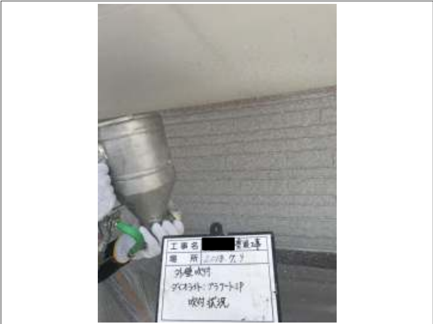
外壁 吹き付け
