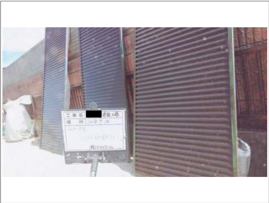
雨戸 施工完了
