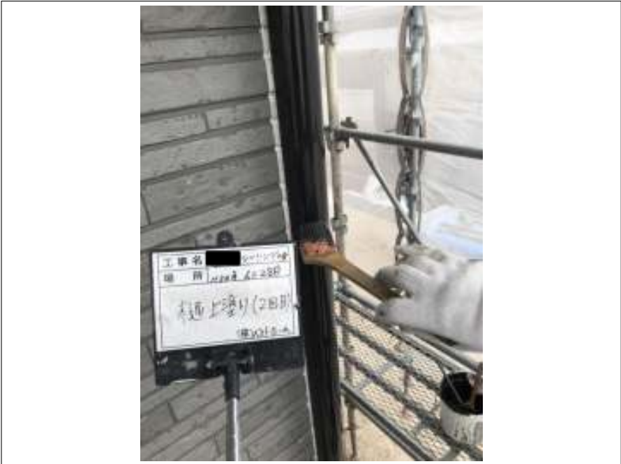
樋 上塗り2回目
