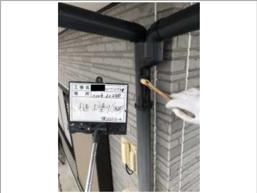
樋 上塗り1回目
