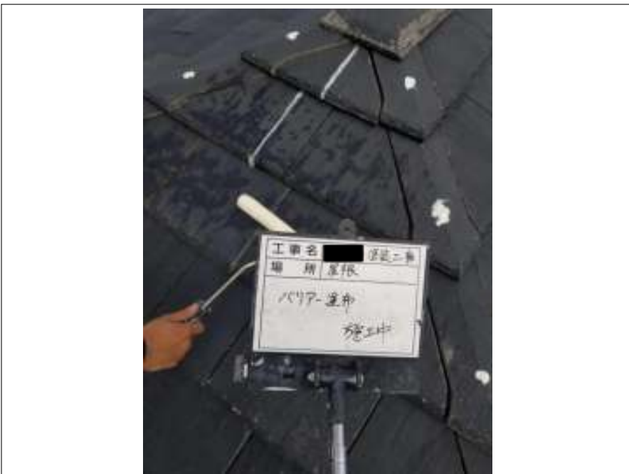
屋根 防カビ下塗 塗布
