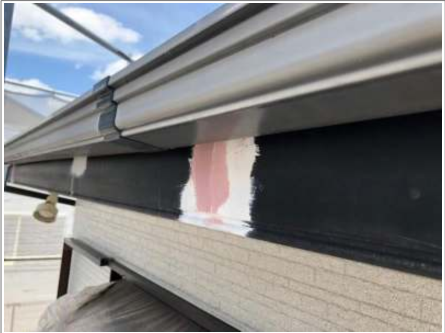
破風 下地補修
