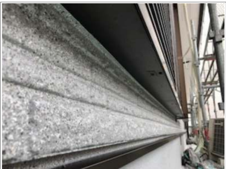
外壁 施工完了
