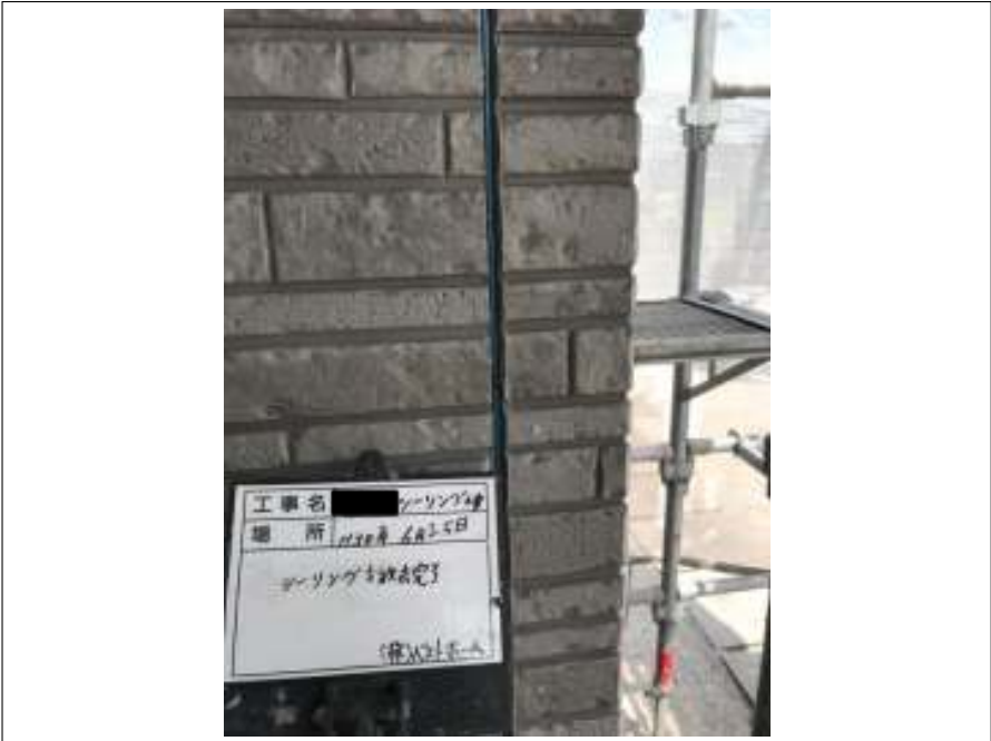
シーリング 撤去完了
