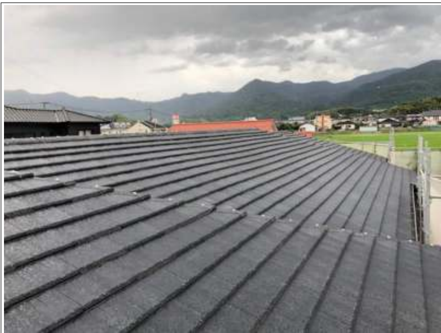
屋根 塗装施工前
