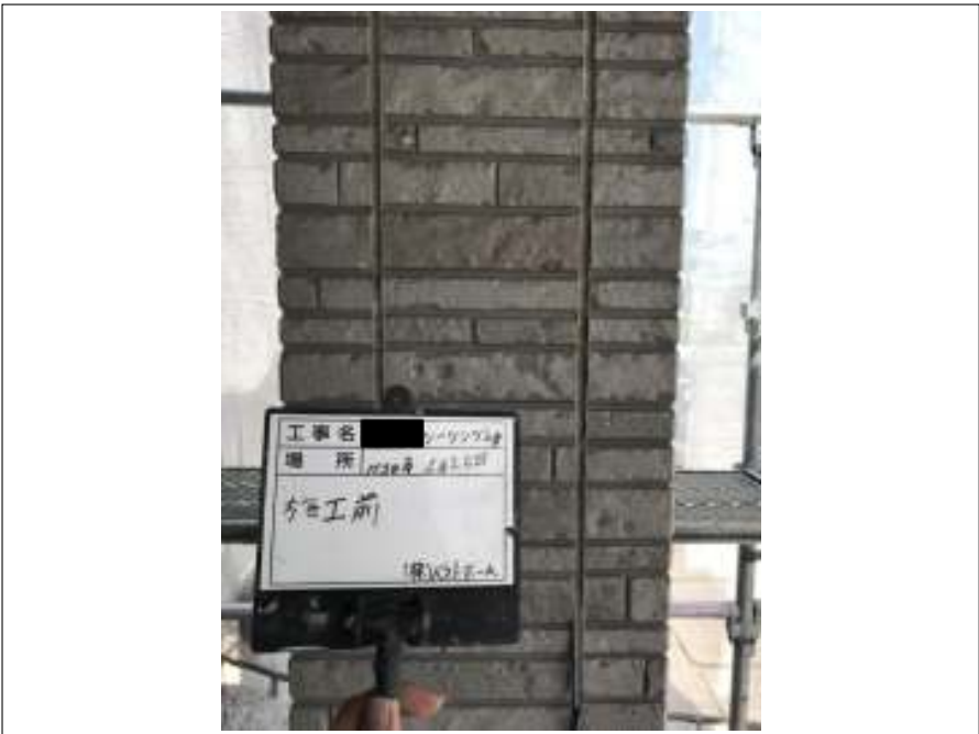
外壁 シーリング 施工前
