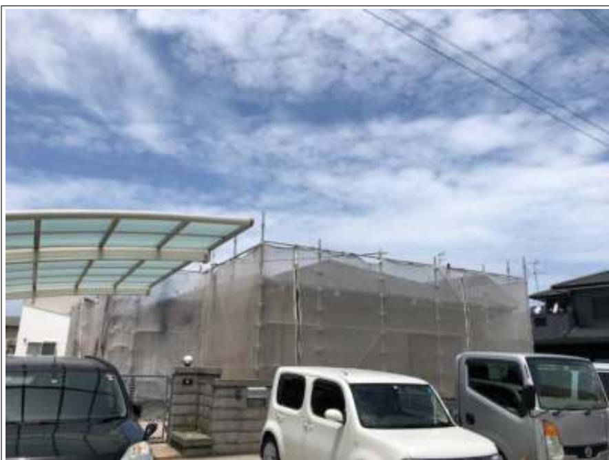
足場組立 完了
