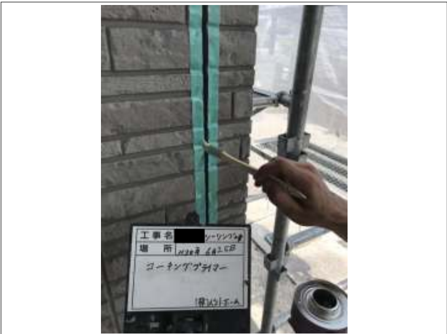
シーリング プライマー塗布
