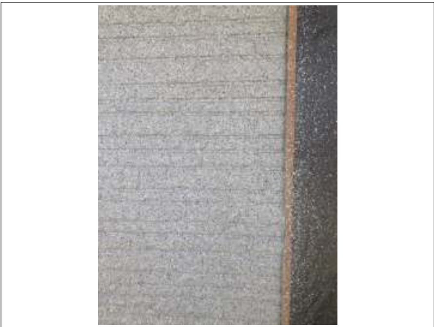
外壁 施工完了
