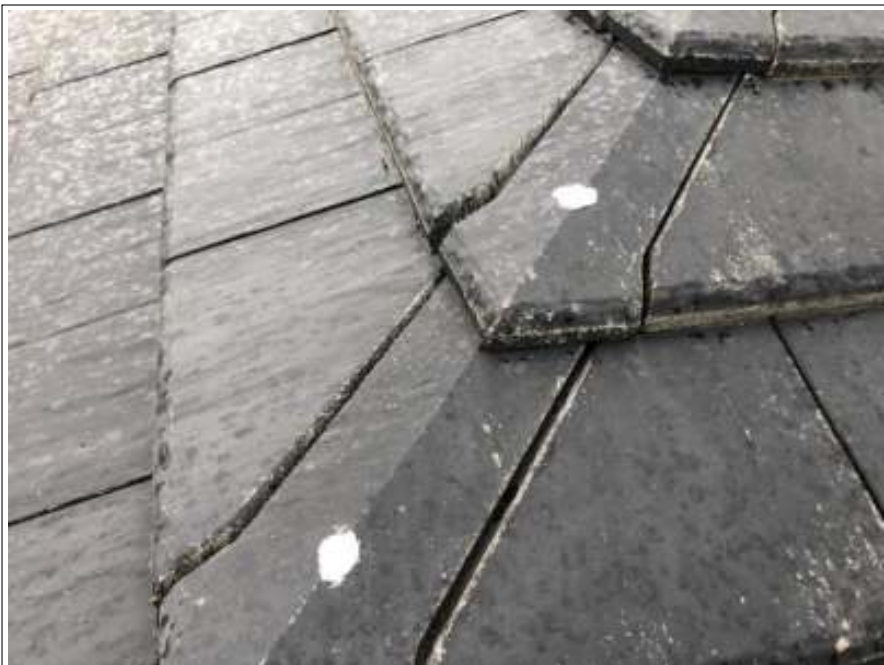
ビス止め シーリング補修後
