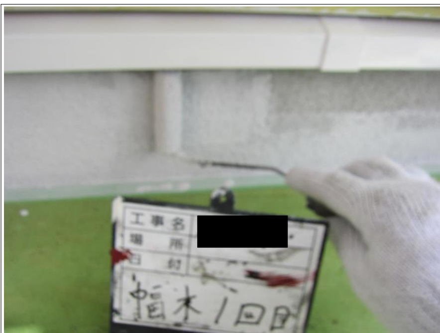
基礎幅木 塗装
