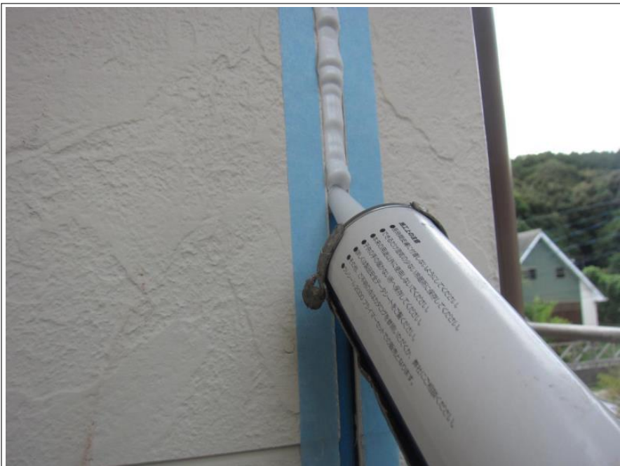
ボードシーリング打替え
