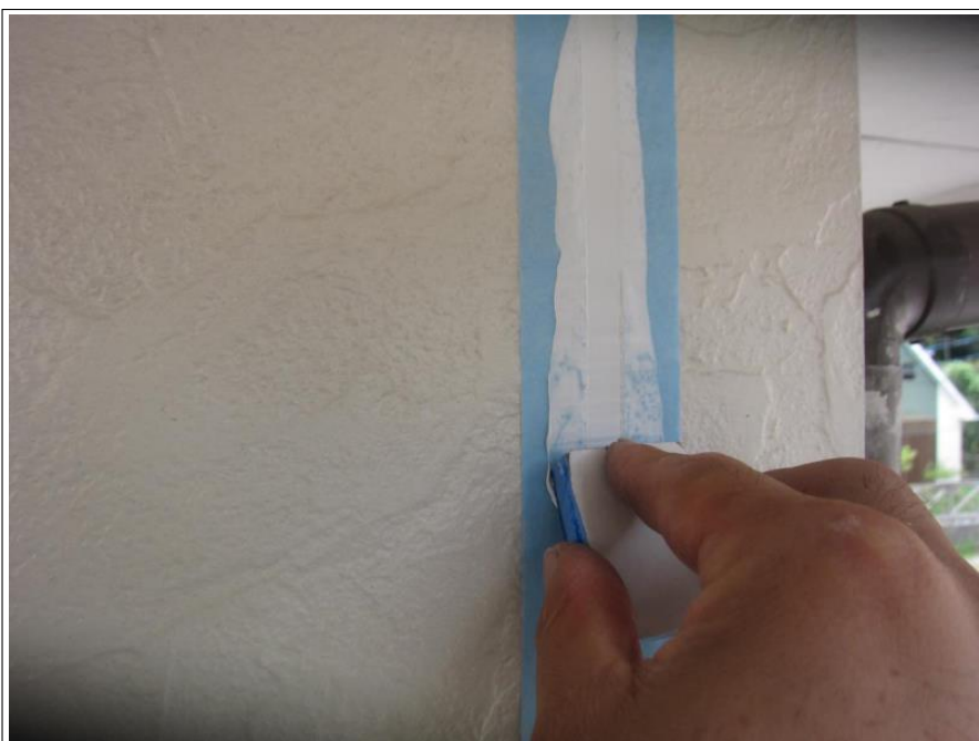
ボードシーリング打替え
