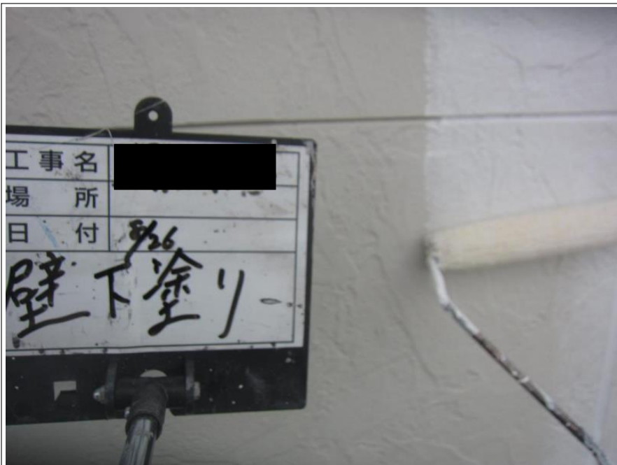
2階外壁 下塗り
