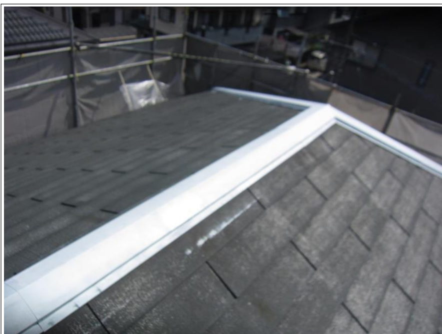
屋根板金部 サビ止め
