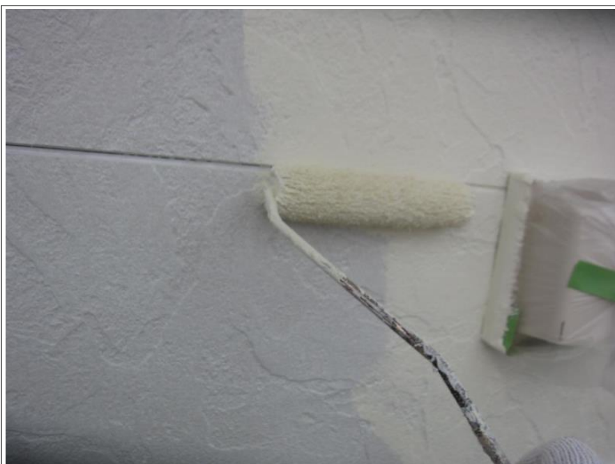
2階外壁 中塗り
