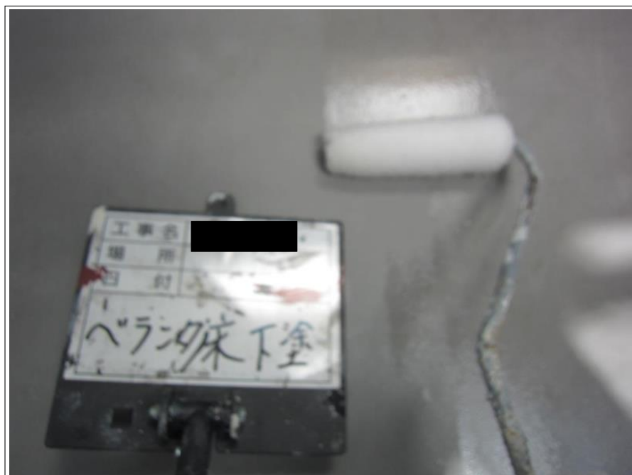
ベランダ床 下塗り
