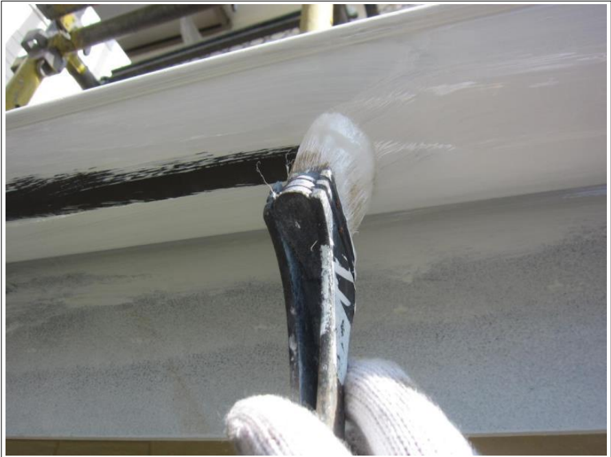
破風板・樋 塗装 1回目
