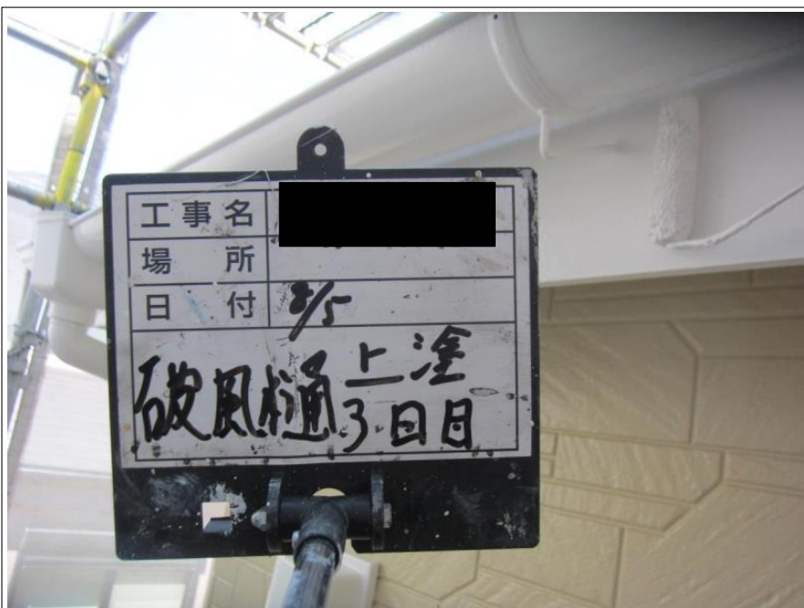
破風板・樋 塗装 3回目
