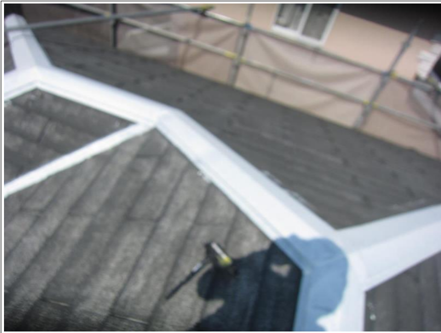
屋根板金部 サビ止め
