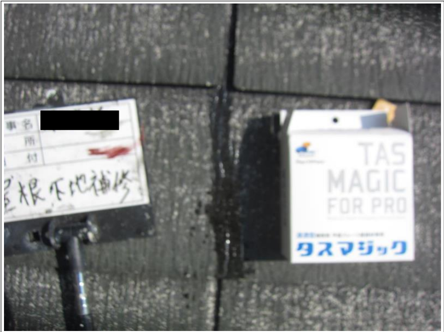
屋根 下地処理
