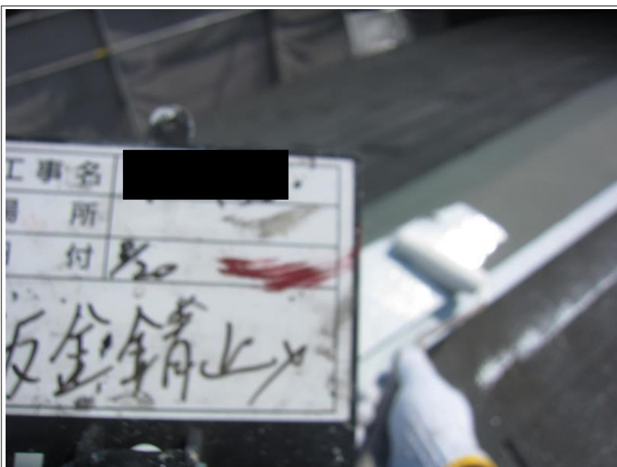
屋根板金部 サビ止め
