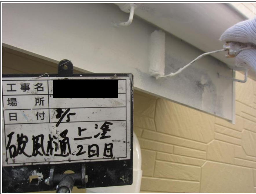
破風板・樋 塗装 2回目
