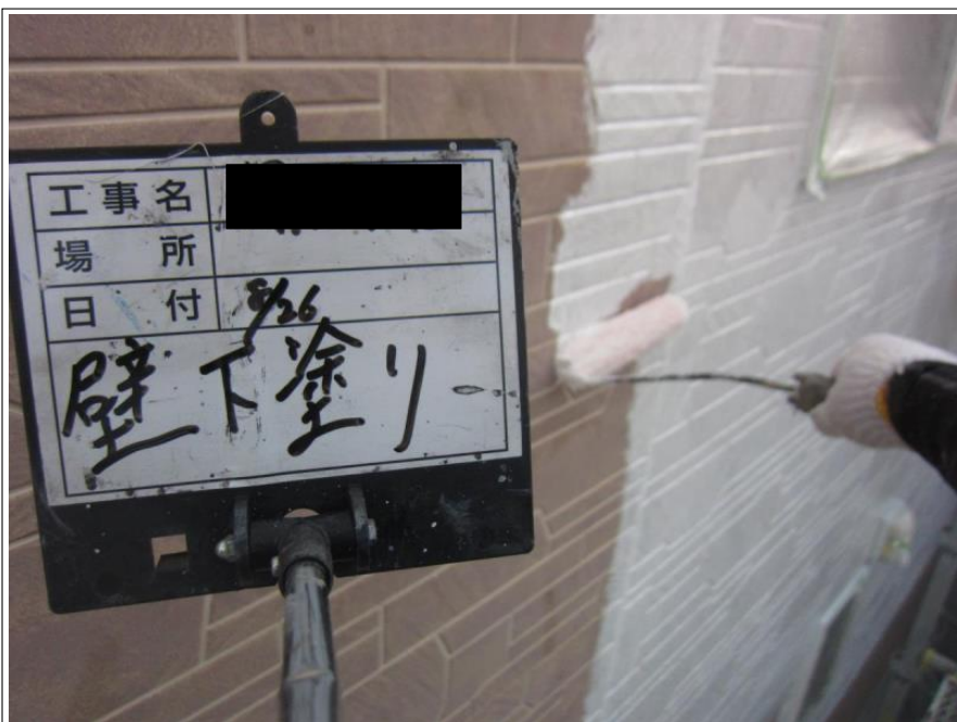
1階外壁 下塗り
