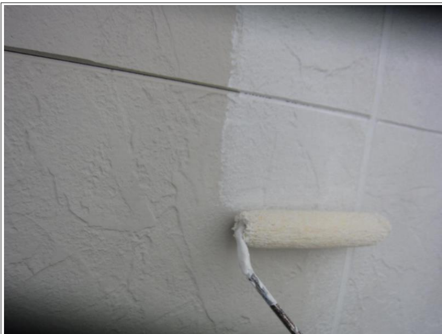
2階外壁 下塗り
