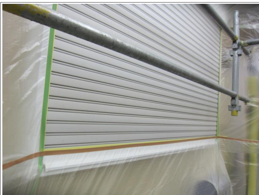
シャッター 施工完了
