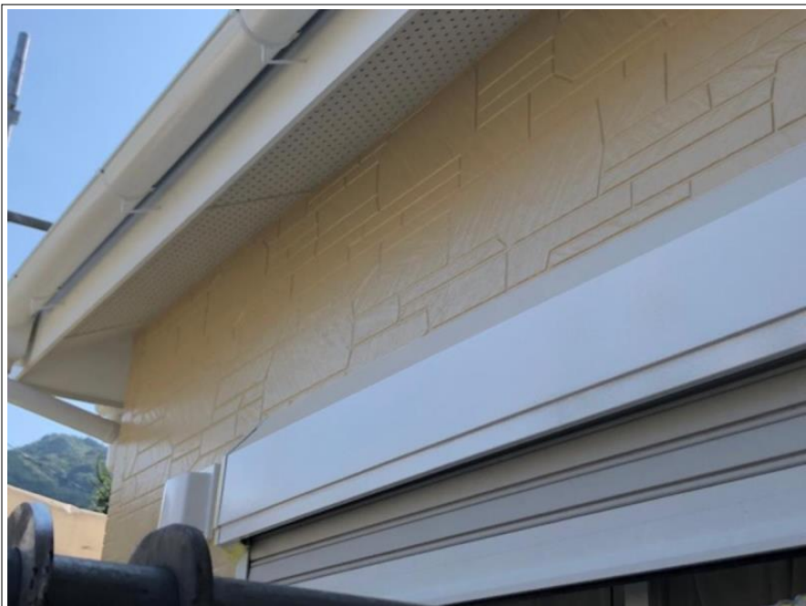
破風板・樋・シャッター 塗装完了
