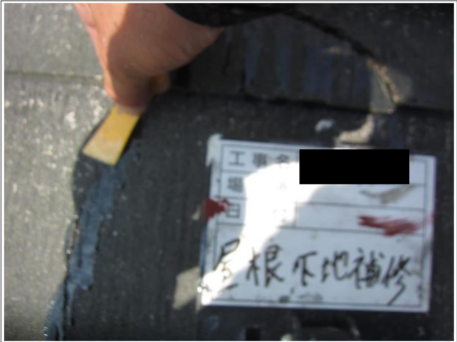
屋根 下地処理
