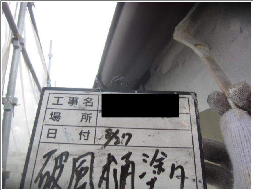
破風板・樋 塗装 1回目
