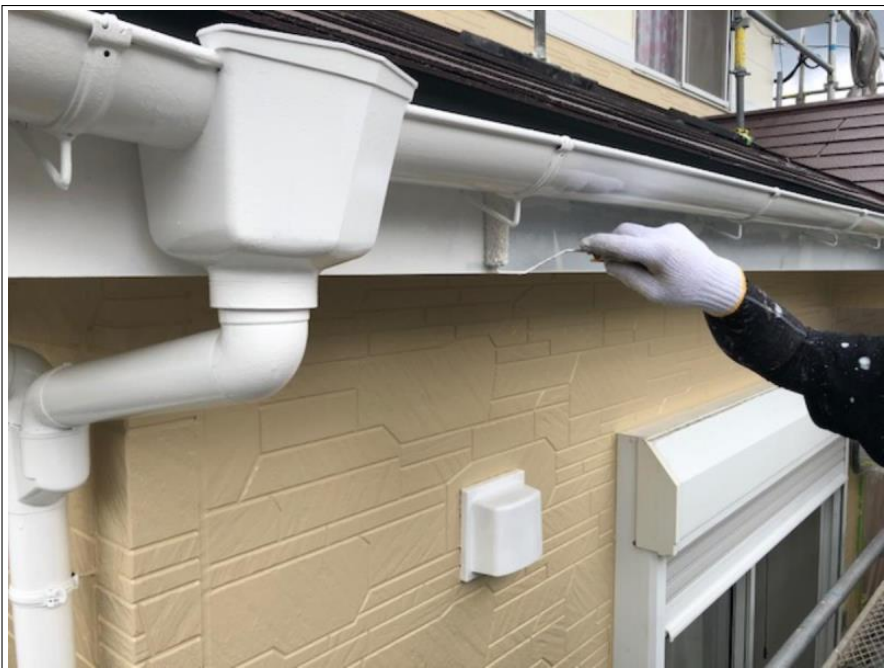
破風板・樋 塗装 2回目
