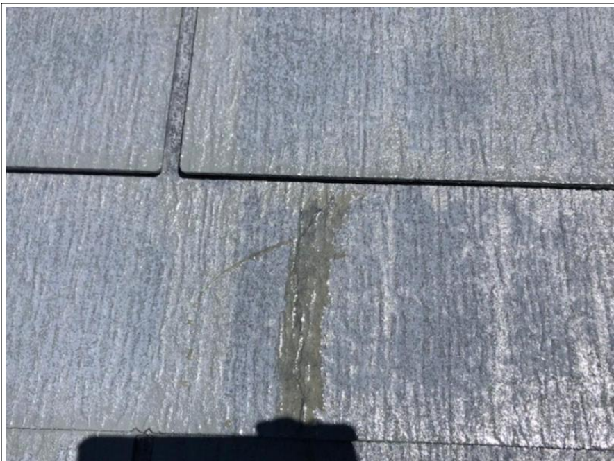
屋根 下地処理
