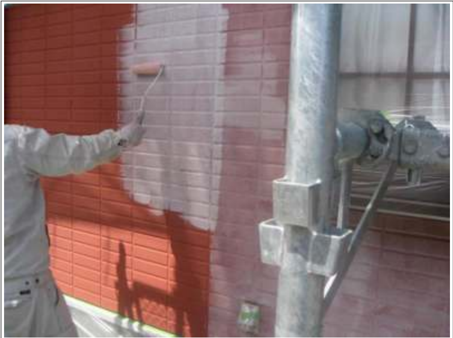
外壁 下塗り施工中
