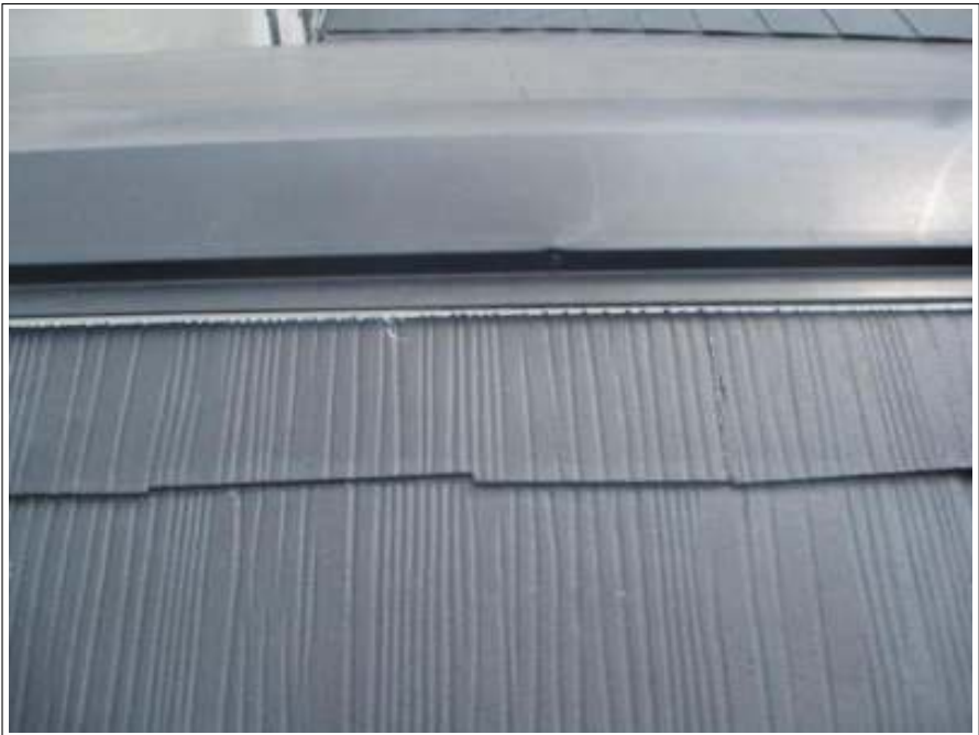
棟鉄板ラバー止め 施工後
