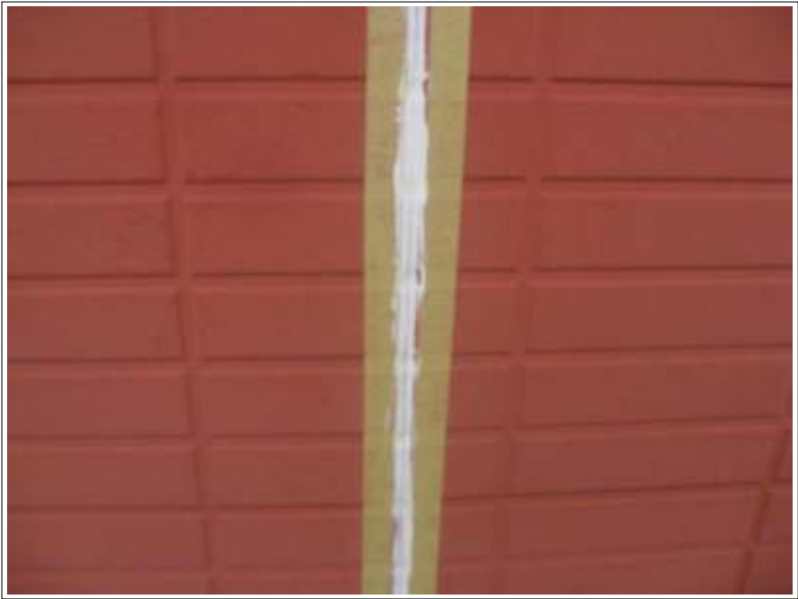
シーリング打ち増し 施工後
