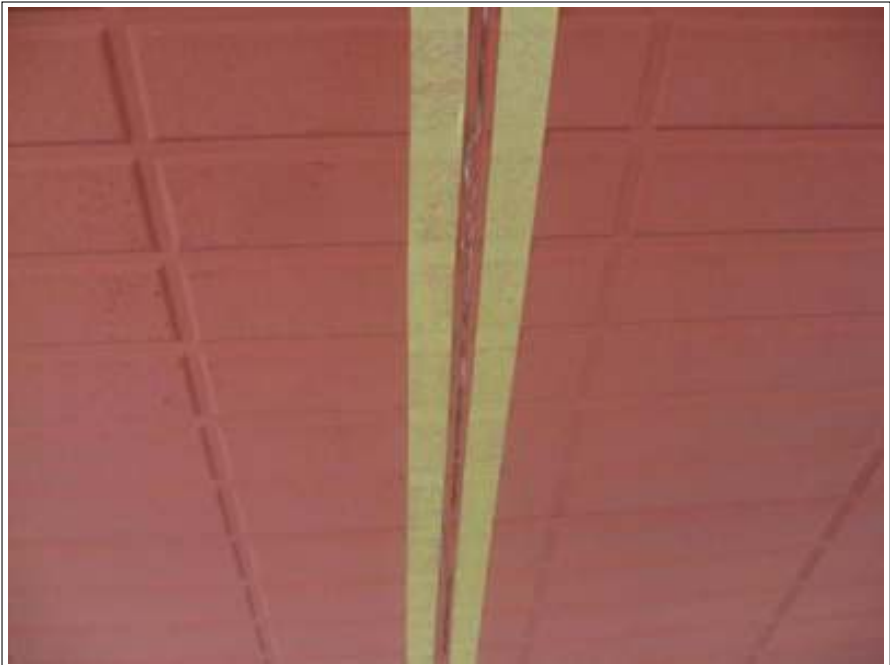
シーリング打ち増し 施工前
