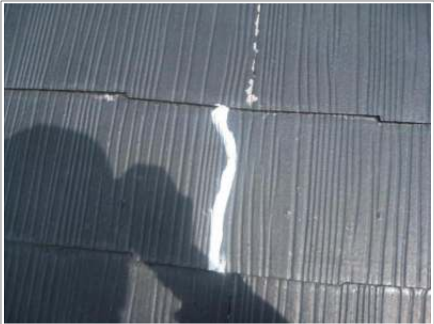
屋根 クラック補修 施工後
