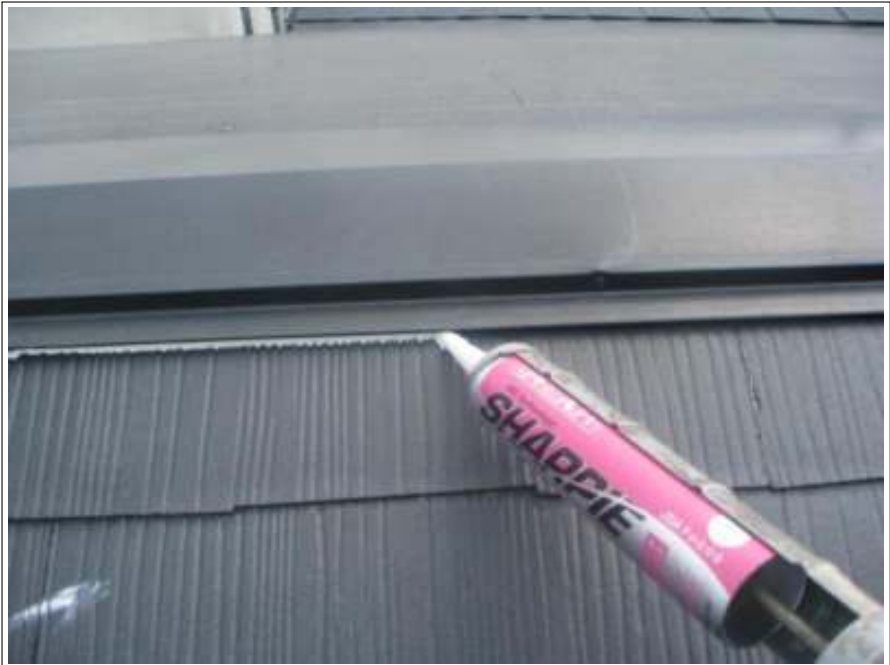
棟鉄板ラバー止め 施工中
