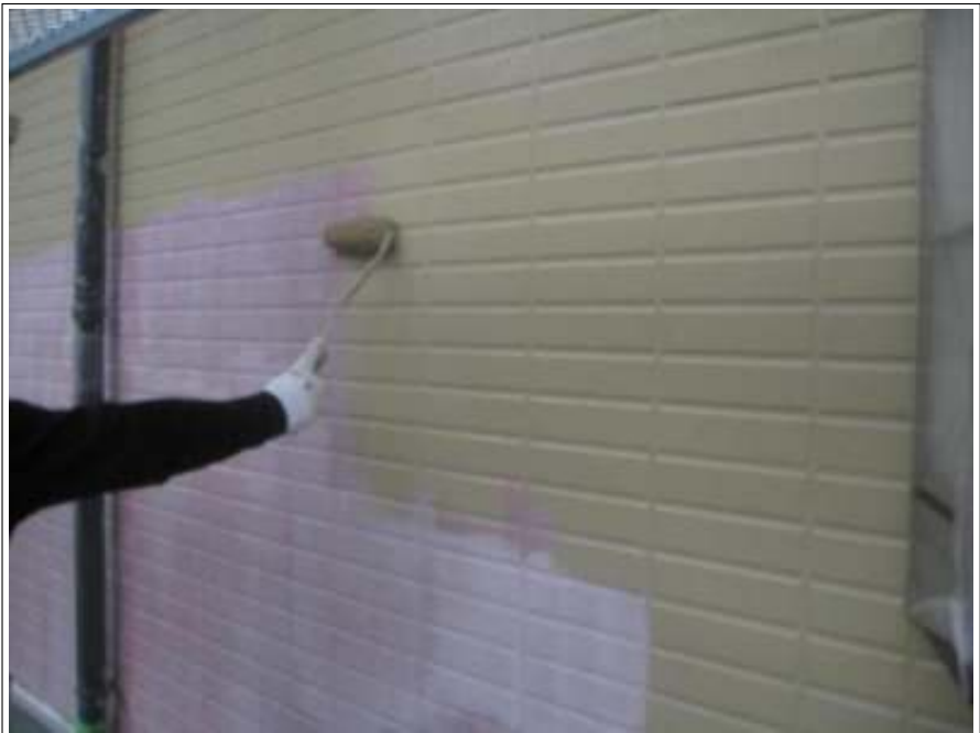
外壁 中塗り施工中
