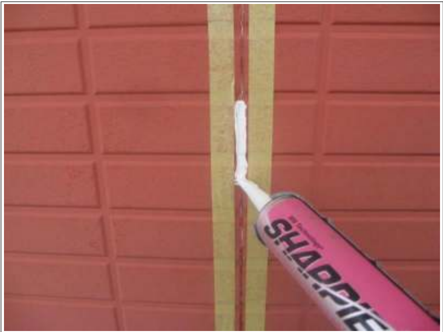
シーリング打ち増し 施工中
