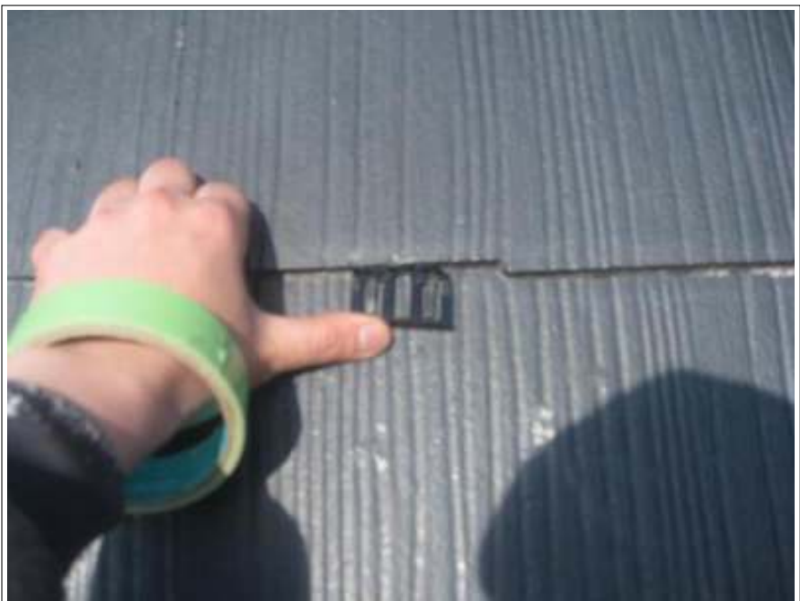
屋根 タスペーサー取付施工中
