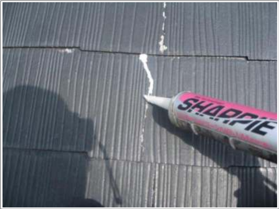
屋根 クラック補修 施工中
