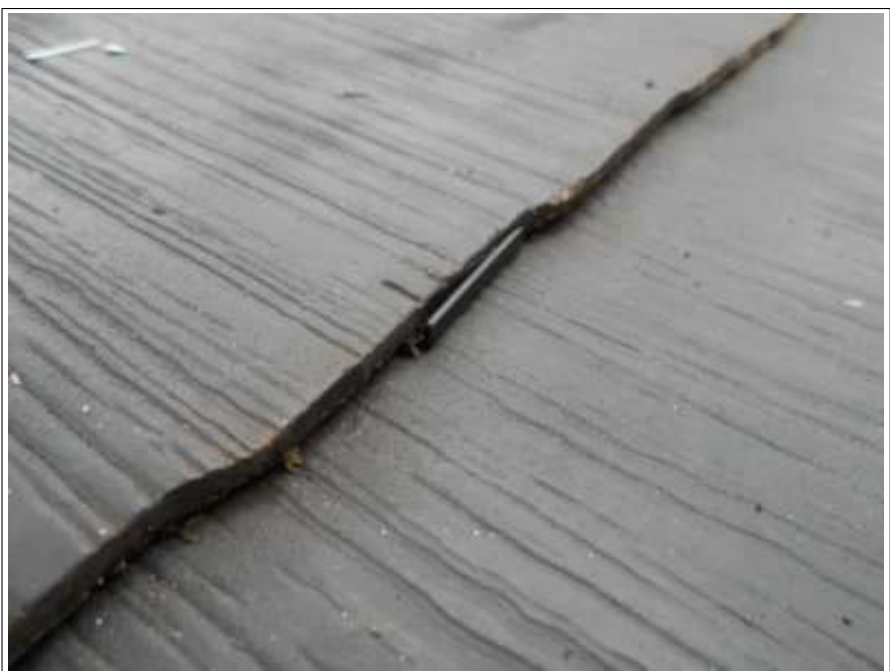
屋根 タスペーサー取付施工後
