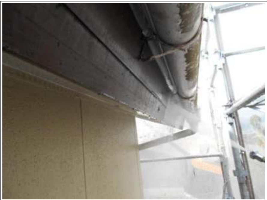
破風板 高圧洗浄中
