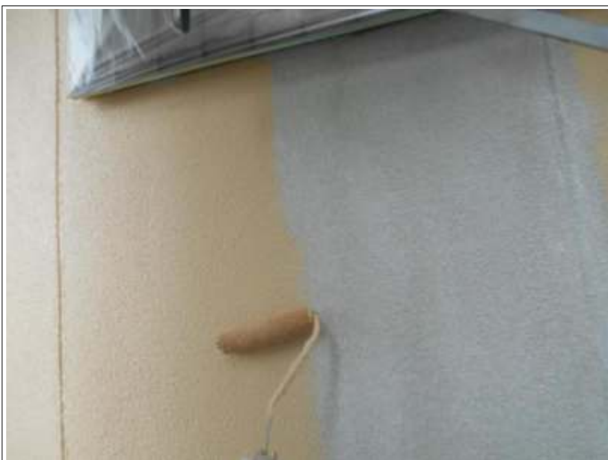
外壁 中塗り施工中
