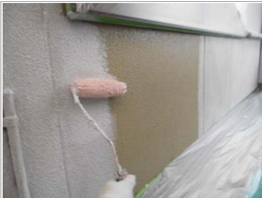
外壁 下塗り施工中
