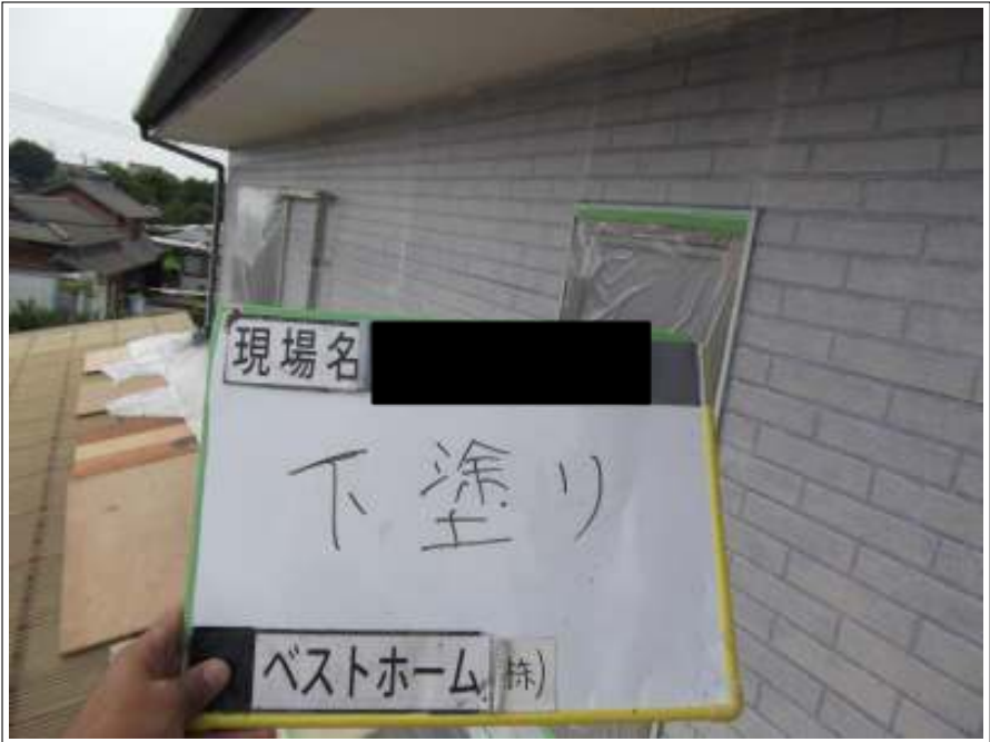
外壁下塗り 施工後
