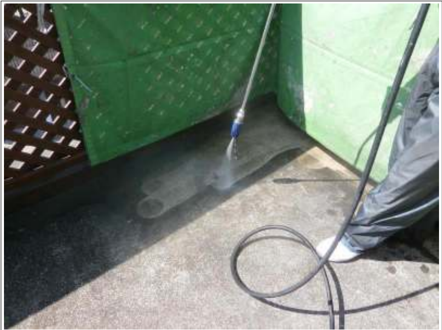
高圧洗浄施工中
