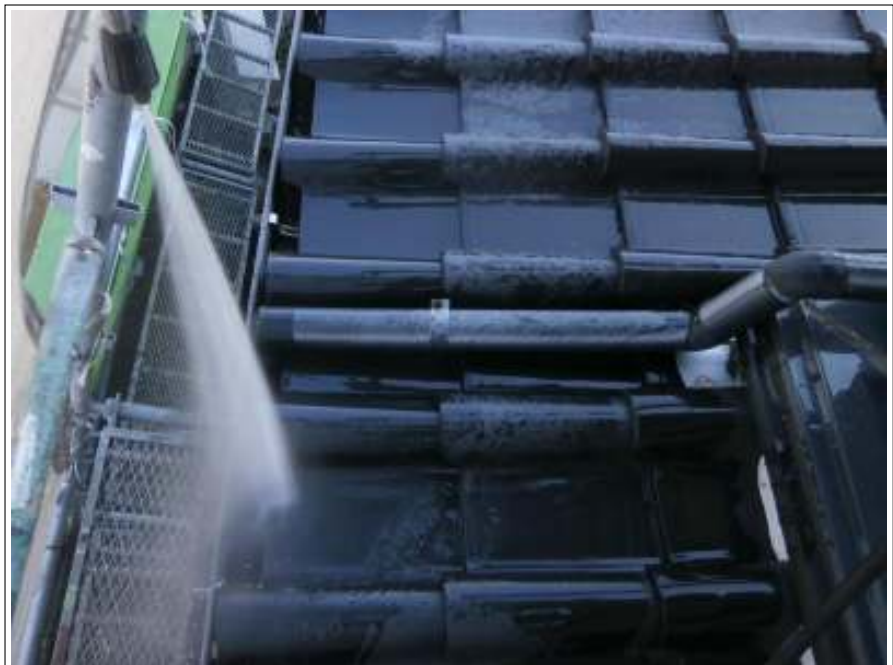
高圧洗浄施工中
