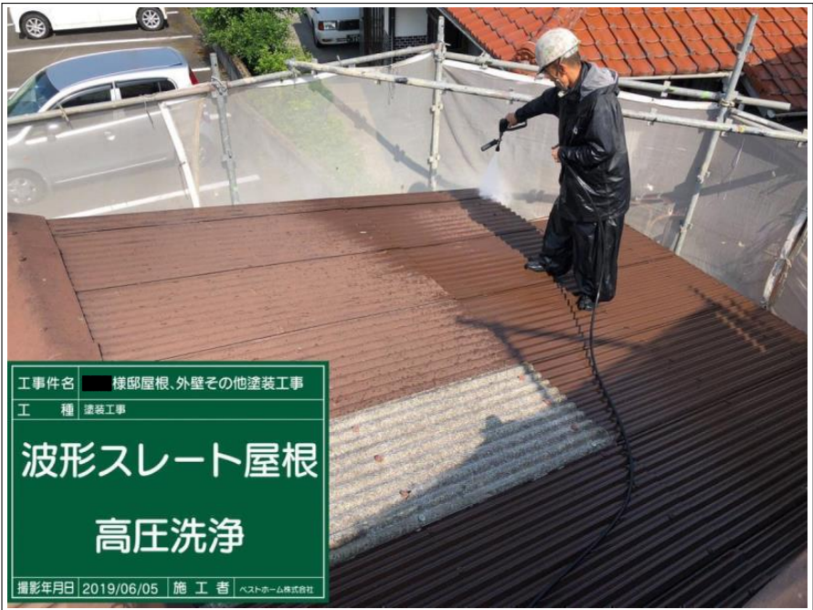
工事件名 様邸屋根、外壁その他塗装工事 工 種 塗装工事 屋根 高圧洗浄 撮影年月日 2019/06/05 施 工 者 ヘストホーム株式会社
