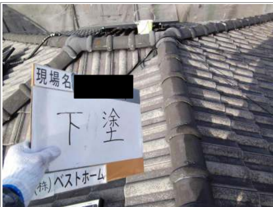
屋根下塗り1回目施工中
