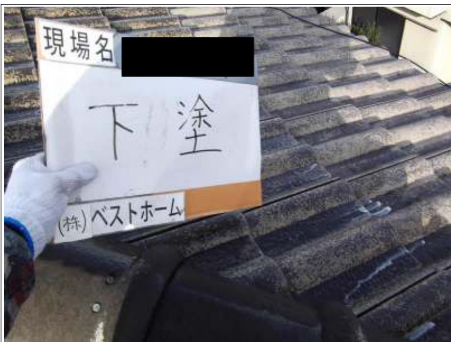
屋根下塗り1回目施工中
