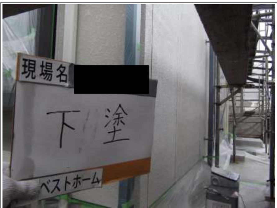
外壁下塗り施工中
