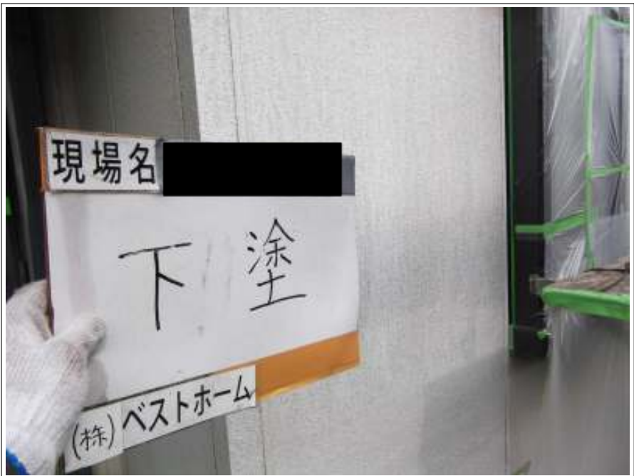
外壁下塗り施工中
