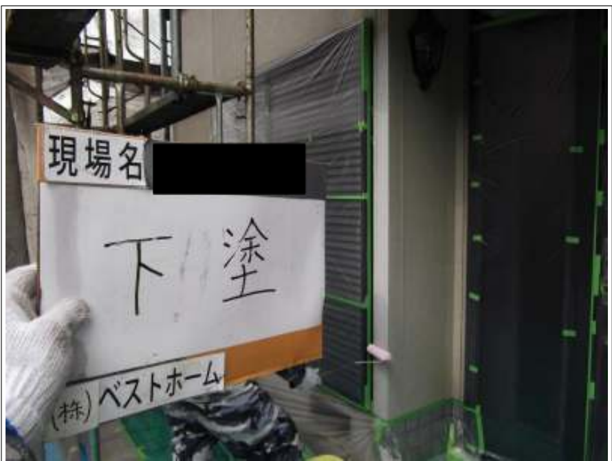
外壁下塗り施工中
