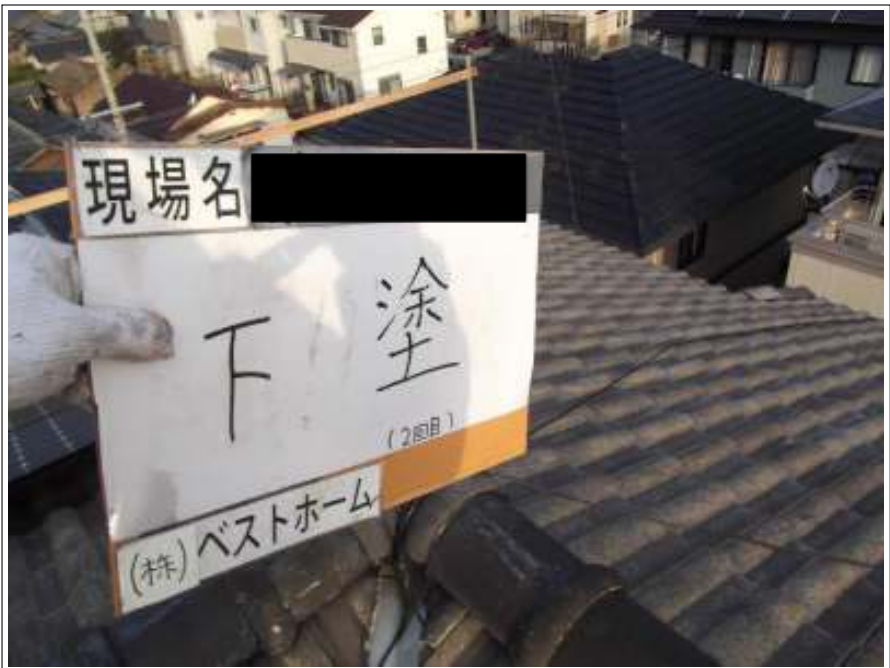
屋根下塗り2回目施工中
