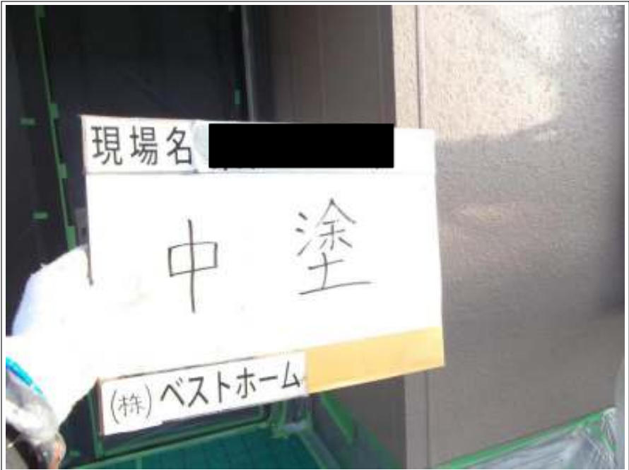
外壁中塗り施工中
