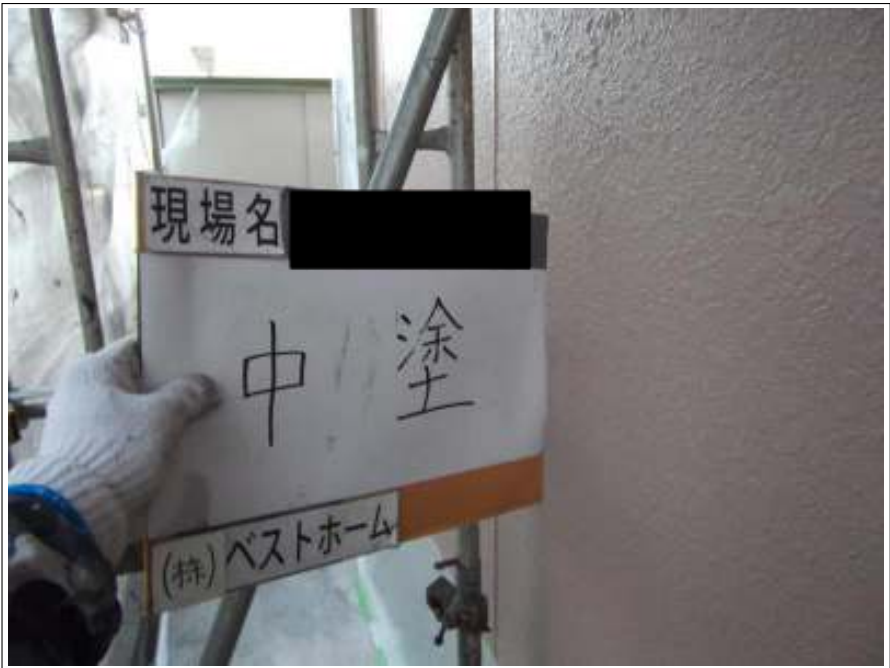
外壁中塗り施工中
