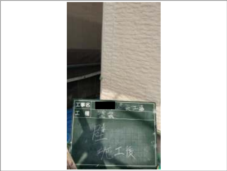
外壁 中塗り施工後
