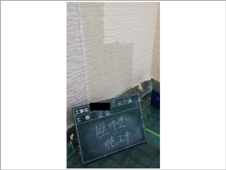
外壁 中塗り施工中
