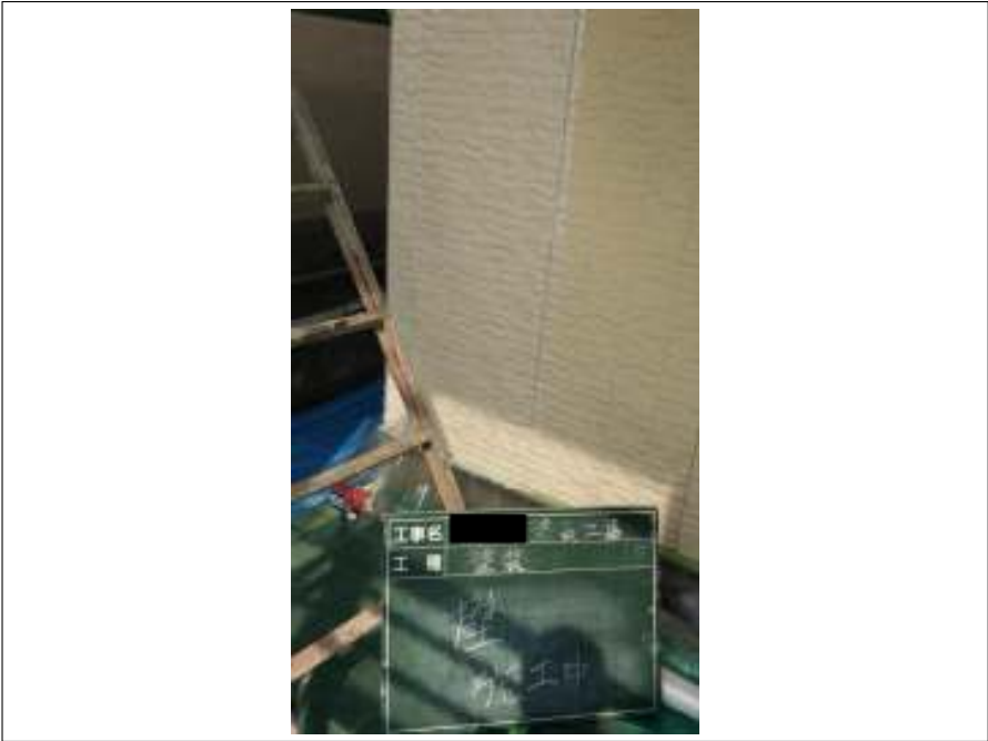
外壁 中塗り施工中
