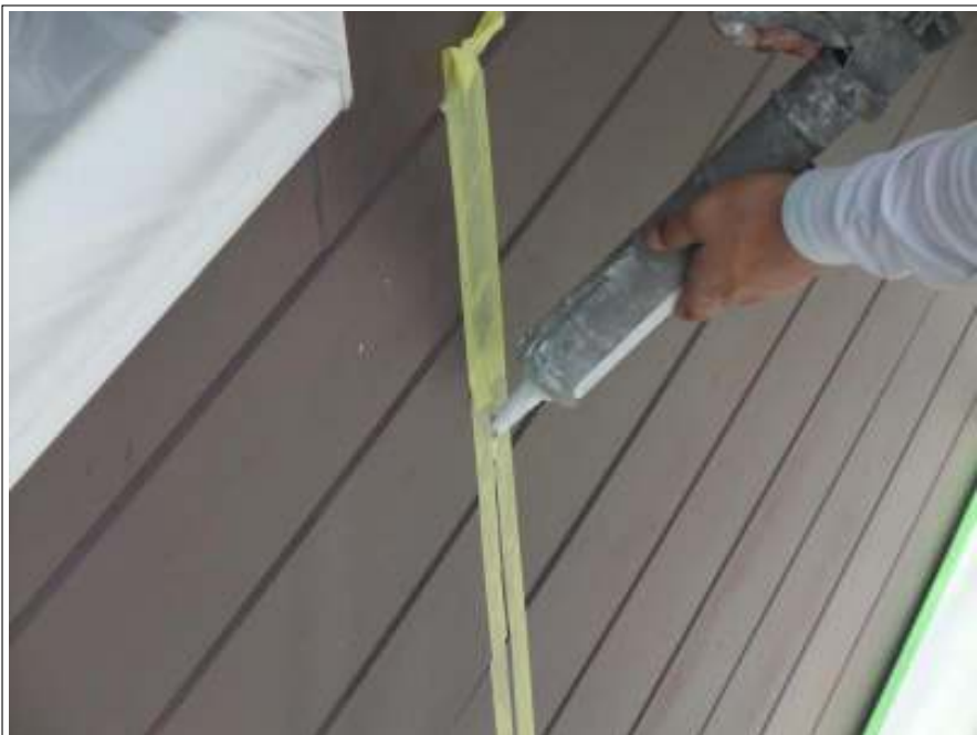
外壁 シーリング打替え施工中
