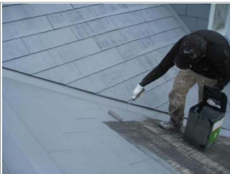
屋根 下塗り施工中
