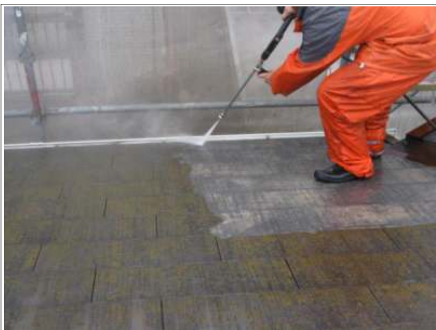
屋根 高圧洗浄中
