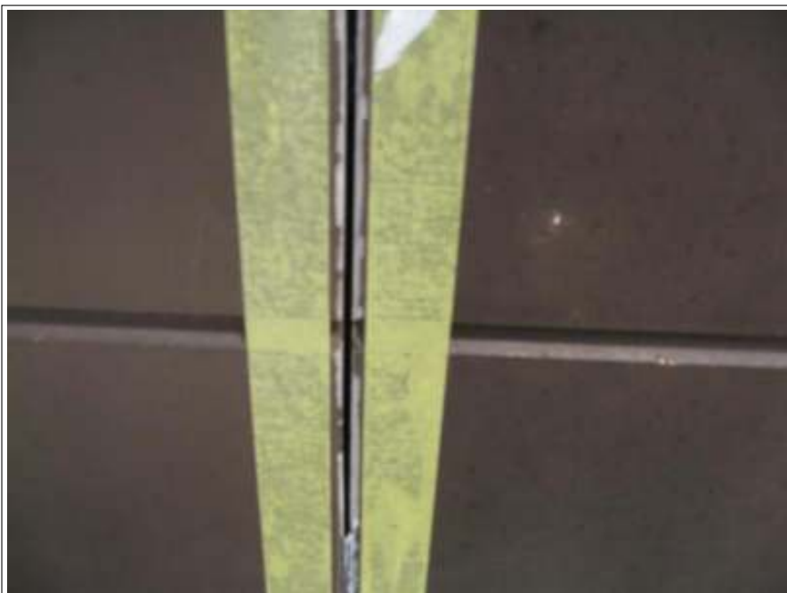
外壁 シーリング打替え施工中
