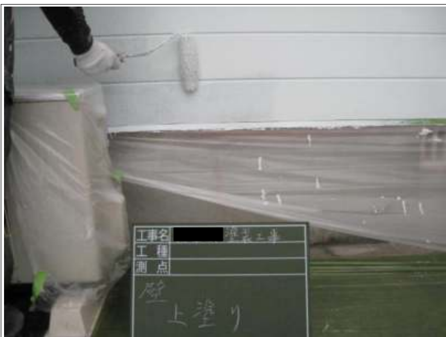
外壁 上塗り施工中
