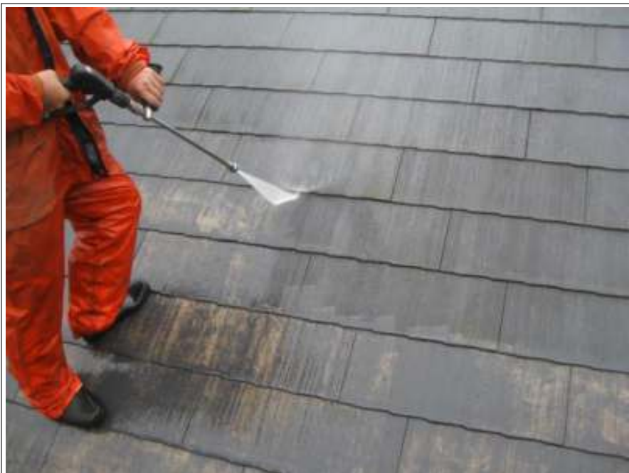
屋根 高圧洗浄中
