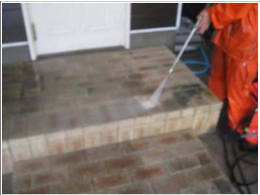
土間 高圧洗浄中
