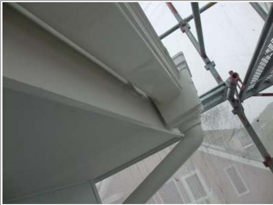
雨樋塗装 施工完了
