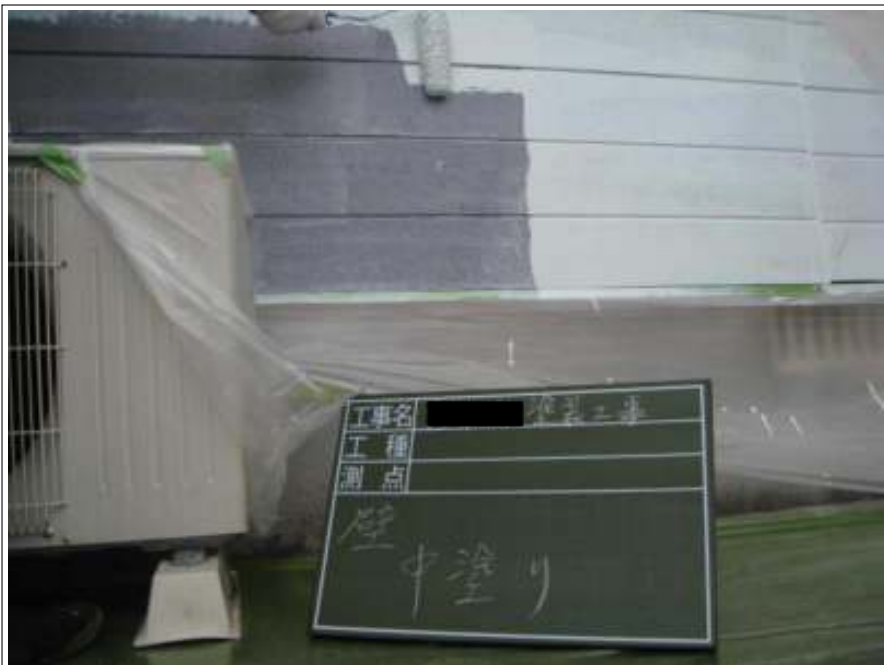
外壁 中塗り施工中
