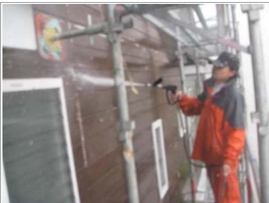
外壁 高圧洗浄中
