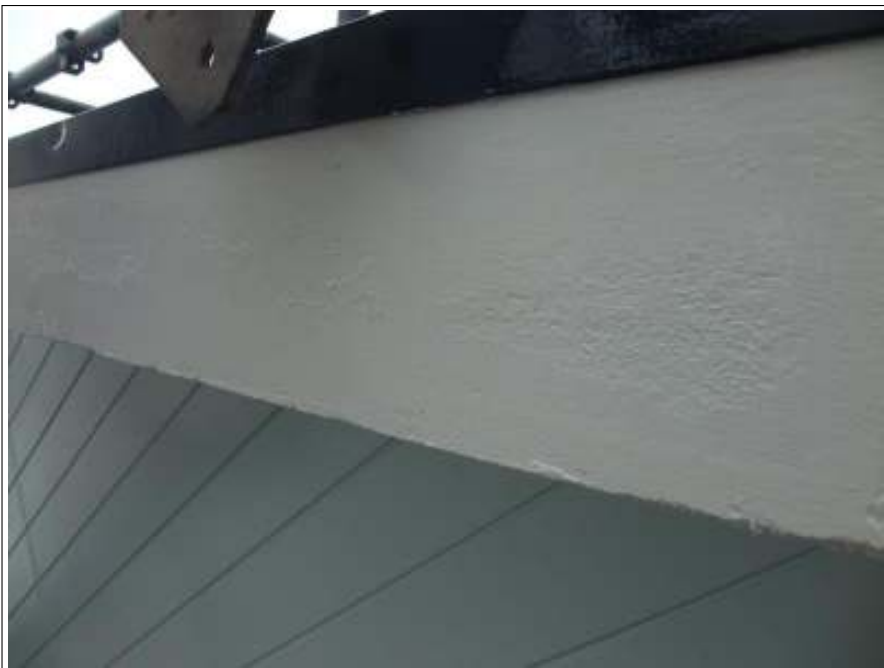
破風板 施工完了
