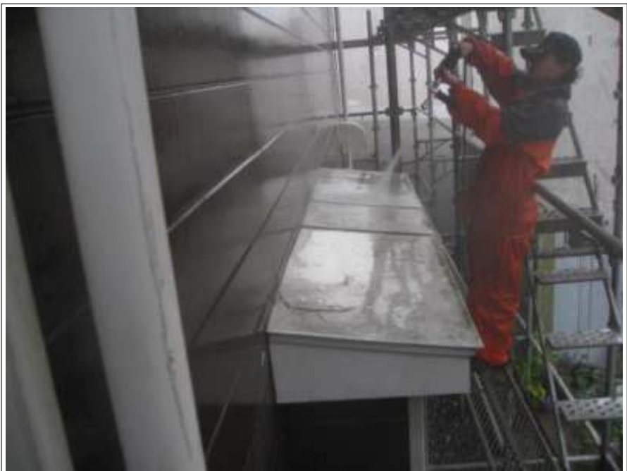
小庇 高圧洗浄中
