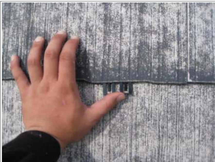
屋根 タスペーサー施工中
