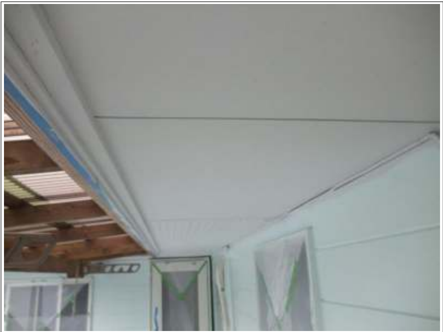
軒天 施工完了
