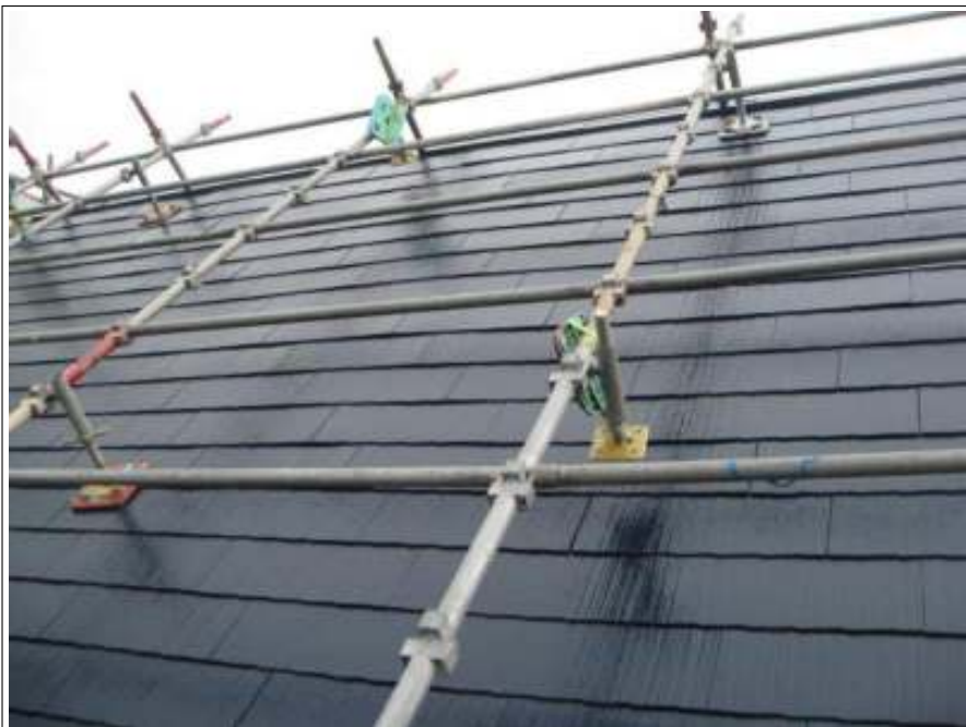
屋根 施工完了
