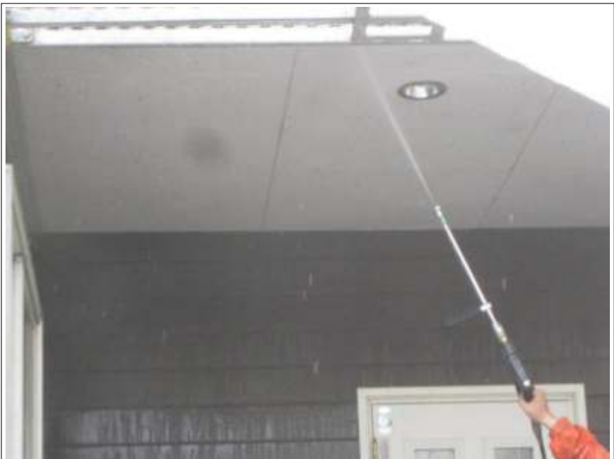
軒天 高圧洗浄中
