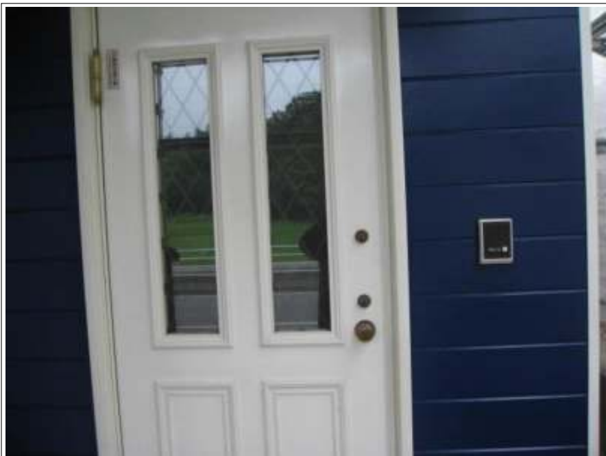
外壁（玄関部） 施工完了
