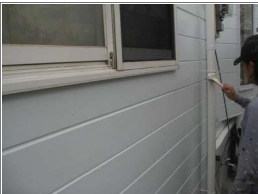
雨樋塗装 施工中
