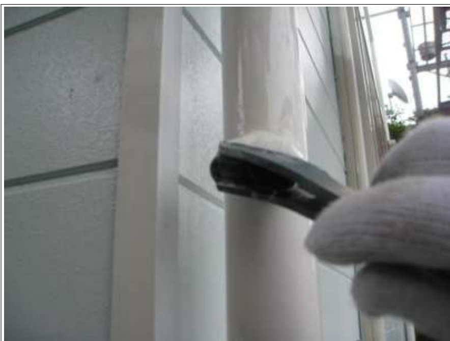
雨樋塗装 施工中
