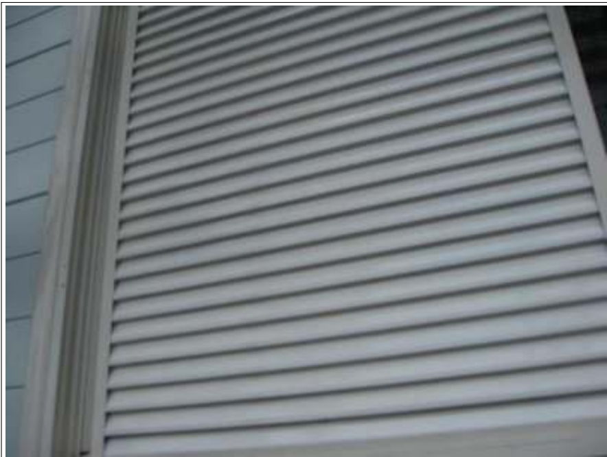
シャッター 施工完了
