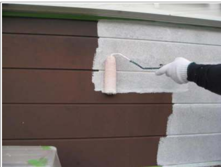
外壁 下塗り施工中
