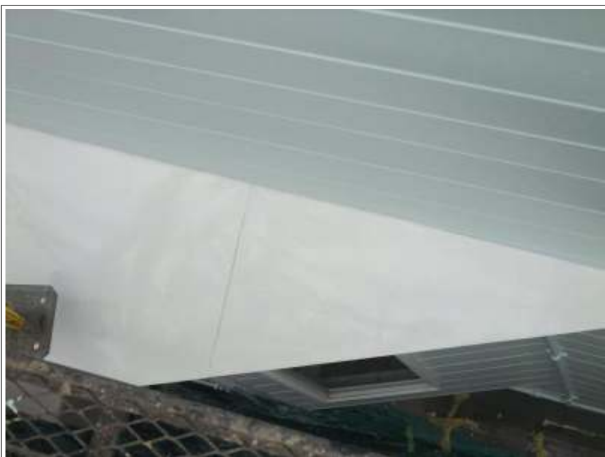
小庇 施工完了
