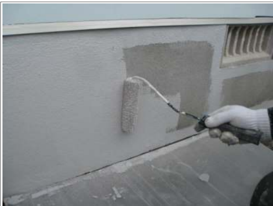
基礎塗装（1回目） 施工中
