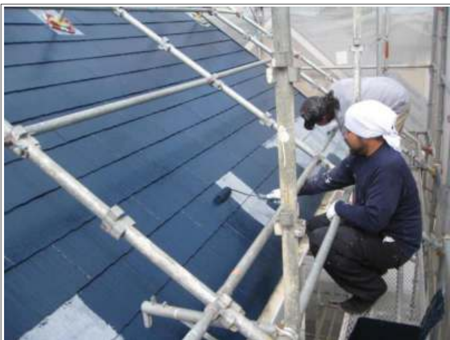
屋根 中塗り施工中
