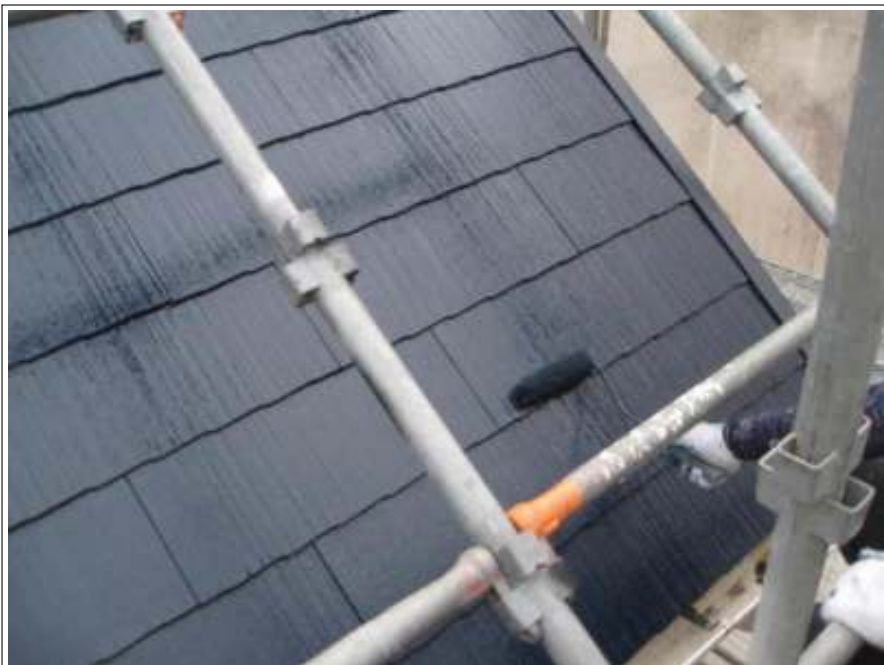
屋根 上塗り施工中
