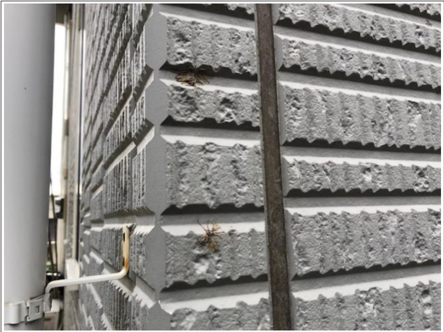
外壁 ボードシーリング劣化部
