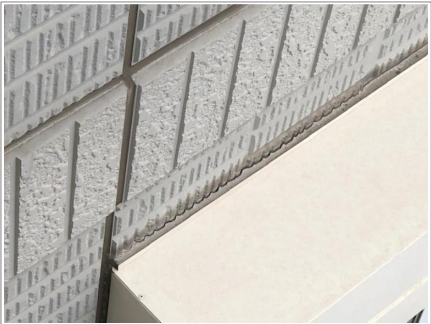
外壁 サッシ廻りシーリング劣化部
