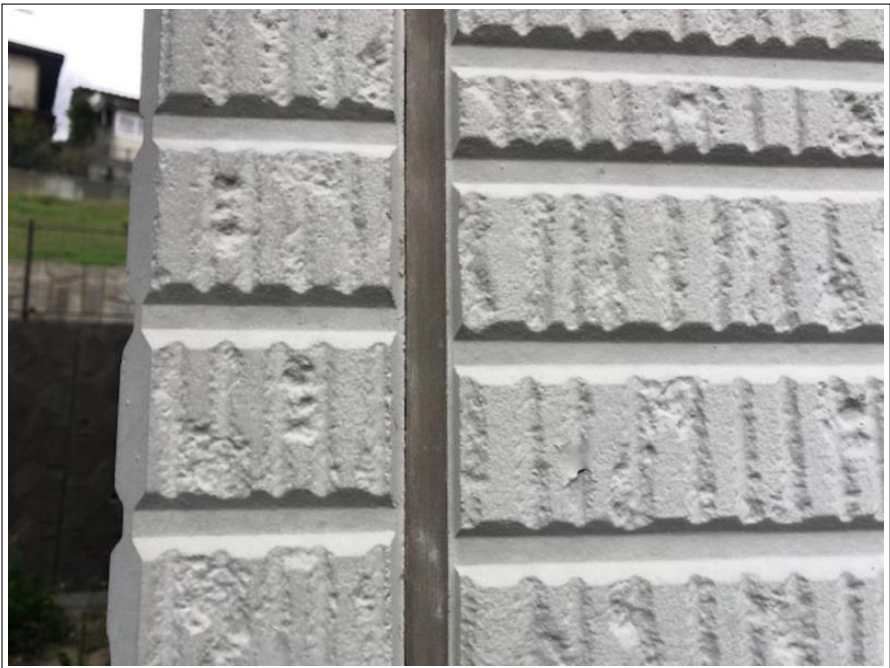
外壁 ボードシーリング劣化部
