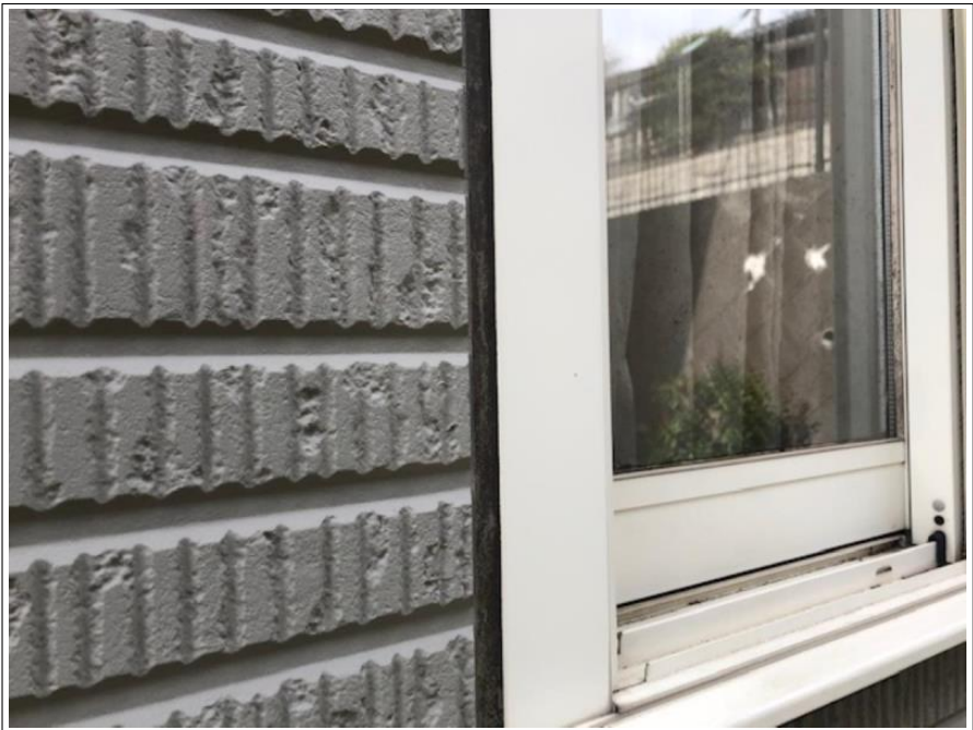
外壁 サッシ廻りシーリング劣化部
